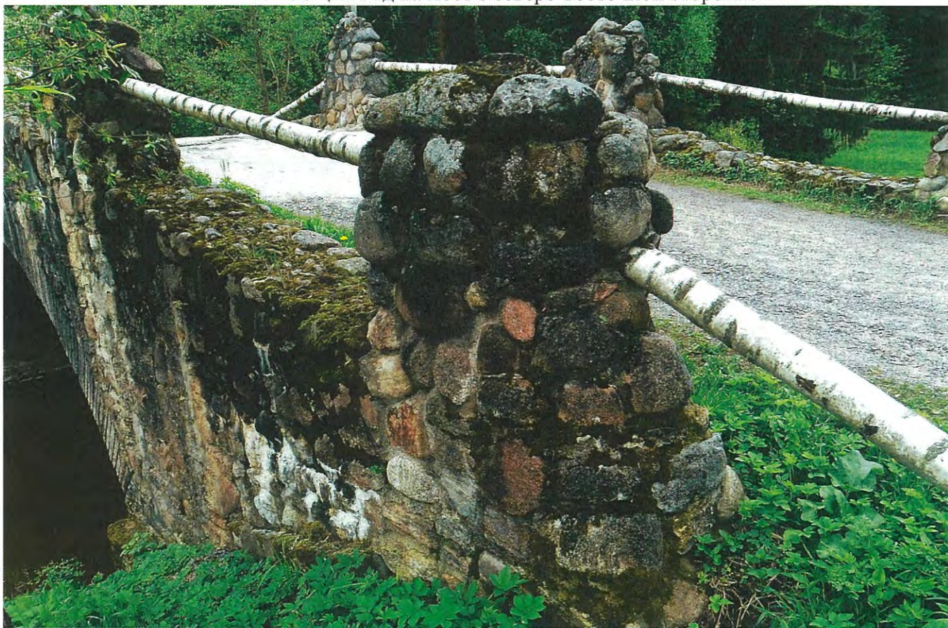
2. Фрагмент ограждения моста.
