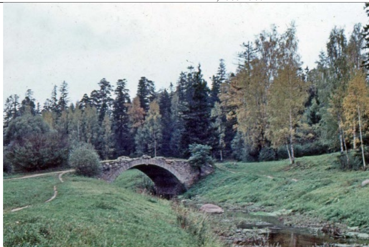
13. Мост Ново-Сильвийский, 1970-1975 гг.
