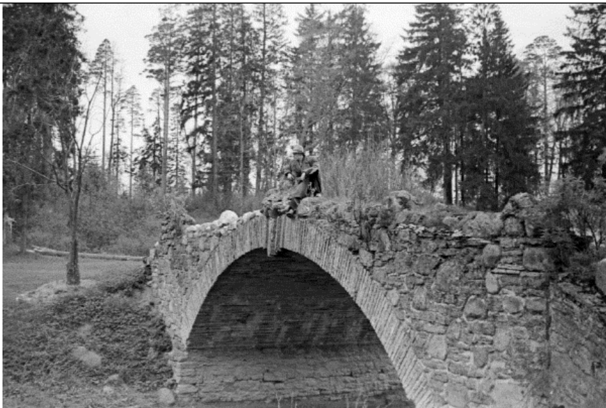
12. Мост Ново-Сильвийский, 1955-1960 гг.
