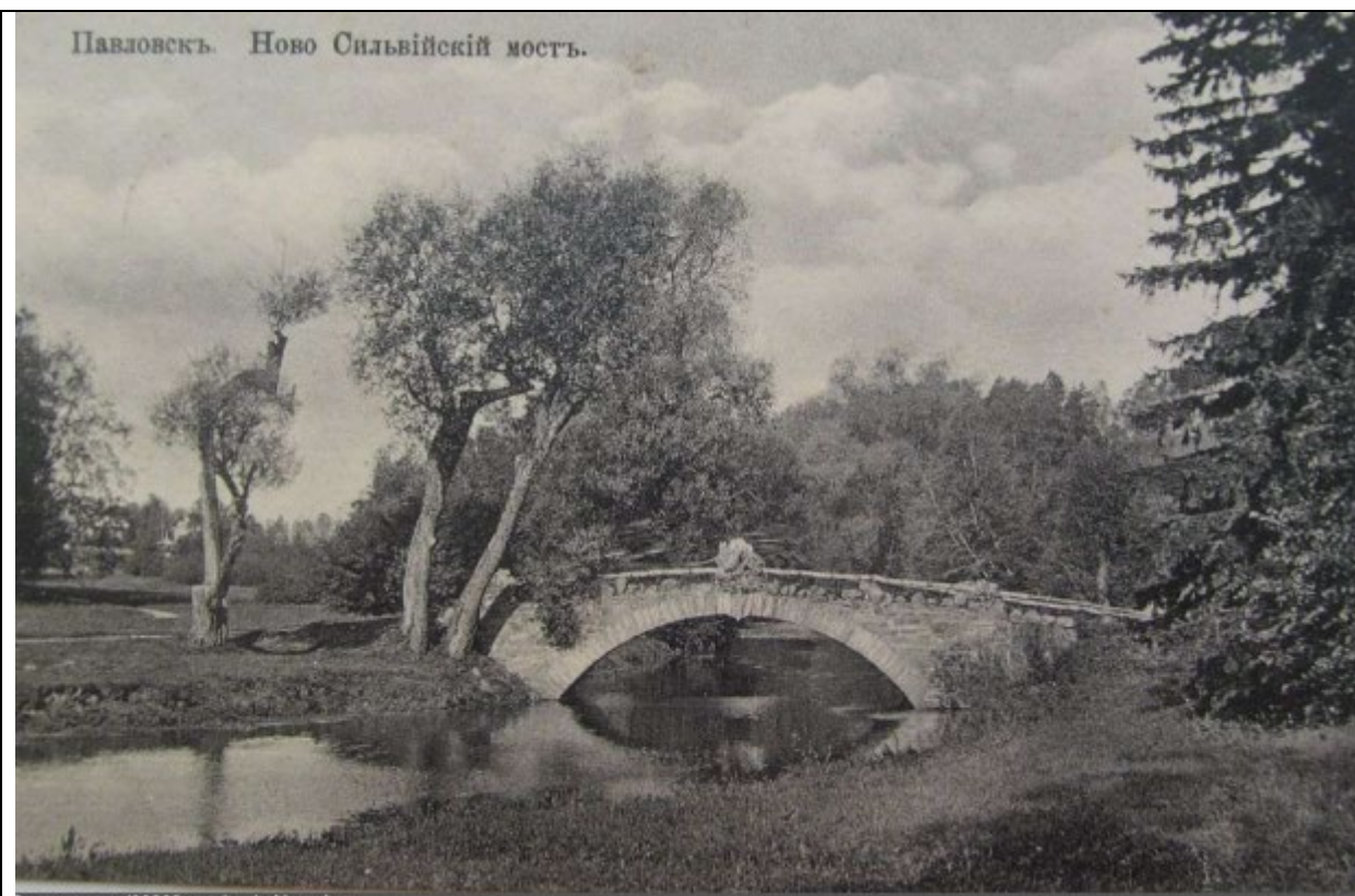
9. Мост Ново-Сильвийский, 1890-1914 гг.
