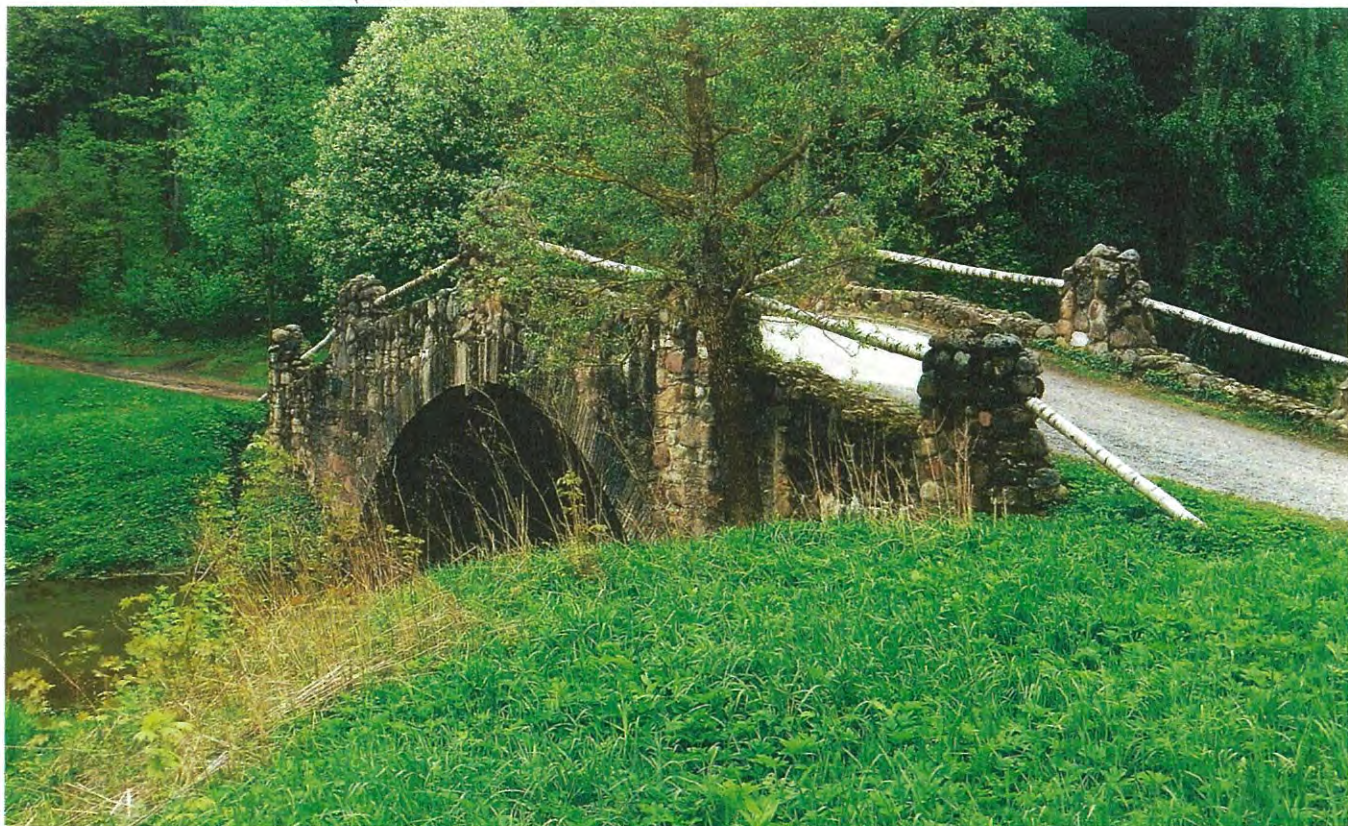
1. Общий вид на мост с северо-восточной стороны.
