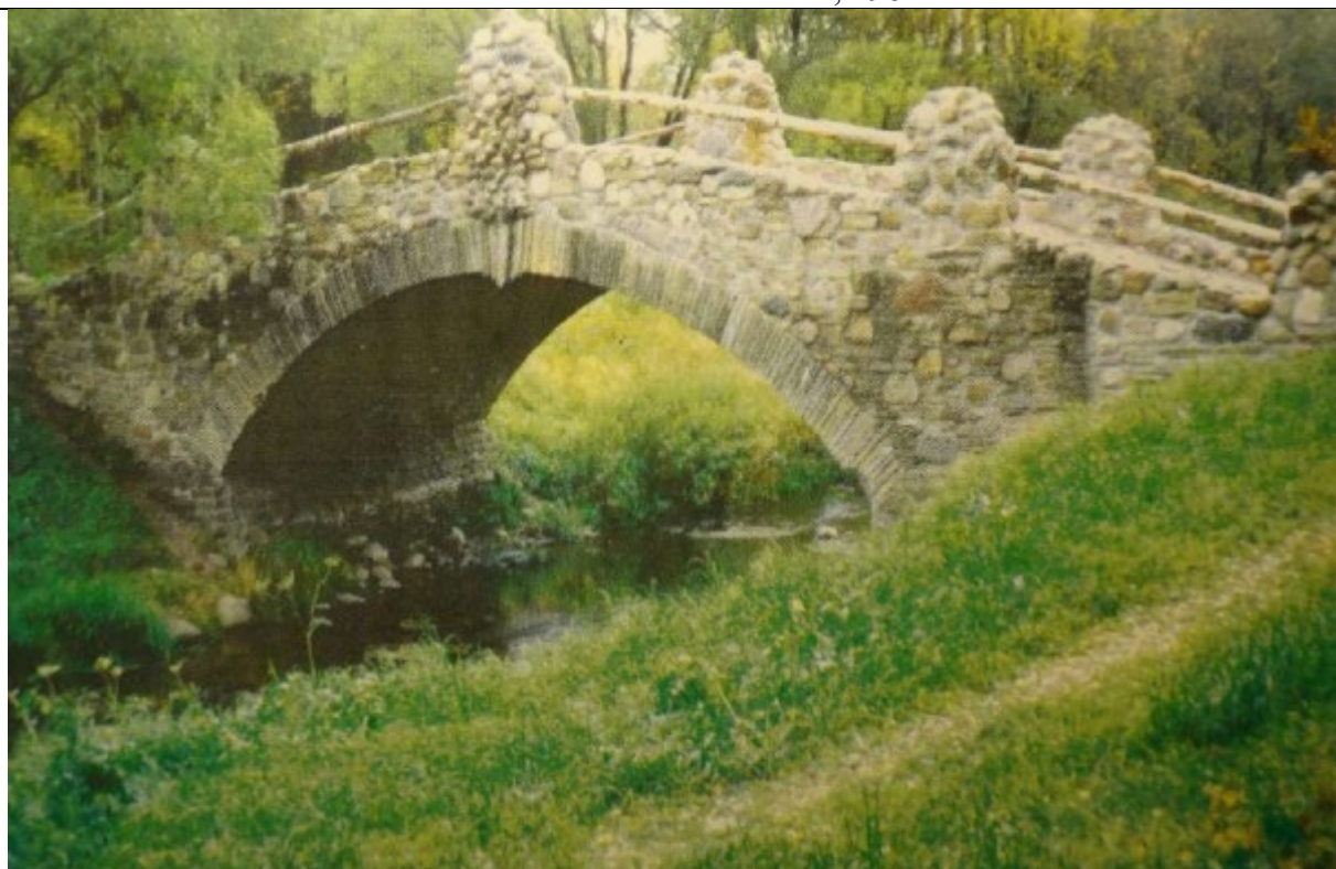
15. Мост Ново-Сильвийский, 1990-1991 гг.
