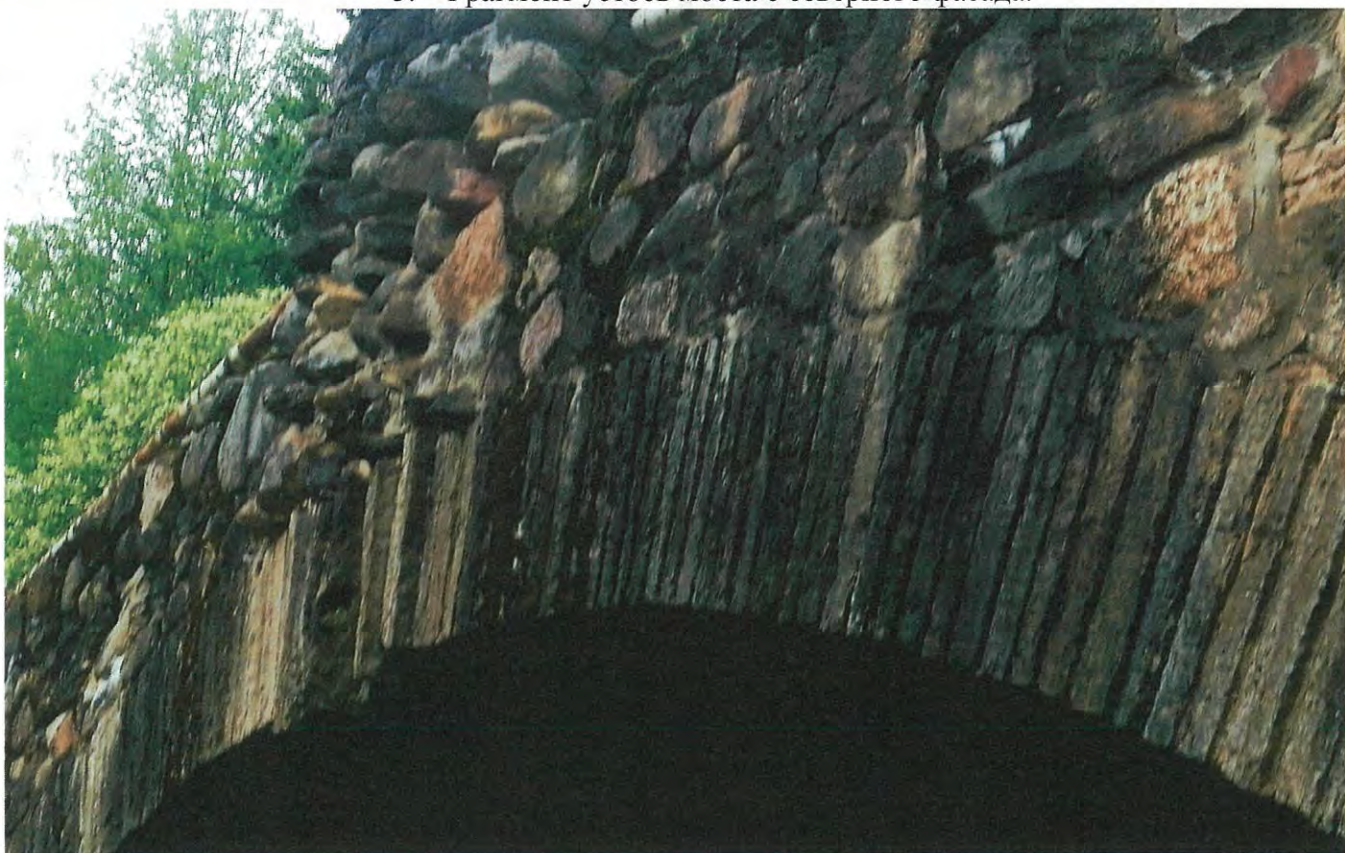
4. Фрагмент северного фасада моста.
