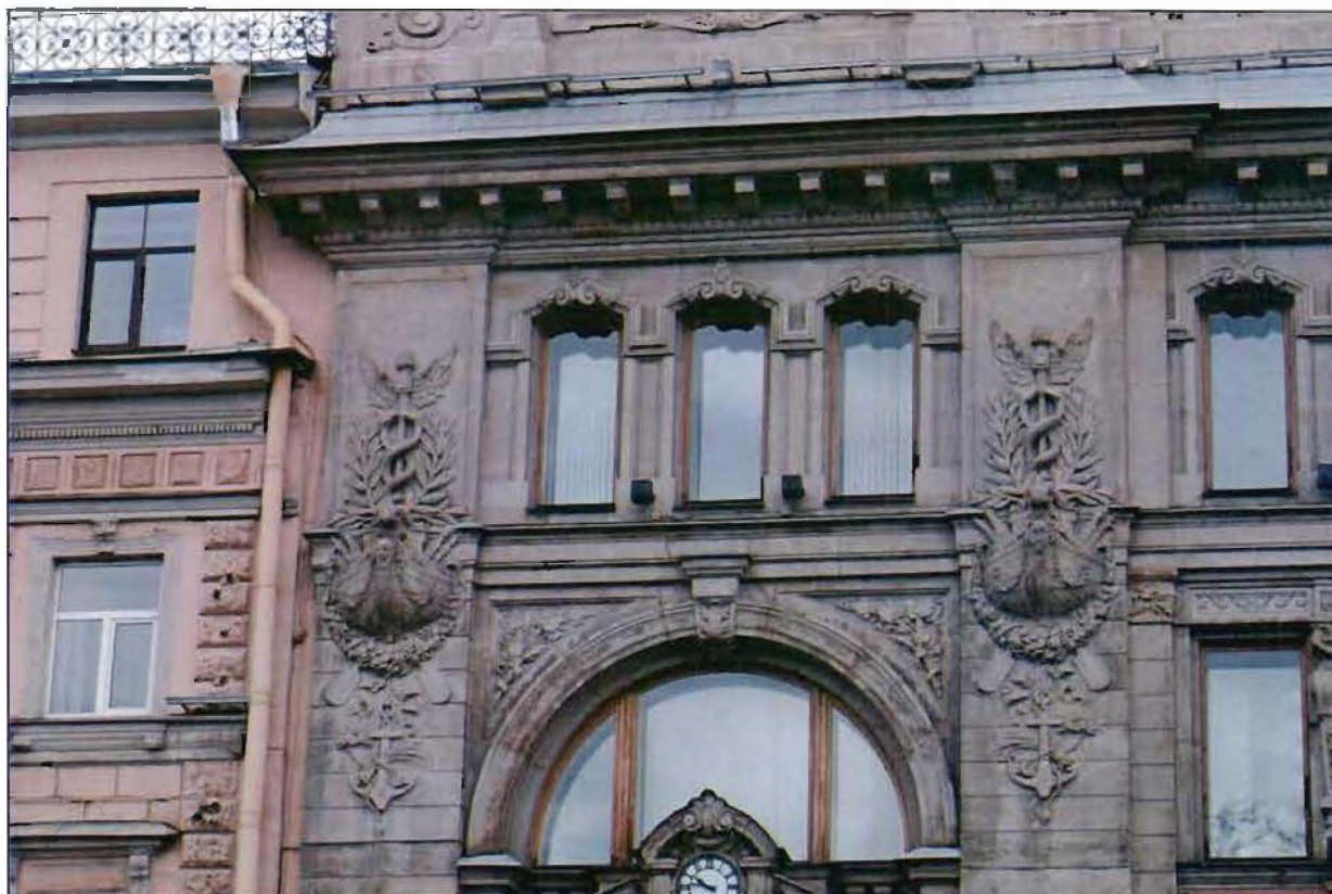
2. Лицевой фасад по Невскому проспекту. Фрагмент.
