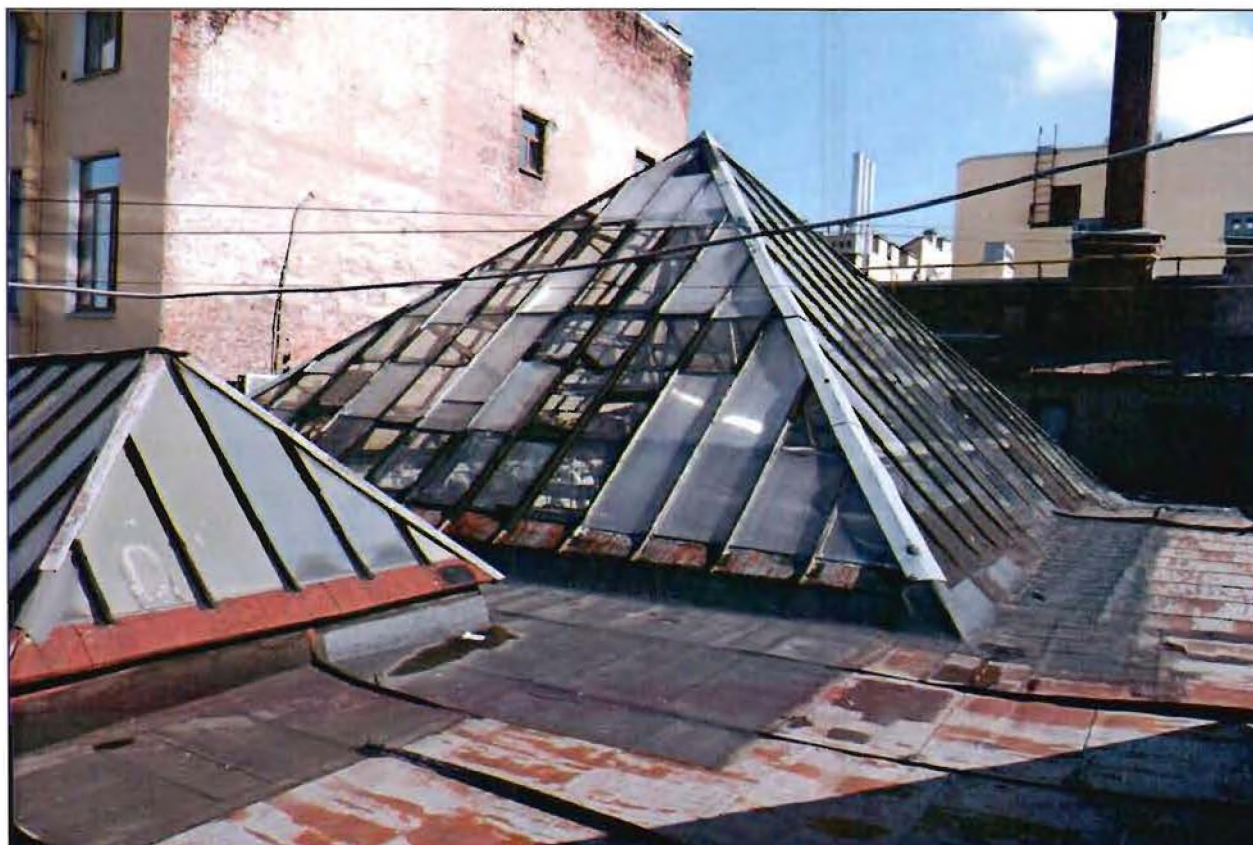
6. Общий вид кровли. Фрагмент. Световые фонари.
