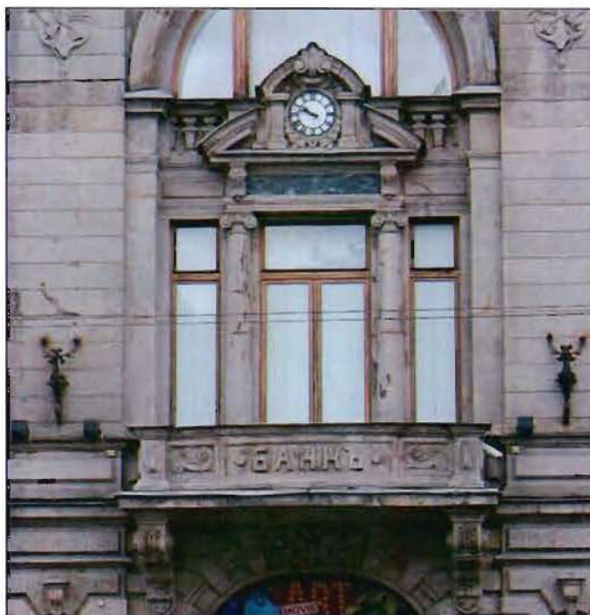
4. Лицевой фасад по Невскому проспекту. Фрагмент.
