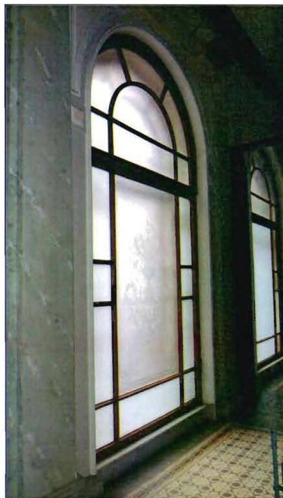
15. Интерьер. Фрагмент. Оконное заполнение.
