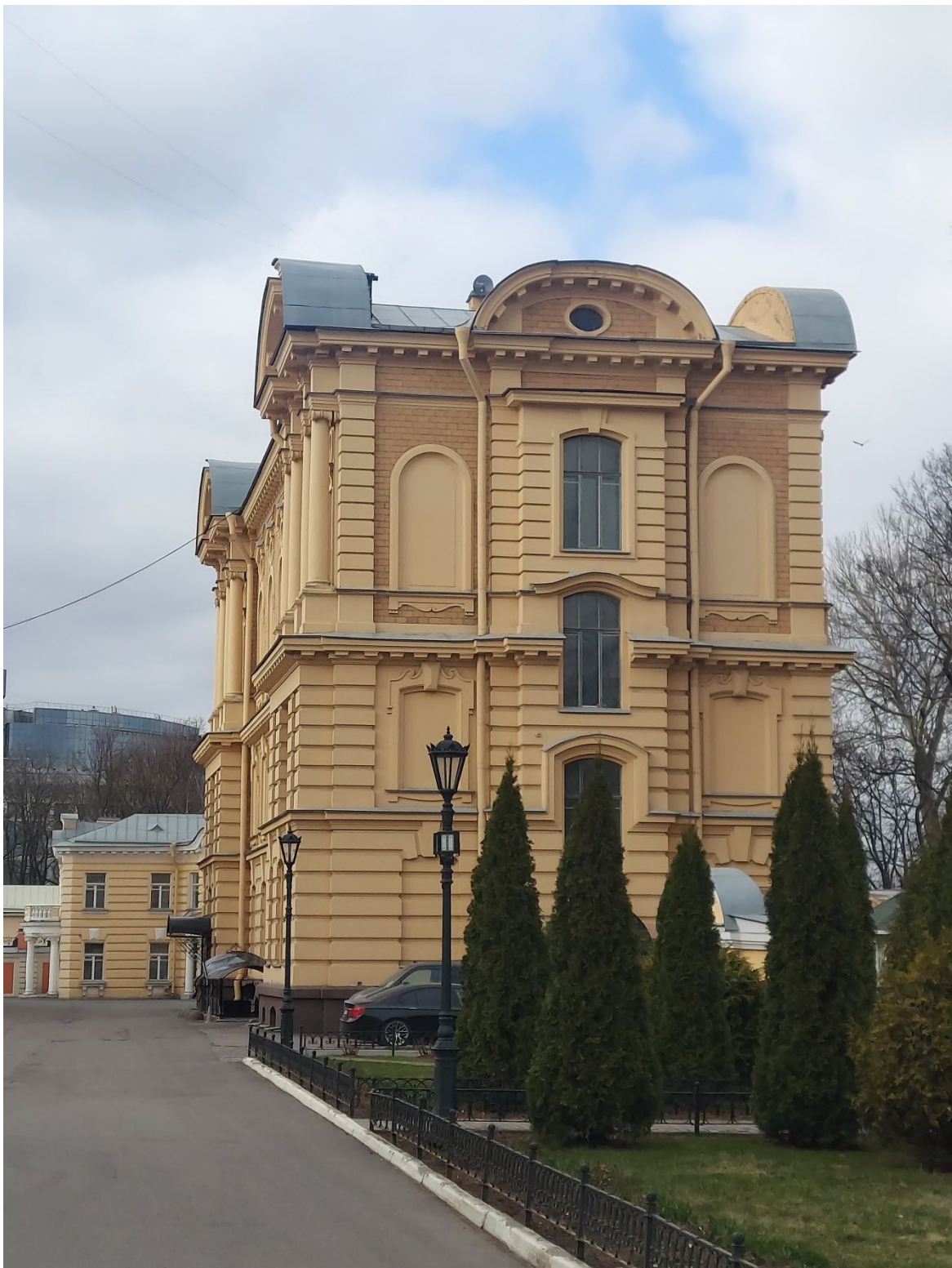
Фото 5. Южный торцевой фасад Ризницы.
