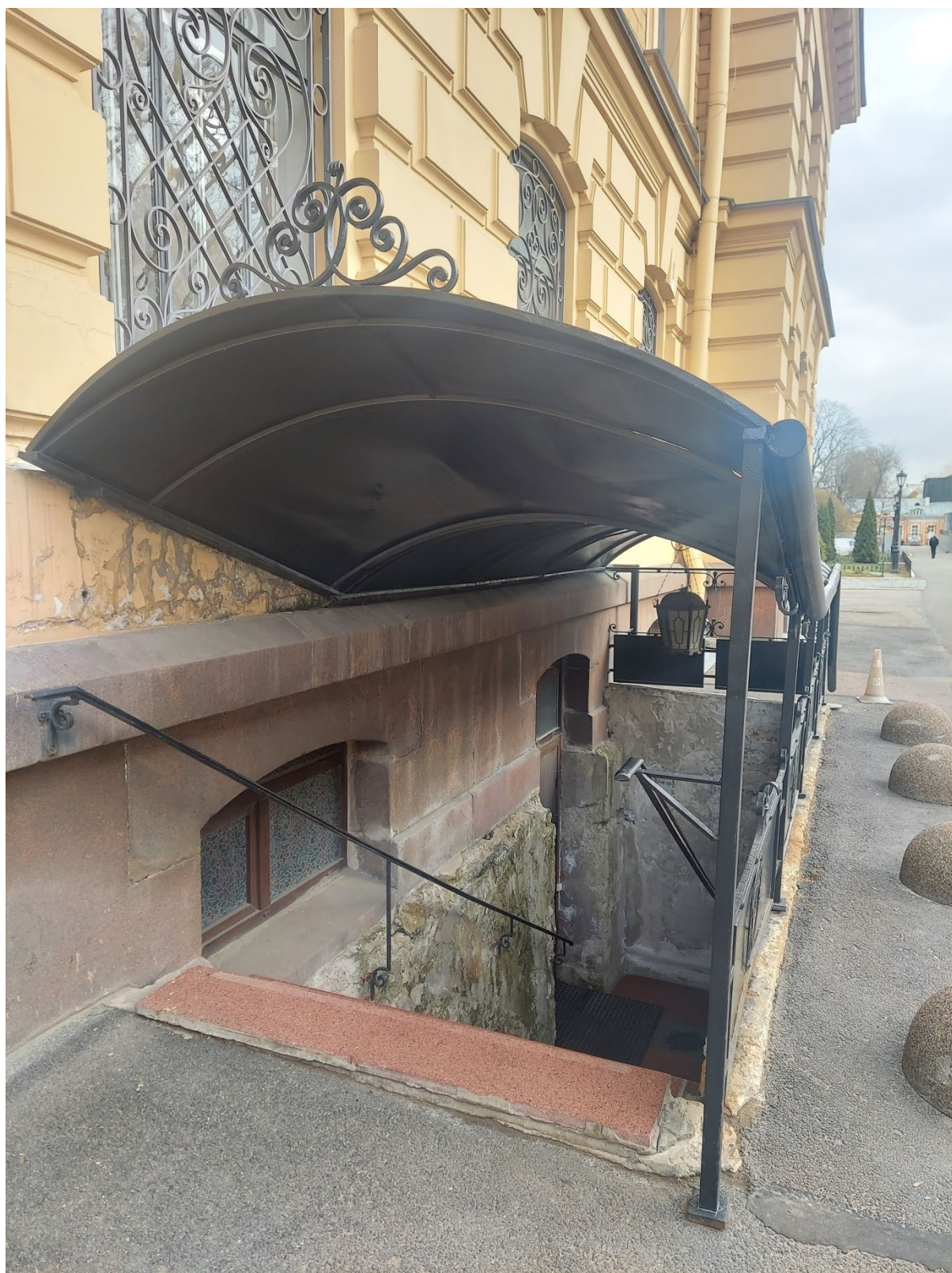
Фото 3. Прямок – спуск в подвальные помещения Ризницы.
