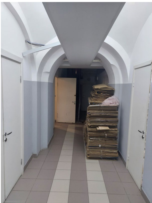
Фото 19. Коридор цокольного этажа.
