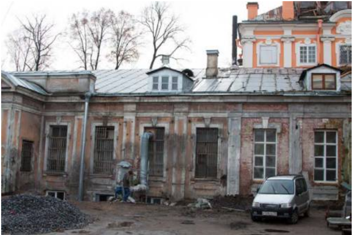
67.Исидоровская церковь. Реставрация фасадов. Вид с северо-запада.
