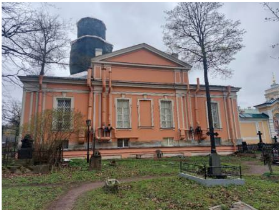
Фото 1. Восточный фасад церкви.
