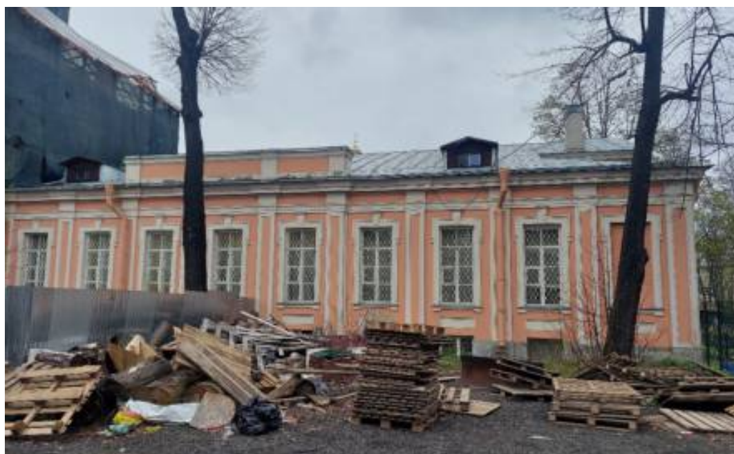
Фото 2. Южный фасад церкви.
