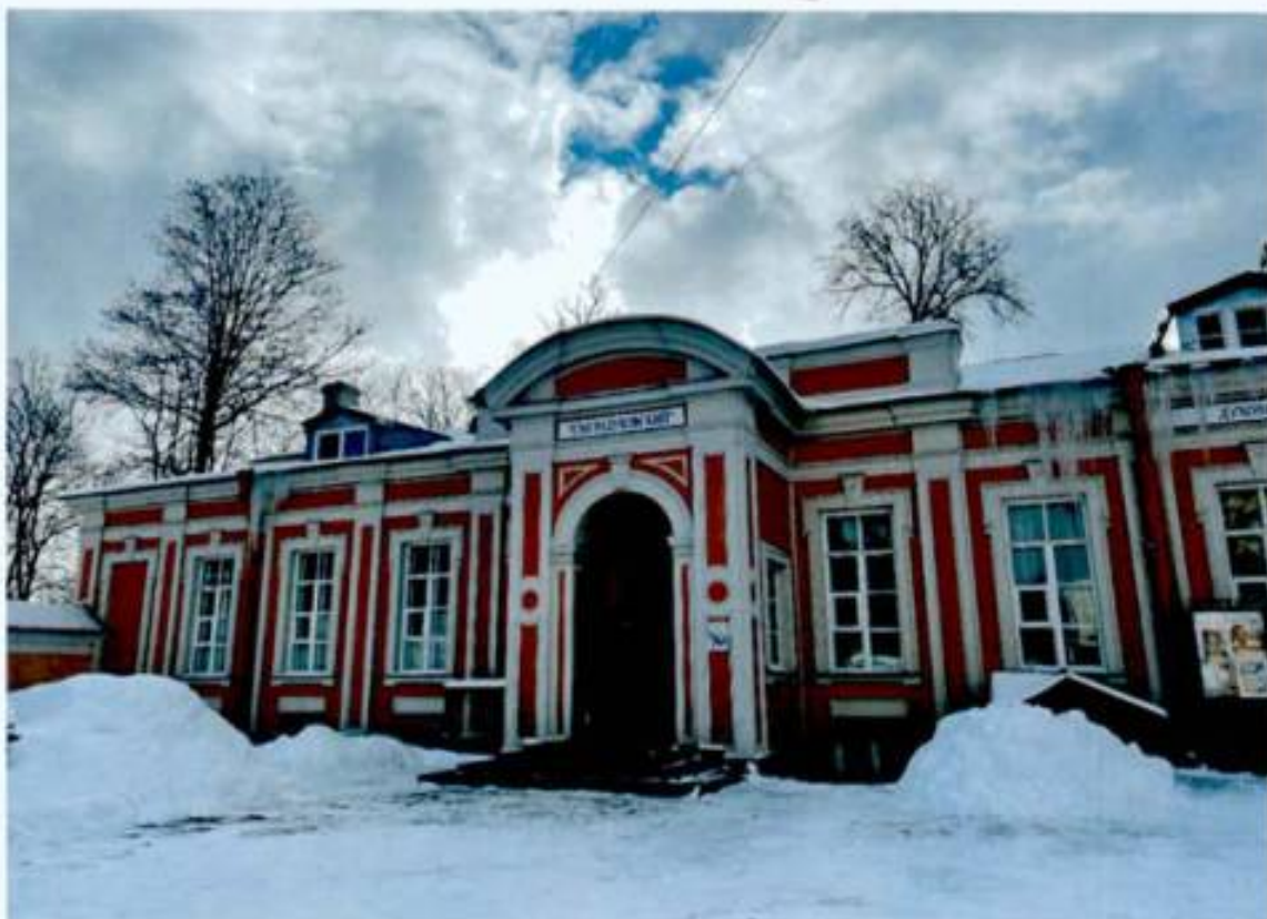
1. Северный фасад объекта культурного наследия.
