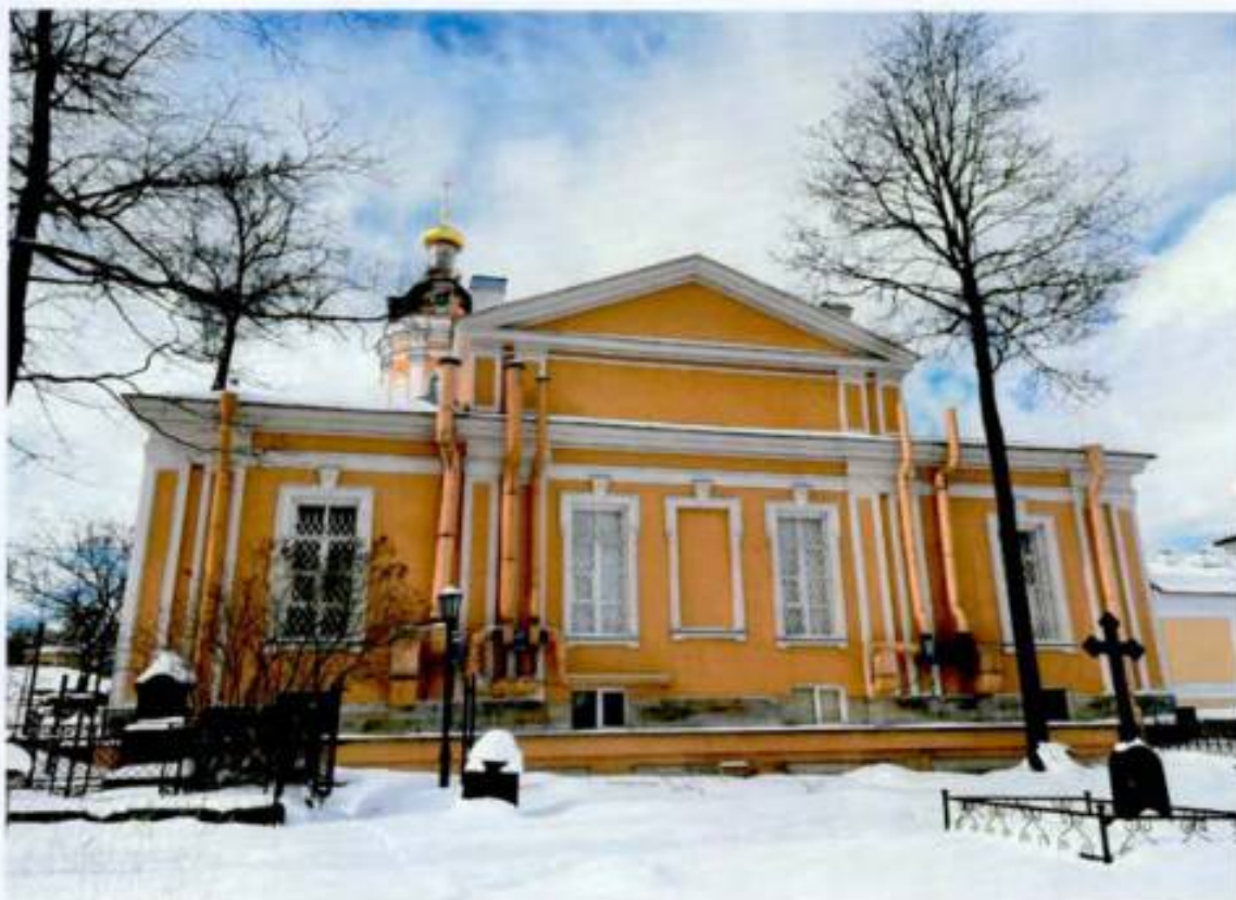
2. Восточный фасад объекта культурного наследия.
