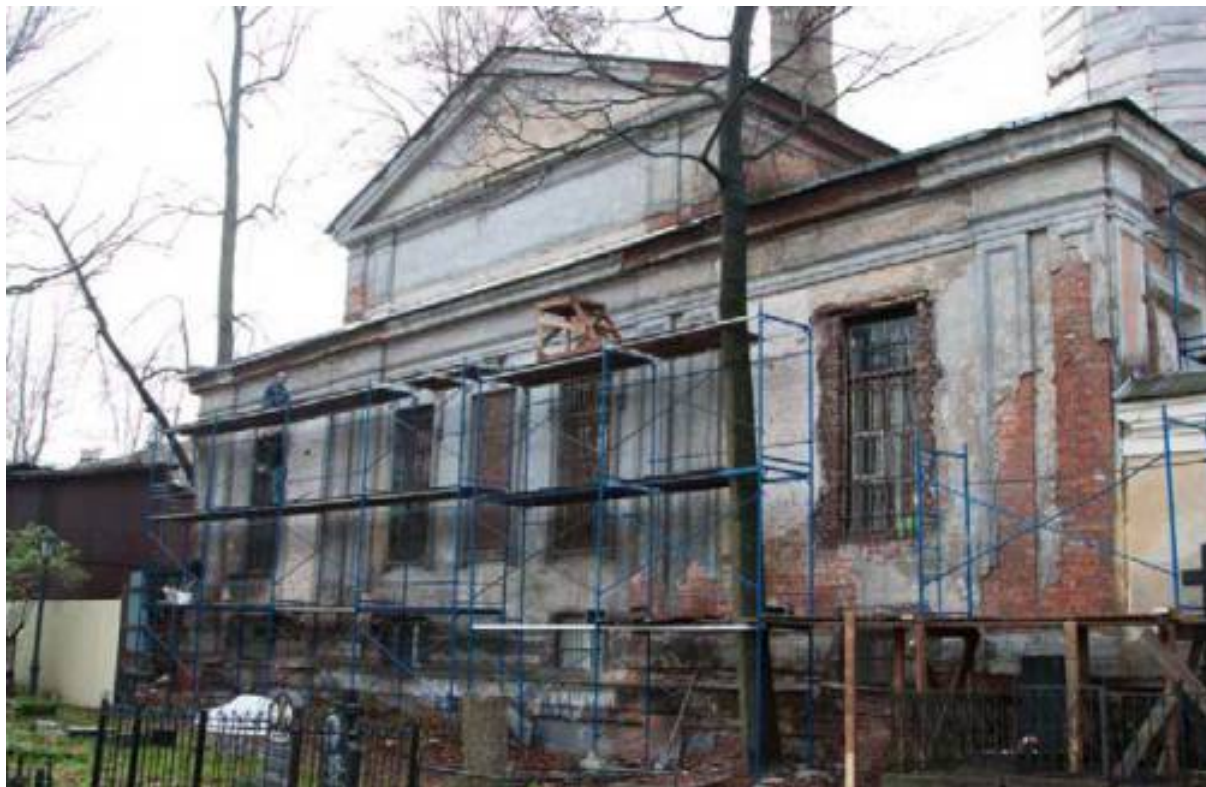
65.Исидоровская церковь. Реставрация фасадов. Вид с северо-востока. Ноябрь 2012 г. (с сайта: https://lavra.spb.ru/ )
