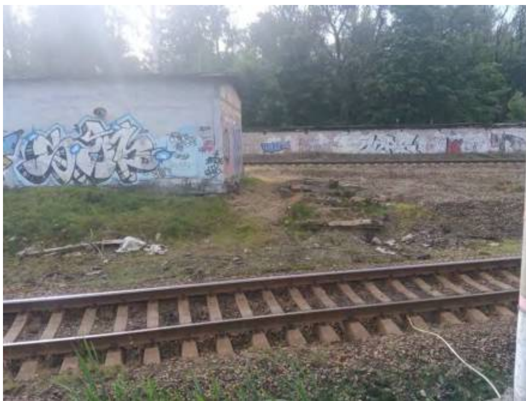
Илл. 10. Точка фотофиксации 6. Общий вид с С.
