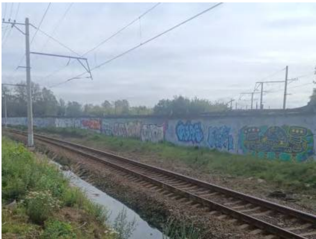
Илл. 13. Точка фотофиксации 8. Общий вид с Ю.
