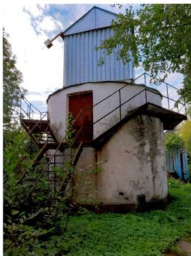
Фото 21: фрагмент объекта: Башня Глазенапа.
