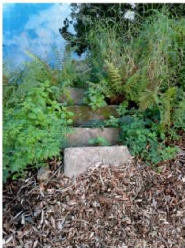
Фото 11: фрагмент объекта: южный лестничный спуск (на южном берегу пруда, западнее моста).
