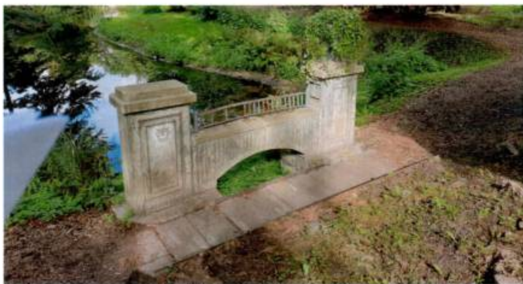
Фото 15: фрагмент объекта: мост.
