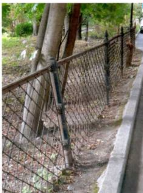
Фото 19: фрагмент объекта: фрагмент исторической чугуной ограды (опорные стойки круглые в сечении с прямоугольными перехватами, контрфорсами и конусообразным навершием).
