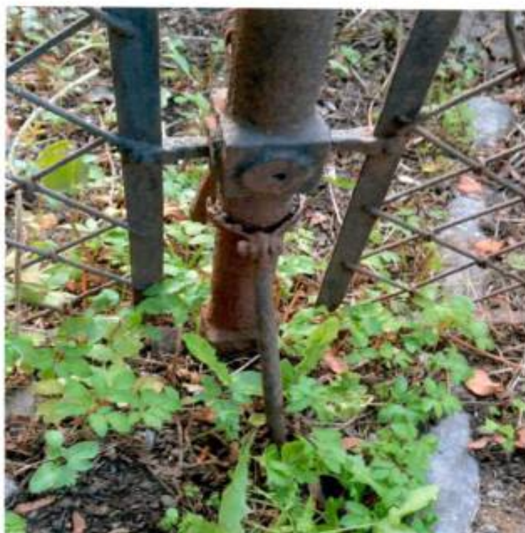
Фото 20: фрагмент объекта: фрагмент исторической чугуной ограды (волотообразный контрфорс с внутренней стороны ограды).
