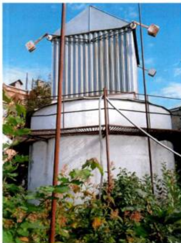
Фото 23: фрагмент объекта: Башня Глазенапа.
