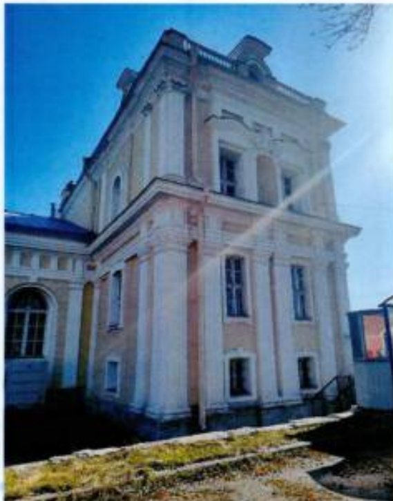
4. Фрагмент юго-западного фасада объекта культурного наследия.
