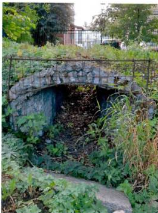
Фото 12: фрагмент объекта: грот (юго-восточная часть объекта).
