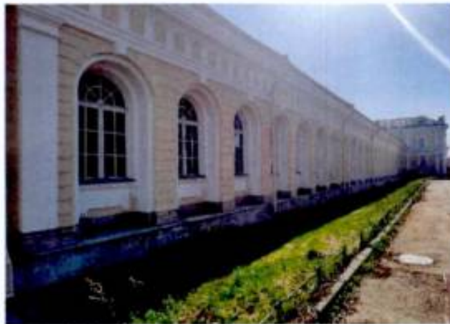
7. Фрагмент юго-западного фасада объекта культурного наследия.
