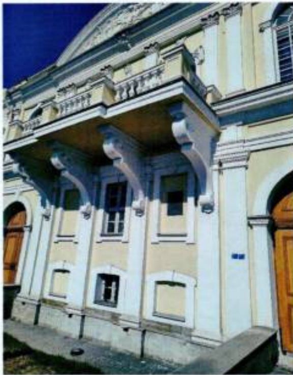
2. Фрагмент южного фасада объекта культурного наследия.
