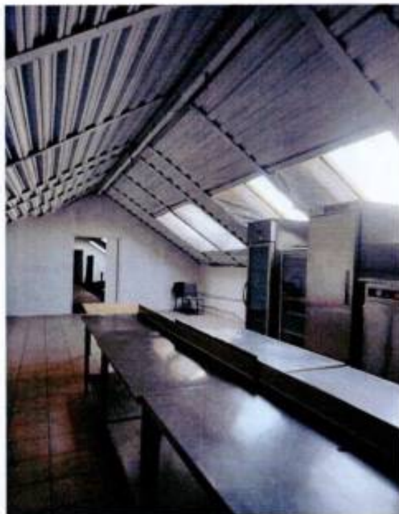
21. Конструкция крыши объекта культурного наследия.
