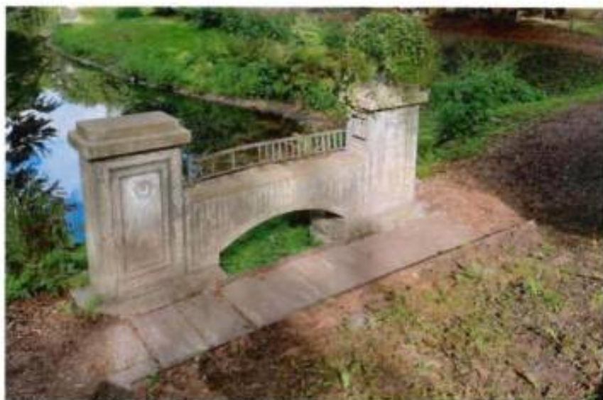
Фото 11: фрагмент объекта культурного наследия: мост.
