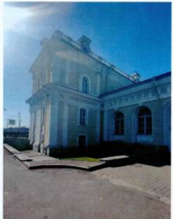
5. Фрагмент северо-восточного фасада объекта культурного наследия.
