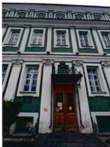
4. Фрагмент фасада с юго-восточной стороны.
