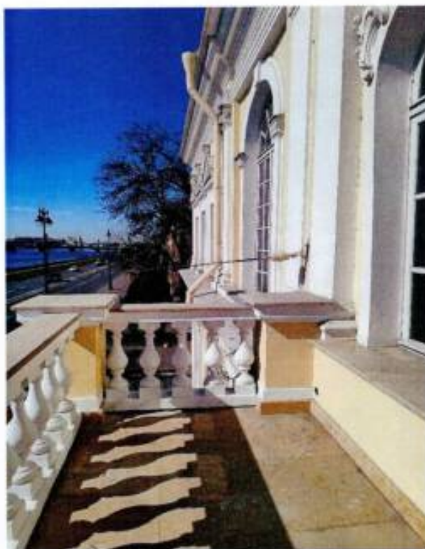
19. Балкон объекта культурного наследия.
