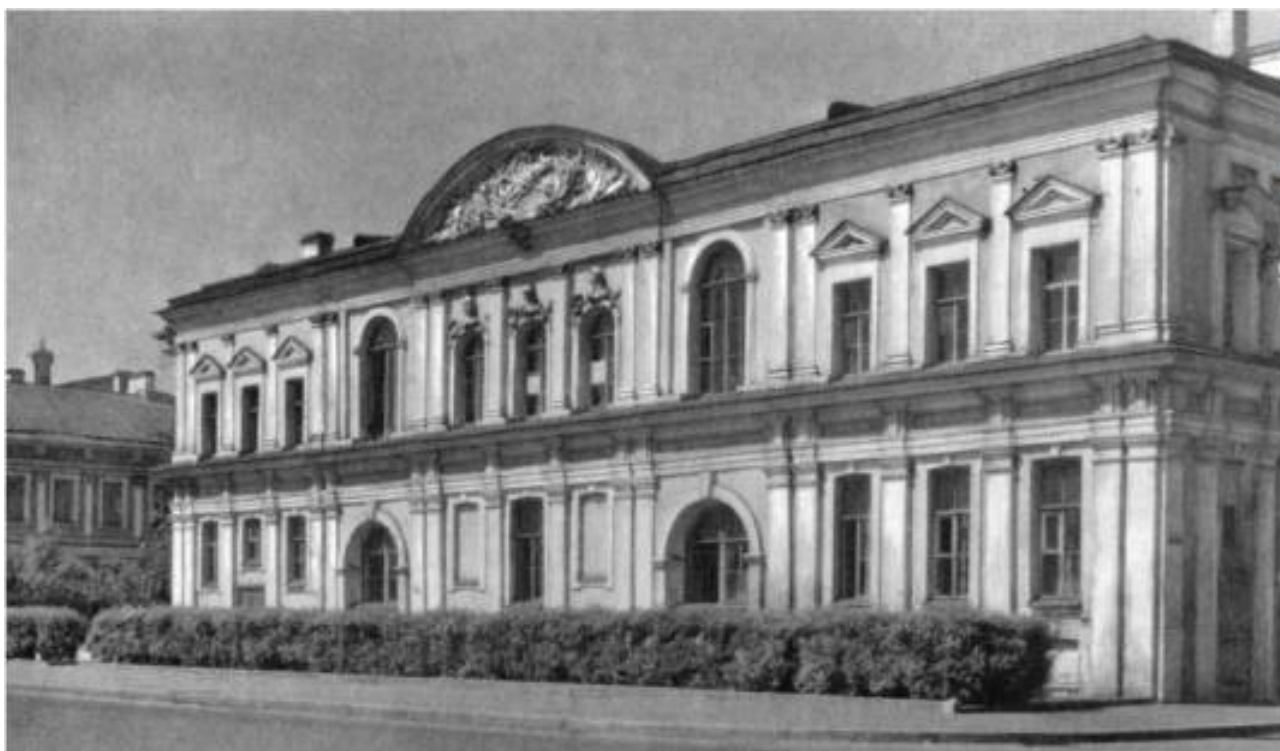
83. Манеж 1-го Кадетского корпуса на Университетской набережной. 1973 г. Citywalls: Архитектурный сайт Санкт-Петербурга [Электронный ресурс]. URL: https://www.citywalls.ru/
