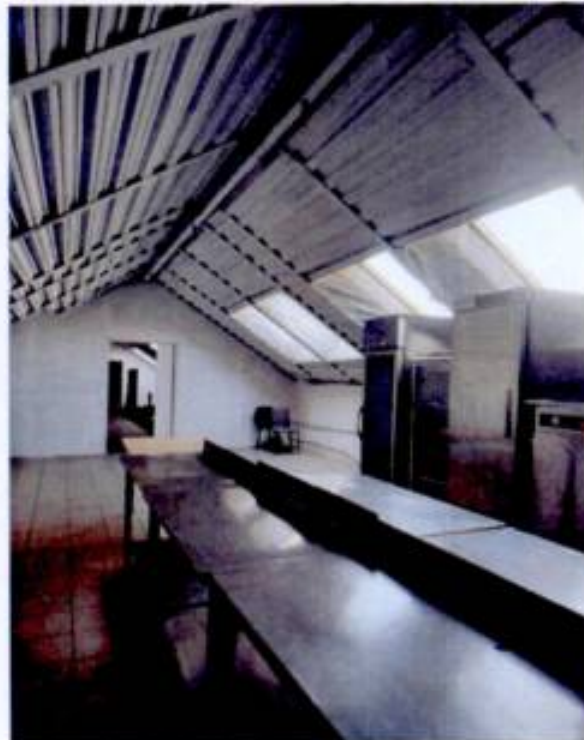
15. Конструкция крыши объекта культурного наследия.
