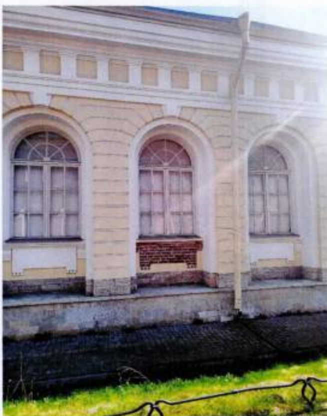
9. Фрагмент юго-западного фасада объекта культурного наследия.
