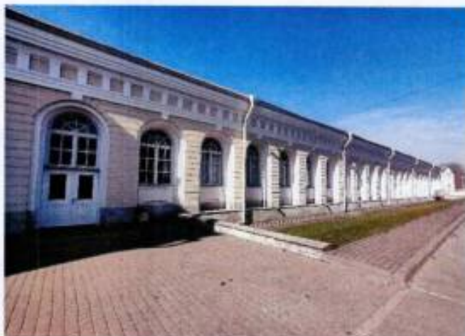
6. Фрагмент северо-восточного фасада объекта культурного наследия.
