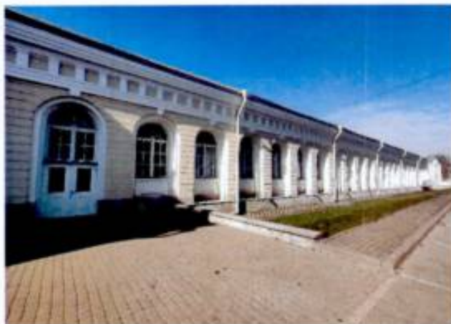
6. Фрагмент северо-восточного фасада объекта культурного наследия.
