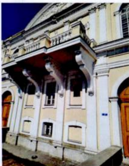
2.Фрагмент южного фасада объекта культурного наследия.
