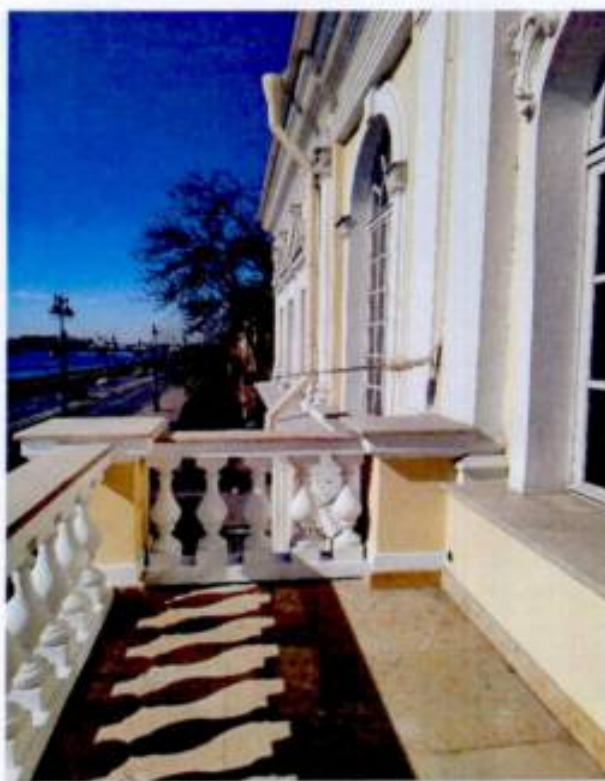
13. Балкон объекта культурного наследия.
