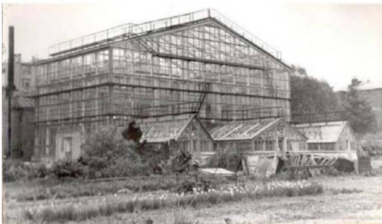
73. Оранжерея. Весна 1974 г. Оранжерея в основном остеклена, идут работы по электрике и сантехнике. Автор съёмки: А. Осипова. Из материалов директора Ботанического сада Д.М. Залесского. Музей истории СПбГУ.
