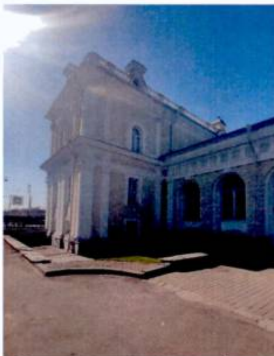
5. Фрагмент северо-восточного фасада объекта культурного наследия.
