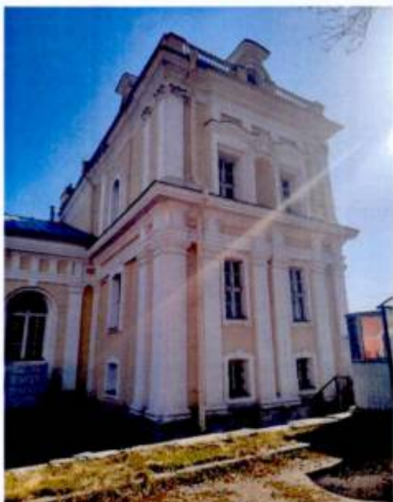
4. Фрагмент юго-западного фасада объекта культурного наследия.
