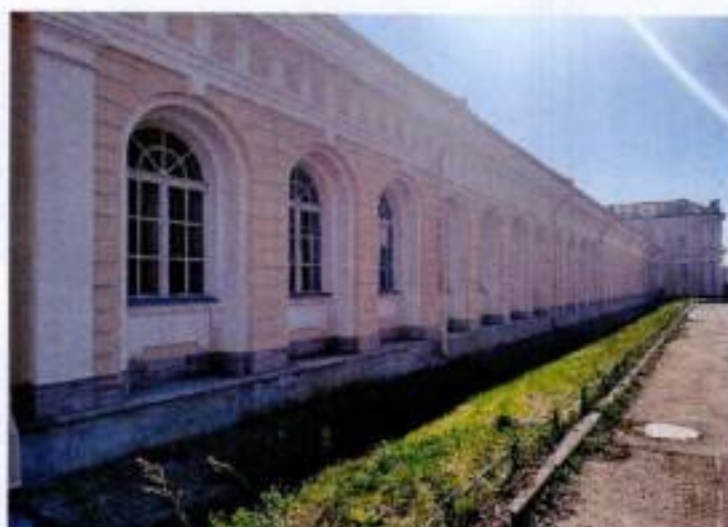
7. Фрагмент юго-западного фасада объекта культурного наследия.
