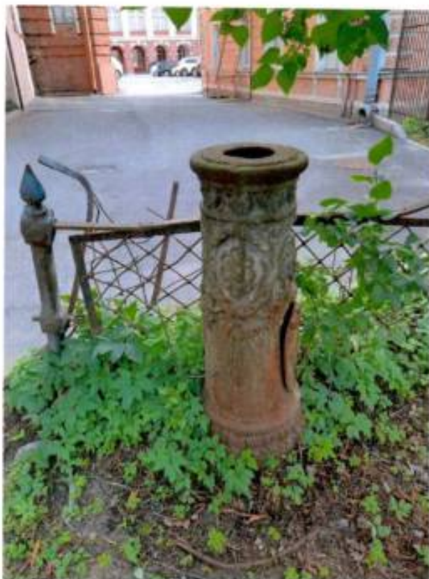
Фото 16: фрагмент объекта: фрагмент исторической чугуной фонарной опоры.
