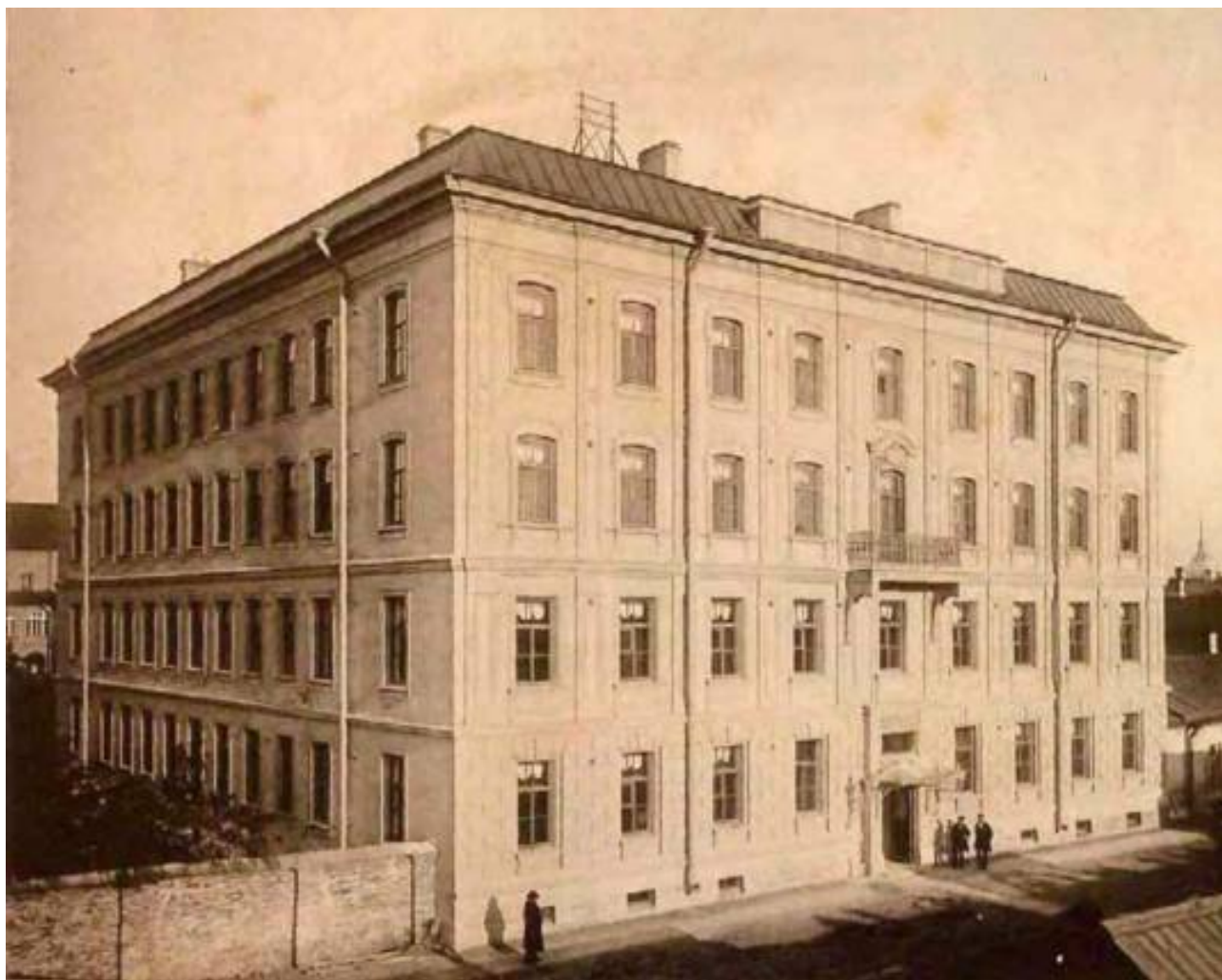
33. Здание Александровской коллегии. 1882 г. Из кн.: Аничков Н. Краткий отчёт по постройке здания Коллегии императора Александра II для студентов С.-Петербургского университета. СПб., 1882. С. 2.
