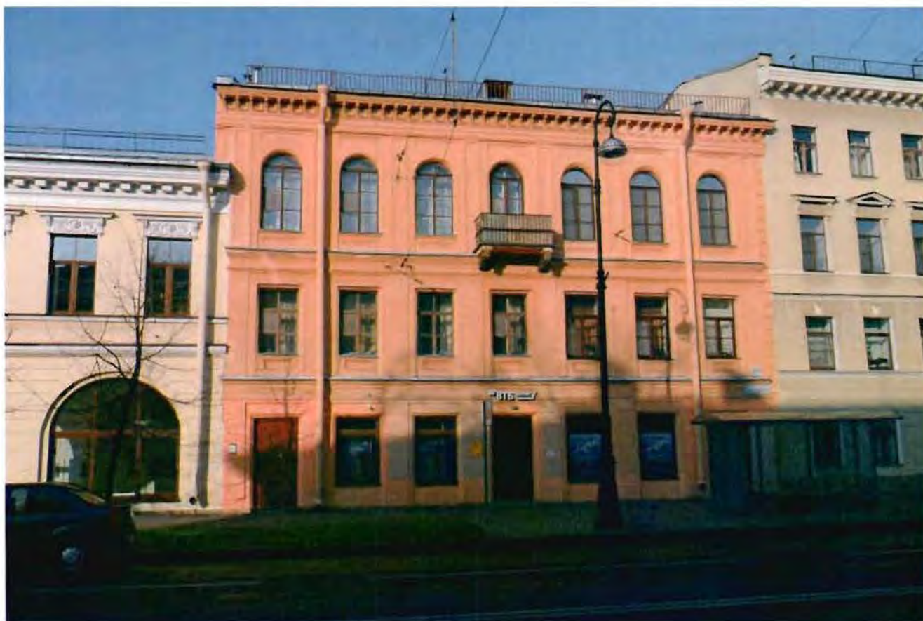
1. Общий вид с юго-востока.
