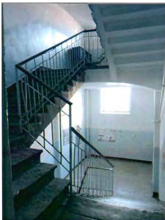
5. Интерьер. Фрагмент. Лестница.
