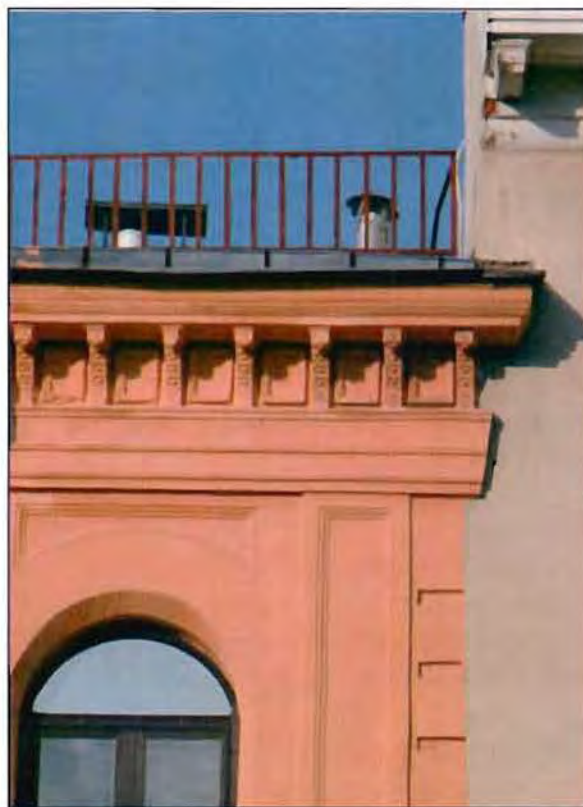
3. Общий вид с юго-востока. Фрагмент. Венчающий карниз.
