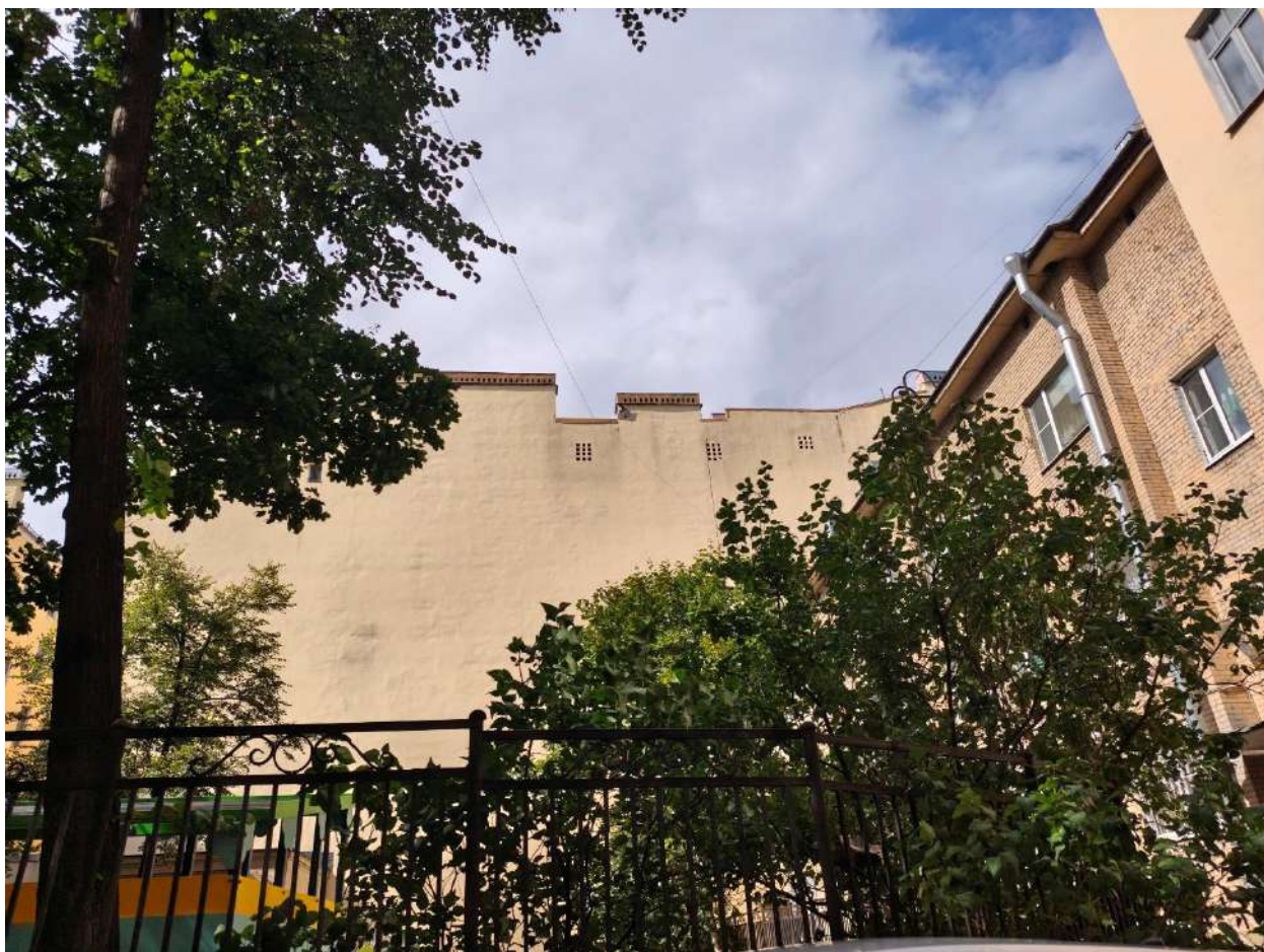
Фото 15. Вид на брандмауэрную стену выявленного объекта культурного наследия «Дом Ф.Л. и Д.Л. Парфеновых».
