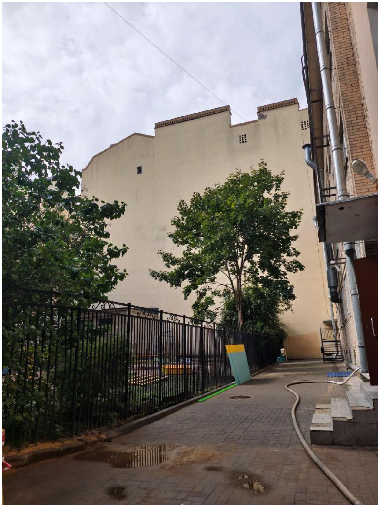
Фото 14. Вид на брандмауэрную стену выявленного объекта культурного наследия «Дом Ф.Л. и Д.Л. Парфеновых».
