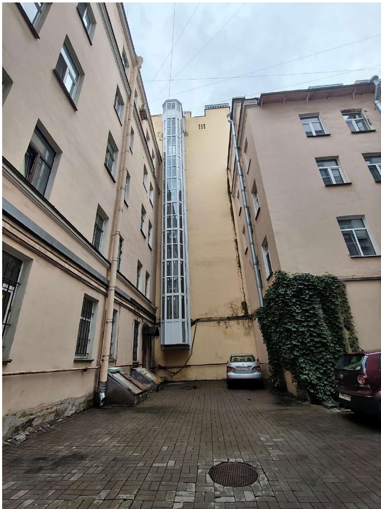
Фото 17. Вид на дворовые фасады выявленного объекта культурного наследия «Дом Ф.Л. и Д.Л. Парфеновых».
