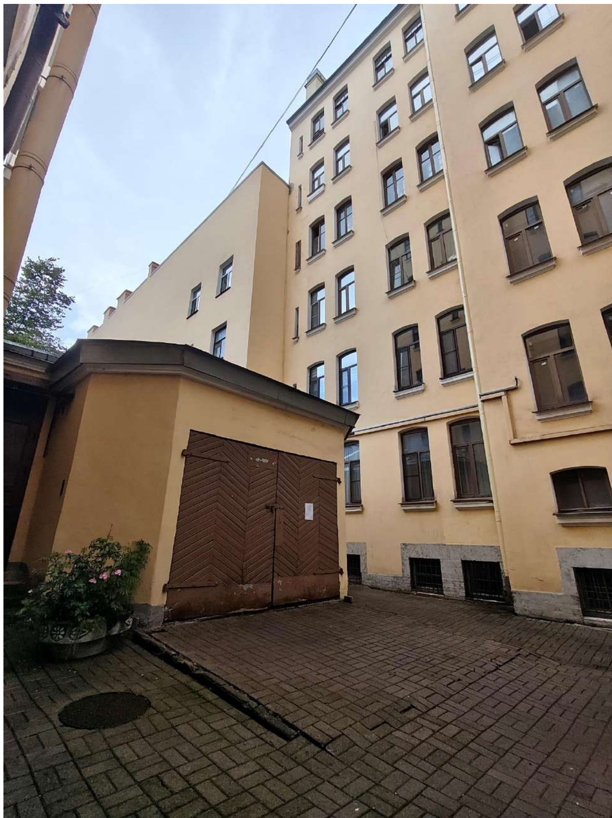
Фото 12. Вид на дворовые фасады выявленного объекта культурного наследия «Дом Ф.Л. и Д.Л. Парфеновых».
