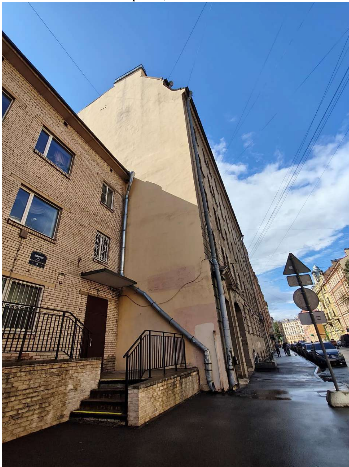
Фото 1. Вид на брандмауэрную стену выявленного объекта культурного наследия «Дом Ф.Л. и Д.Л. Парфеновых» по Конной улице.
