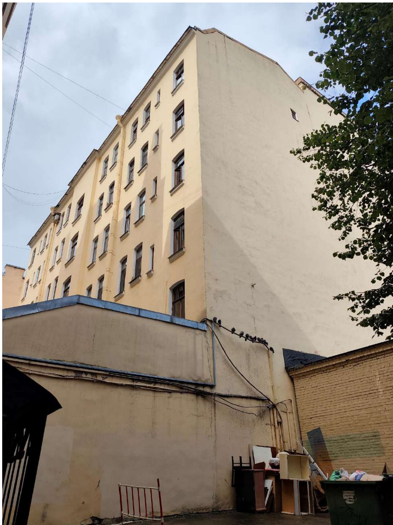
Фото 16. Вид на дворовые фасады выявленного объекта культурного наследия «Дом Ф.Л. и Д.Л. Парфеновых»
