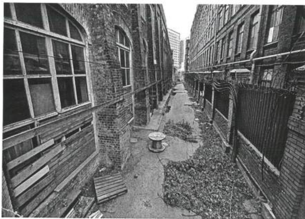
7. Фрагмент восточного фасада.
