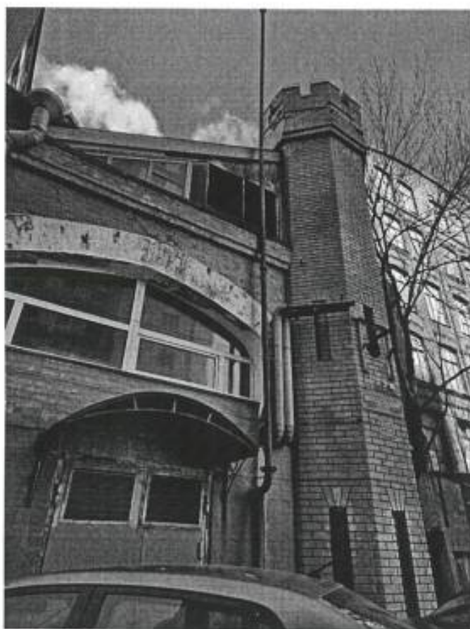
5. Фрагмент южного лицевого фасада.
