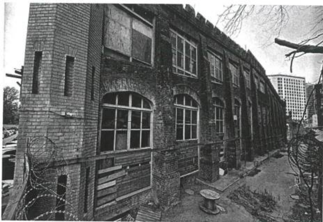
8. Фрагмент восточного фасада.
