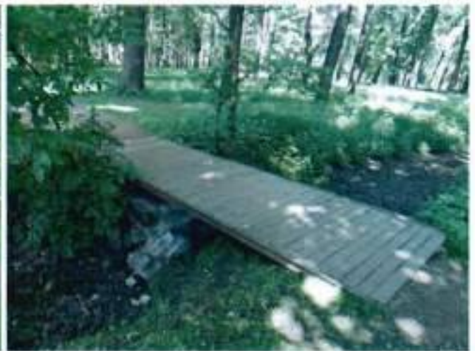
14. Деревянный мостик через протоку между прудами.
