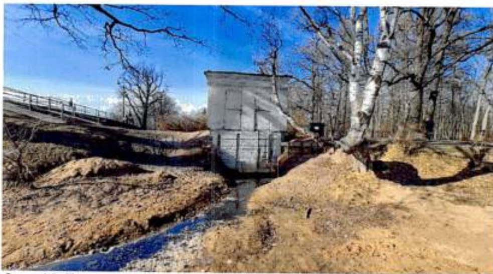
Фото 15. Будка с шандорами.
