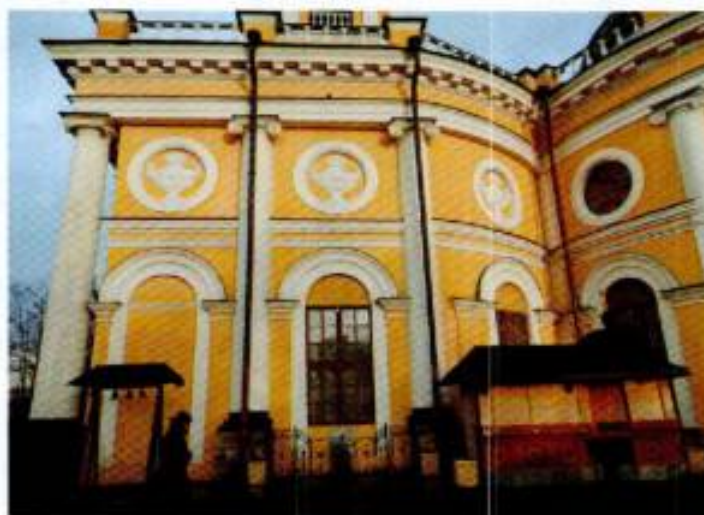
2. Фрагмент южного фасада.
