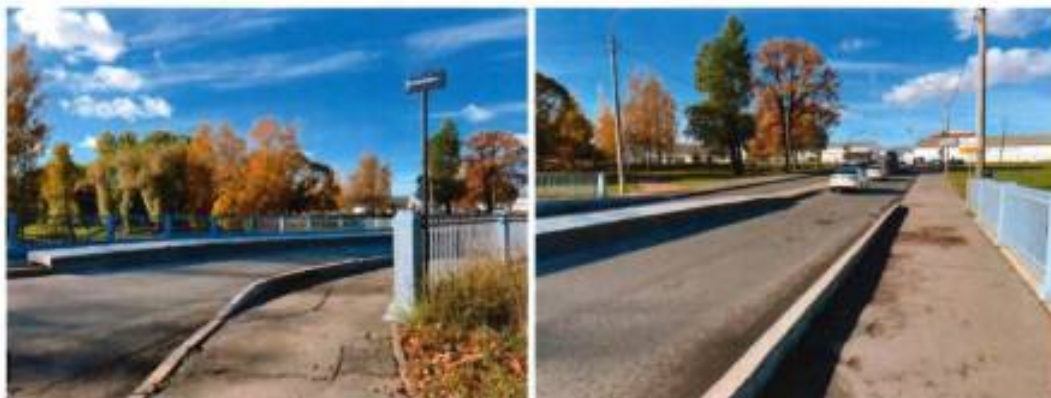
3-4. Общий вид на мостовое полотно.
