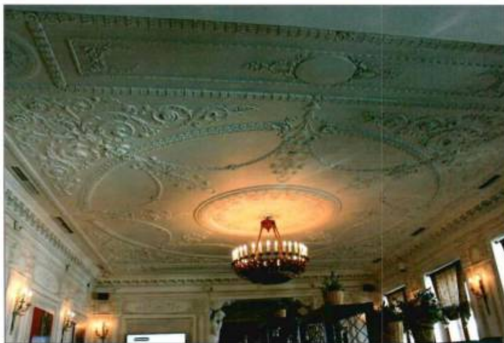
Фото №3, 4. Помещение 58-Н (1) 2-го этажа.
