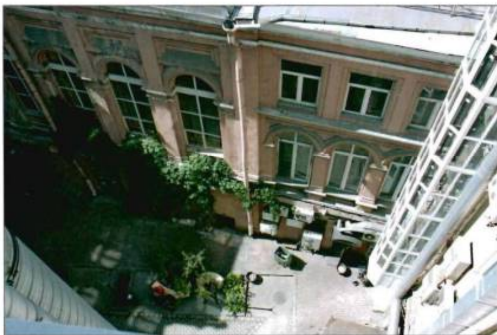
Фото №20. Северный внутренний двор.
