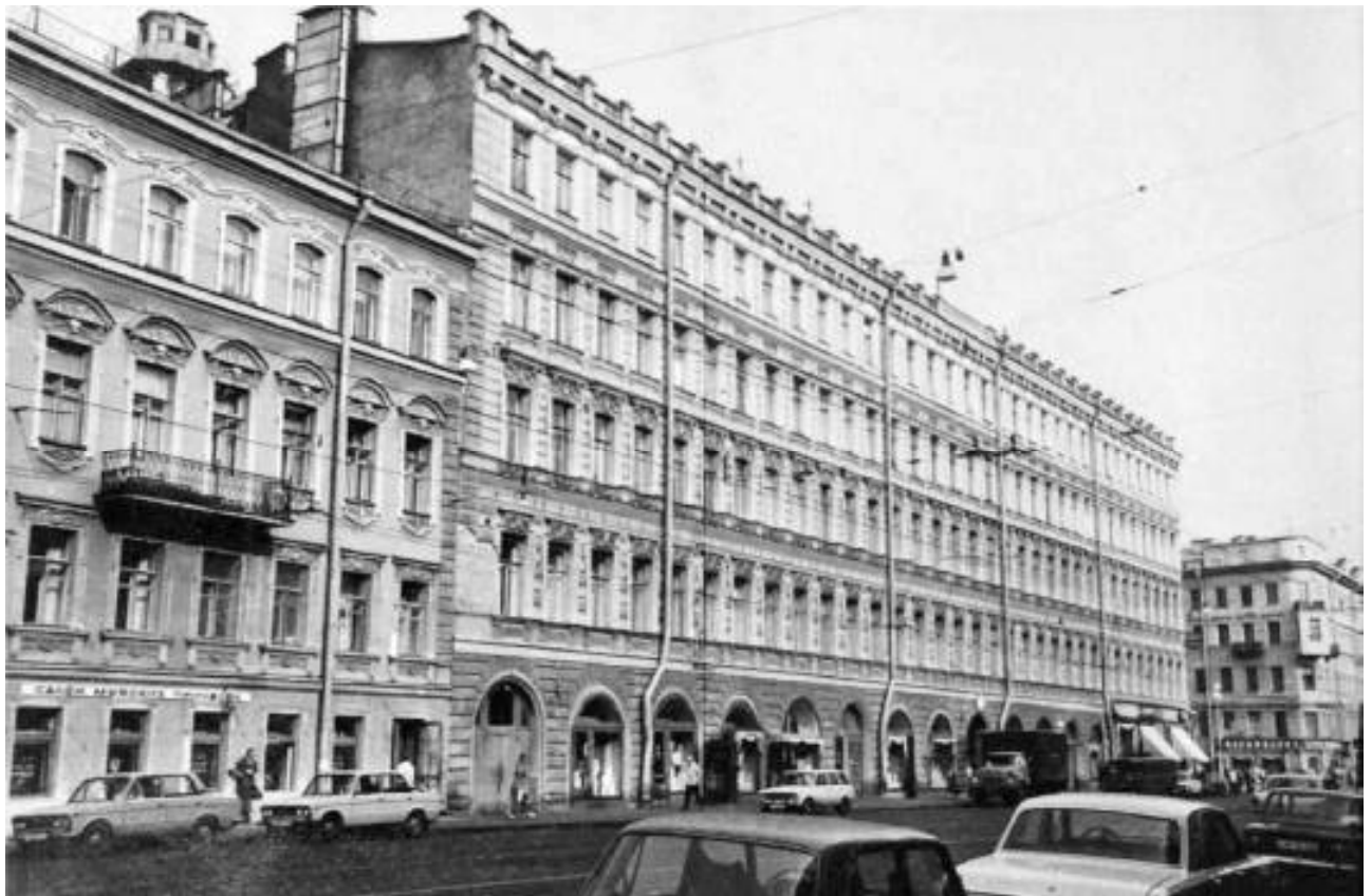
Илл.73. Фасад жилого дома на Владимирском проспекте. Фото 1970-е гг. ЦГАКФФД СПб. Фотодокументы. Опись 1АР-144. Ед.хр.189824.
