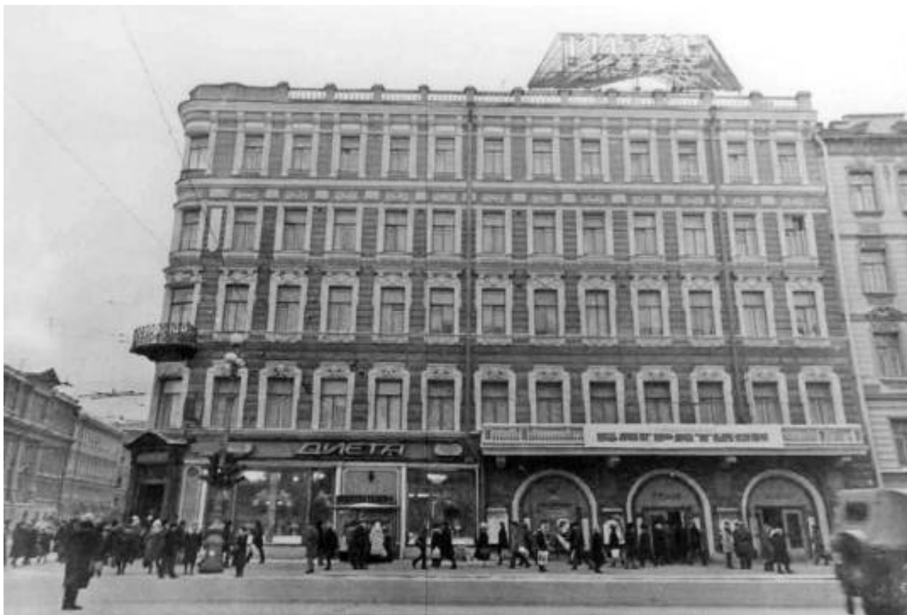
Илл.75. Общий вид здания кинотеатра «Титан». Невский проспект, 47/1. Фото 1985 г. ЦГАКФД СПб. Фотодокументы. Опись 1АР-157. Ед.хр.228013.
