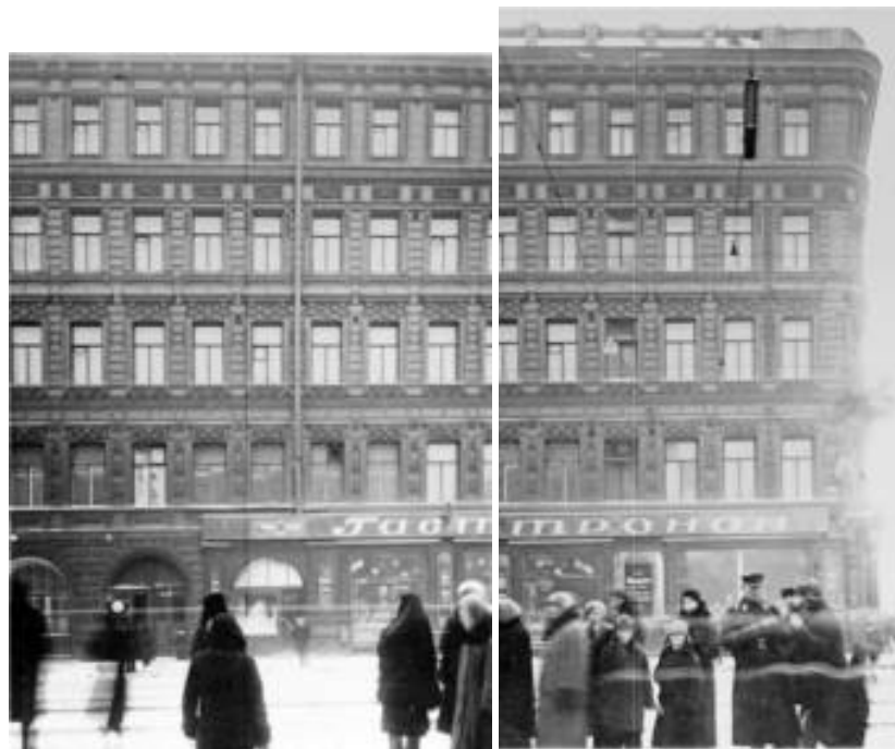
Илл.70. Фрагменты фасада дома №1 на проспекте Нахимсона (дом К.П. Палкина, арх. Кейзер А.К. (1873-1874 гг.), Хренов А.С. (реконструкция 1904-1905 гг.). Фото 1938 г. ЦГАКФФД СПб. Фотодокументы. Описание 1ГР-46. Ед.хр. 69068, 69067.
