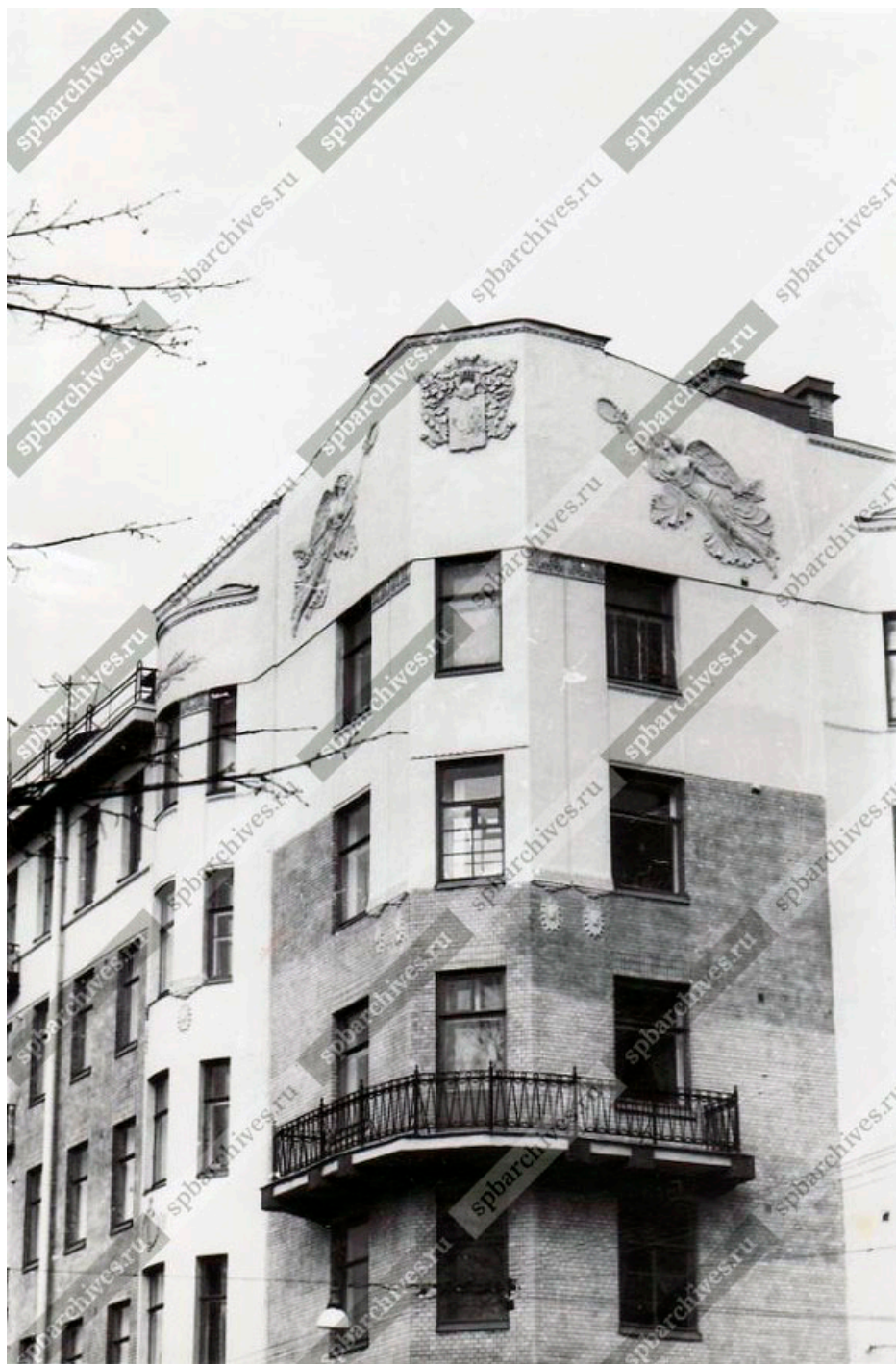
Илл. 22. Вид углового фасада дома № 37, корп., 2 по Таврической и Тверской улицам ( бывший доходный дом А.С. Обольянинова, архитектор А.Ф. Бубырь, 1907-1908 гг.). 09 апреля 1978 г. ЦГАКФФД СПб. Фотодокументы. Опись 1АР-154. Ед. хр. 215080.
