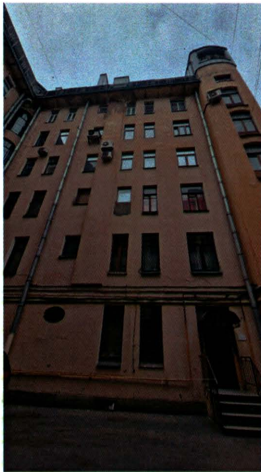
4. Северный дворовой фасад (Фотография от 06.05.2024).
