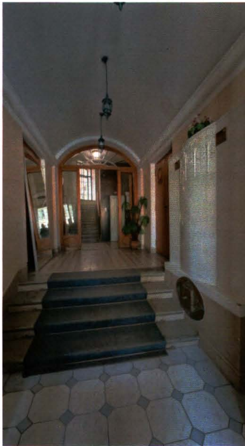
8. Лестница 4ЛК (Фотография от 14.05.2024).
