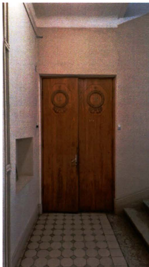
9. Двухстворчатые глухие заполнения дверных проемов квартир. (Фотография от 14.05.2024).
