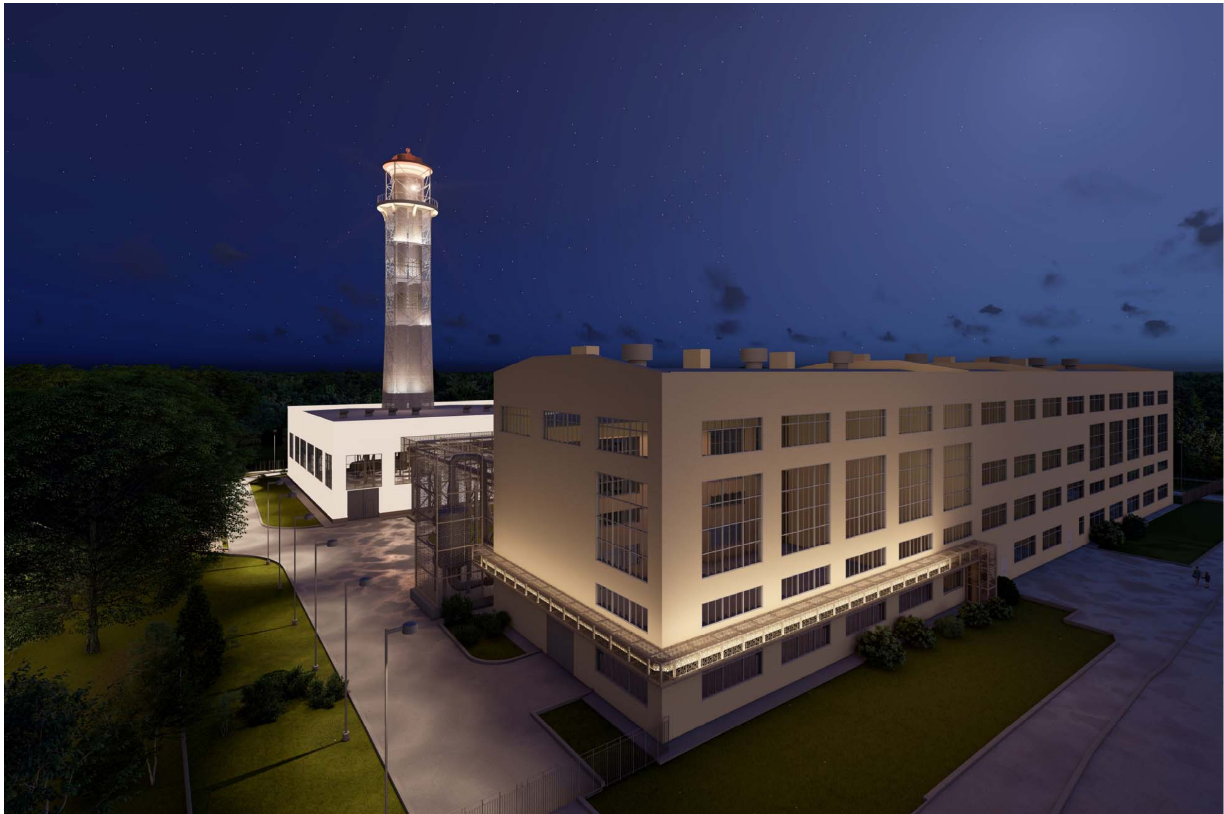
Ночной вид на котельную со стороны ул. Цитадельской
