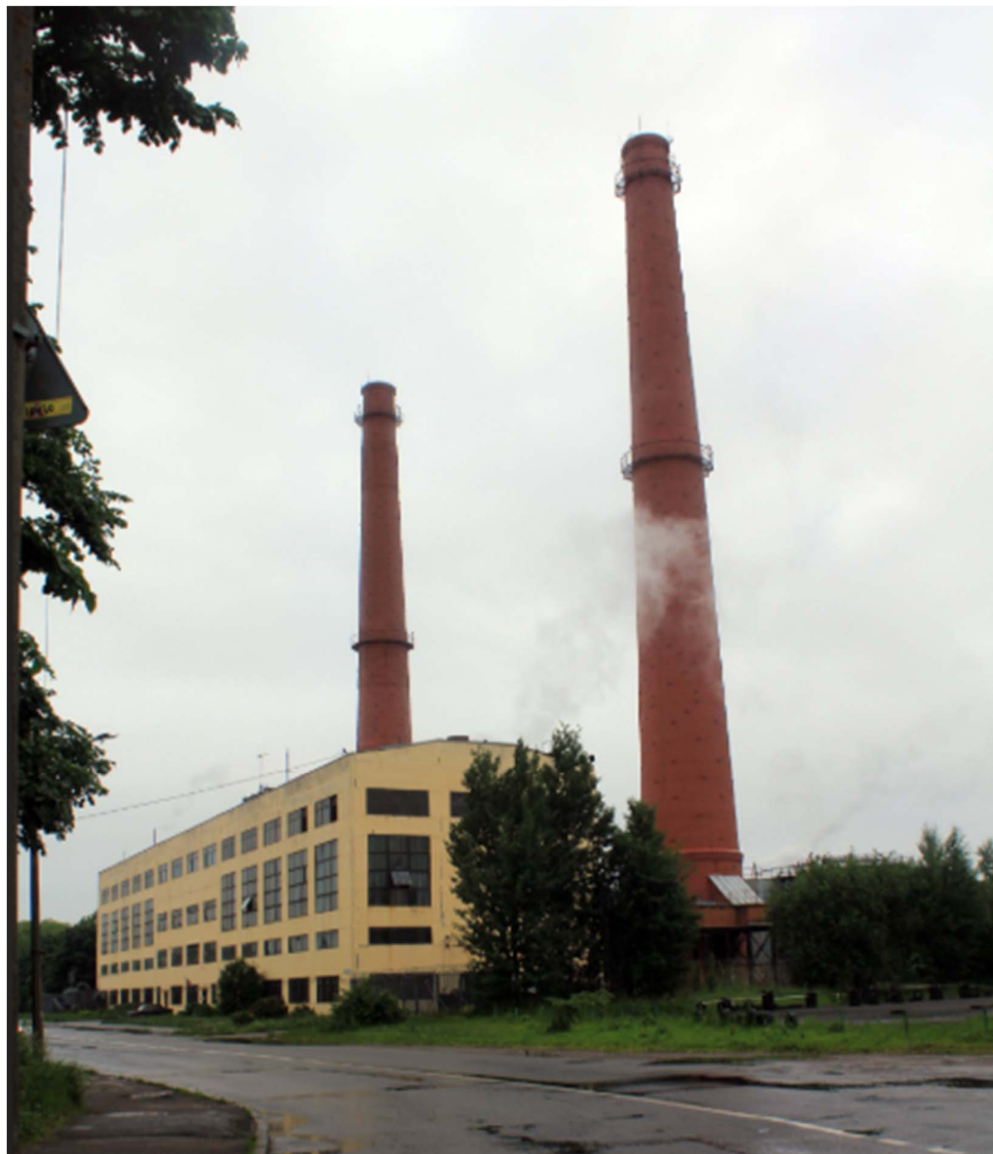
Фото 5. Существующий вид на котельную со стороны Цитадельского ш.
