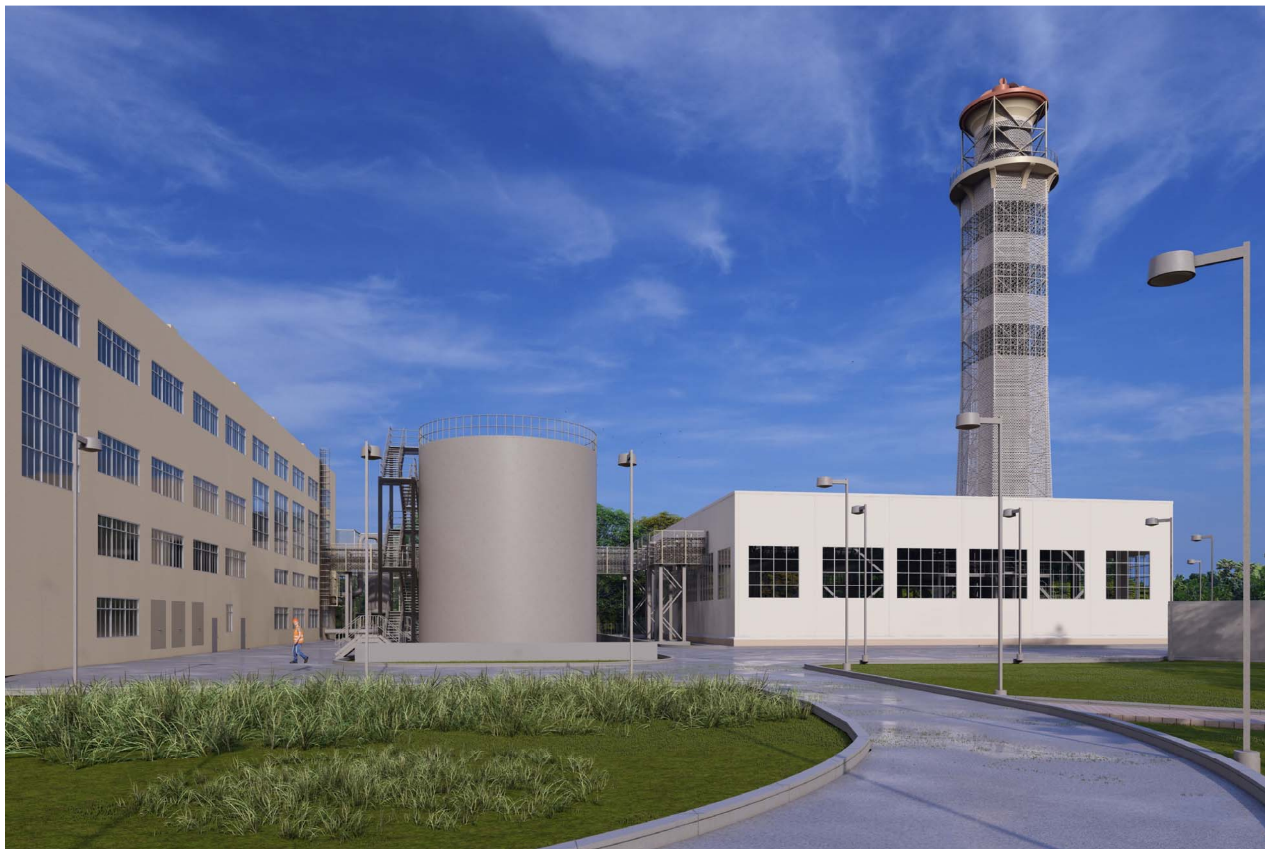
Вид территории котельной после реконструкции
