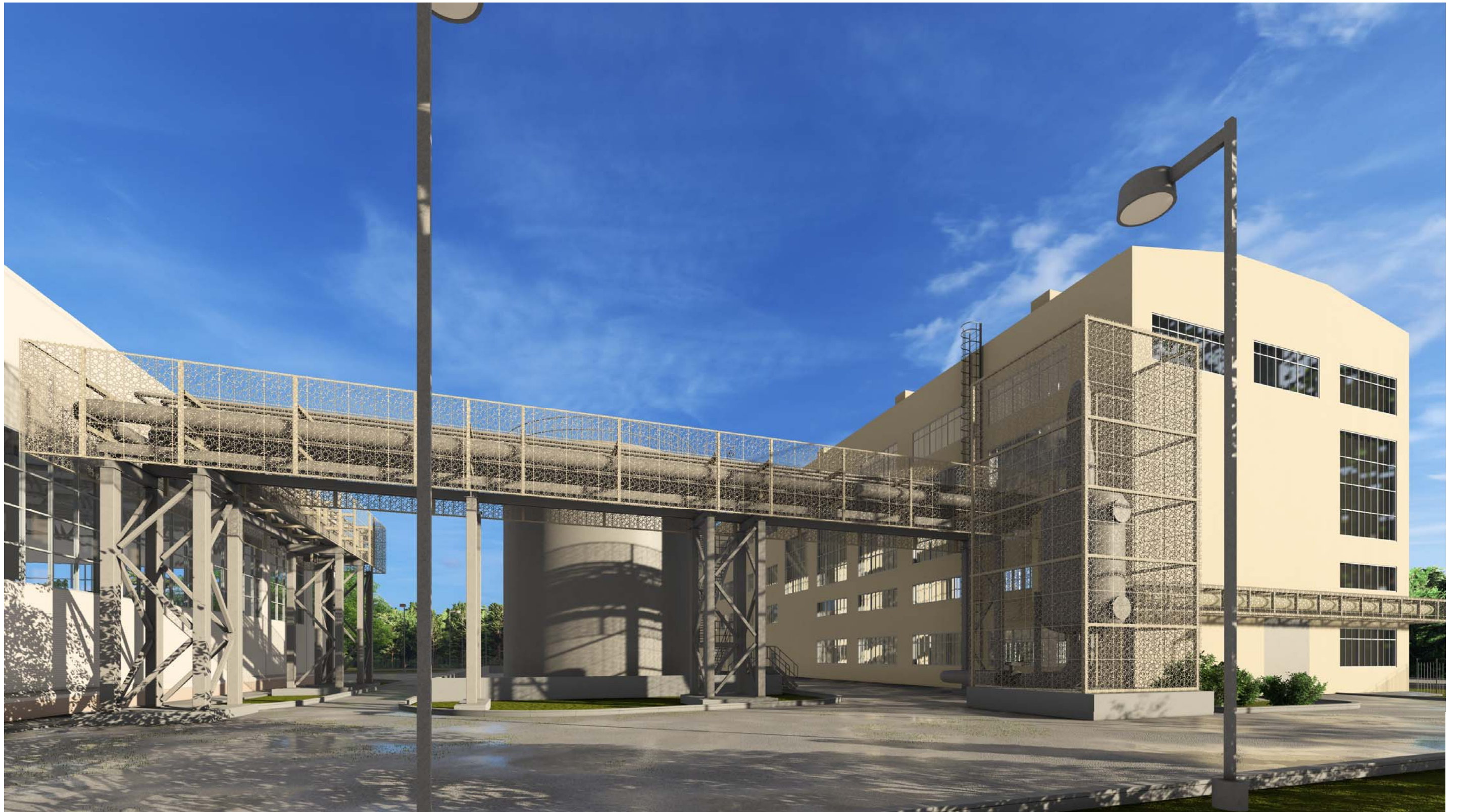
Вид территории котельной после реконструкции
