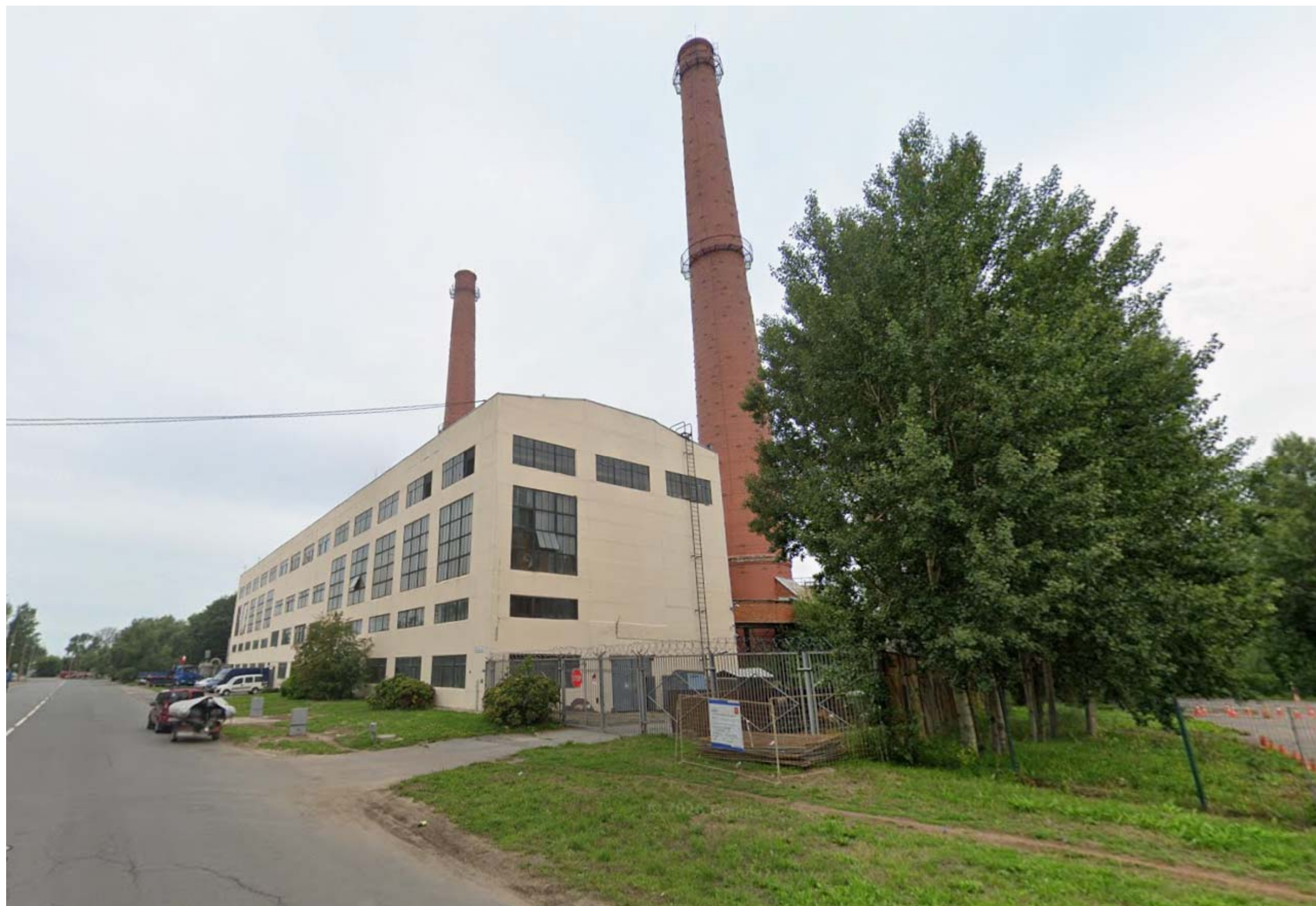
Фото 3. Существующий вид на котельную со стороны Цитадельского ш.
