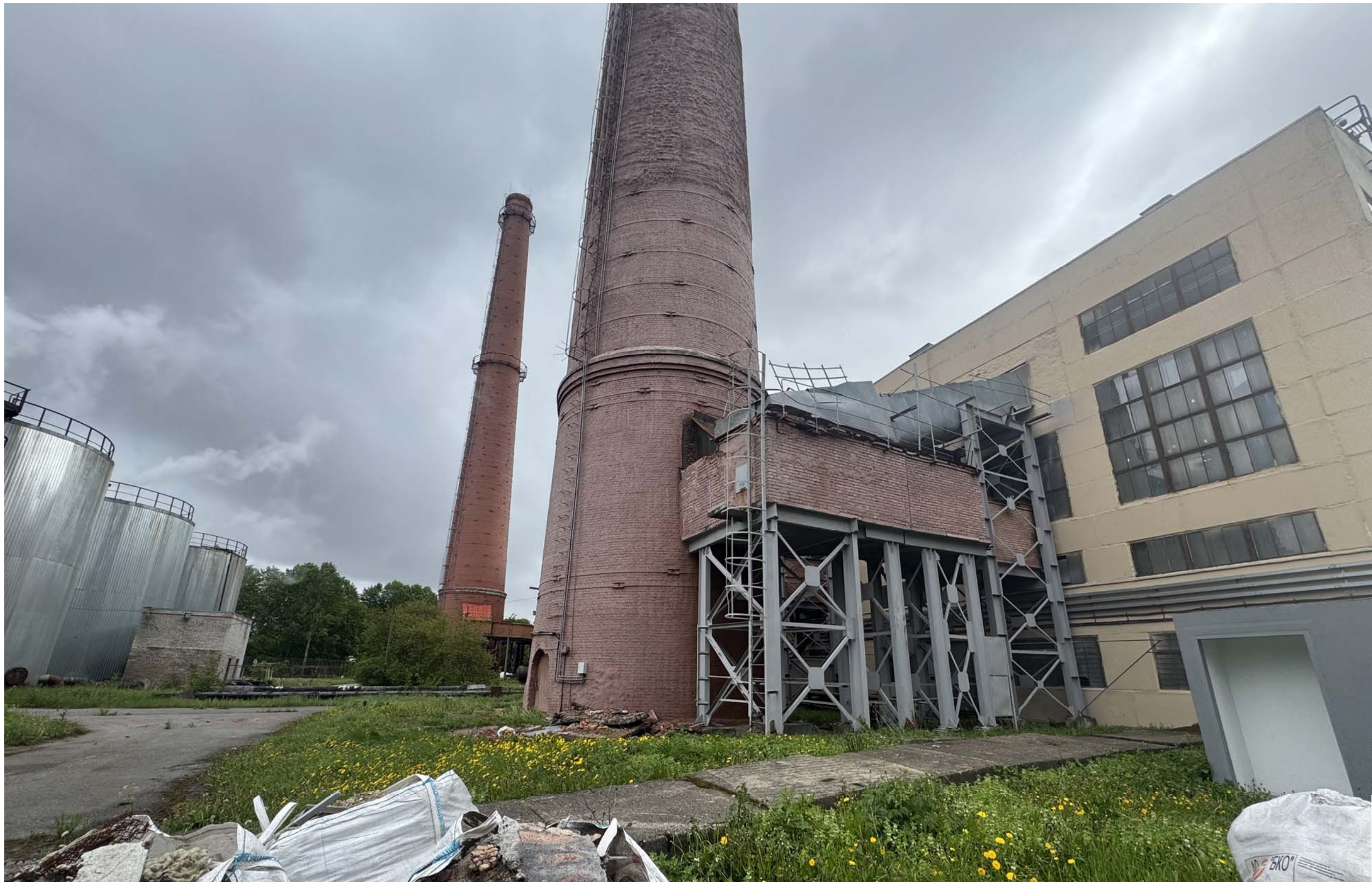
Фото 7. Существующий вид территории котельной
