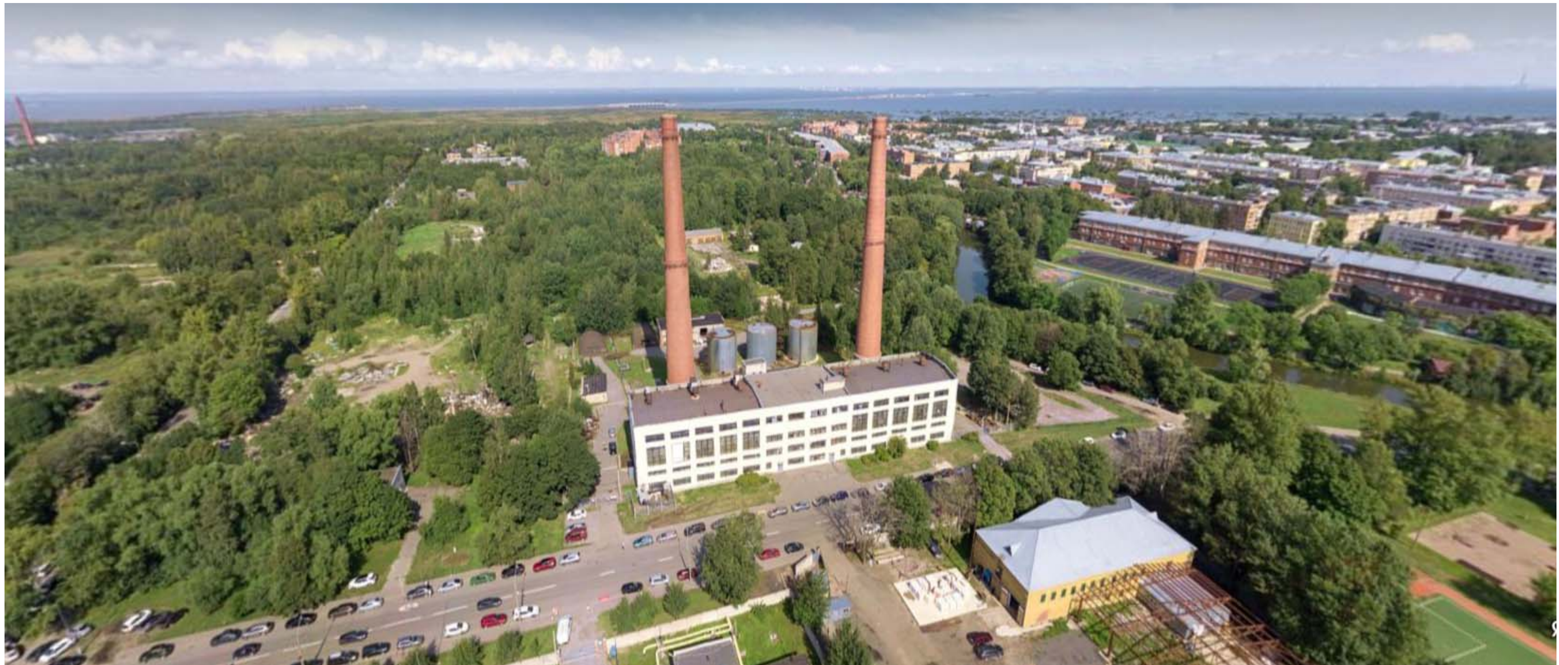
Фото1. Общий вид существующей котельной
