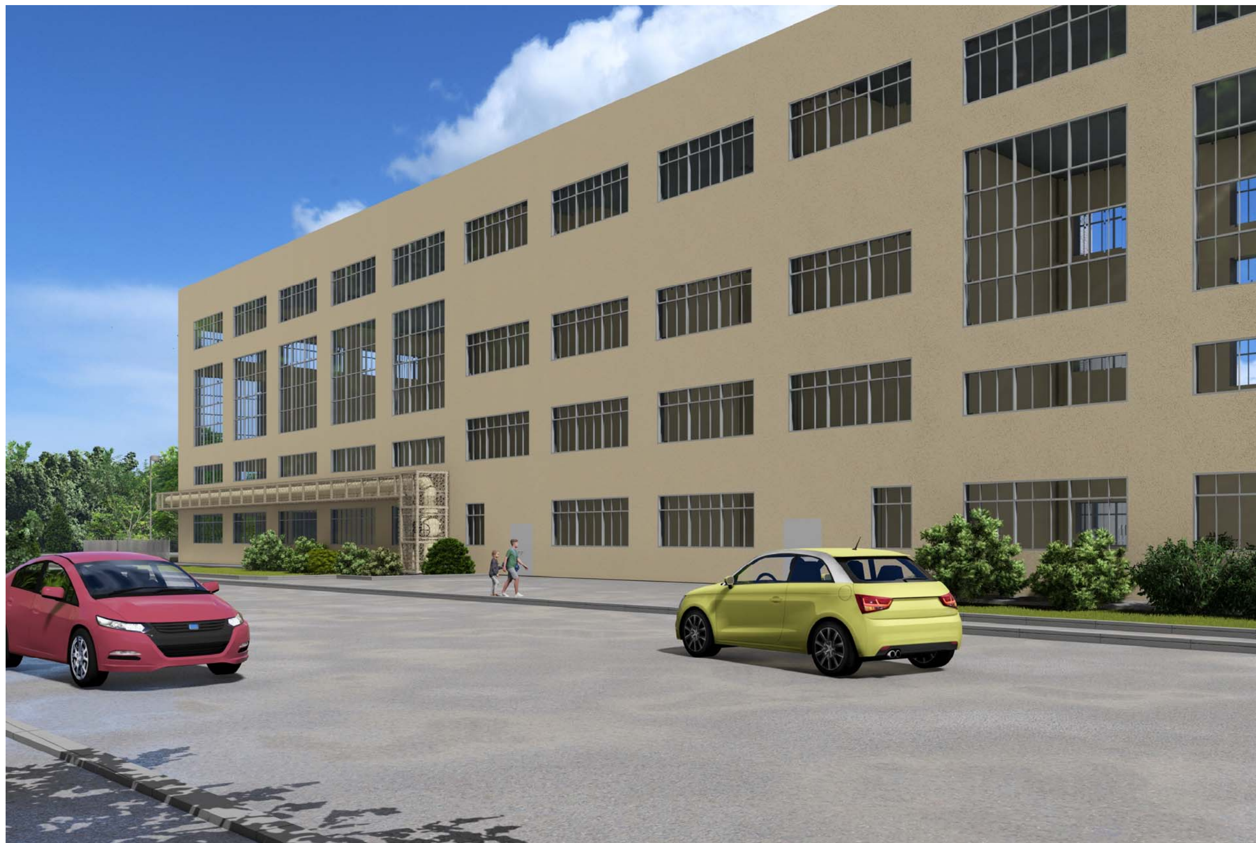
Вид на котельную со стороны Цитадельского ш. после реконструкции
