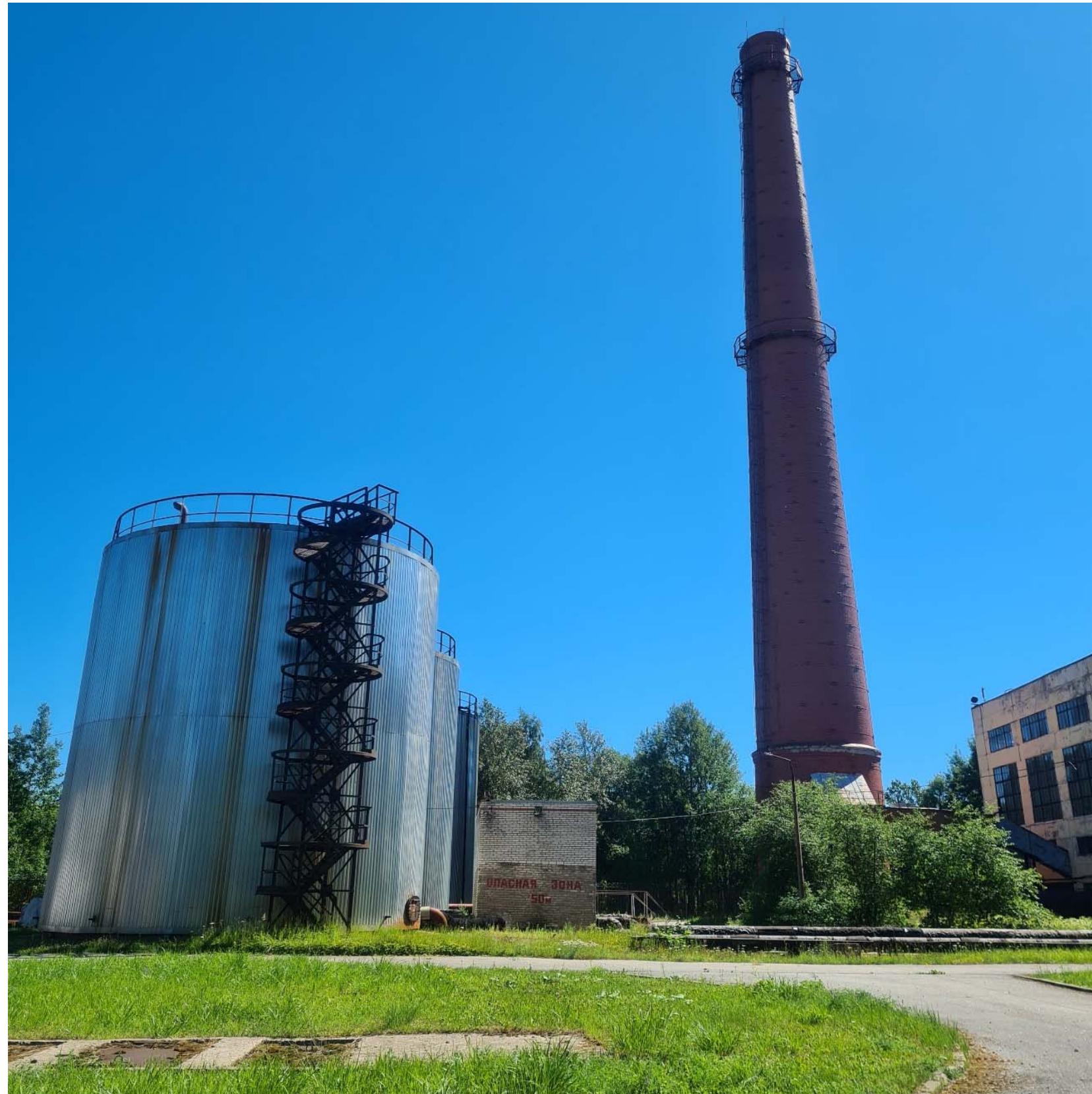
Фото 6. Существующий вид территории котельной
