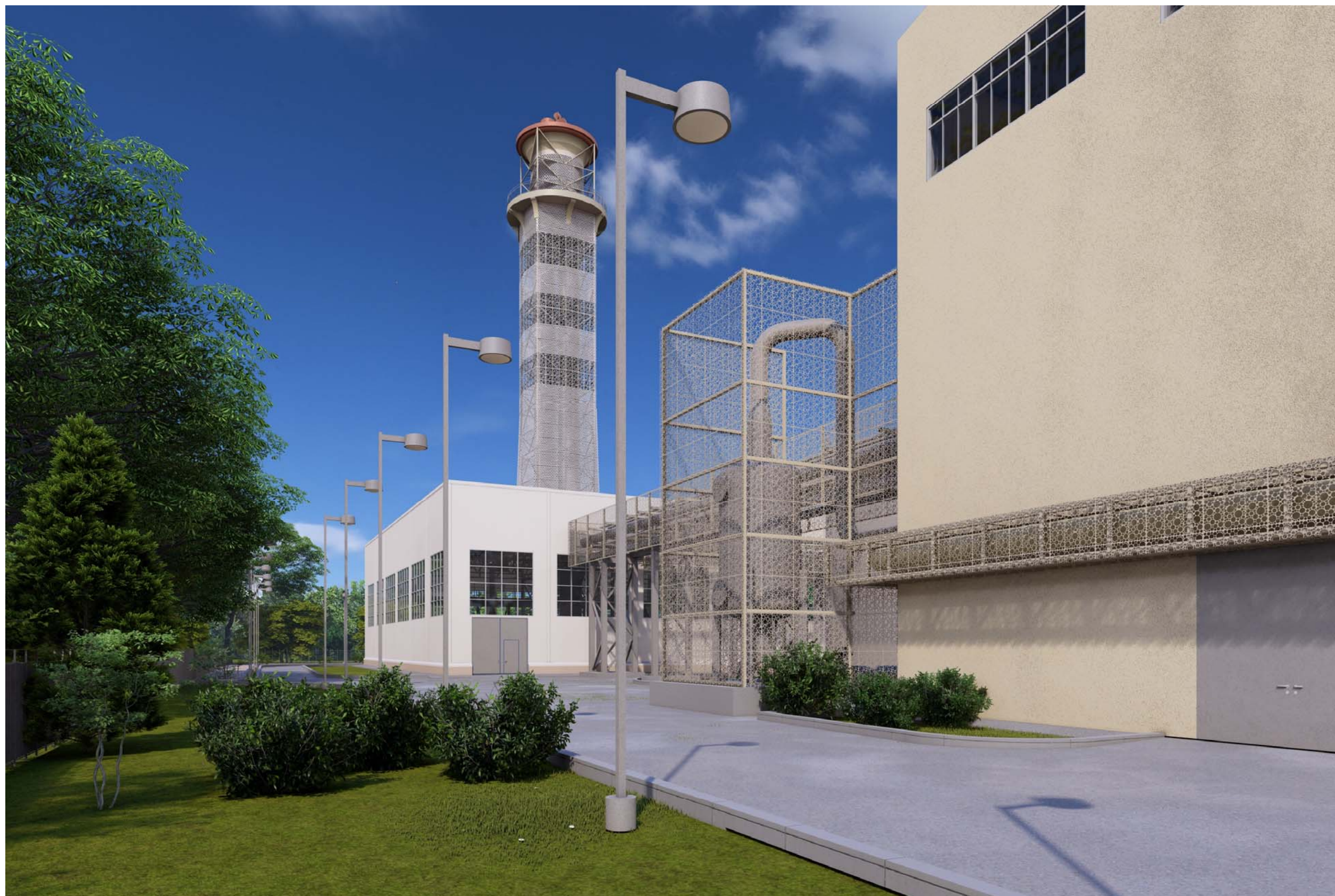
Вид территории котельной после реконструкции
