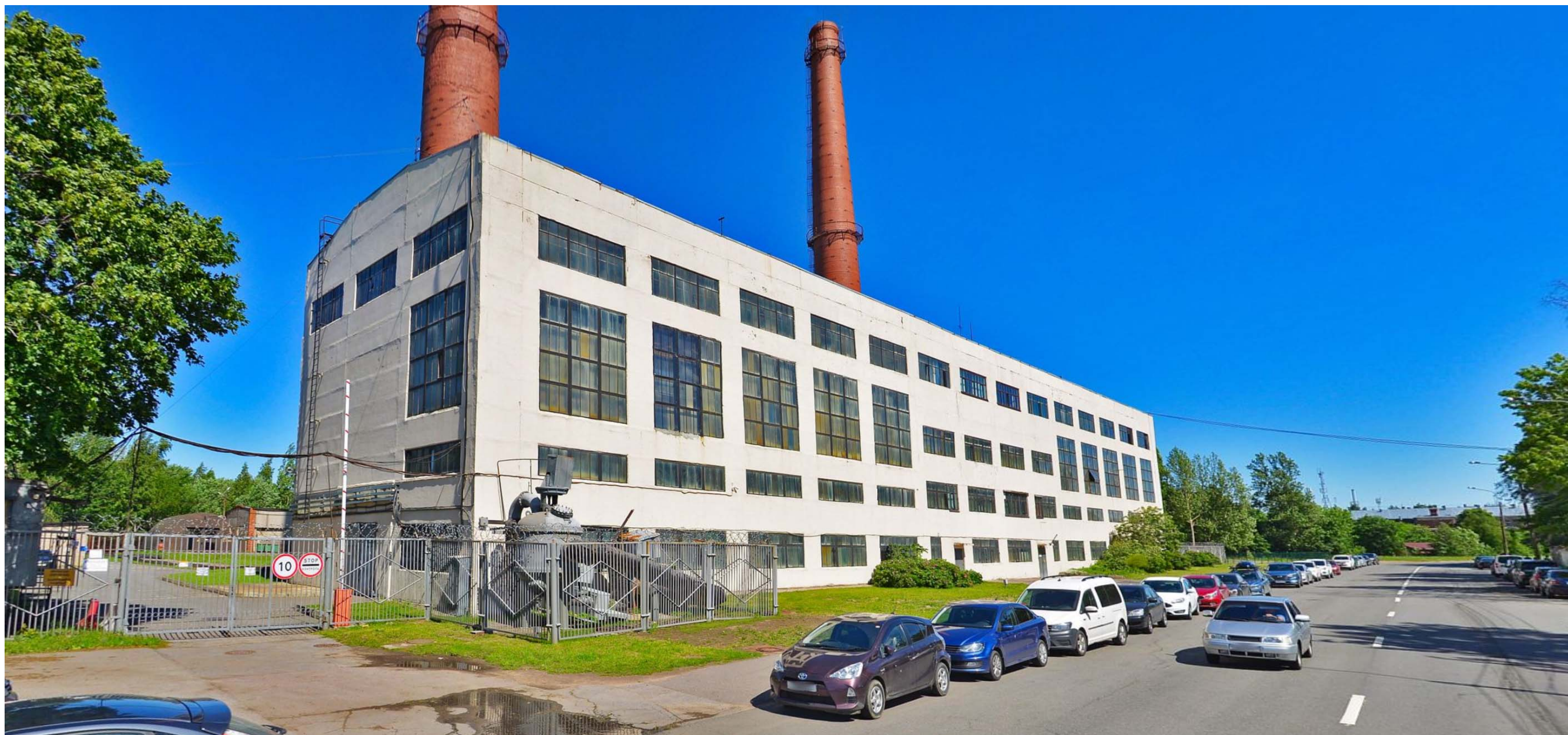
Фото 2. Существующий вид на котельную со стороны Цитадельского ш.
