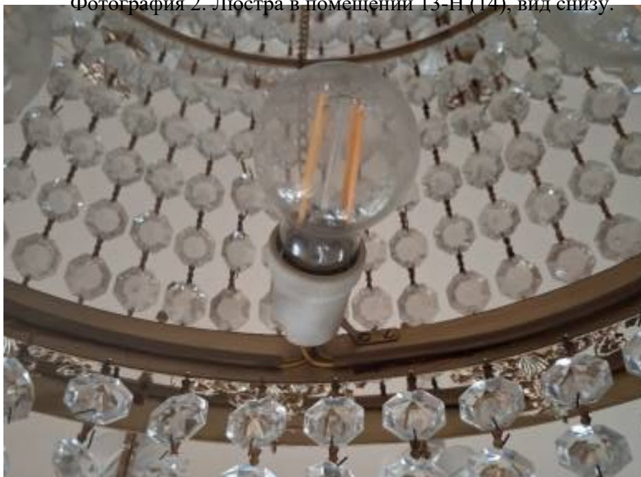
Фотография 3. Люстра в помещении 13-Н (14), узел крепления осветительных элементов к латунному поясу.
