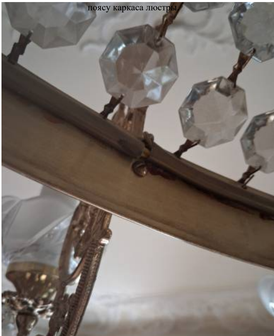
Фотография 5. Люстра в помещении 13-Н (14), узел крепления рожка к 3-ему снизу поясу каркаса люстры.
