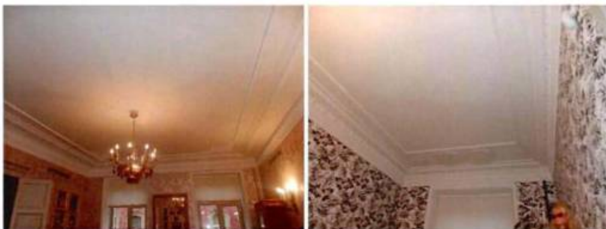
27, 28. Сводчатые потолки в уровне 1 этажа здания (кв. 24)
