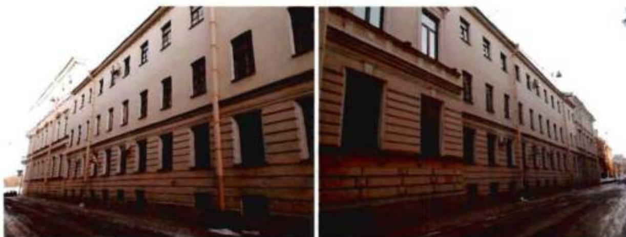
9, 10. Внутренний двор. Северный и южный фасады
