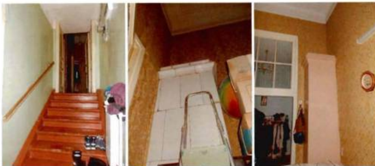
54, 55, 56. Лестница Л-5 (вход со стороны внутреннего двора)
