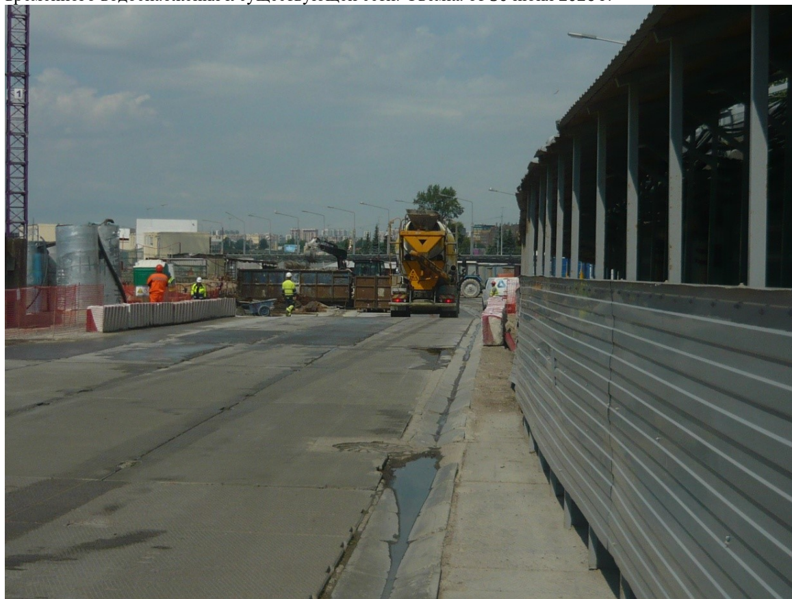
2. Санкт-Петербург, Красногвардейская площадь. Территория строительства общественно-делового центра ПАО «Газпром нефть». Вид вдоль проектируемой сети временного водоснабжения к существующей сети. Съёмка от 30 июня 2026 г.
