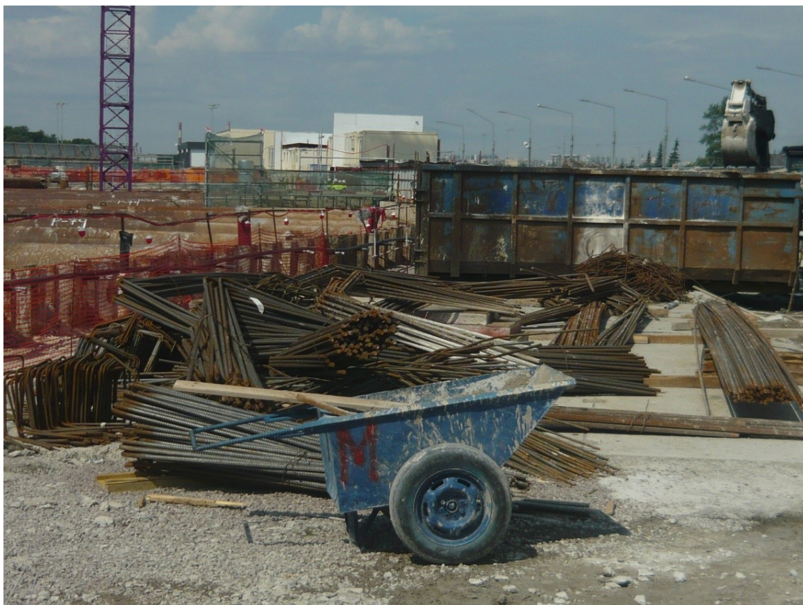
5. Санкт-Петербург, Красногвардейская площадь. Территория строительства общественно-делового центра ПАО «Газпром нефть». Вид вдоль проектируемой сети временного водоснабжения к существующей сети. Съёмка от 30 июня 2026 г.
