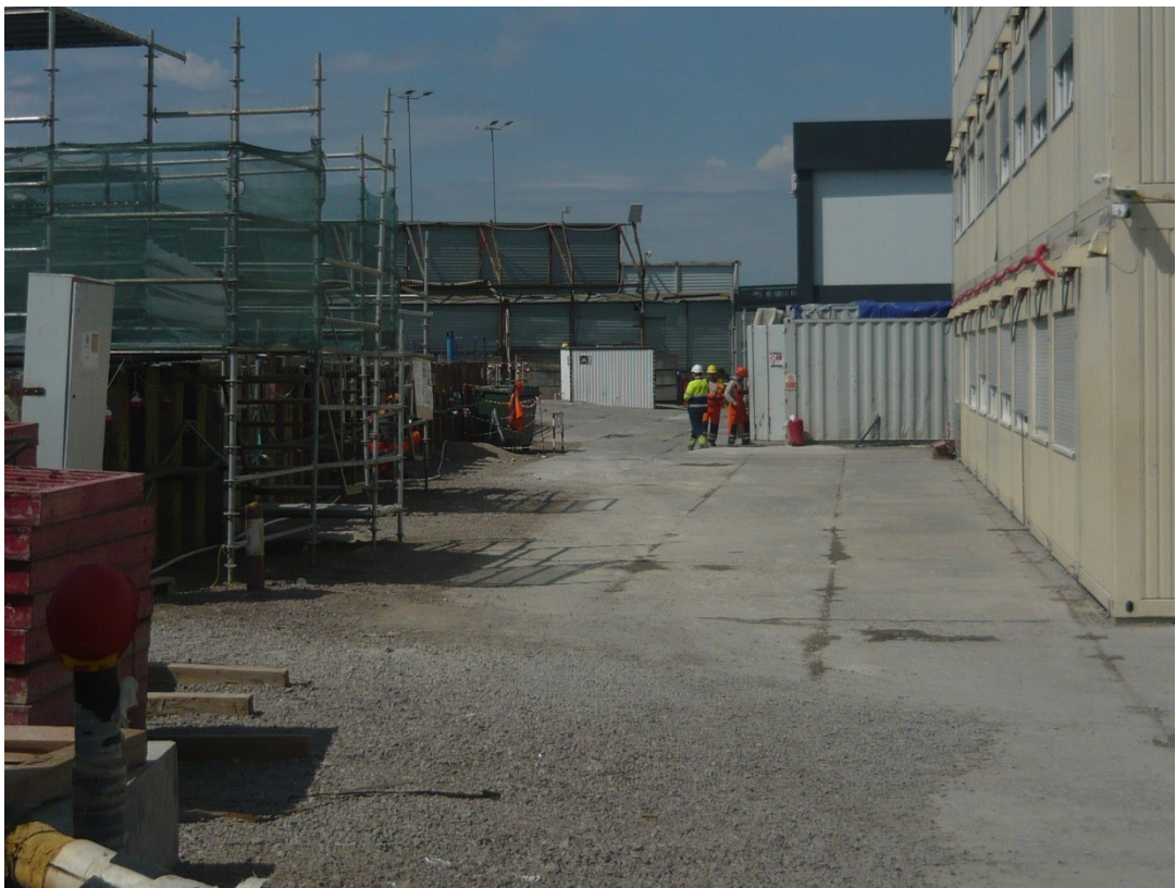
10. Санкт-Петербург, Красногвардейская площадь. Территория строительства общественно-делового центра ПАО «Газпром нефть». Вид вдоль проектируемой сети временного водоснабжения к существующей сети. Съёмка от 30 июня 2026 г.
