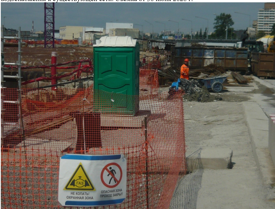
4. Санкт-Петербург, Красногвардейская площадь. Территория строительства общественно-делового центра ПАО «Газпром нефть». Вид вдоль проектируемой сети временного водоснабжения к существующей сети. Съёмка от 30 июня 2026 г.
