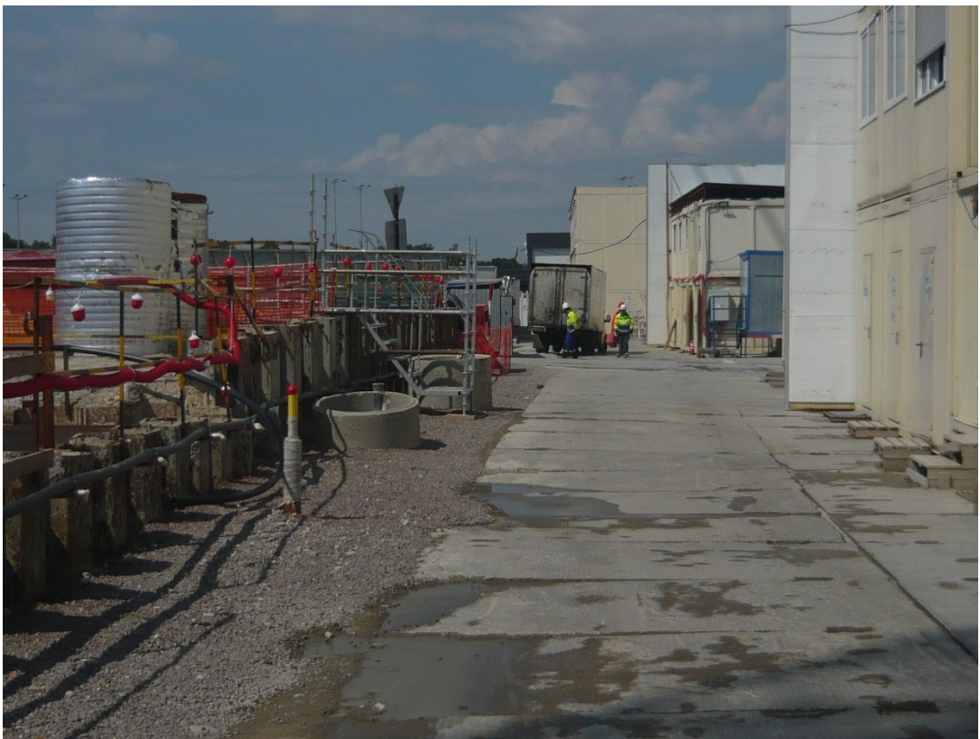
7. Санкт-Петербург, Красногвардейская площадь. Территория строительства общественно-делового центра ПАО «Газпром нефть». Вид вдоль проектируемой сети временного водоснабжения к существующей сети. Съёмка от 30 июня 2026 г.
