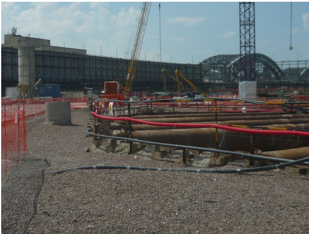
3. Санкт-Петербург, Красногвардейская площадь. Территория строительства общественно-делового центра ПАО «Газпром нефть». Вид вдоль проектируемой сети временного водоснабжения к существующей сети. Съёмка от 30 июня 2026 г.
