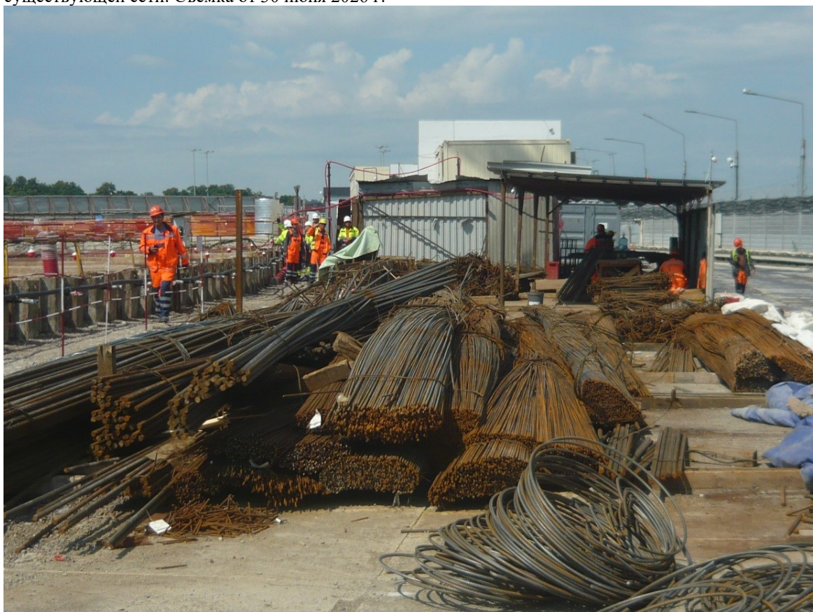
6. Санкт-Петербург, Красногвардейская площадь. Территория строительства общественно-делового центра ПАО «Газпром нефть». Вид вдоль проектируемой сети временного водоснабжения к существующей сети. Съёмка от 30 июня 2026 г.
