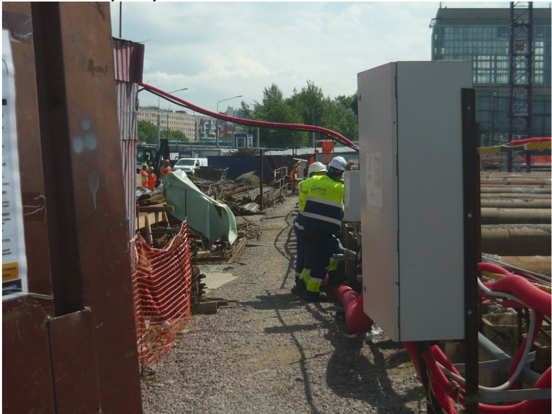
9. Санкт-Петербург, Красногвардейская площадь. Территория строительства общественно-делового центра ПАО «Газпром нефть». Вид вдоль проектируемой сети временного водоснабжения к существующей сети. Съёмка от 30 июня 2026 г.
