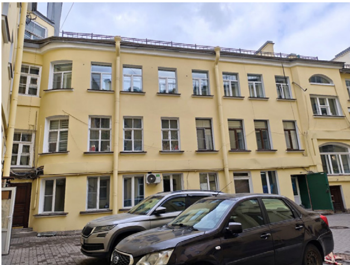
Фото 11. Восточная часть дворового фасада дома по Гончарной ул.
