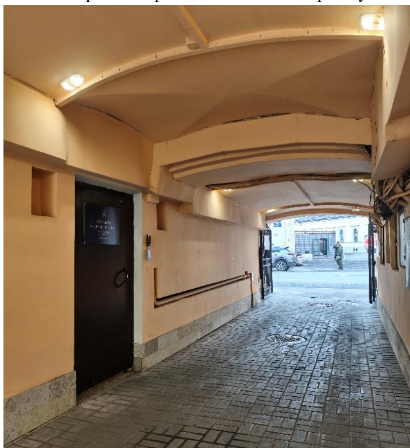
Фото 6. Проездная арка со стороны двора.
