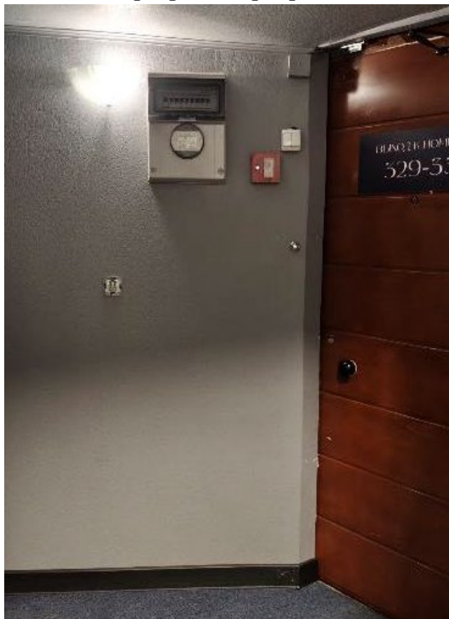
Фото 13. Помещение при входе.
