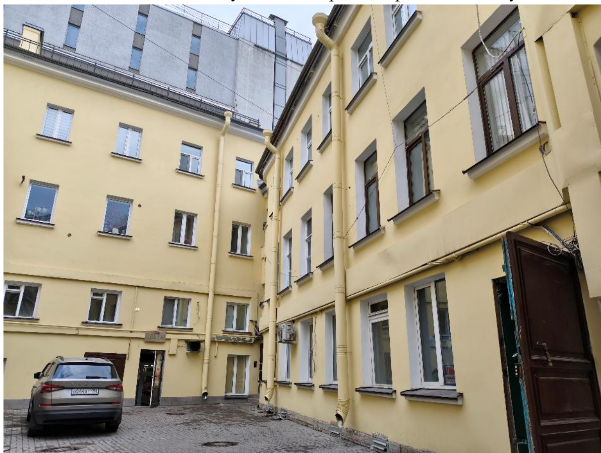
Фото 10. Вид вдоль дома по Гончарной ул. на юго-восточной.
