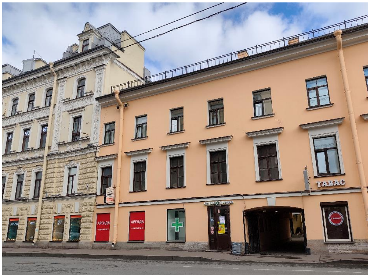
Фото 5. Фрагмент фасада дома по Гончарной улице.
