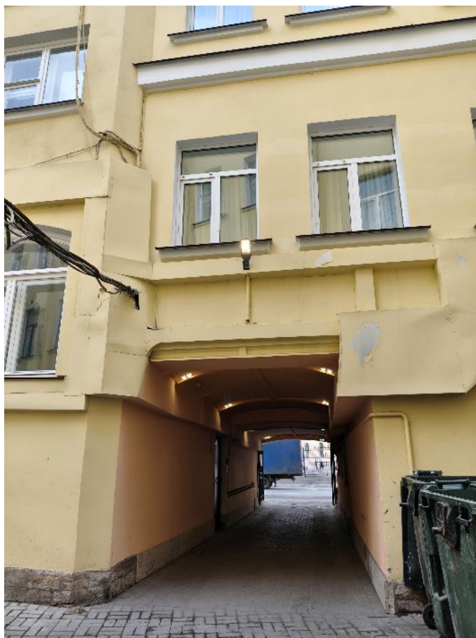
Фото 7. Фрагмент дворового фасада.
