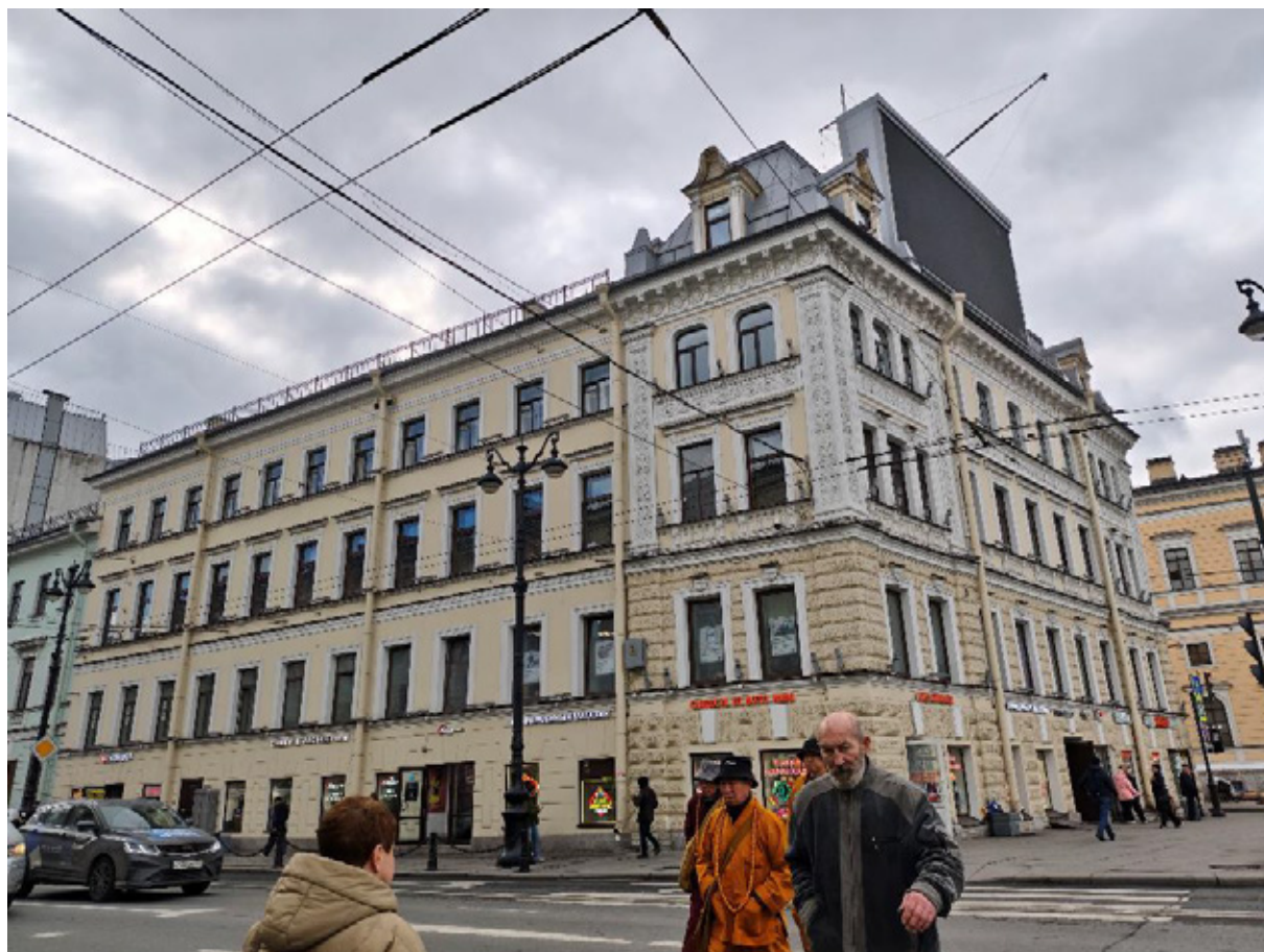
Фото 1. Общий вид с северо-запада.
