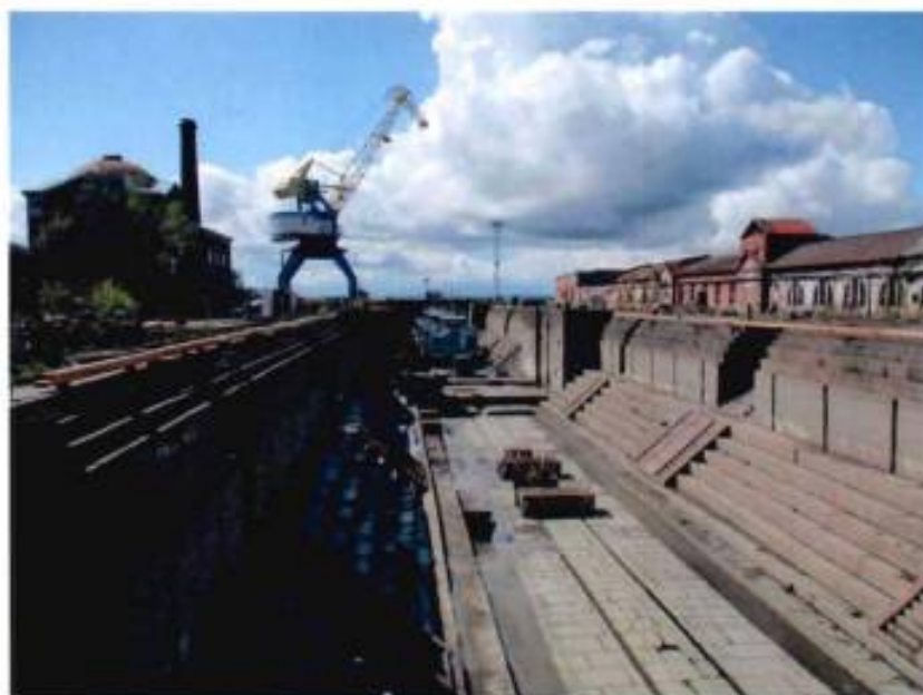
1. Вид сверху с севера на юг
