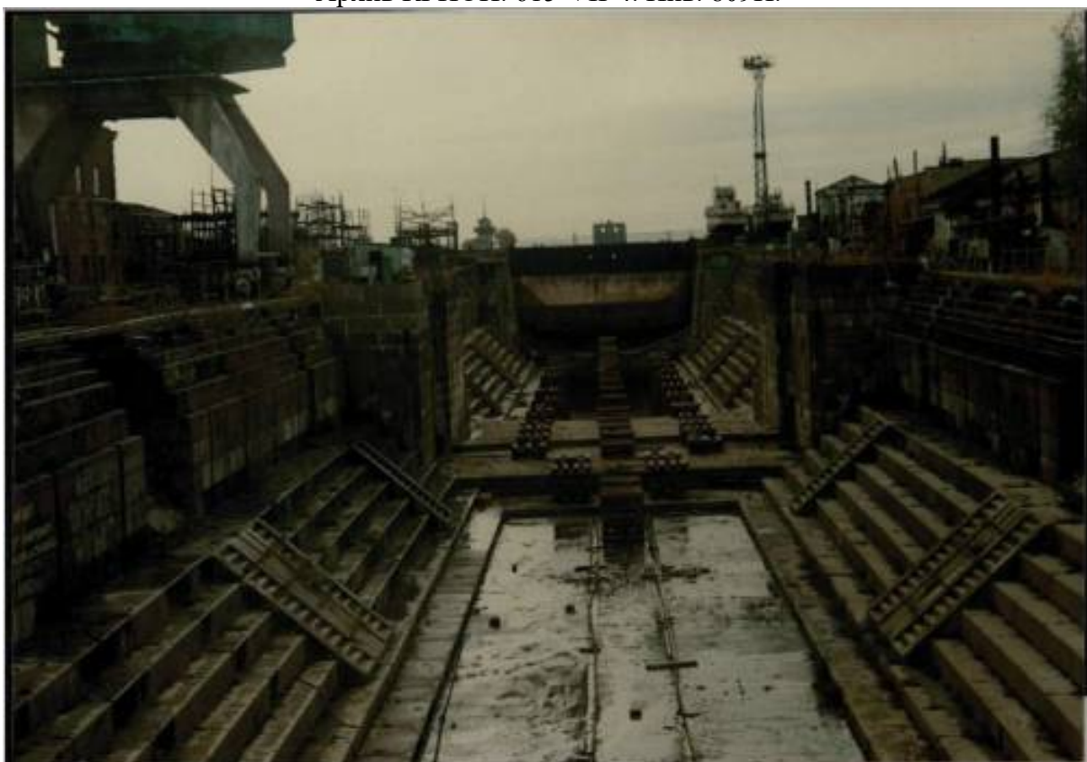
Илл. 42. Николаевский док. Вид на камеры Фрегатного и Корабельного доков. 1997 г. // Паспорт объекта культурного наследия «Док Николаевский». Архив КГИОП. 615-VII-4. Инв. 809П.
