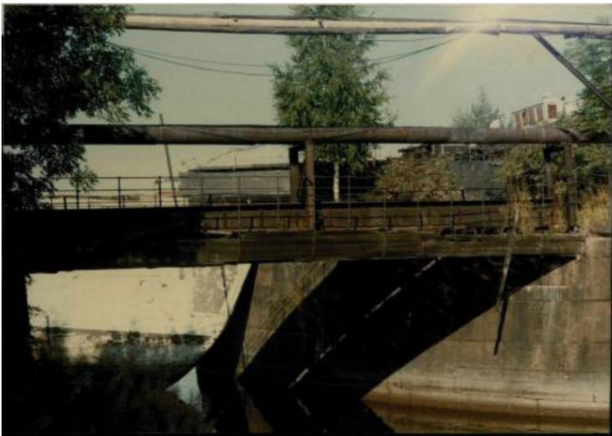
Илл. 53. Николаевский док. Вид на западный мост, соединяющий Николаевский док (Фрегатную камеру) с территорией завода. 1997 г. // Паспорт объекта культурного наследия «Док Николаевский». Архив КГИОП. 615-VII-4. Инв. 809П.
