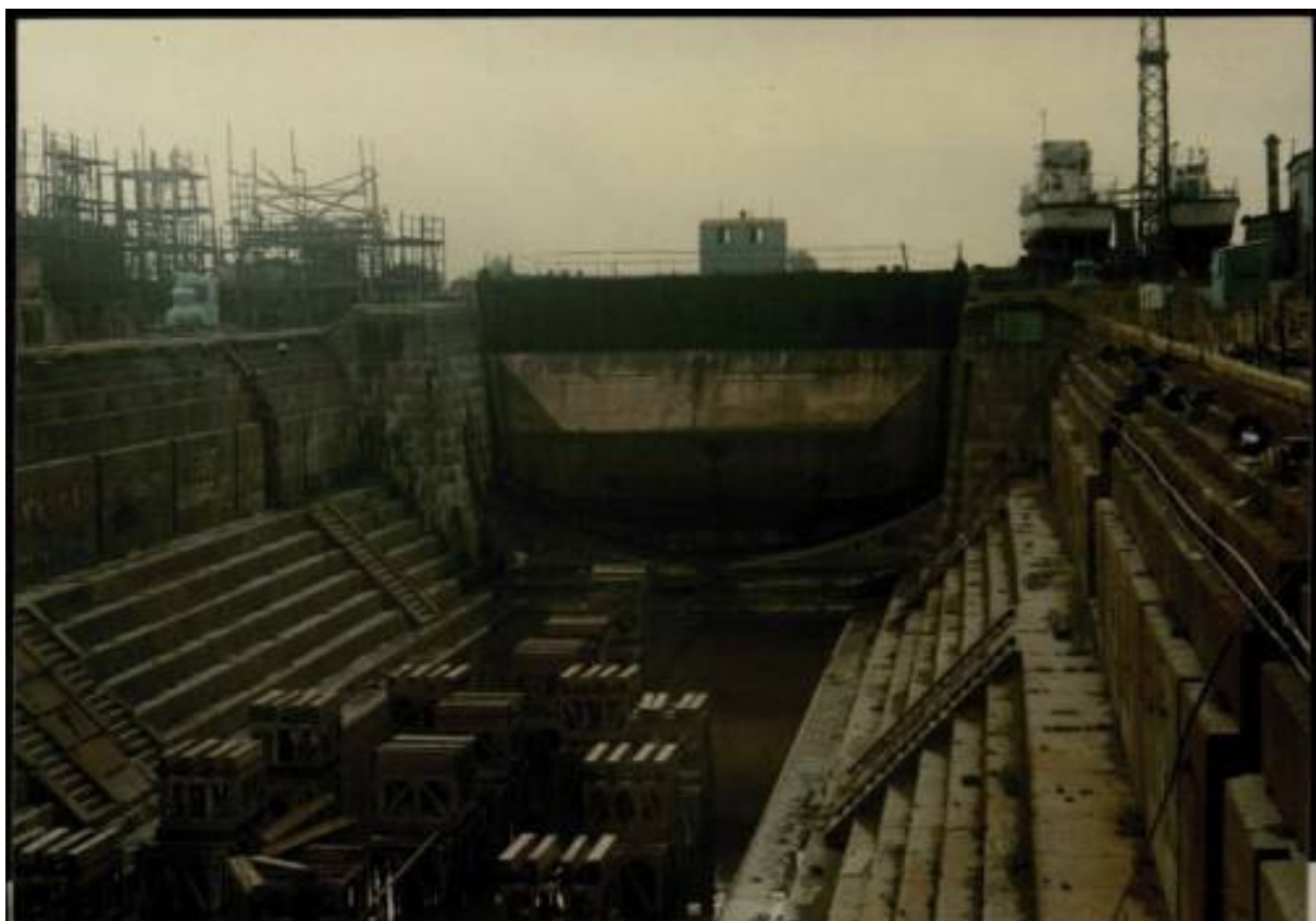
Илл. 45. Николаевский док. Камера Корабельного дока. 1997 г. // Паспорт объекта культурного наследия «Док Николаевский». Архив КГИОП. 615-VII-4. Инв. 809П.
