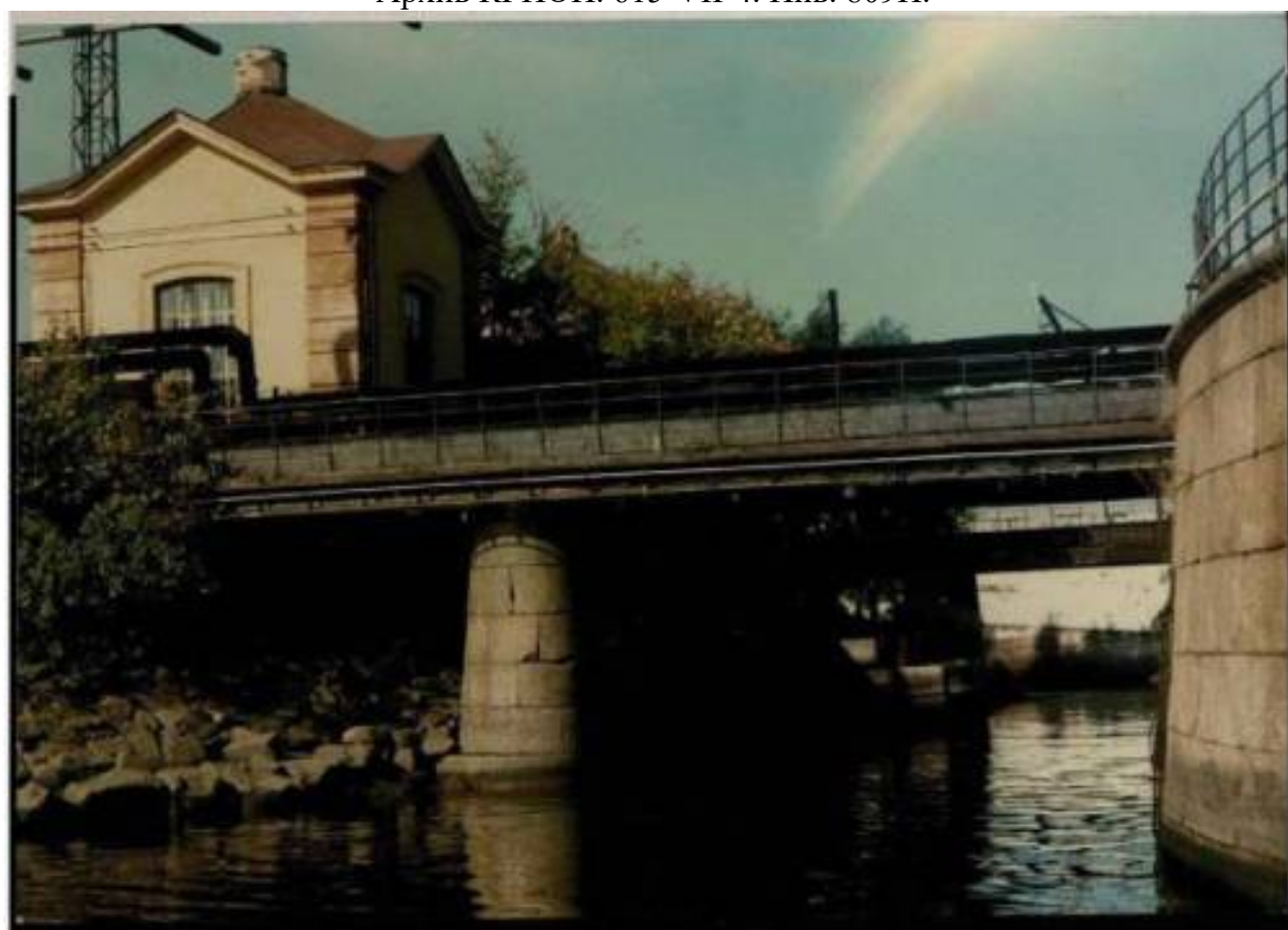
Илл. 52. Николаевский док. Вид на мосты, соединяющие Николаевский док с территорией завода. 1997 г. // Паспорт объекта культурного наследия «Док Николаевский». Архив КГИОП. 615-VII-4. Инв. 809П.
