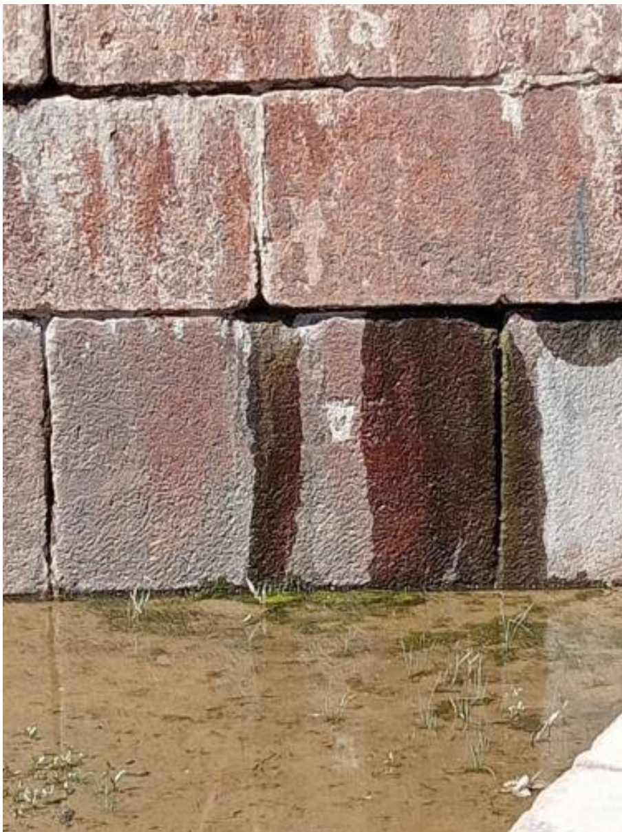
Фото 5. Объект культурного наследия федерального значения «Док Николаевский» с западной стороны. Фильтрация воды через стенки дока. Съемка 07.06.2024 г. Трушковский В.Э.
