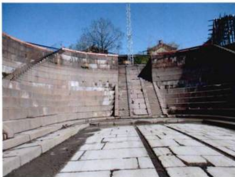
2. Северная подпорная стена дока
