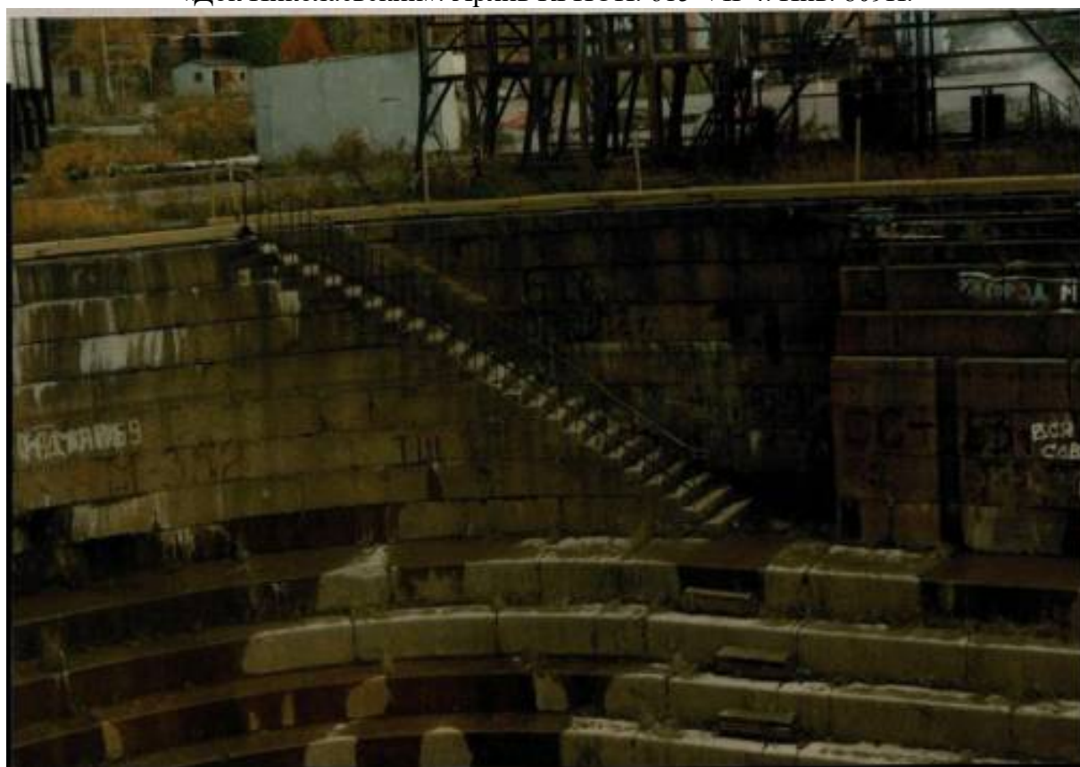
Илл. 48. Николаевский док. Вид на лестницу в торце Фрегатного дока. 1997 г. // Паспорт объекта культурного наследия «Док Николаевский». Архив КГИОП. 615-VII-4. Инв. 809П.
