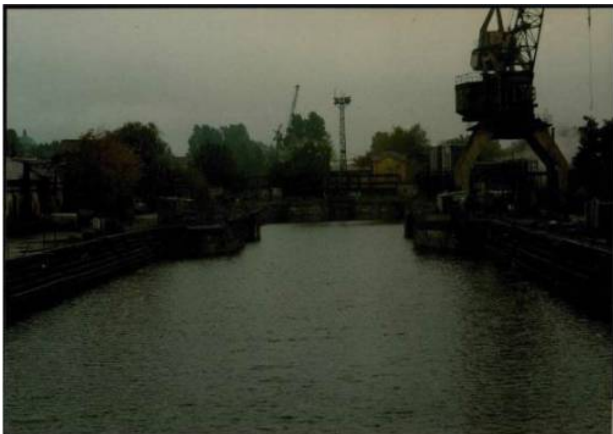
Илл. 43. Николаевский док. Вид на север. 1997 г. // Паспорт объекта культурного наследия «Док Николаевский». Архив КГИОП. 615-VII-4. Инв. 809П.
