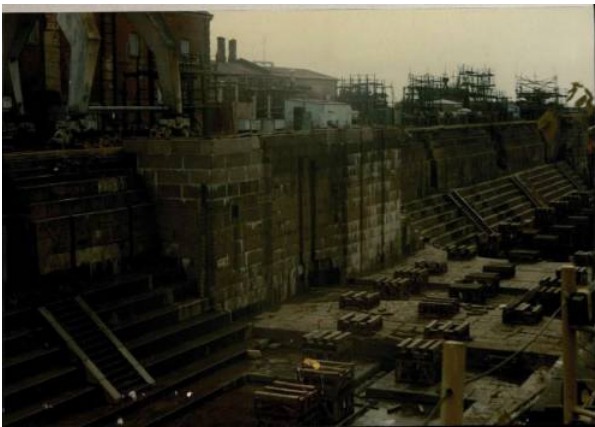
Илл. 47. Николаевский док. Вид на шкафную часть ворот между Корабельным и Фрегатным доками. 1997 г. // Паспорт объекта культурного наследия «Док Николаевский». Архив КГИОП. 615-VII-4. Инв. 809П.
