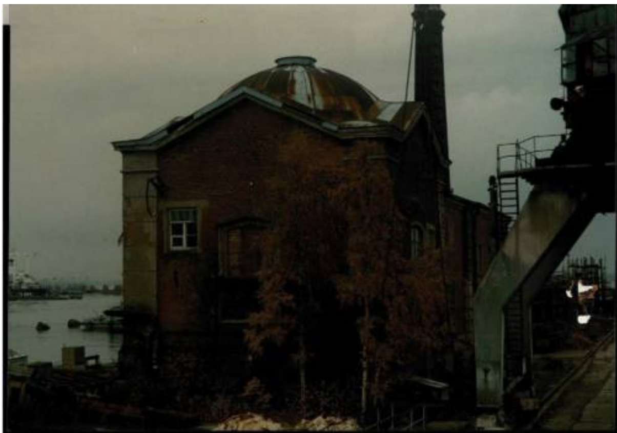
Илл. 51. Николаевский док. Здание насосной станции. 1997 г. // Паспорт объекта культурного наследия «Шлюпочный канал». Архив КГИОП. 615-VII-4. Инв. 809П.
