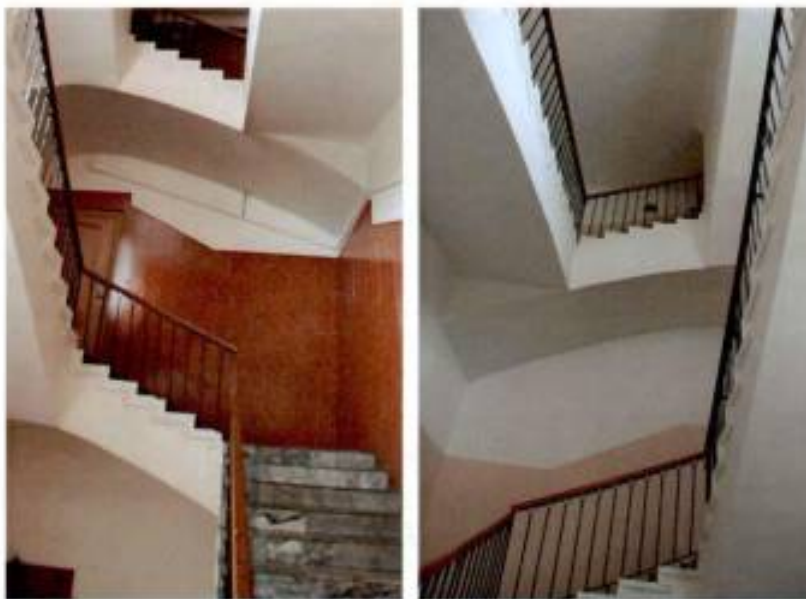
Фото №20, 21. Лестницы 1ЛК, 2ЛК. Съемка: 19.04.2016.
