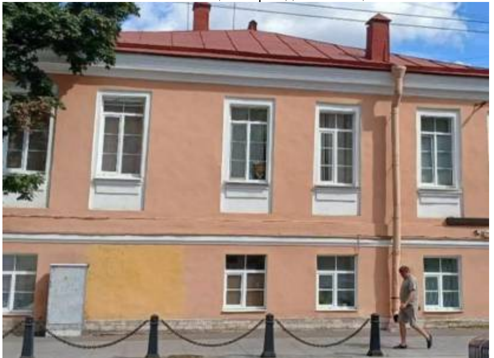
8. «Пожарная часть с палисадником» (Большой пр. П.С., д. 11/2, лит. А). Лицевой фасад (фрагмент). Фото мест установки оборудования и прокладки кабельных трасс. Штиглиц М.С. 07.08.2026 г. Штиглиц М.С. 07.08.2026 г.
