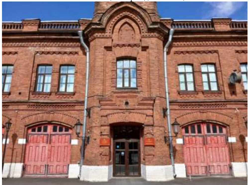
2. «Пожарное отделение» (в составе «Здания полицейского управления и пожарной команды Васильевской части») (Большой пр. В.О., д. 73, лит. А). Лицевой фасад (фрагмент). Фото мест установки оборудования и прокладки кабельных трасс. Штиглиц М.С. 07.08.2026 г.
