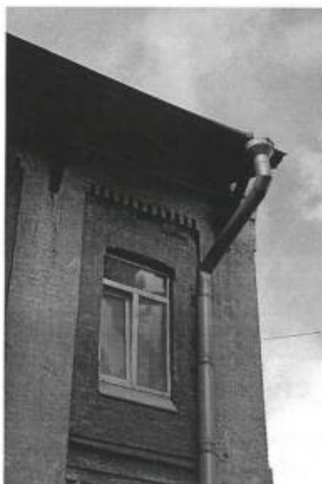
12. Фрагмент восточного фасада.
