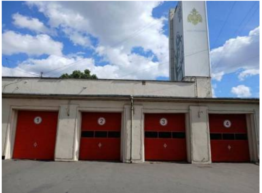
23. «Пожарная часть» (Лесной пр., д. 17, лит. А). Лицевой фасад (фрагмент). Фото мест установки оборудования и прокладки кабельных трасс. Штиглиц М.С. 07.08.2026 г.
