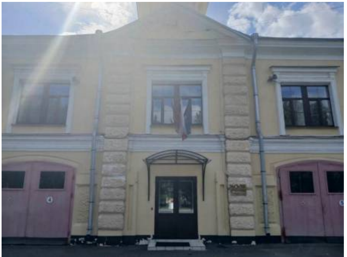
20. «Здание Шлиссельбургской пожарной части» (Обуховской Обороны пр., д. 43, лит. А). Лицевой фасад (фрагмент). Фото мест установки оборудования и прокладки кабельных трасс. Штиглиц М.С. 07.08.2026 г.
