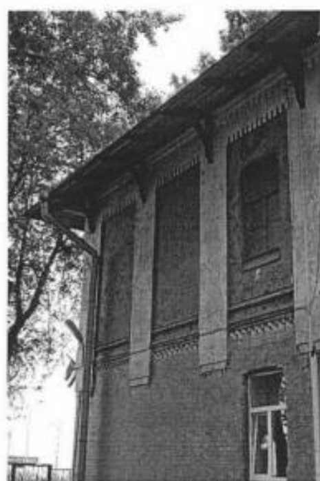
9. Фрагмент восточного фасада.
