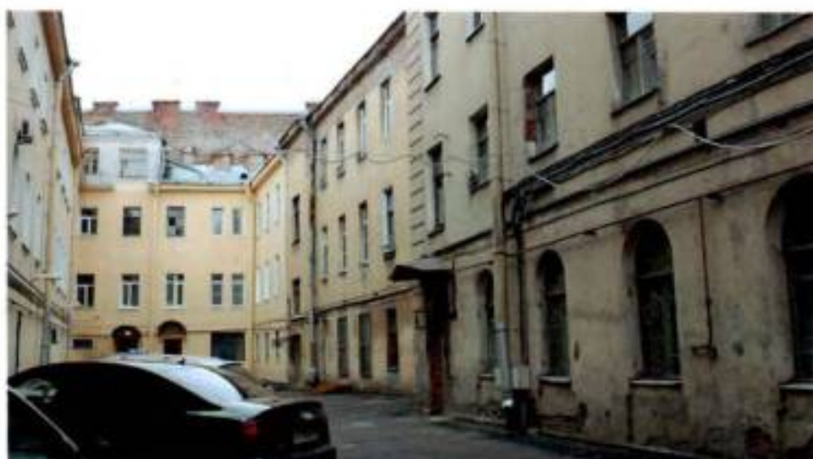
Фото №2. Дворовые фасады. Съемка: 19.04.2016.
