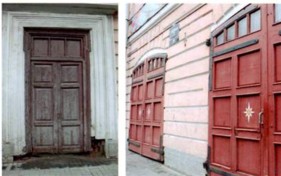
Фото №34, 35. Дверные и воротные заполнения лицевых фасадов. Съемка: 19.04.2016.
