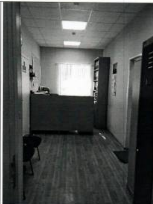
27. Вид на помещение (приемная) 1-го этажа
