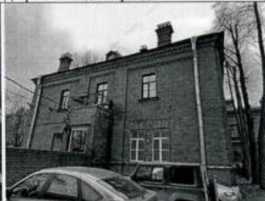
Дворовый северный фасад
