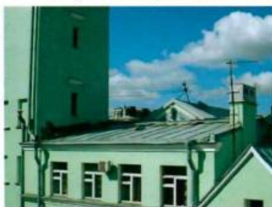
10. Вид на фальцевое покрытие кровли
