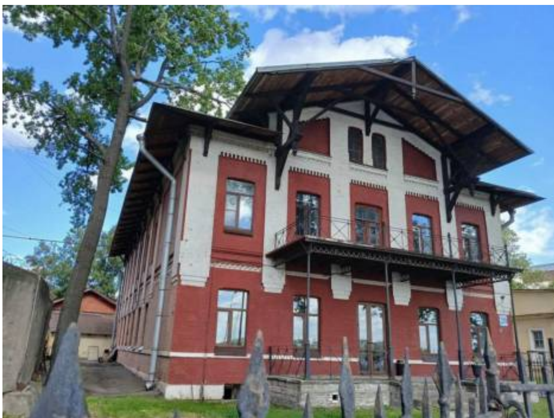
14. «Пожарное депо» (Свердловская наб., д. 20, лит. А). Общий вид. Штиглиц М.С. 07.08.2026 г.
