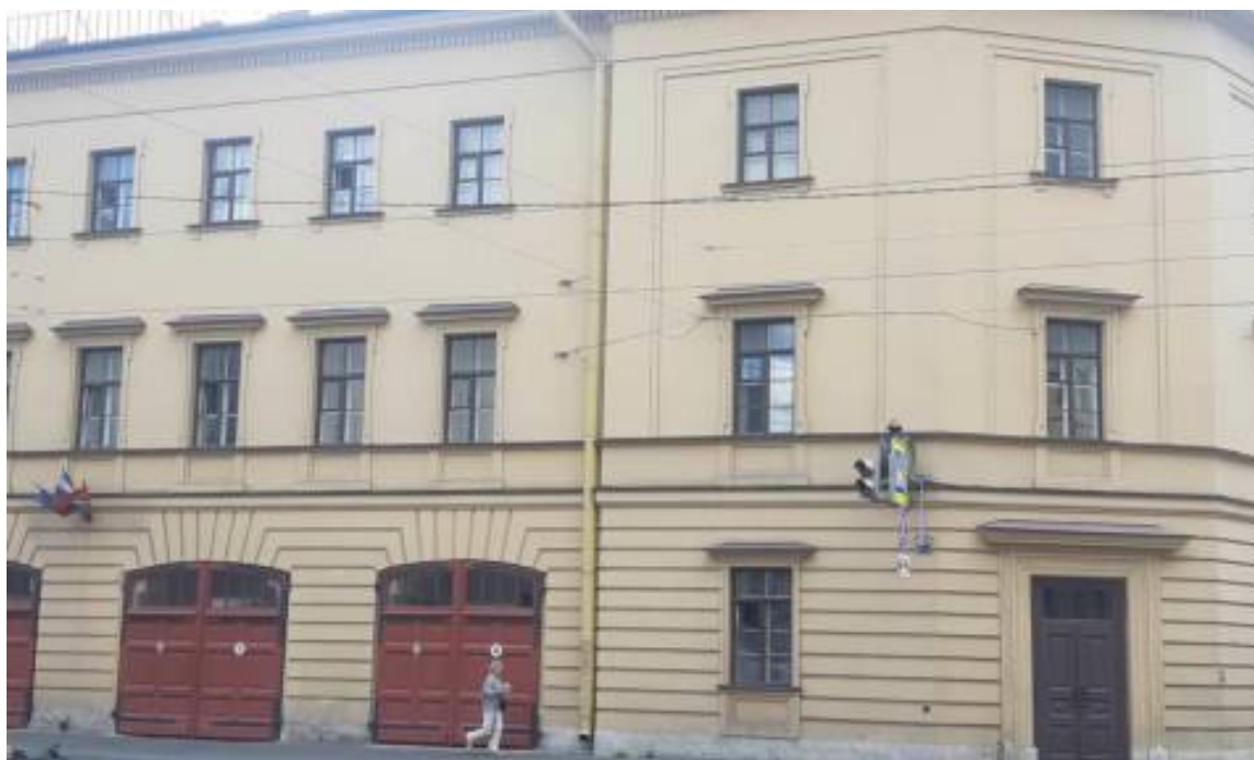
32. «Пожарное отделение» (в составе «Съезжий дом 3-й Адмиралтейской части») (Садовая ул., д. 58, лит. Б). Лицевой фасад (фрагмент). Фото мест установки оборудования и прокладки кабельных трасс. Штиглиц М.С. 07.08.2026 г.
