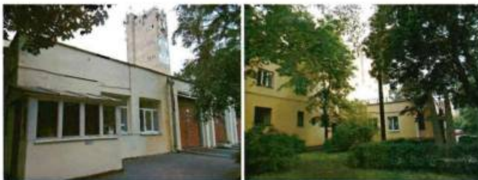
1, 2. Фасад объекта культурного наследия со стороны Загородного пр.
