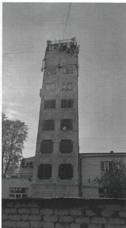
7. Фрагмент южного фасада и каланчи объекта культурного наследия
