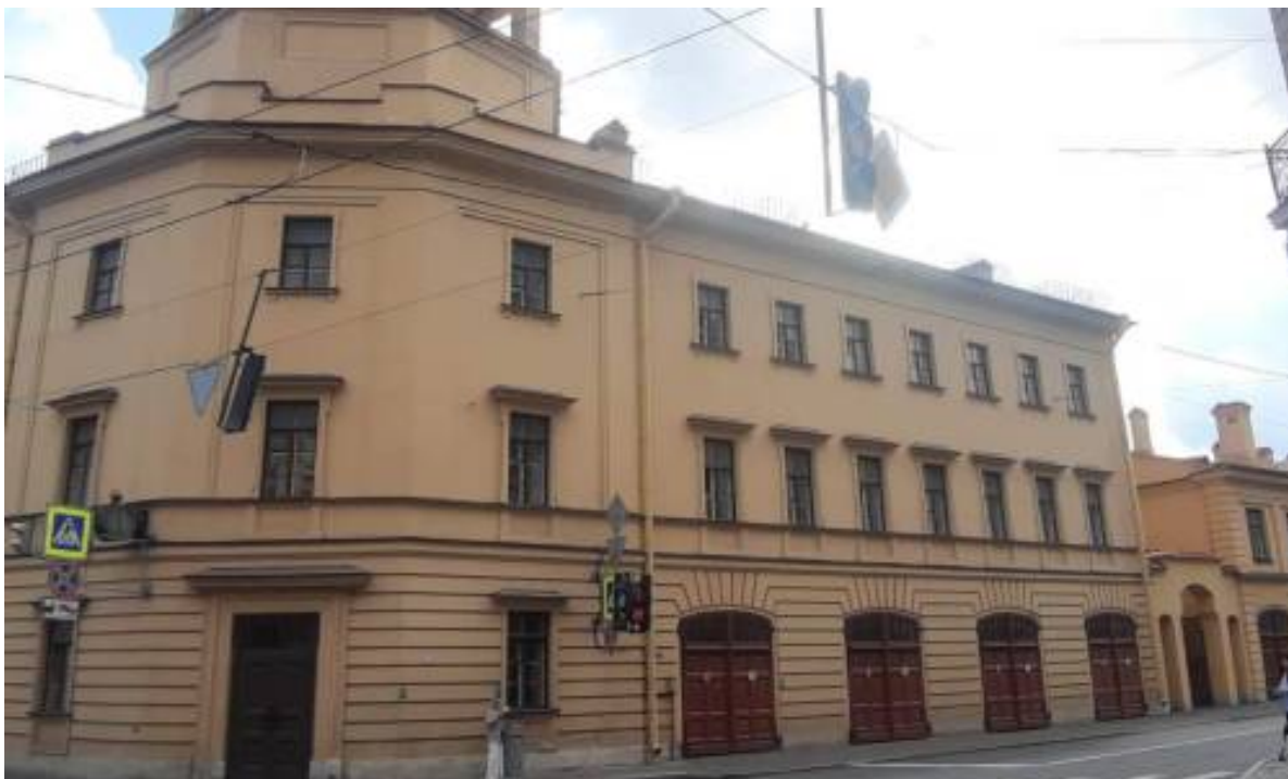
33. «Пожарное отделение» (в составе «Съезжий дом 3-й Адмиралтейской части») (Садовая ул., д. 58, лит. Б). Лицевой фасад (фрагмент). Фото мест установки оборудования и прокладки кабельных трасс. Штиглиц М.С. 07.08.2026 г.
