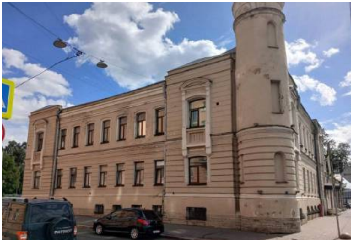
25. «Здание бывшей богадельни Охтинского пригородного общества» (в составе «Охтинская съезжая часть») (Большеохтинский пр., д. 3, лит. А). «Пожарное отделение» (в составе «Съезжий дом 3-й Адмиралтейской части») (Садовая ул., д. 58, лит. Б). Общий вид. Штиглиц М.С. 07.08.2026 г.
