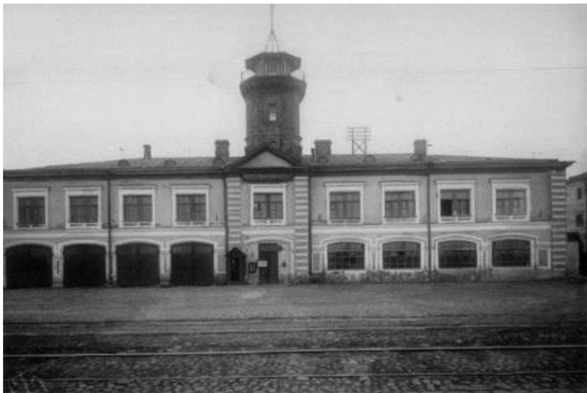
27. «Здание Шлиссельбургской пожарной части» (Обуховской Обороны пр., д. 43, лит. А). 27 июля 1934 г. * см. ниже ЦГАКФФД СПб Гр 67243.
