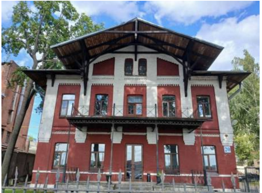
15. «Пожарное депо» (Свердловская наб., д. 20, лит. А). Лицевой фасад. Штиглиц М.С. 07.08.2026 г.
