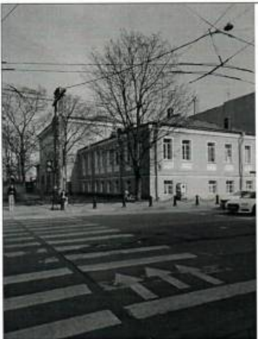
5. Вид на северо-западный корпус
