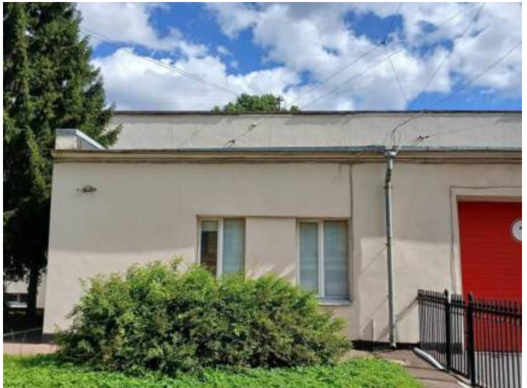
22. «Пожарная часть» (Лесной пр., д. 17, лит. А). Лицевой фасад (фрагмент). Фото мест установки оборудования и прокладки кабельных трасс. Штиглиц М.С. 07.08.2026 г.
