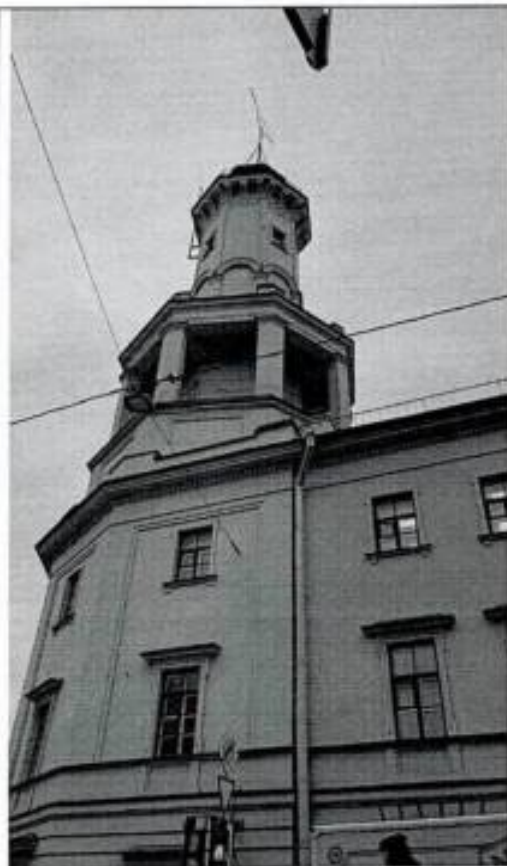
6. Фрагмент лицевого фасада со стороны Большой Подъяческой улицы.
