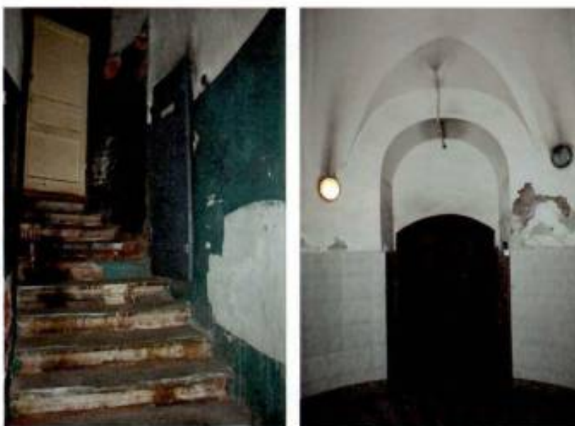
Фото №22, 23. Ротонда I-го этажа с кольцевой лестницей 3ЛК. Съемка: 19.04.2016.
