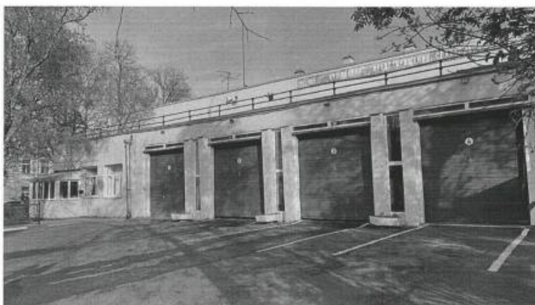
3. Вид на север-западный фасад объекта культурного наследия
