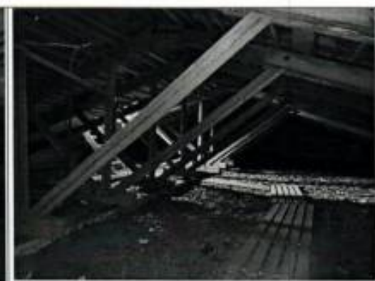
11. Вид на чердачное помещение
