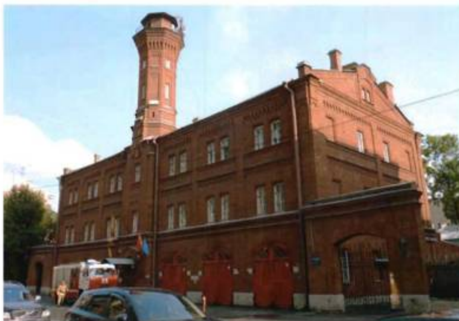
1. «Главное здание с каланчой» (Мичуринская ул., д. 5, лит. А). Общий вид с юга.
