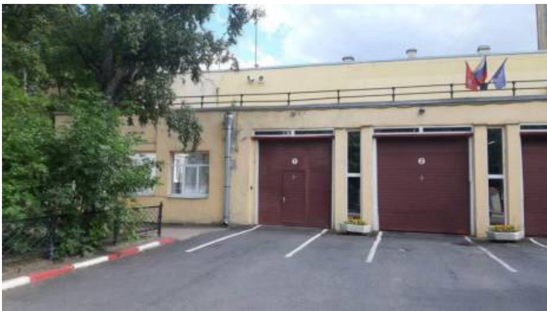
29. «Пожарное депо» (Загородный пр., д. 56, лит. А). Лицевой фасад (фрагмент). Фото мест установки оборудования и прокладки кабельных трасс. Штиглиц М.С. 07.08.2026 г.
