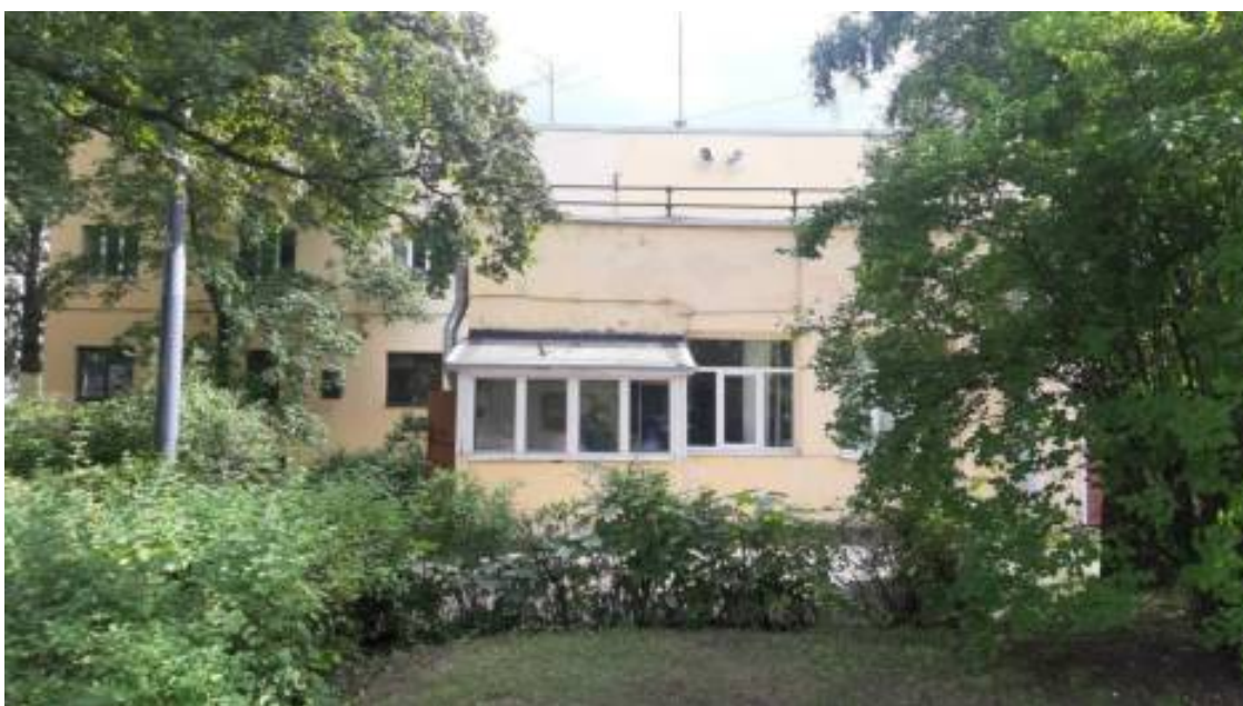
30. «Пожарное депо» (Загородный пр., д. 56, лит. А). Лицевой фасад (фрагмент). Фото мест установки оборудования и прокладки кабельных трасс. Штиглиц М.С. 07.08.2026 г.
