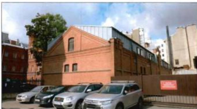
10. «Служебный корпус» (Пеньковская ул., д. 6, лит. Б). Общий вид с юго-востока.
