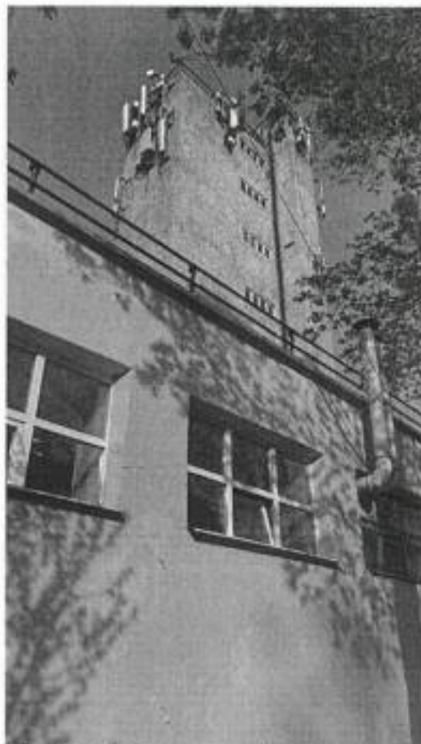
4. Фрагмент западного фасада и каланчи объекта культурного наследия. На фасадах каланчи объекта культурного наследия зафиксировано устройство сетей связи.
