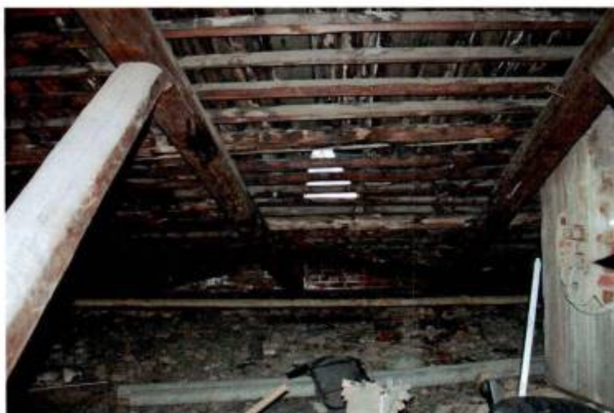
Фото №44. Чердак лицевого флигеля. Съемка: 19.04.2016.
