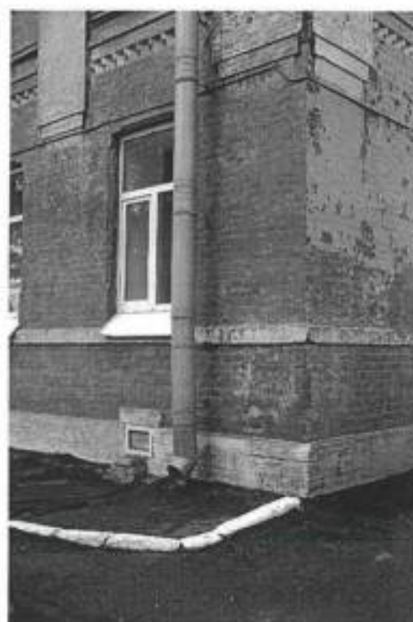
13. Фрагмент восточного и северного фасадов.
