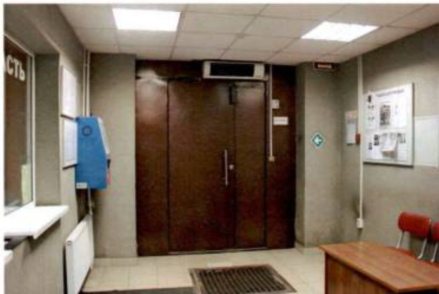
Фото №7. Входной тамбур лицевого корпуса (отделение полиции). Съемка: 19.04.2016.
