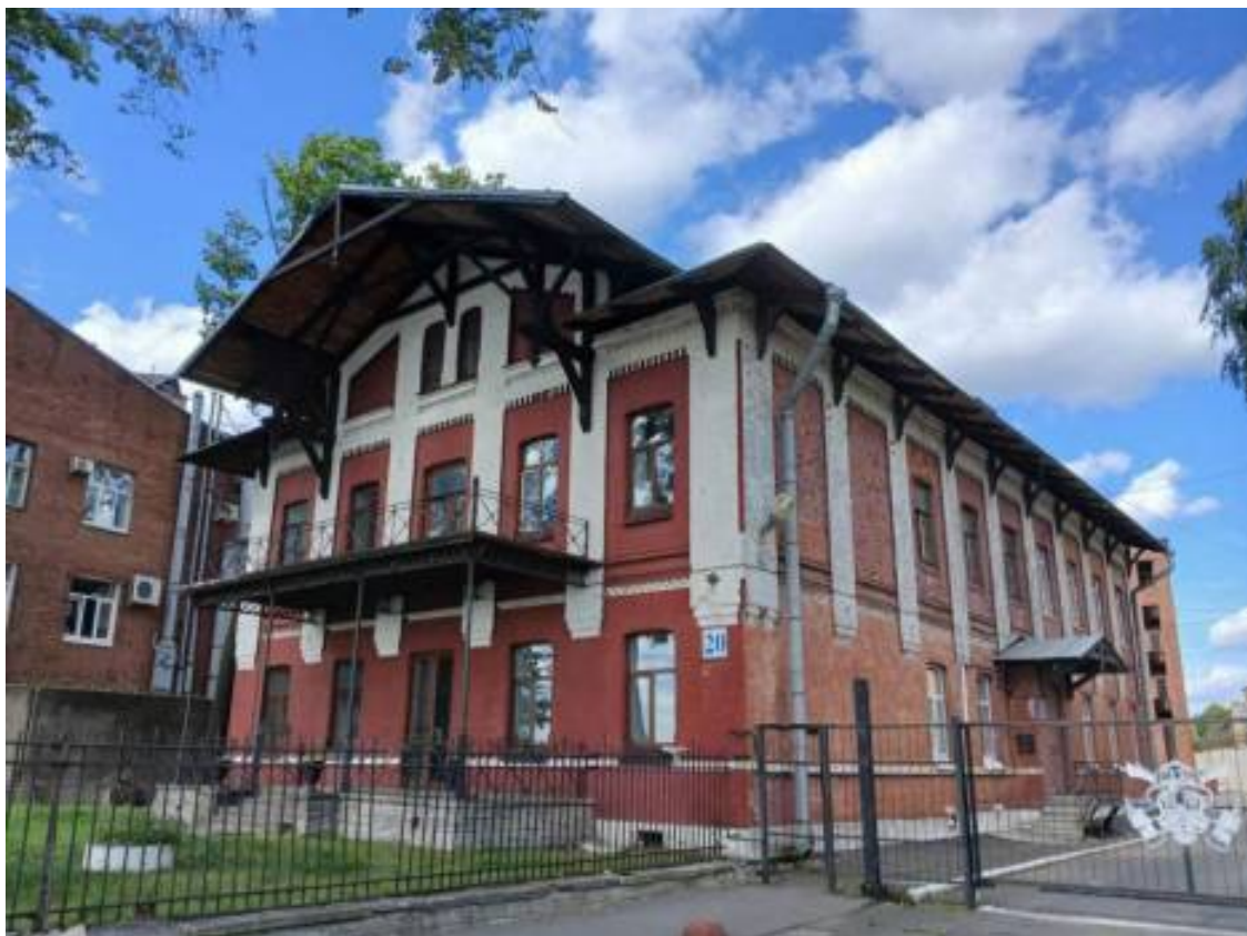
13. «Пожарное депо» (Свердловская наб., д. 20, лит. А). Общий вид. Штиглиц М.С. 07.08.2026 г.
