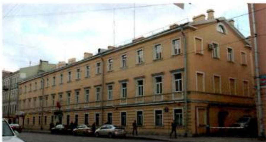
Фото №1. Лицевой и торцевой фасады. Вид со стороны ул. Садовой. Съемка: 19.04.2016.
