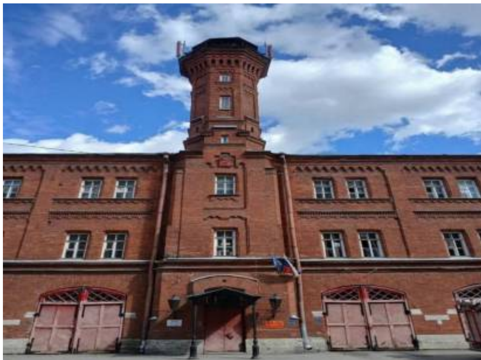
11. «Главное здание с каланчой, учебной башней, служебным корпусом, оградой и двумя воротами» (в составе «Пожарное отделение и полицейское управление Петровской части») (Мичуринская ул., д. 5, лит. А). Лицевой фасад (фрагмент). Фото мест установки оборудования и прокладки кабельных трасс. Штиглиц М.С. 07.08.2026 г.
