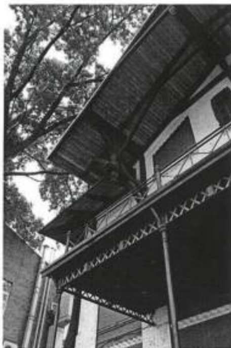
6. Фрагмент южного лицевого фасада.
