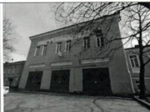
3. Центральная часть здания со стороны Большого пр.
