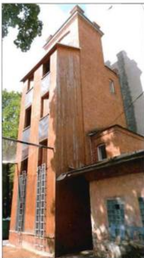
6. «Учебная башня» (Мичуринская ул., д. 5, лит. Е). Вид с востока.
