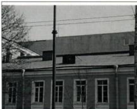
12. Вид на часть фасада с крышей Объекта
