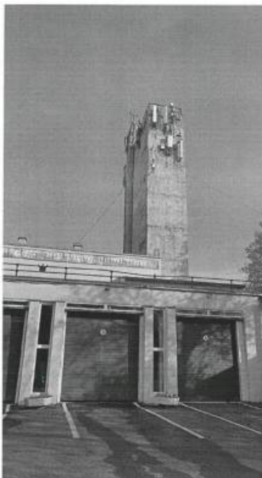
6. Фрагмент северного фасада и каланчи объекта культурного наследия
