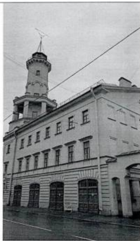
3. Фрагмент лицевого фасада со стороны Большой Подъяческой улицы
