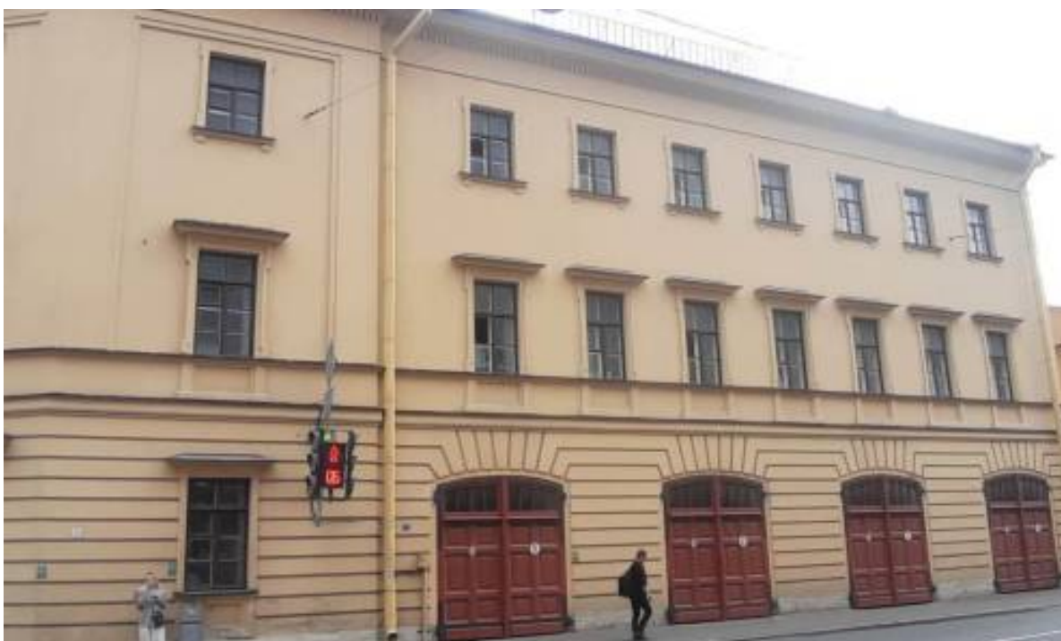
34. «Пожарное отделение» (в составе «Съезжий дом 3-й Адмиралтейской части») (Садовая ул., д. 58, лит. Б). Лицевой фасад (фрагмент). Фото мест установки оборудования и прокладки кабельных трасс. Штиглиц М.С. 07.08.2026 г.
