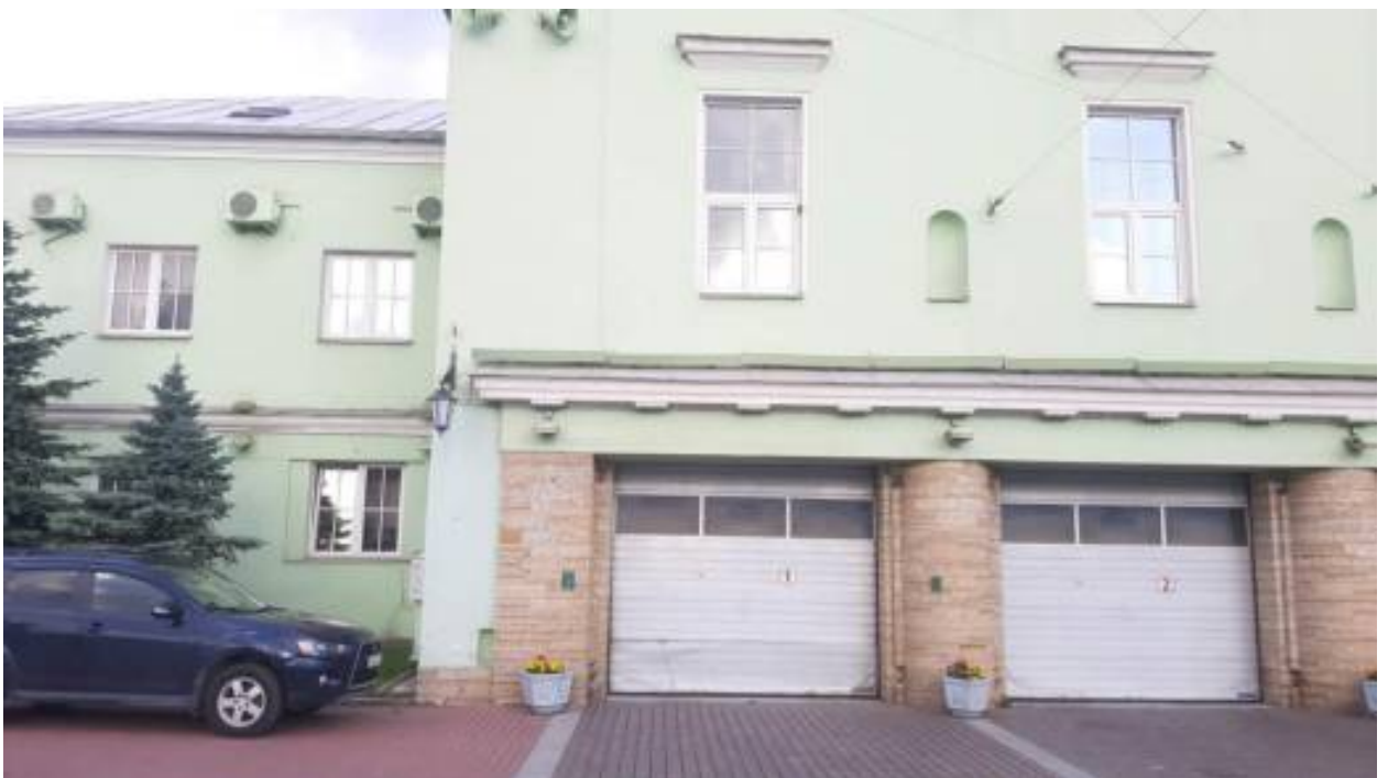
36. «Пожарное депо» (Московский пр., д. 116, лит. А). Лицевой фасад (фрагмент). Фото мест установки оборудования и прокладки кабельных трасс. Штиглиц М.С. 07.08.2026 г.
