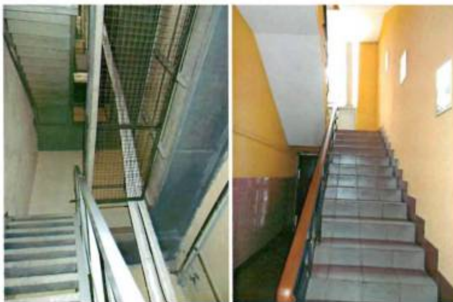
7, 8. Внутренние лестницы объекта культурного наследия
