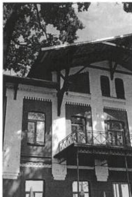
7. Фрагмент южного лицевого фасада.
