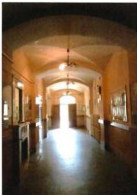
5. «Главное здание с каланчой». Сводчатые перекрытия в уровне первого этажа.
