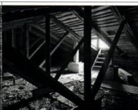
13. Вид на чердачное помещение Объекта
