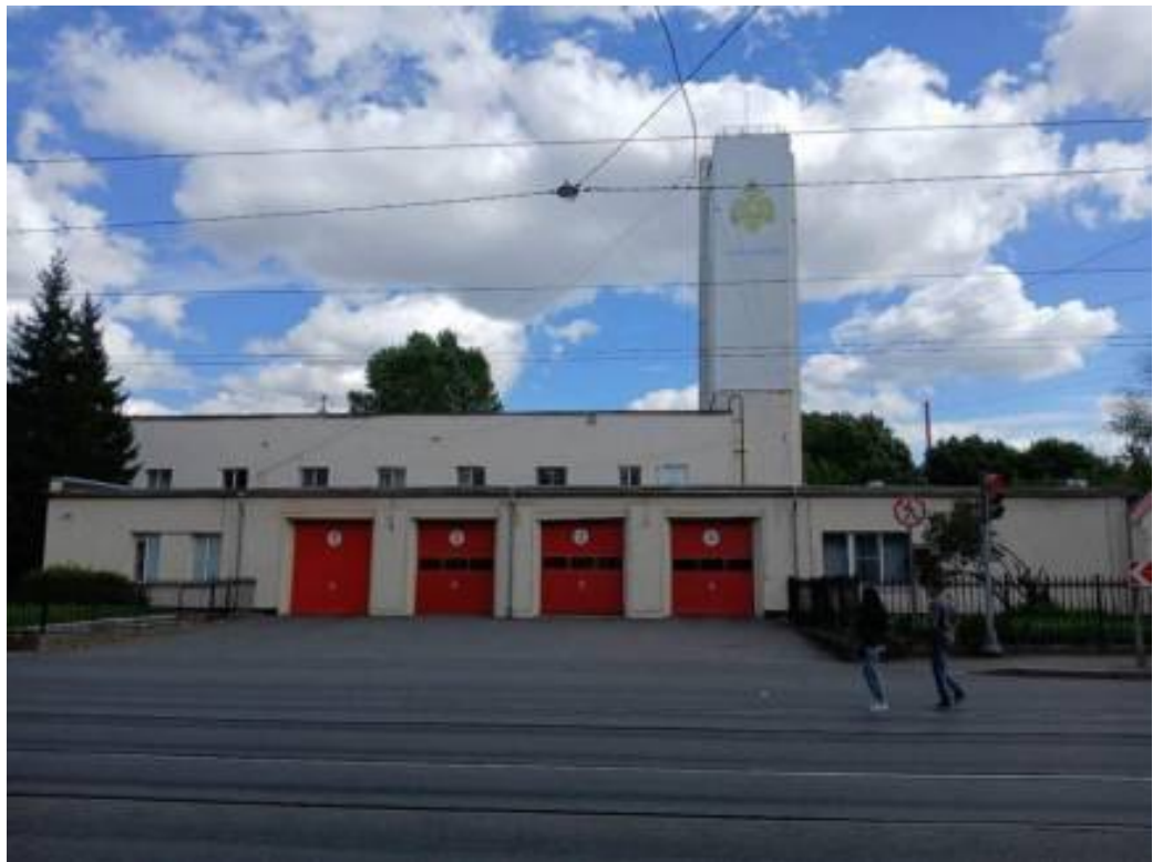
21. «Пожарная часть» (Лесной пр., д. 17, лит. А). Лицевой фасад. Штиглиц М.С. 07.08.2026 г.
