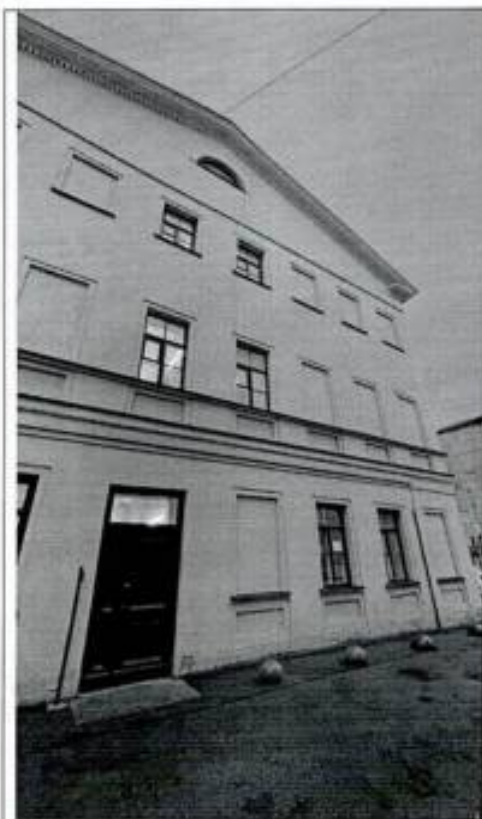
8. Фрагмент торцевого фасада.
