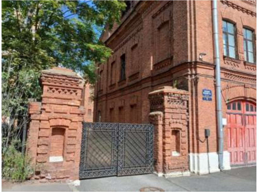
3. «Пожарное отделение» (в составе «Здания полицейского управления и пожарной команды Васильевской части») (Большой пр. В.О., д. 73, лит. А). Лицевой фасад (фрагмент). Фото мест установки оборудования и прокладки кабельных трасс. Штиглиц М.С. 07.08.2026 г.
