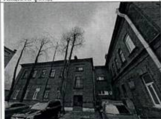
Дворовый северный фасад
