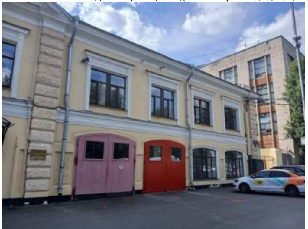
18. «Здание Шлиссельбургской пожарной части» (Обуховской Обороны пр., д. 43, лит. А). Лицевой фасад (фрагмент). Фото мест установки оборудования и прокладки кабельных трасс. Штиглиц М.С. 07.08.2026 г.
