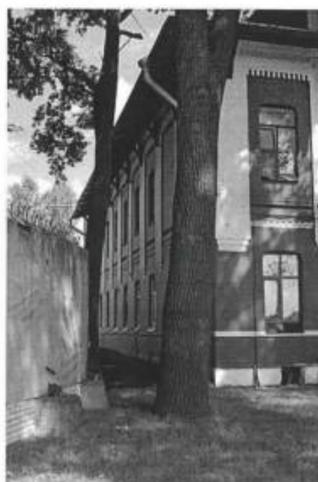
5. Общий вид южного и западного фасадов.
