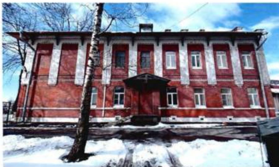
4. Восточный фасад объекта культурного наследия.
