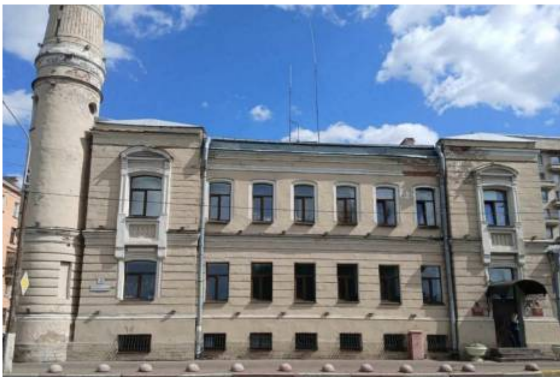
26. «Здание бывшей богадельни Охтинского пригородного общества» (в составе «Охтинская съезжая часть») (Большеохтинский пр., д. 3, лит. А). Лицевой фасад (фрагмент). Фото мест установки оборудования и прокладки кабельных трасс. Штиглиц М.С. 07.08.2026 г.
