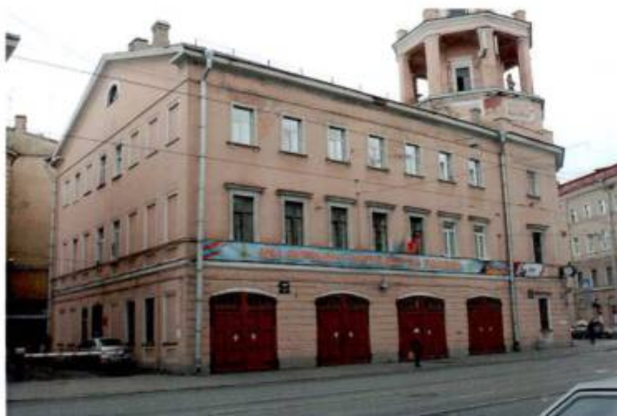
Фото №16. Лицевой и торцевой фасады. Вид со стороны ул. Садовой. Съемка: 19.04.2016.
