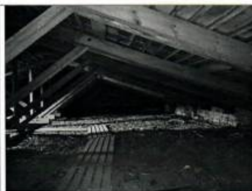
9. Вид на чердачное помещение
