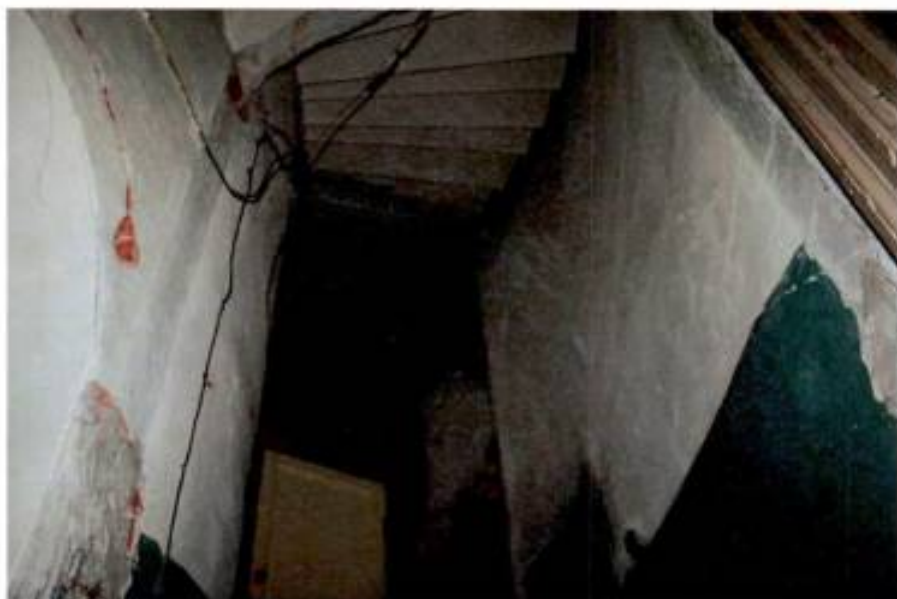
Фото №24. Ротонда 1-го этажа с кольцевой лестницей 3ЛК. Съемка: 19.04.2016.
