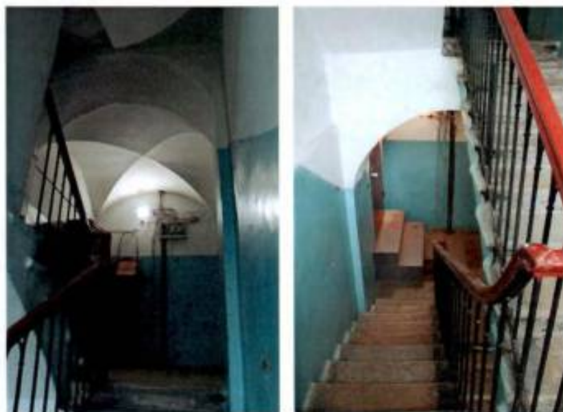
Фото №5, 6. Подъезд дворового (жилого) корпуса. Съемка: 19.04.2016.
