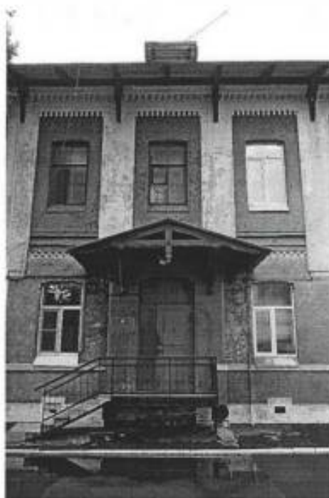
8. Фрагмент восточного фасада.
