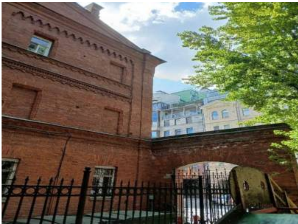
12. «Главное здание с каланчой, учебной башней, служебным корпусом, оградой и двумя воротами» (в составе «Пожарное отделение и полицейское управление Петровской части») (Мичуринская ул., д. 5, лит. А). Боковой фасад. Штиглиц М.С. 07.08.2026 г.
