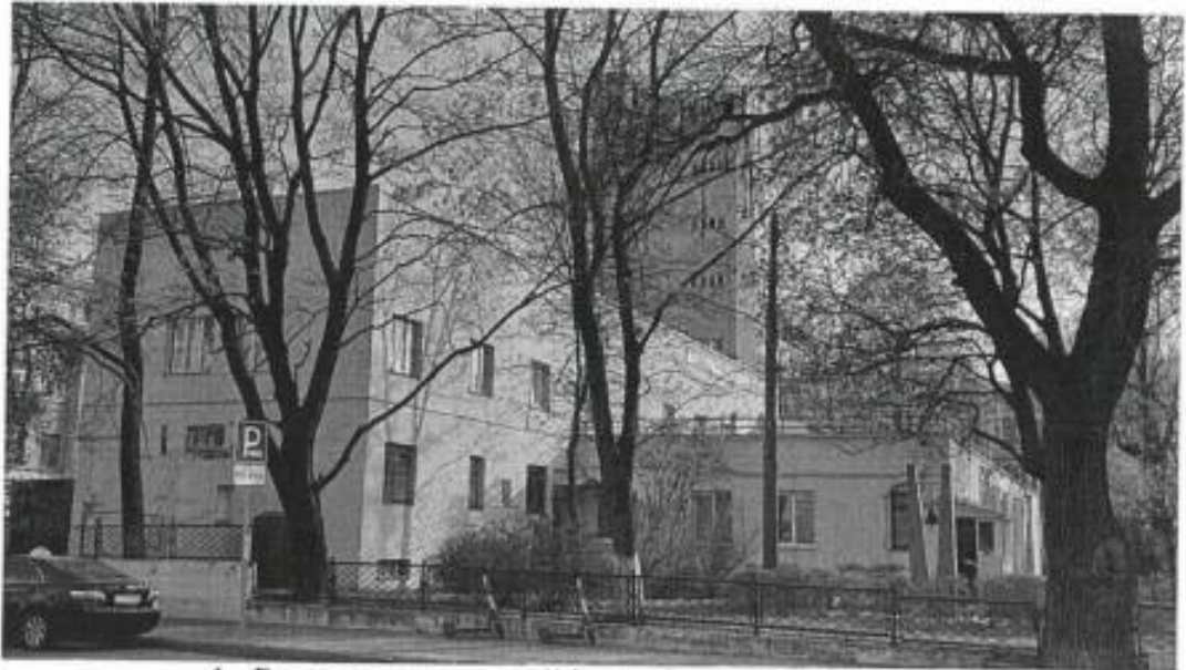
1. Вид на северо-восточный фасад объекта культурного наследия
