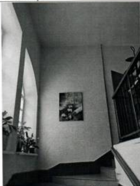
16. Вид на лестницу в пом. 2-Н.
