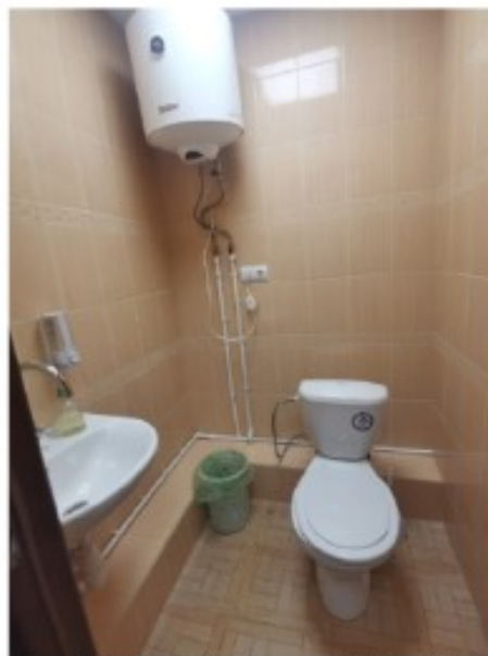
Фото 32. Пом. 14. Санузел. Общий вид.
