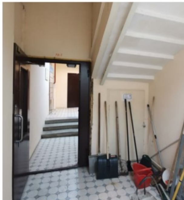
Фото 64. Пом. 7.3. Тамбур лестницы ЛК-7.
