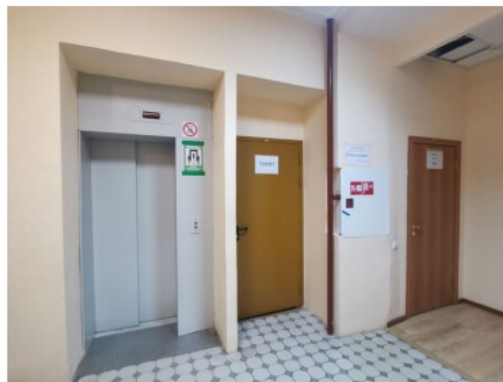
Фото 27. Пом. 6.6. Общий вид площадки лестницы ЛК-6.
