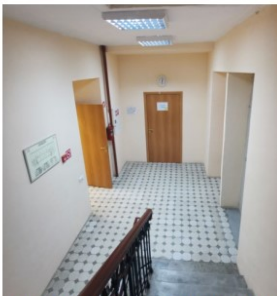
Фото 1. Пом. 7.6. Общий вид лестницы ЛК-7
