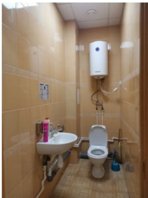
Фото 31. Пом.10. Санузел. Общий вид.
