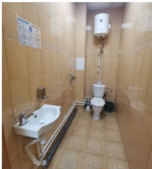
Фото 28. Пом. 8. Санузел. Общий вид
