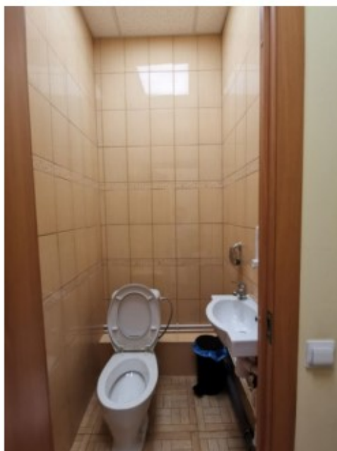
Фото 36. Пом. 14. Санузел. Общий вид.
