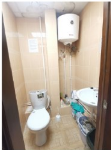
Фото 53. Пом. 25. Санузел. Общий вид.
