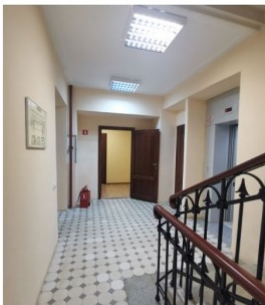
Фото 3. Пом. 7.10. Лестничная клетка ЛК-7. Общий вид.
