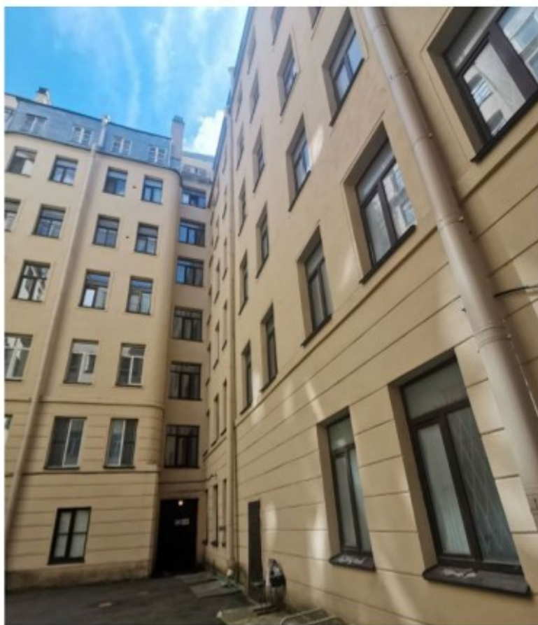
Фото 5. Фрагмент северо-восточного фасада здания во внутреннем дворе.
