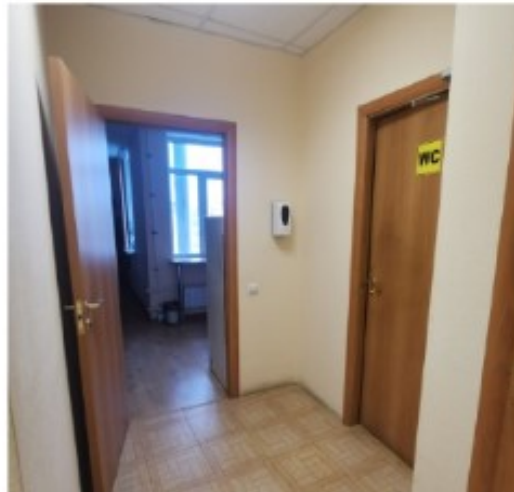
Фото 53. Пом. 23. Коридор. Общий вид в сторону санузлов.
