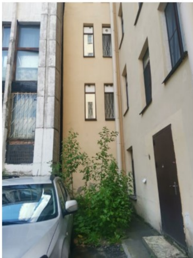
Фото 1. Фрагмент юго-восточного фасада здания.
