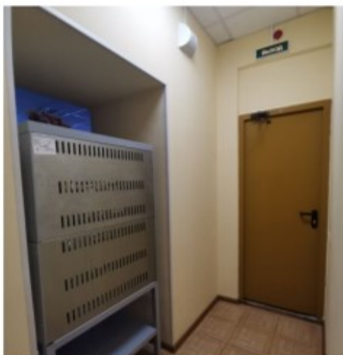
Фото 9. Пом. 3. Коридор. Выход на лестницу ЛК-6.
