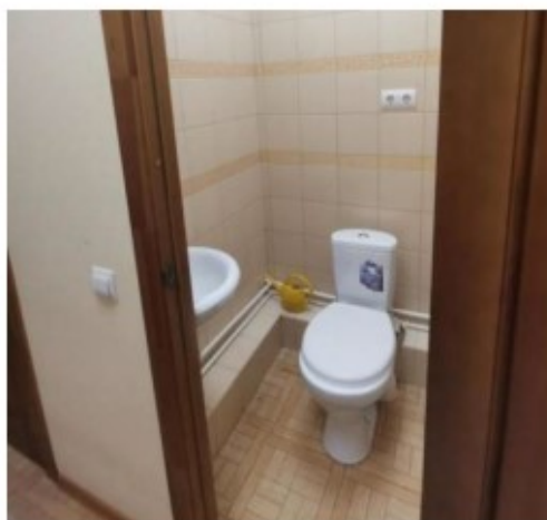
Фото 39. Пом. 20. Санузел. Общий вид.
