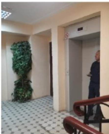
Фото 3. Пом. 7.11. Общий вид лестницы ЛК-7.
