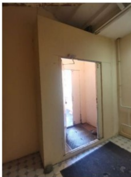
Фото 57. Пом. 6.2. Тамбур. Вид в сторону дверного заполнения.
