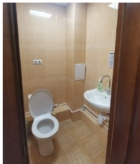
Фото 33. Пом. 15. Санузел. Общий вид.
