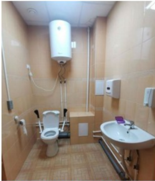
Фото 37. Пом.23. Санузел. Общий вид.
