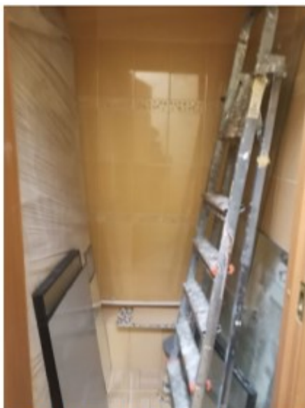
Фото 13. Пом. 7. Санузел. Общий вид.
