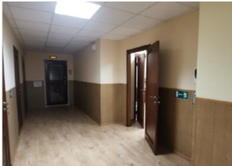
Фото 8. Пом. 1. Коридор. Общий вид.
