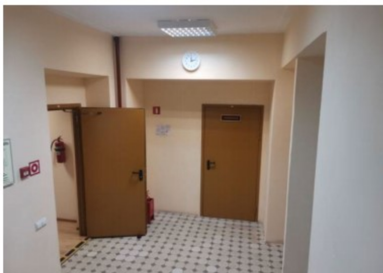
Фото 3. Пом. 7.9. Общий вид лестничной площадки лестницы ЛК-7.
