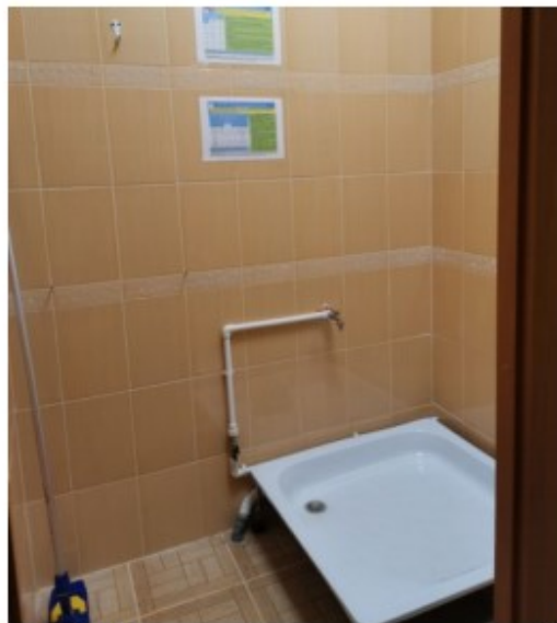
Фото 44. Пом.14. Комната уборочного инвентаря. Общий вид.
