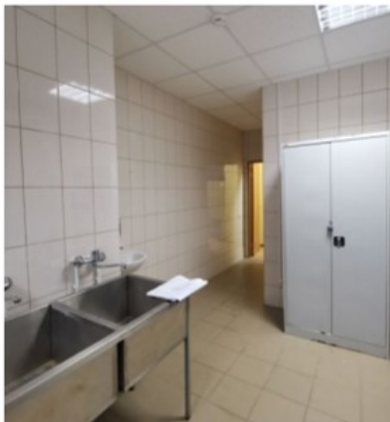
Фото 16. Пом. 4. Класс производственного обучения. Общий вид.
