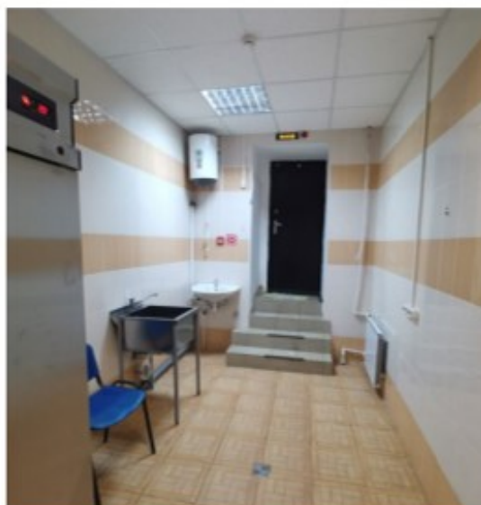
Фото 29. Пом. 15. Тамбур. Общий вид. Выход.
