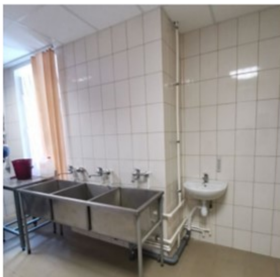
Фото 17. Пом. 4. Класс производственного обучения. Общий вид.
