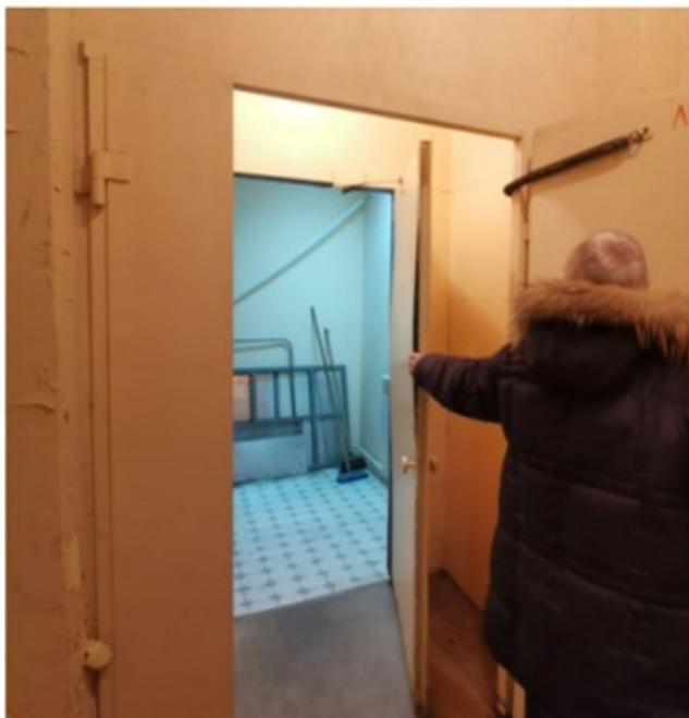
Фото 63. Пом. Пом. 7.2. Тамбур лестницы ЛК-7.
