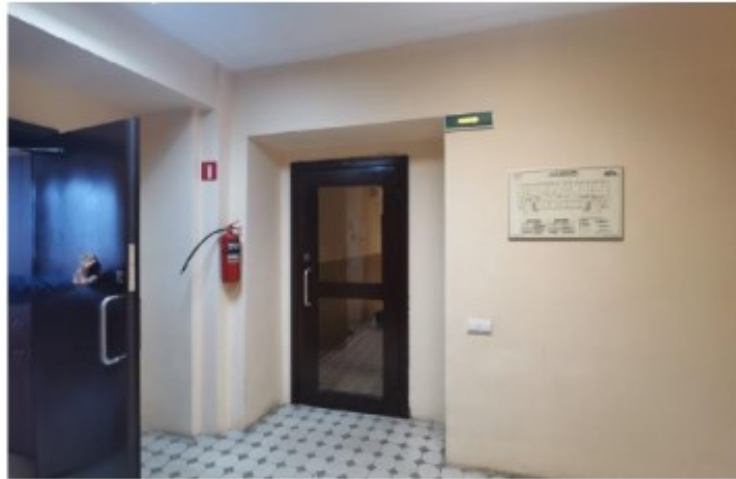
Фото 46. Пом. 6.10. Общий вид лестницы ЛК-7.
