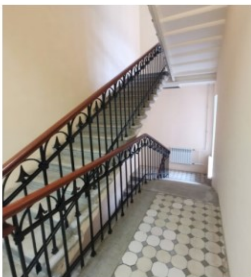
Фото 2. Пом. 7.7. Общий вид лестницы ЛК-7.
