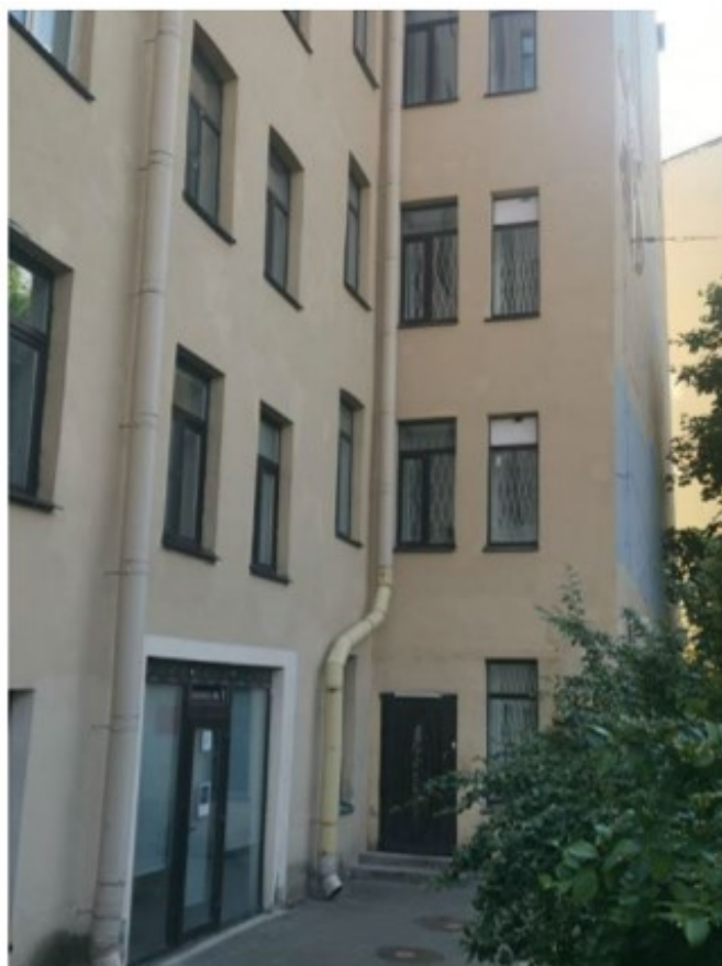
Фото 13. Фрагмент северо-восточного фасада здания.
