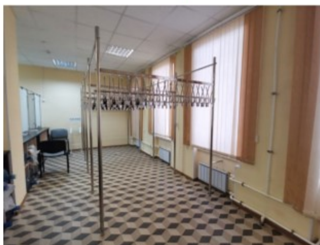
Фото 45. Пом. 27. Гардероб. Общий вид.
