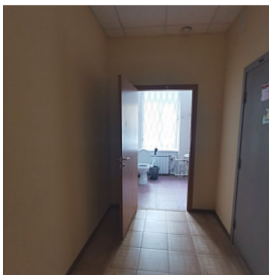
Фото 37. Пом. 20. Коридор. Общий вид.
