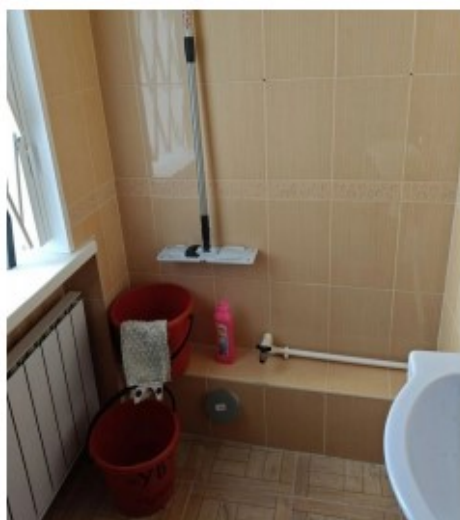
Фото 38. Пом. 14. Санузел. Общий вид.
