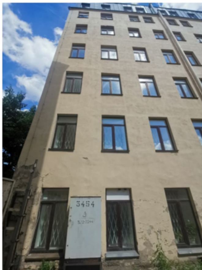
Фото 18. Юго-западный фасад здания. Фрагмент.
