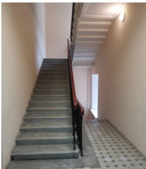
Фото 1. Пом. 7.7. Общий вид лестницы ЛК-7.
