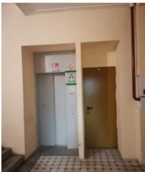
Фото 53. Пом. 6.3. Лестница ЛК-6. Общий вид.
