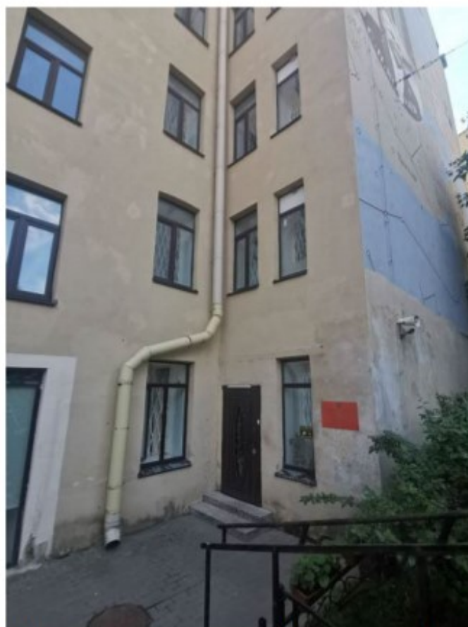
Фото 14. Фрагмент северо-восточного фасада здания. Вид с севера
