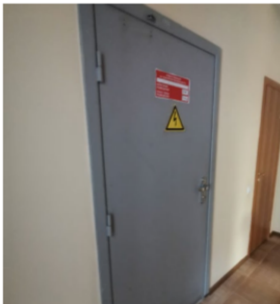
Фото 38. Пом. 20. Коридор. Вход в Пом. 23.
