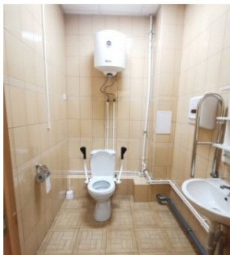
Фото 39. Пом. 17. Санузел для МГН. Общий вид.
