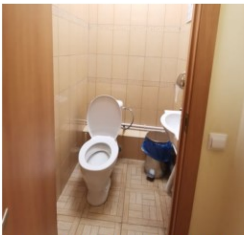
Фото 37. Пом. 16. Санузел. Общий вид.
