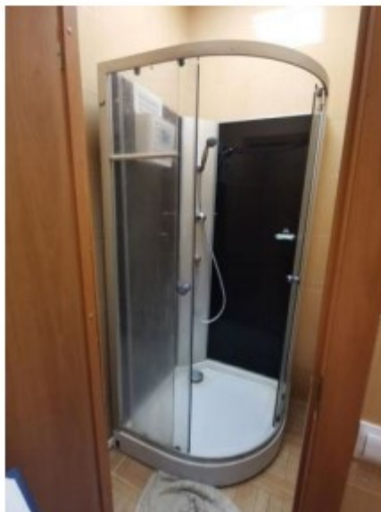
Фото 39. Пом.21. Душевая. Общий вид.
