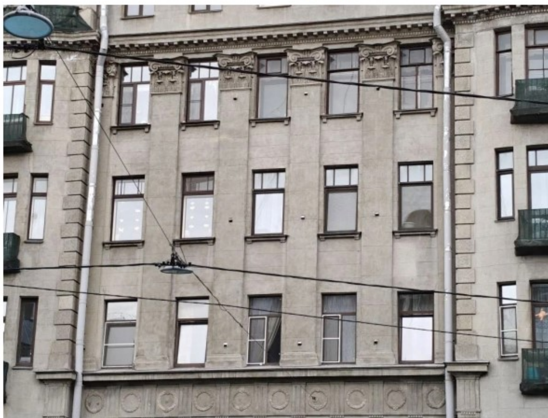
Фото 23. Оконные заполнения главного фасада выявленного объекта культурного наследия «Дом Ф.П. Петрова (Д.Г. Лурье)».
