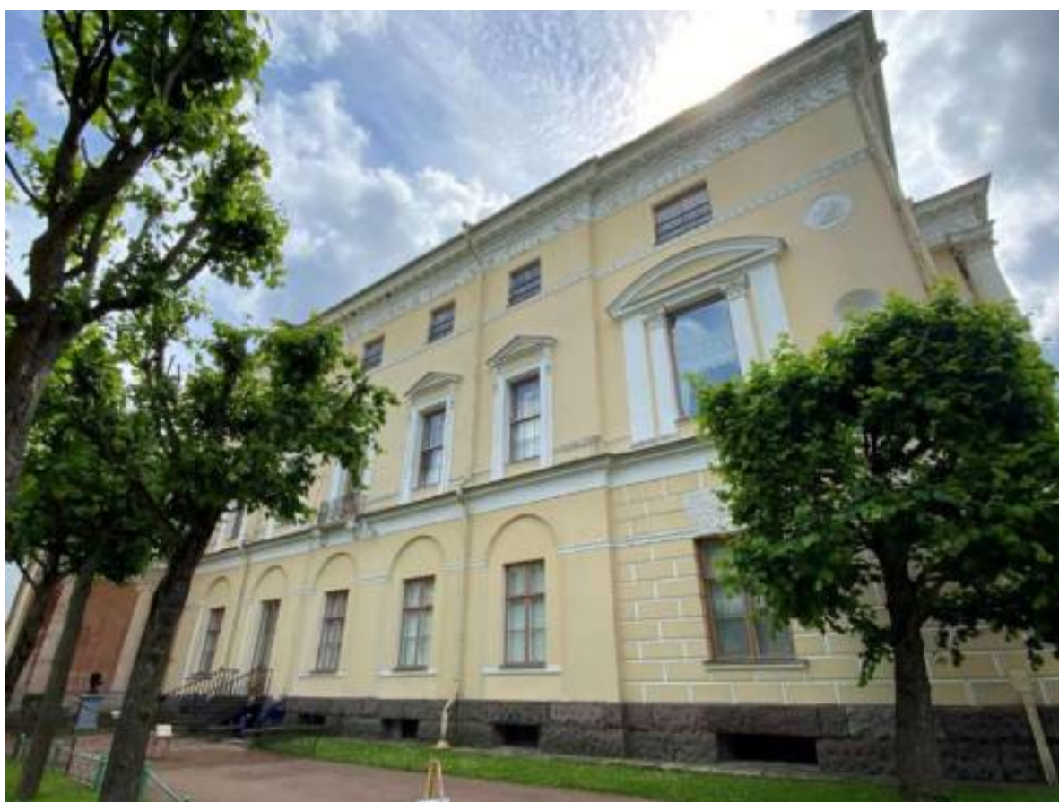
Фото 34. Вид на Центральный корпус (лит. А4) со стороны парка.
