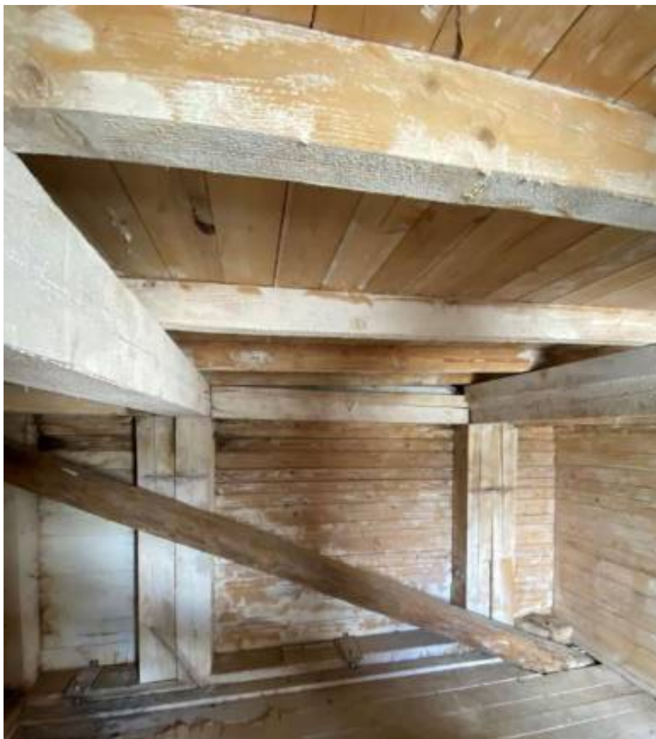
Фото 81. Чердачное пространство Северного прямоугольного корпуса (лит. А6).
