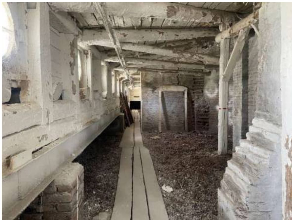
Фото 67. Чердачное пространство Центрального корпуса (лит. А4).
