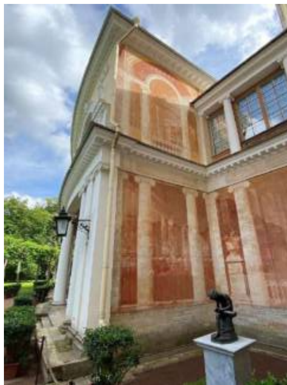
Фото 39. Вид на Северный полуциркульный корпус с колоннадой (лит. А5) со стороны парка.
