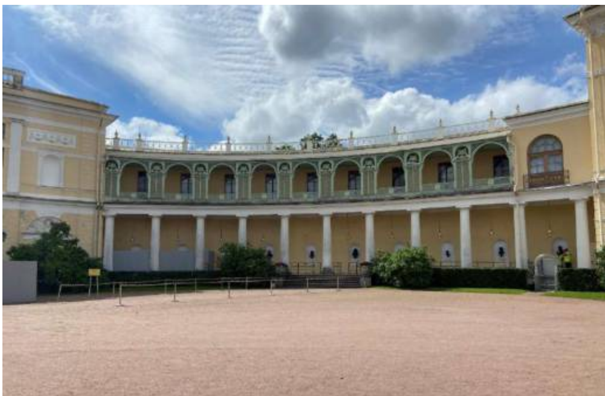
Фото 9. Вид на Южный полуциркульный корпус с колоннадой (лит. А3) со стороны парадного двора.
