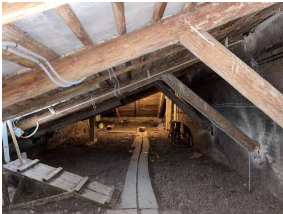
Фото 58. Чердачное пространство Церковного корпуса (лит. А2).
