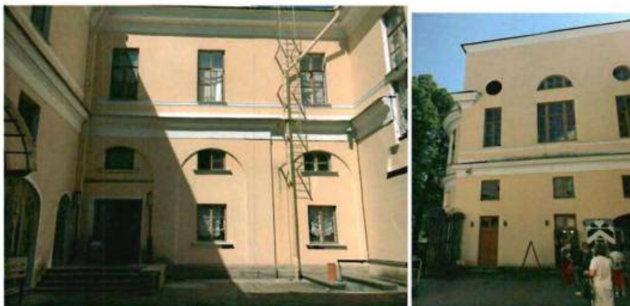
16, 17. Общий вид фасадов со стороны внутреннего двора.
