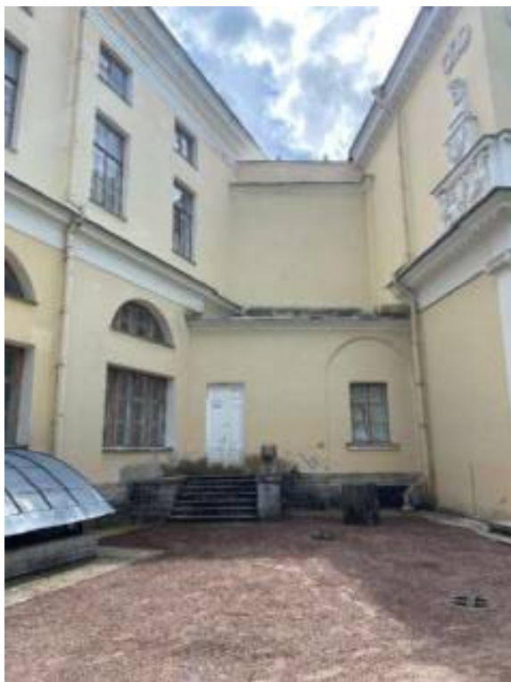
Фото 46. Вид на фрагмент Северного полуциркульного корпуса с колоннадой (лит. А5) со стороны парка.
