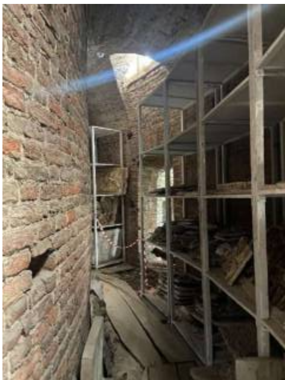
Фото 71. Чердачное пространство Центрального корпуса (лит. А4).
