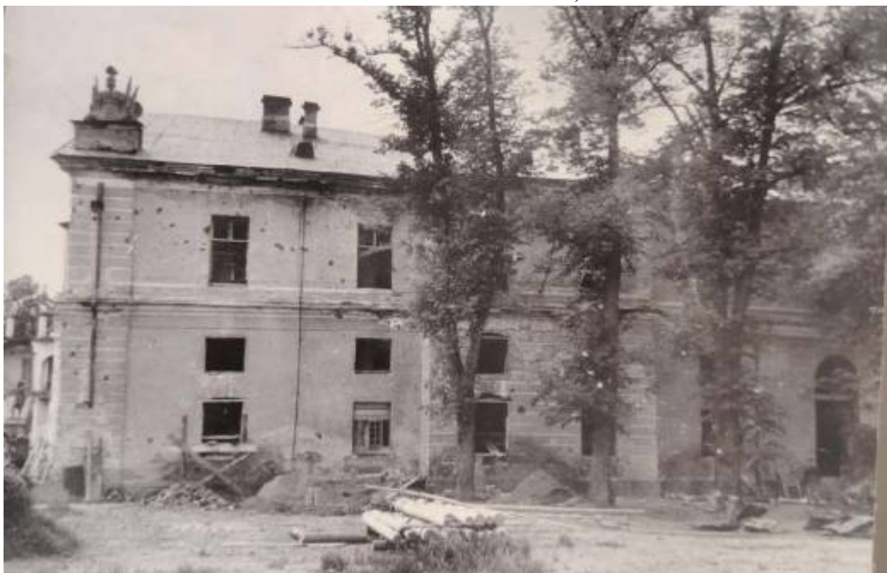
Илл. 83. Северо-восточный фасад северного полуциркульного корпуса. Левая часть. 1946 г. (источник: Научный архив ГМЗ «Павловск». Инв. № 4274. Нег.б-814).
