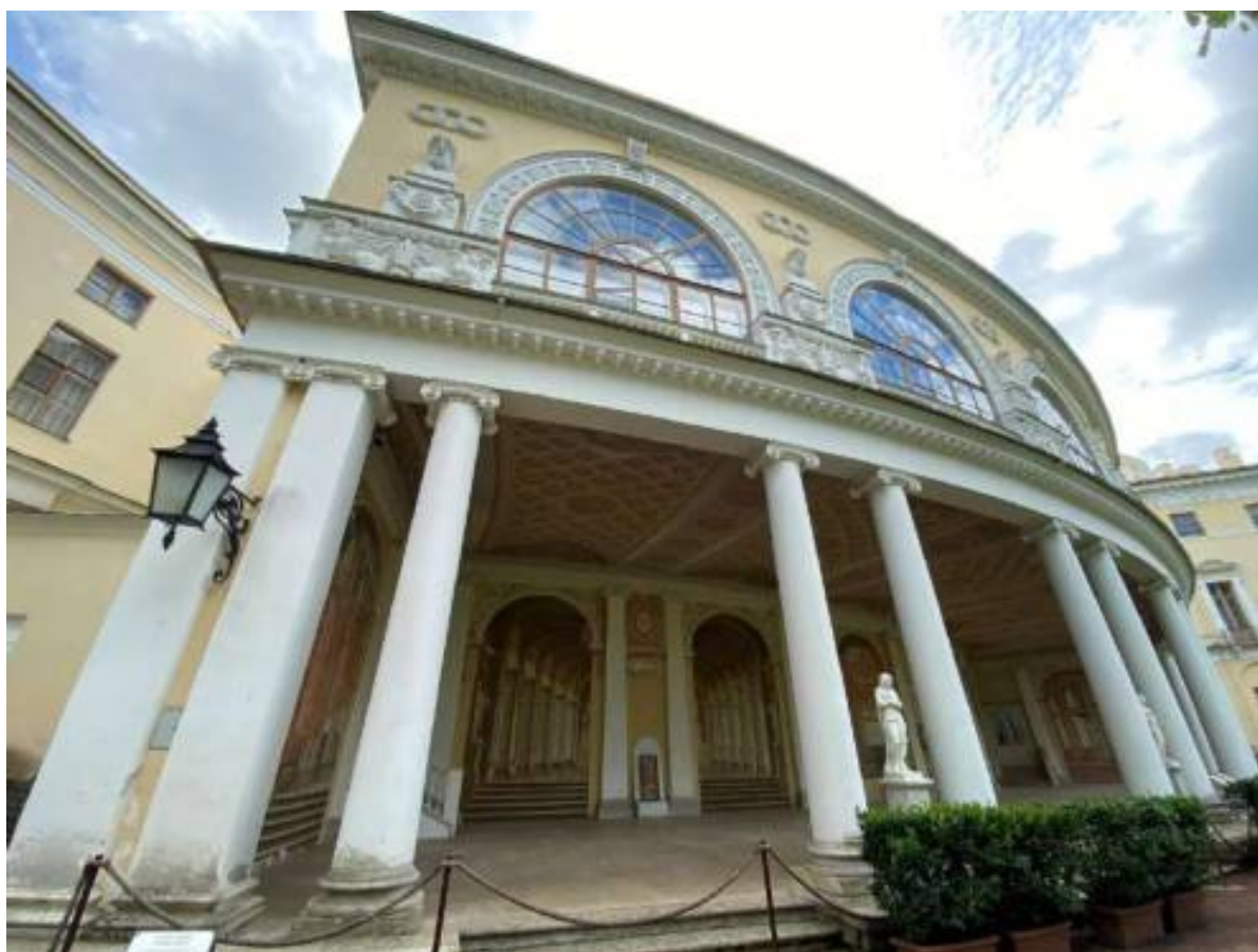
Фото 44. Вид на Северный полуциркульный корпус с колоннадой (лит. А5) со стороны парка.
