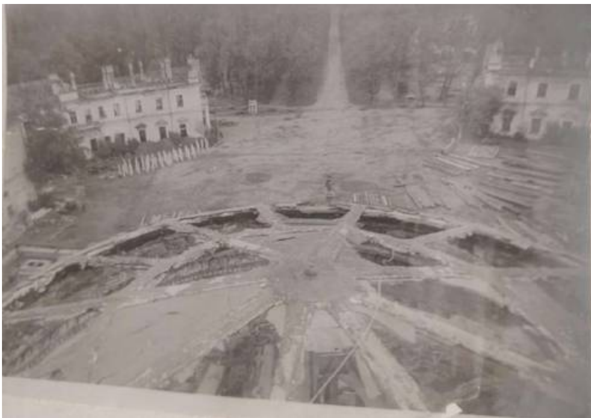
Илл. 74. Перекрытие купола дворца. 1945 г. (источник: Научный архив ГМЗ «Павловск». Инв. № 664. Нег.б-2210).
