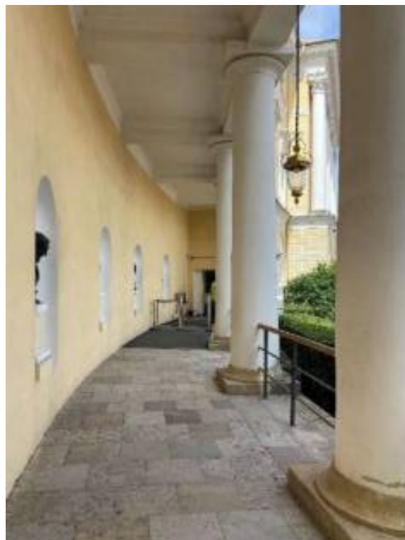
Фото 11. Вид на колоннаду Южного полуциркульного корпуса с колоннадой (лит. А3).
