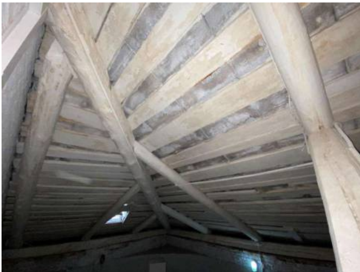
Фото 50. Чердачное пространство Церковного корпуса (лит. А2).
