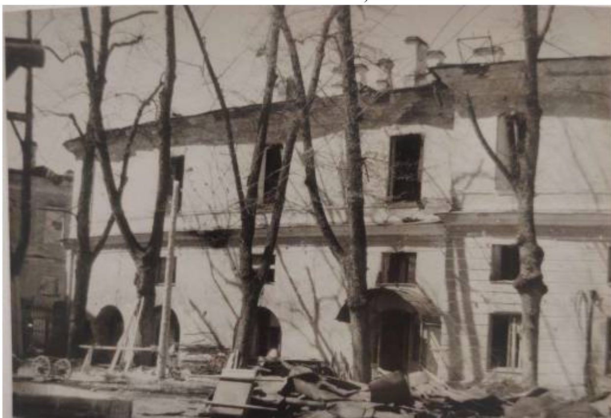
Илл. 77. Левая часть фасада южного полуциркульного крыла со стороны дороги. Навес над проемом. 1946 г. (источник: Научный архив ГМЗ «Павловск». Инв. № 4052. Нег.б-732).
