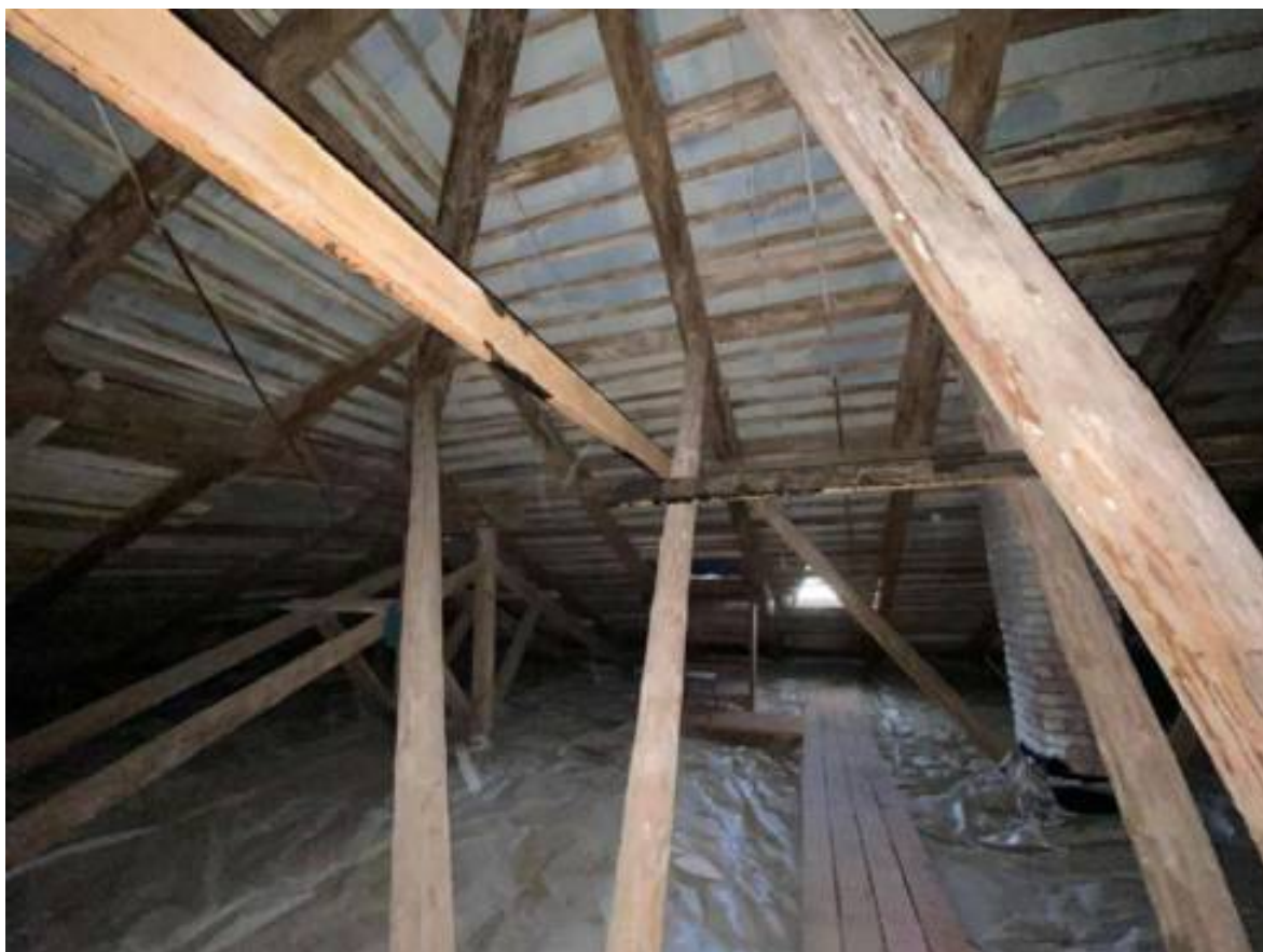
Фото 78. Чердачное пространство Северного прямоугольного корпуса (лит. А6).
