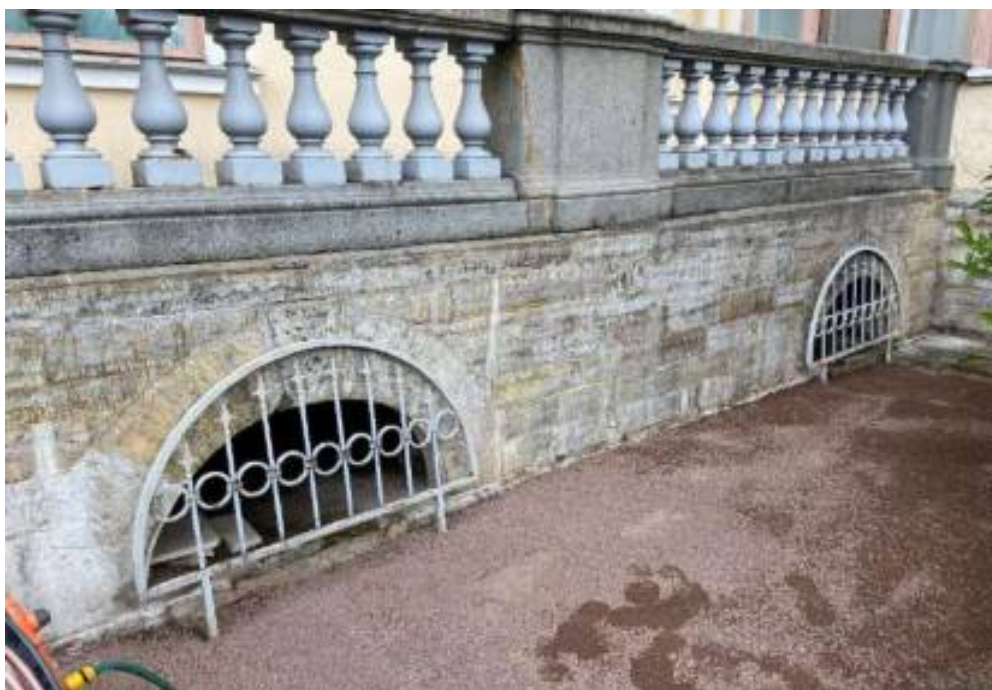
Фото 30. Вид на фрагмент Церковного корпуса (лит. А2) со стороны Собственного сада.
