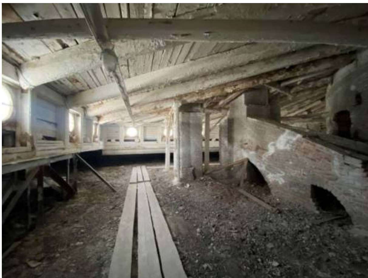
Фото 66. Чердачное пространство Центрального корпуса (лит. А4).
