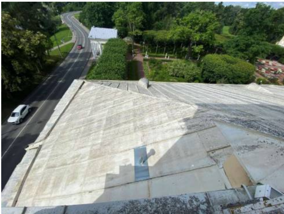
Фото 94. Вид на крышу Церковного корпуса (лит. А2).
