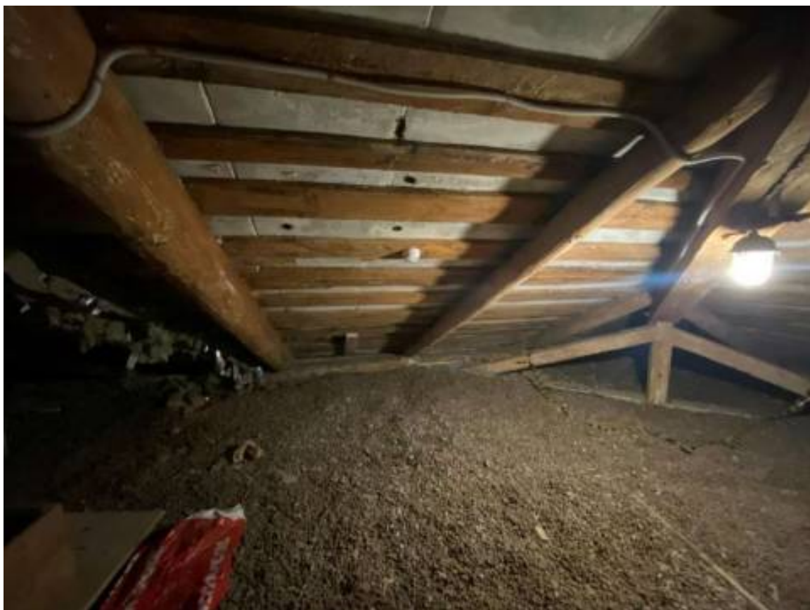
Фото 53. Чердачное пространство Церковного корпуса (лит. А2).
