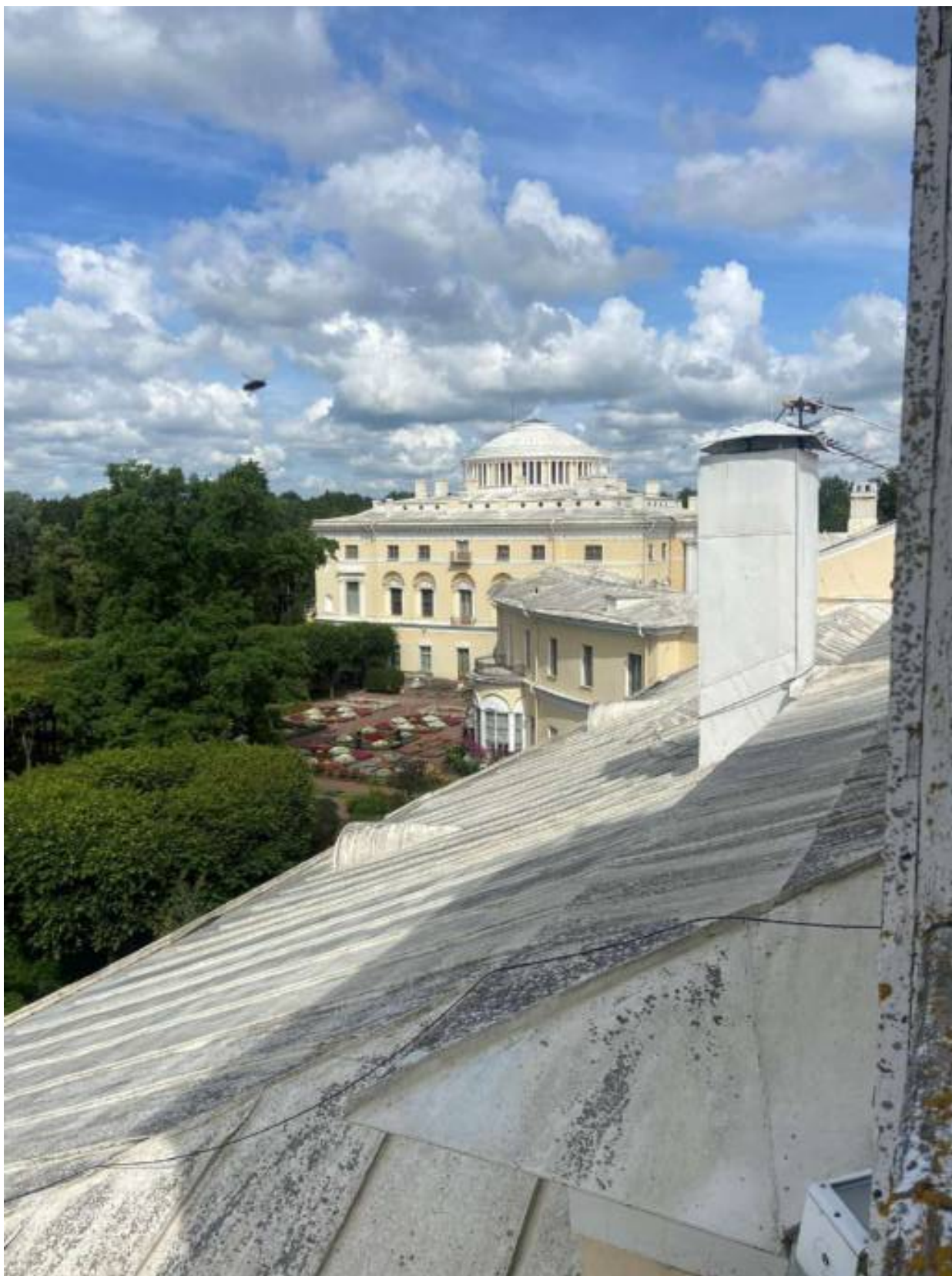
Фото 95. Вид на крышу южных и центрального корпусов.
