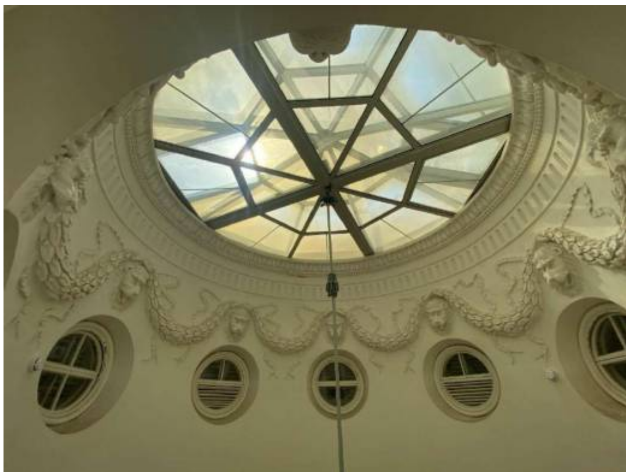
Фото 77. Фонарь Центрального корпуса (лит. А4).
