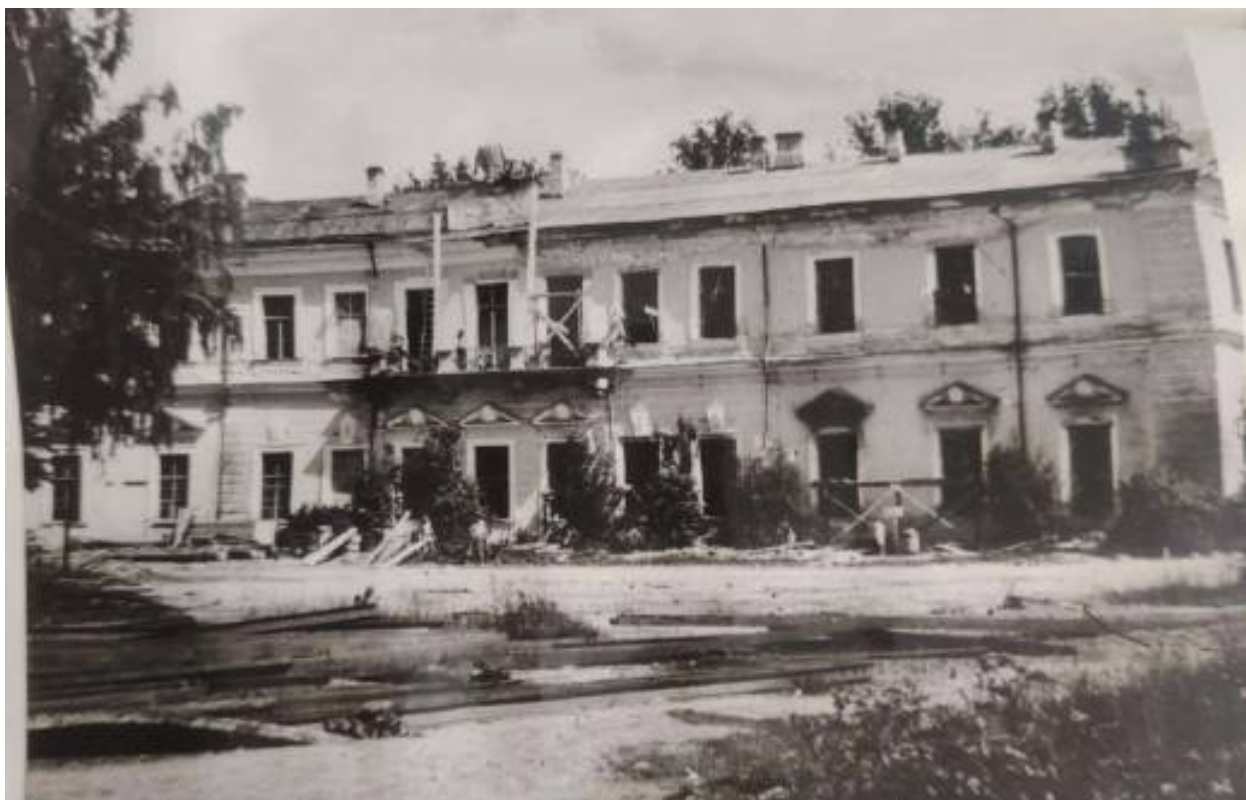
Илл. 80. Юго-западный фасад северного полуциркульного корпуса. 1946 г. (источник: Научный архив ГМЗ «Павловск». Инв. № б/н).
