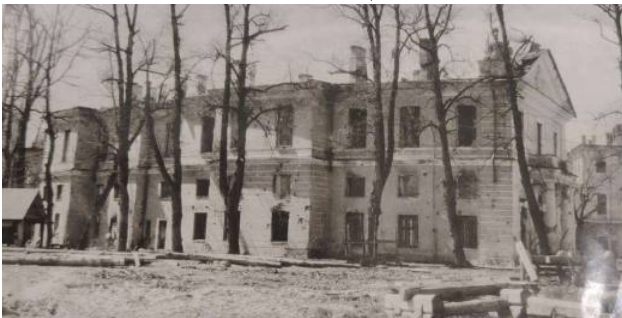
Илл. 79. Правая часть фасада южного полуциркульного крыла со стороны дороги. 1946 г. (источник: Научный архив ГМЗ «Павловск». Инв. № 4044. Нег.б-729).
