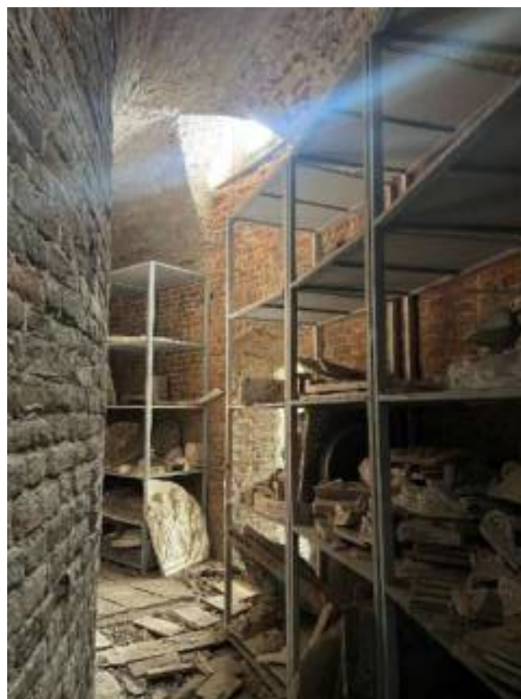
Фото 72. Чердачное пространство Центрального корпуса (лит. А4).
