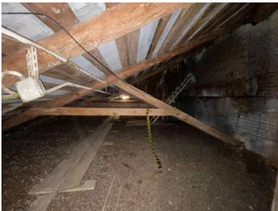
Фото 54. Чердачное пространство Церковного корпуса (лит. А2).
