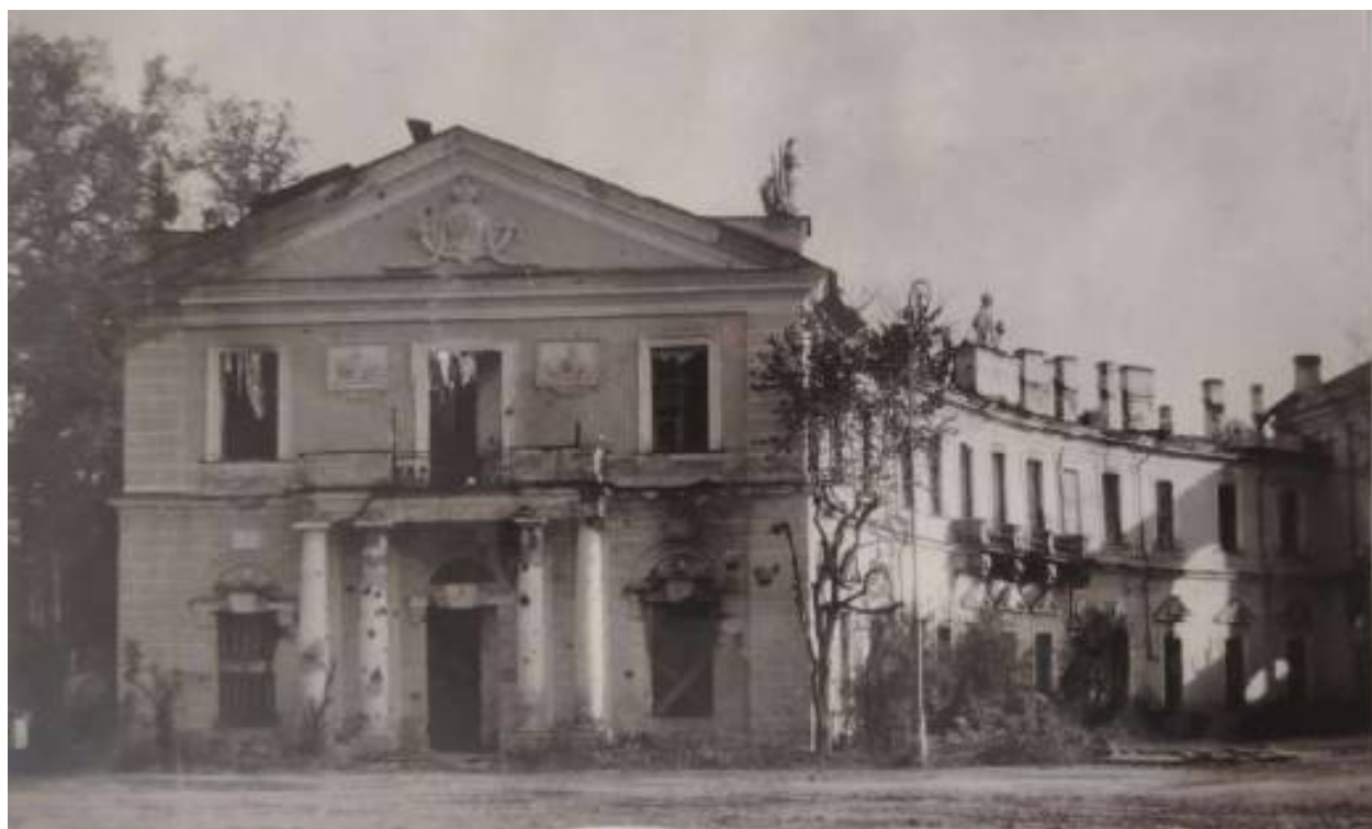
Илл. 73. Южный полуциркульный корпус. Торцевой и северо-западный фасад. 1944-1945 г. (источник: Научный архив ГМЗ «Павловск». XVIII. 5.22.14. Инв. № б/н).
