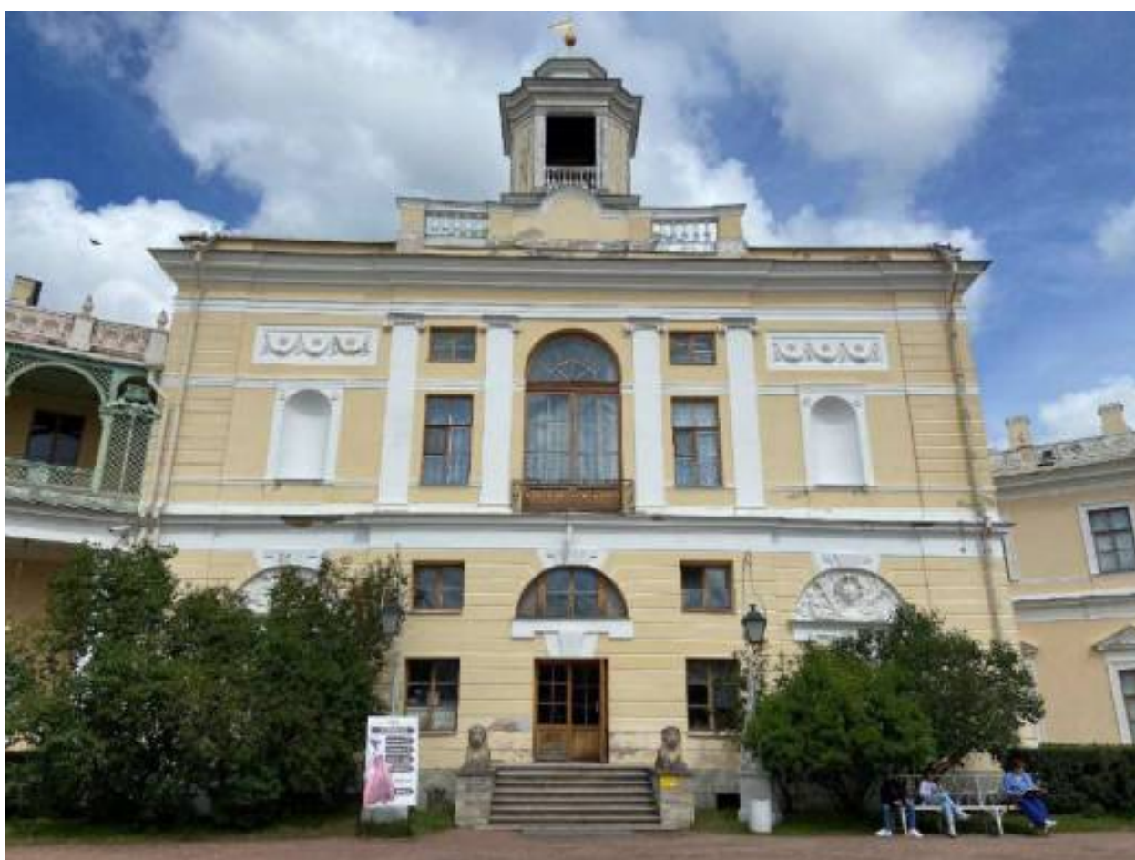
Фото 2. Вид на Северный прямоугольный корпус (лит. А6) со стороны парадного двора.
