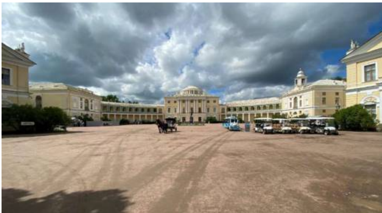
Фото 1. Вид на объект со стороны парадного двора.
