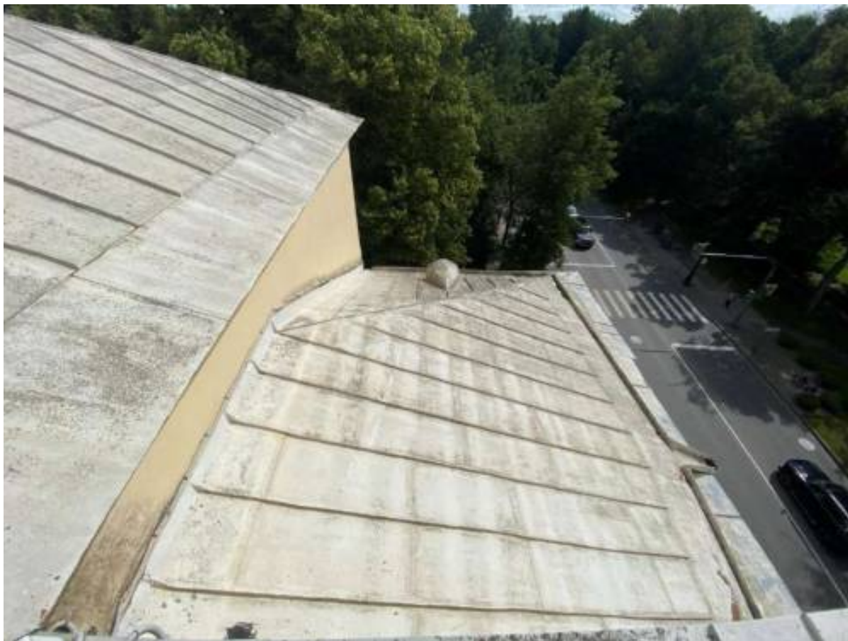
Фото 93. Вид на крышу Церковного корпуса (лит. А2).
