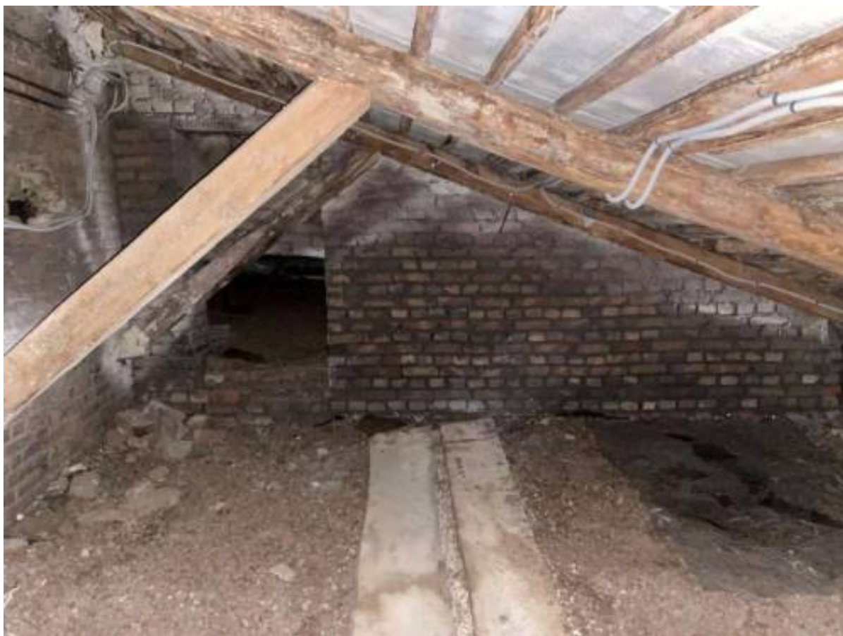
Фото 59. Чердачное пространство Церковного корпуса (лит. А2).
