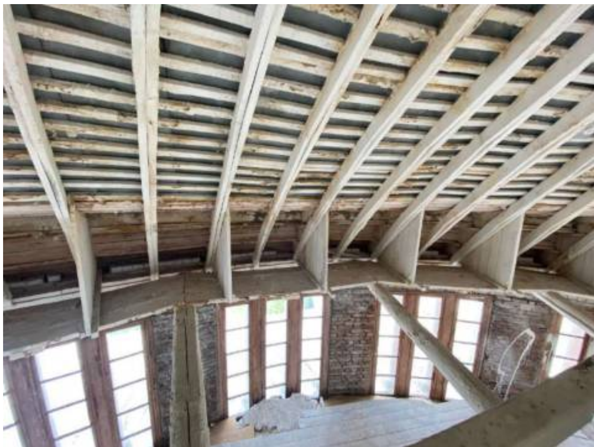
Фото 76. Чердачное пространство Центрального корпуса (лит. А4).
