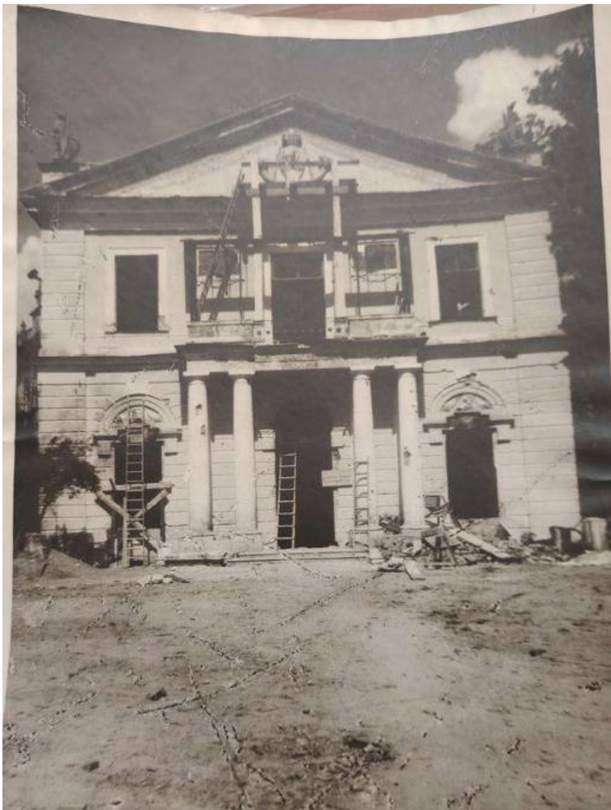
Илл. 85. Торцевой фасад левого служебного крыла. 1946 г. (источник: Научный архив ГМЗ «Павловск». Инв. № 9191).
