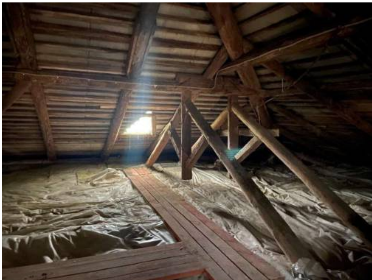
Фото 79. Чердачное пространство Северного прямоугольного корпуса (лит. А6).
