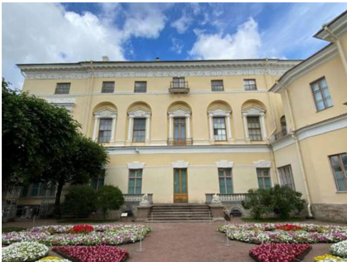
Фото 31. Вид на Церковный корпус (лит. А2) со стороны Собственного сада.
