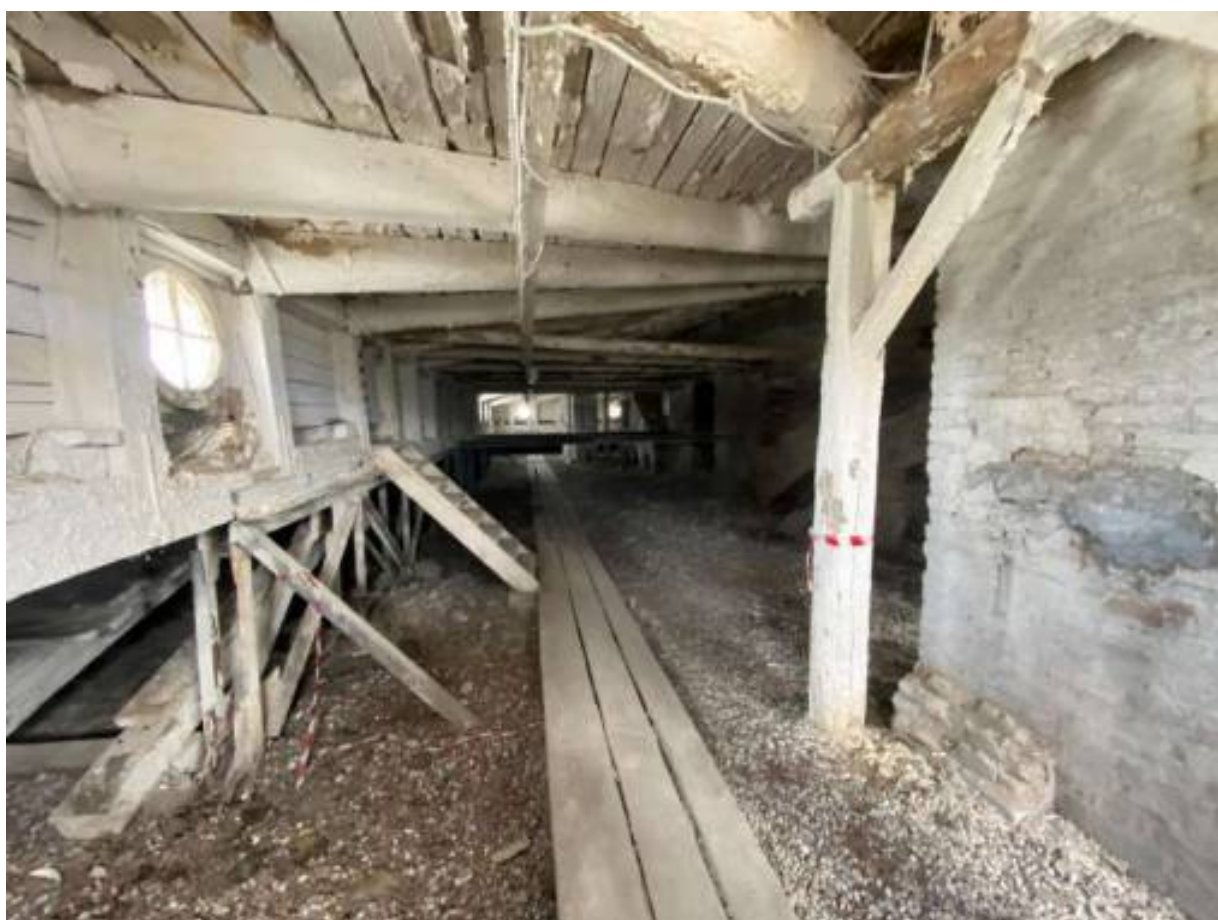
Фото 64. Чердачное пространство Центрального корпуса (лит. А4).
