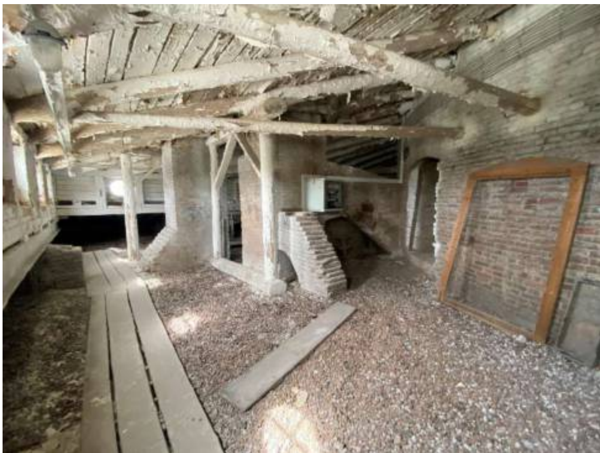
Фото 63. Чердачное пространство Центрального корпуса (лит. А4).
