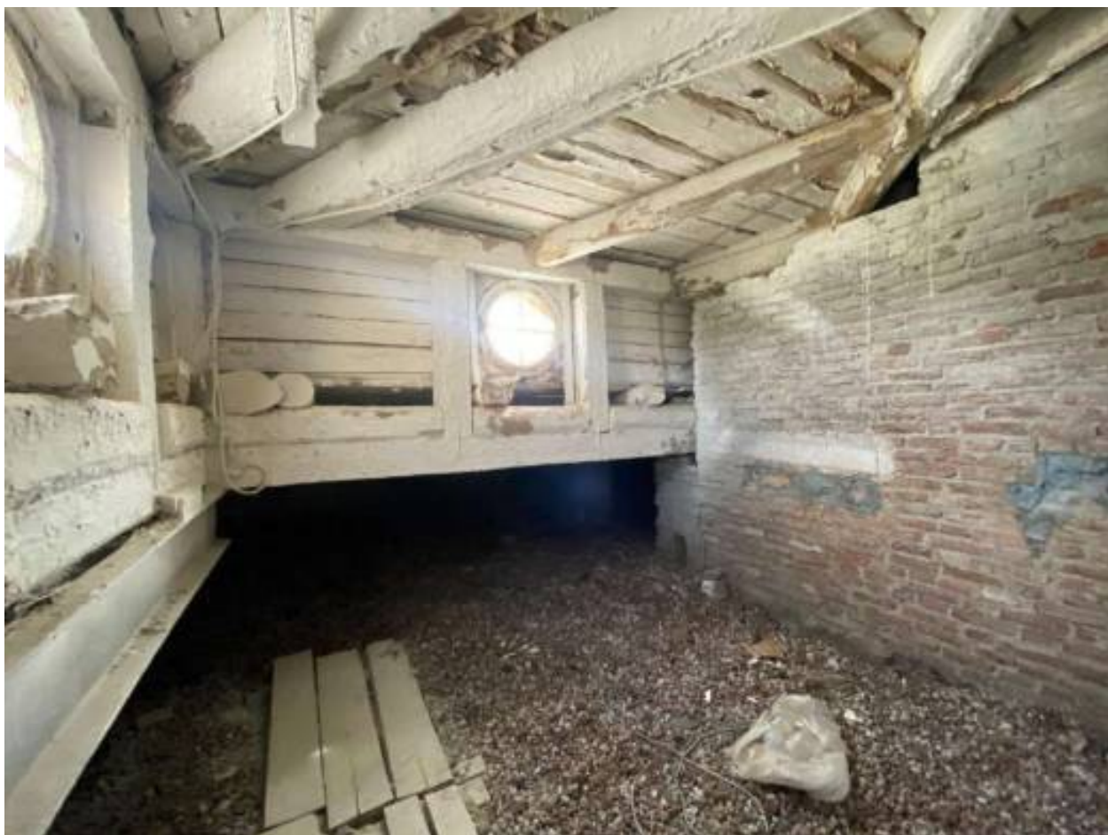
Фото 69. Чердачное пространство Центрального корпуса (лит. А4).
