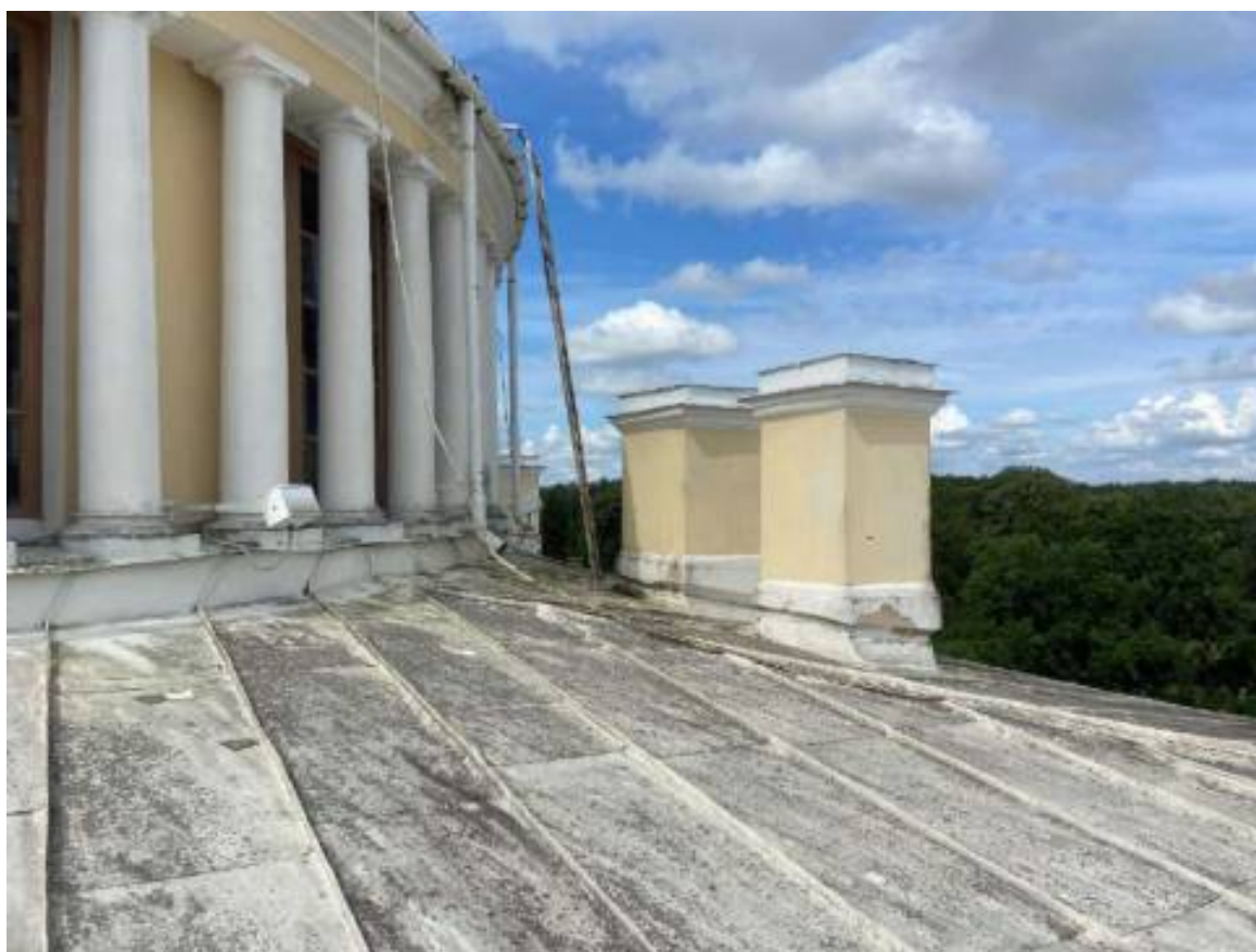
Фото 88. Вид на крышу Центрального корпуса (лит. А4).
