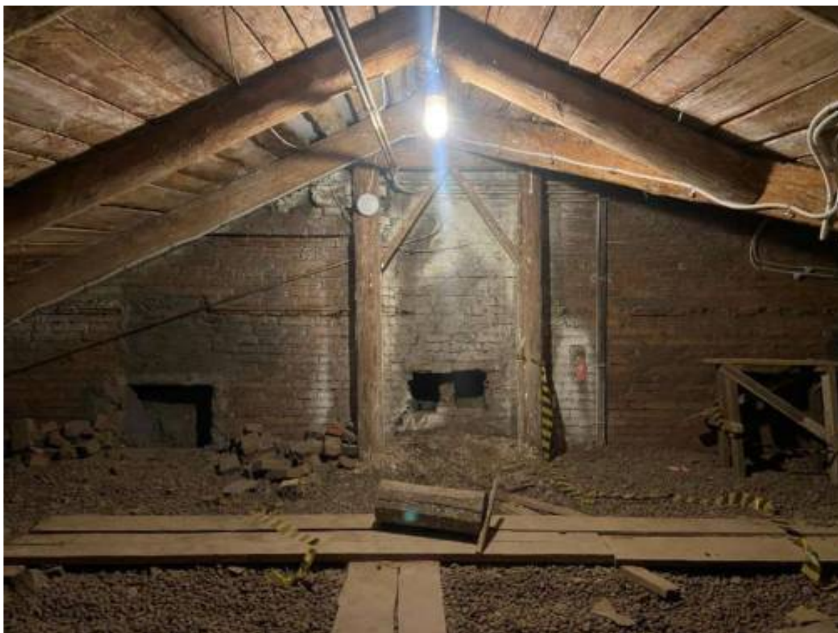
Фото 55. Чердачное пространство Церковного корпуса (лит. А2).
