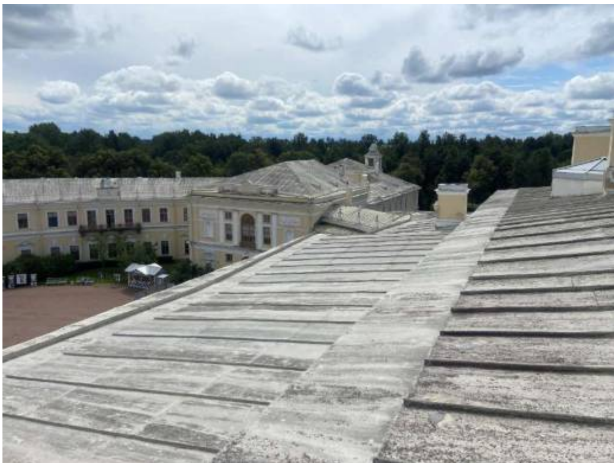
Фото 87. Вид на крышу центрального и южного корпусов.
