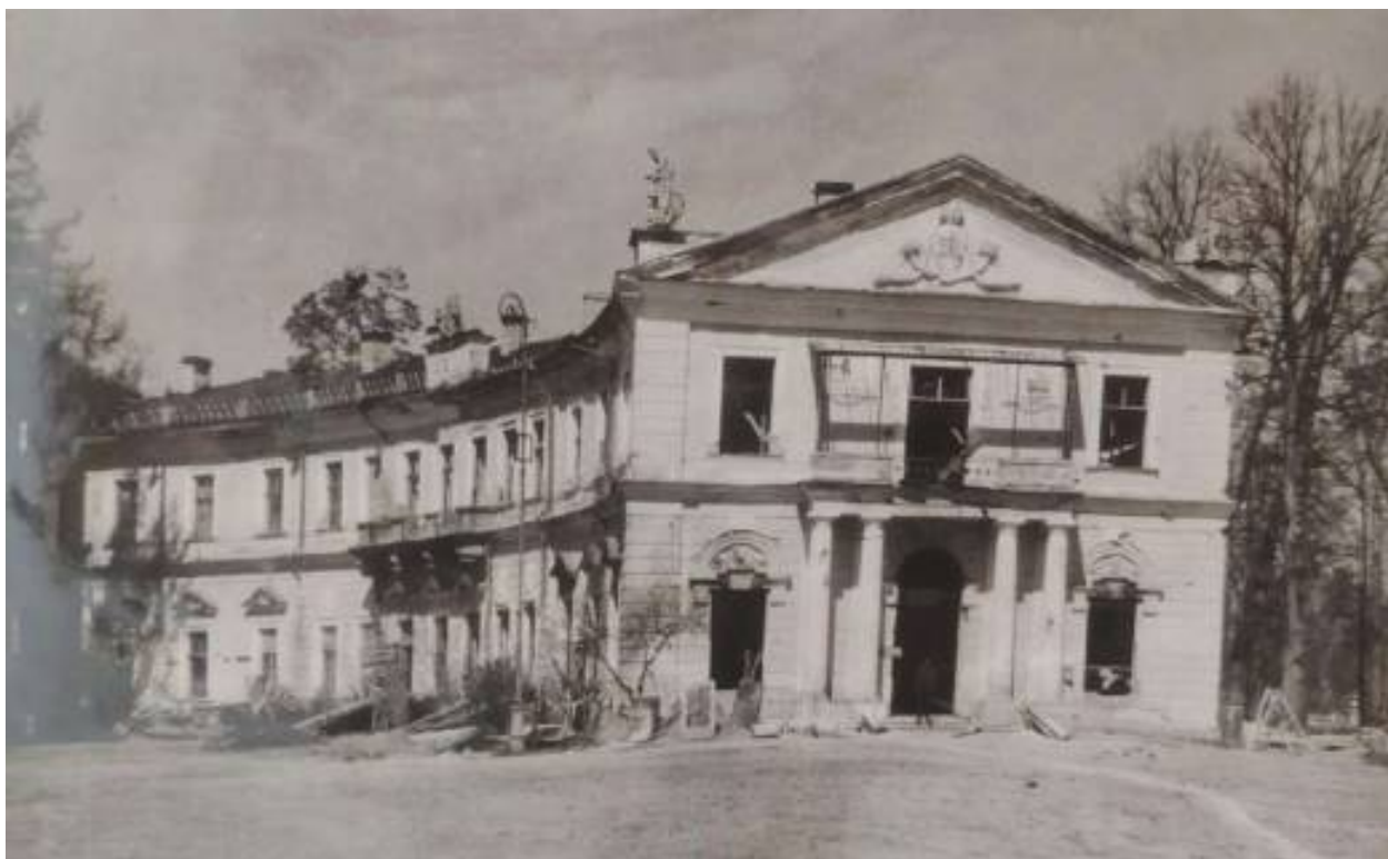
Илл. 82. Юго-западный и торцевой фасад северного полуциркульного корпуса. 1946 г. (источник: Научный архив ГМЗ «Павловск». Инв. № 4026. Нег.б-723).
