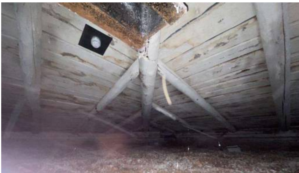
Фото 70. Чердачное пространство Центрального корпуса (лит. А4).
