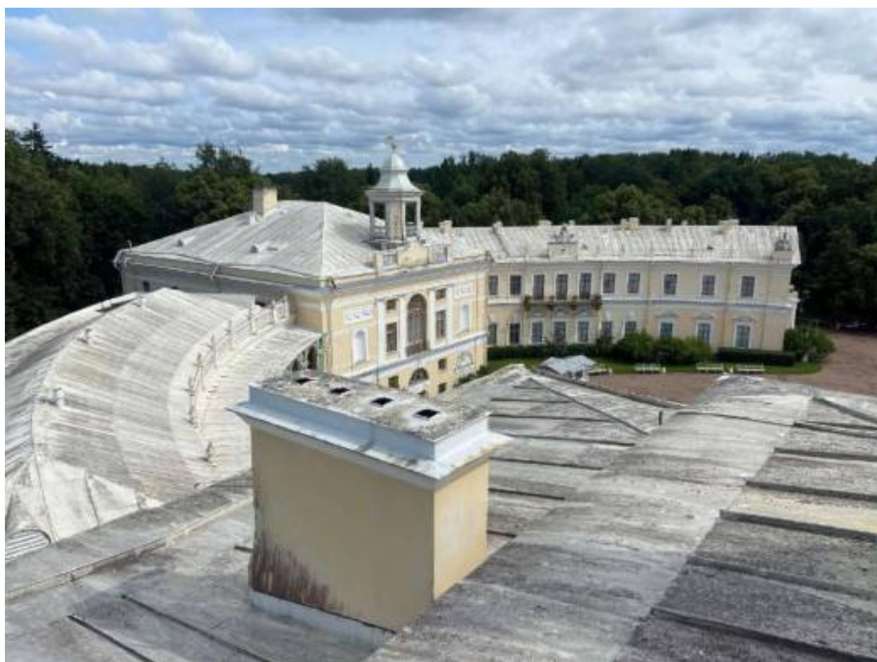
Фото 86. Вид на крышу северных корпусов.
