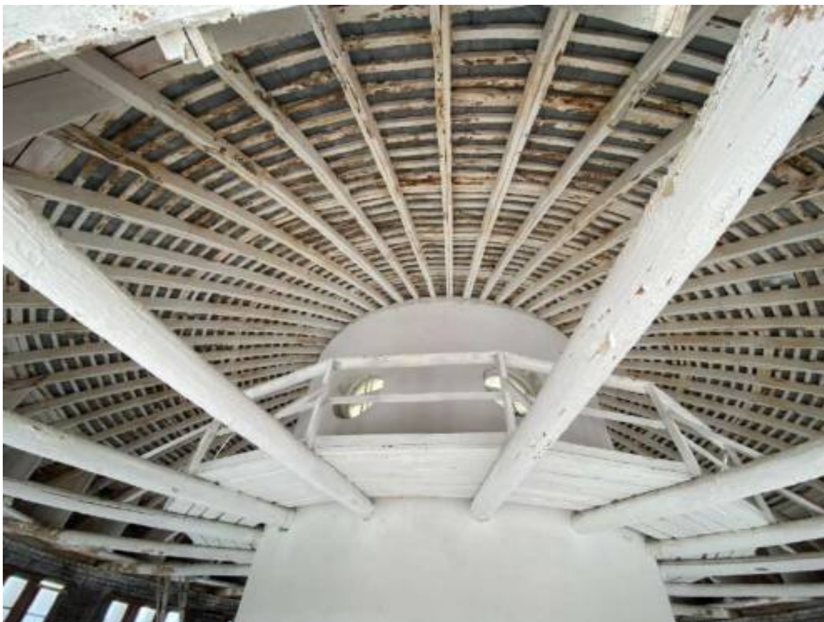
Фото 75. Чердачное пространство Центрального корпуса (лит. А4).
