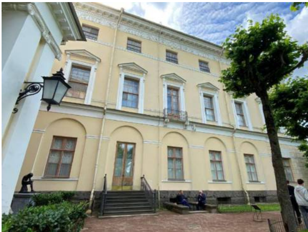
Фото 35. Вид на Центральный корпус (лит. А4) со стороны парка.
