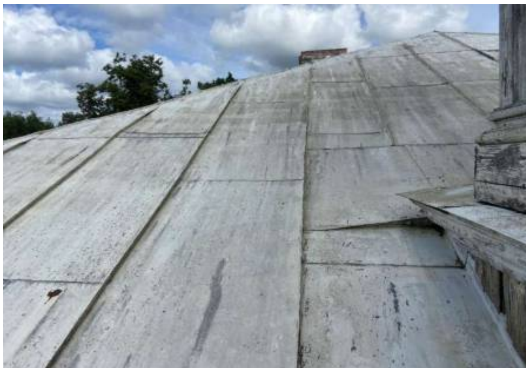
Фото 82. Вид на фрагмент крыши здания.
