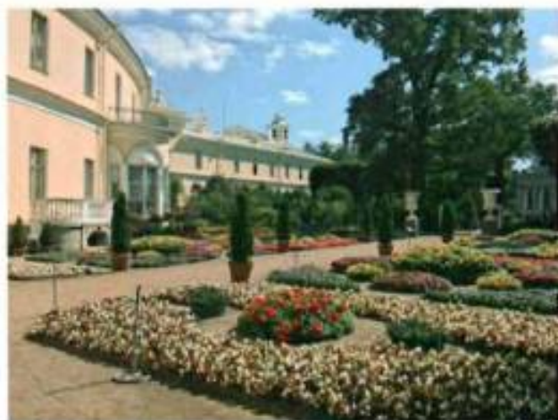
12. Западный фасад южной галереи.
