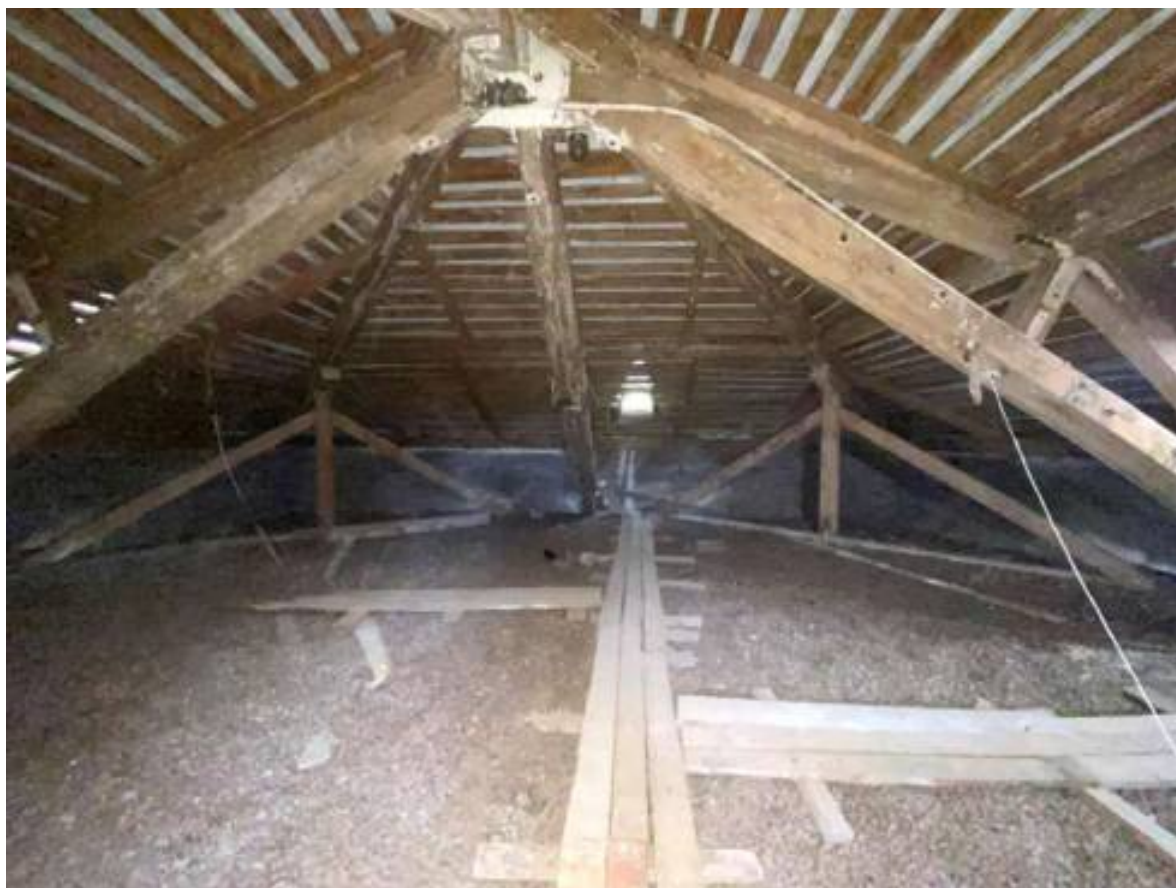
Фото 51. Чердачное пространство Церковного корпуса (лит. А2).
