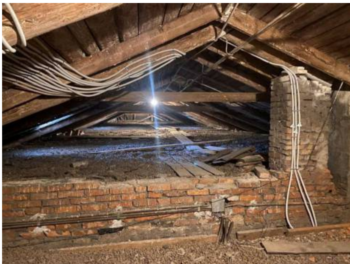
Фото 56. Чердачное пространство Церковного корпуса (лит. А2).
