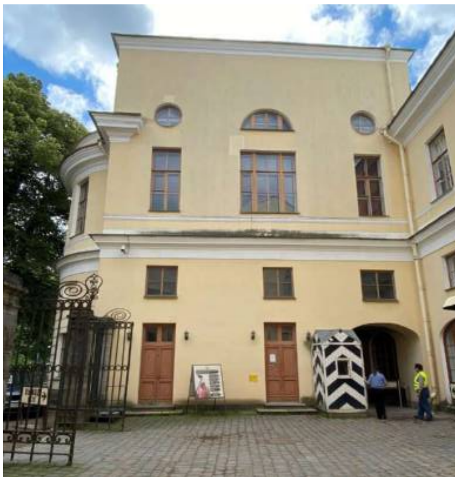
Фото 16. Вид на Церковный корпус (лит. А2) со стороны Церковного дворика.
