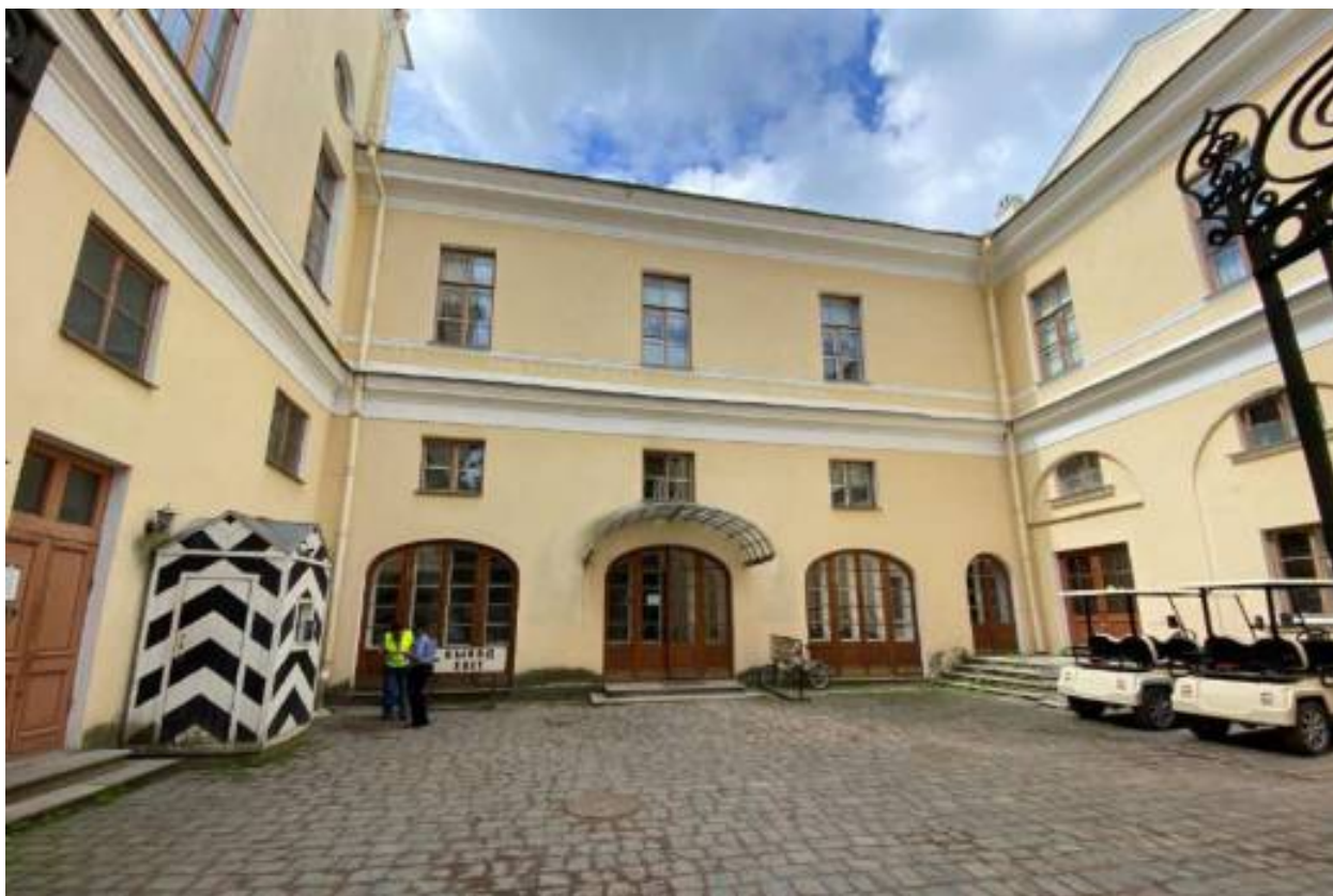
Фото 15. Вид на Церковный корпус (лит. А2) со стороны Церковного дворика.
