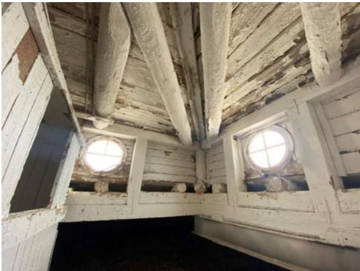
Фото 60. Чердачное пространство Центрального корпуса (лит. А4).
