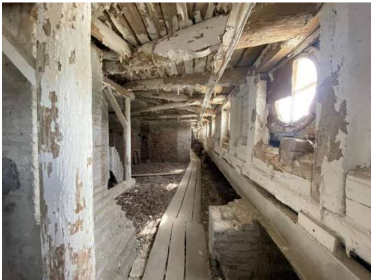
Фото 65. Чердачное пространство Центрального корпуса (лит. А4).
