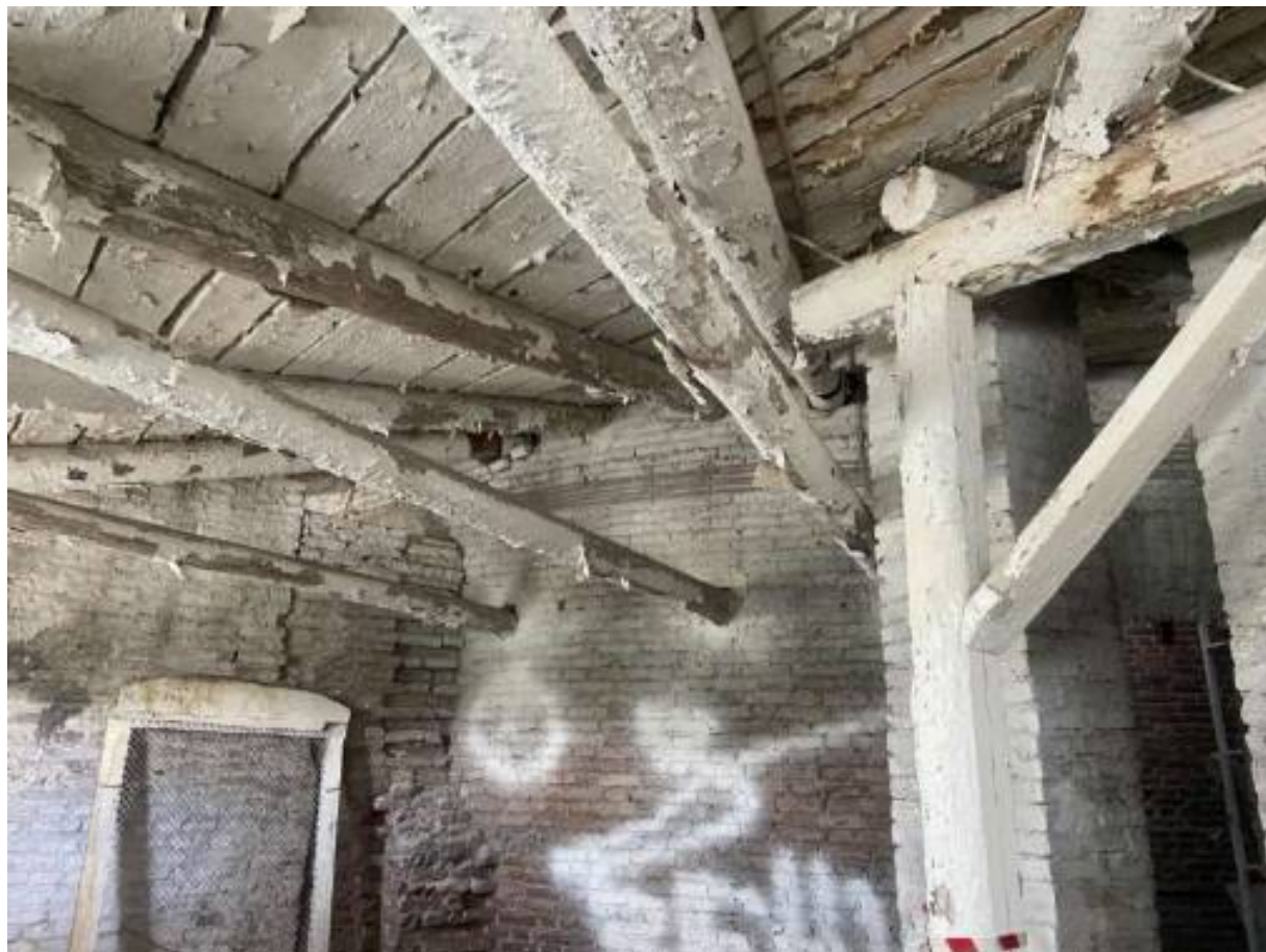
Фото 68. Чердачное пространство Центрального корпуса (лит. А4).
