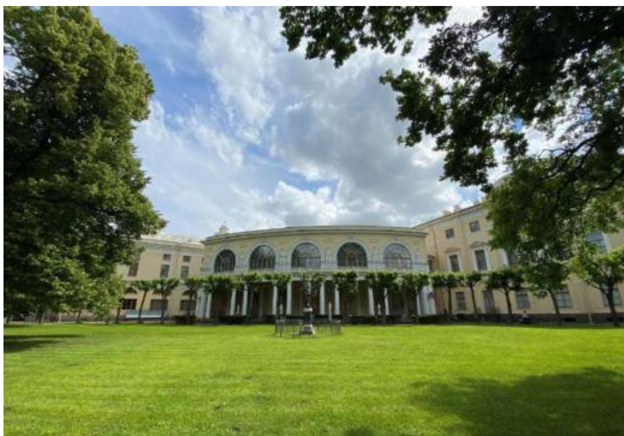
Фото 36. Вид на Северный полуциркульный корпус с колоннадой (лит. А5) со стороны парка.
