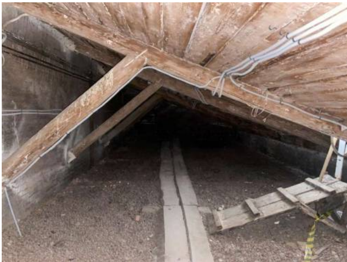
Фото 57. Чердачное пространство Церковного корпуса (лит. А2).
