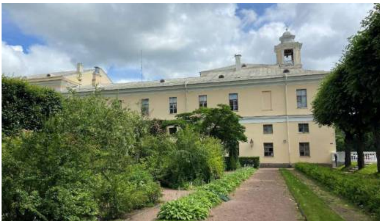
Фото 20. Вид на Церковный корпус (лит. А2) со стороны Собственного садика.
