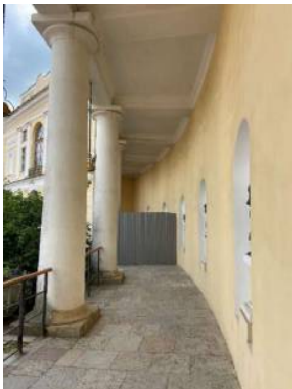
Фото 10. Вид на колоннаду Южного полуциркульного корпуса с колоннадой (лит. А3).
