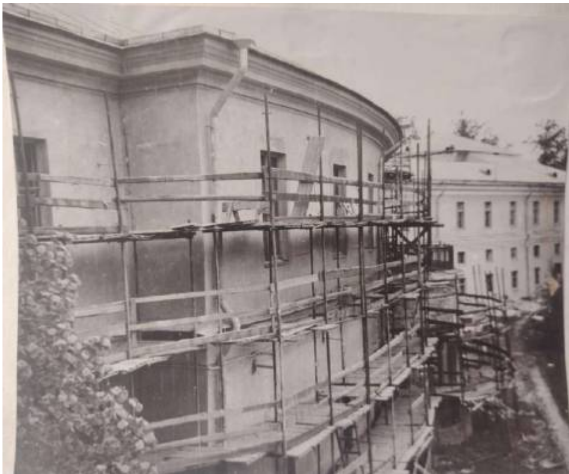
Илл. 88. Реставрация карниза полуциркульного корпуса со стороны Собственного сада. 1954 г. (источник: Научный архив ГМЗ «Павловск». Инв. № 27865. Нег.б-5406).
