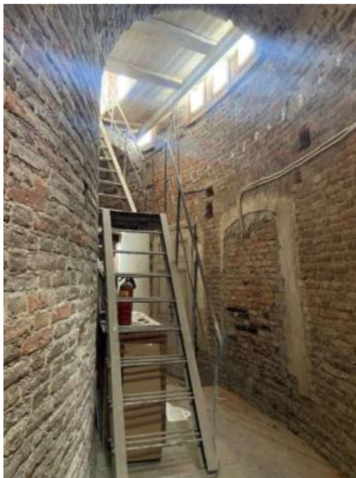
Фото 73. Чердачное пространство Центрального корпуса (лит. А4).
