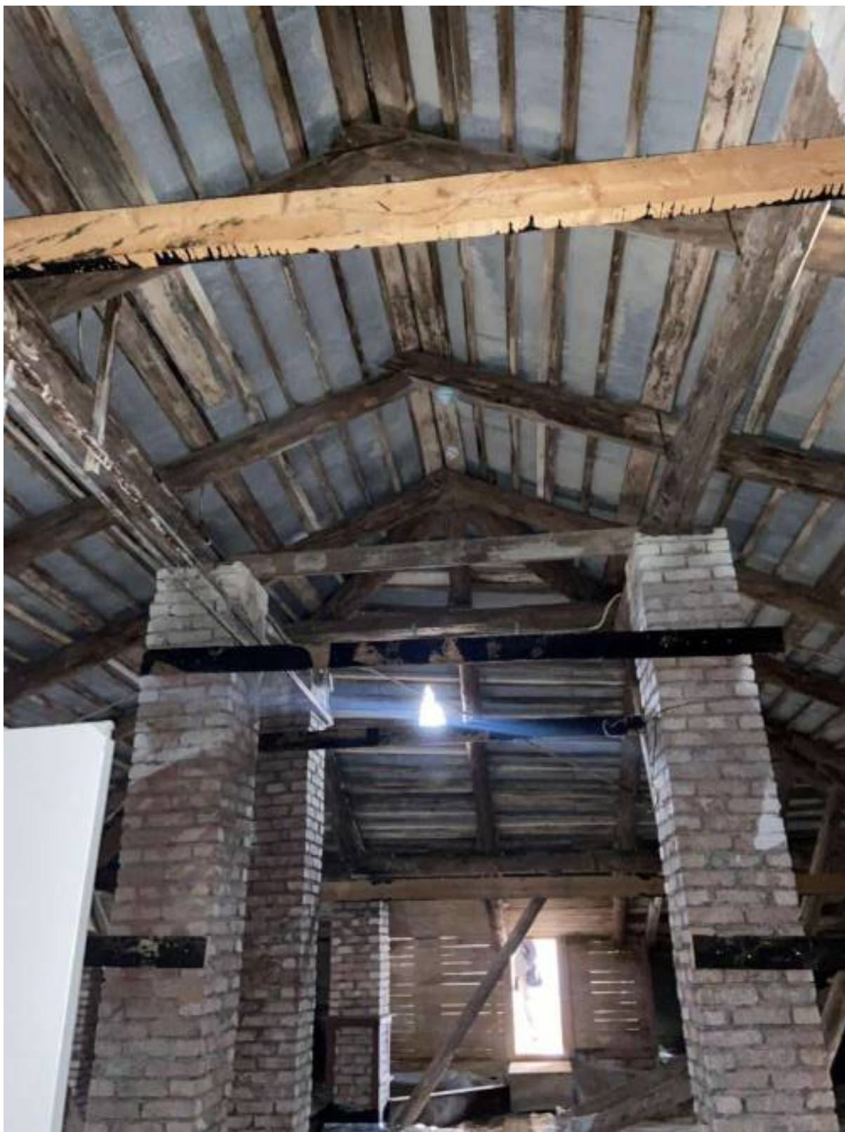
Фото 80. Чердачное пространство Северного прямоугольного корпуса (лит. А6).
