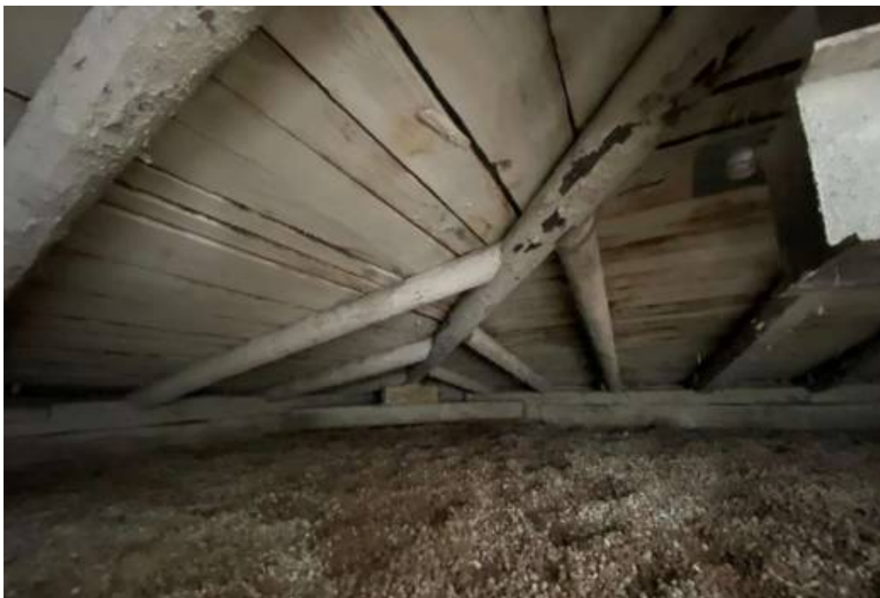
Фото 61. Чердачное пространство Центрального корпуса (лит. А4).
