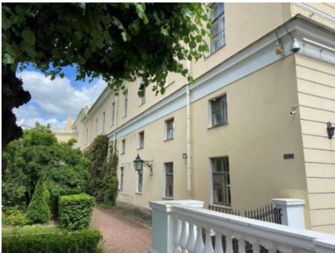
Фото 21. Вид на Церковный корпус и Южный прямоугольный корпус (лит. А2) со стороны Собственного садика.
