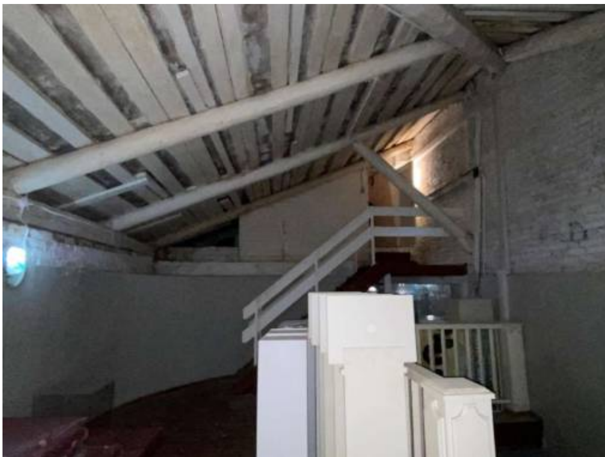
Фото 49. Чердачное пространство Церковного корпуса (лит. А2).
