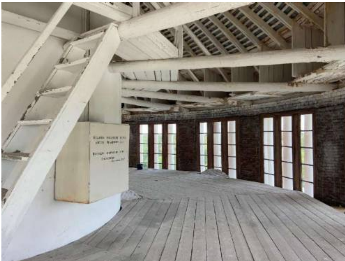
Фото 74. Чердачное пространство Центрального корпуса (лит. А4).
