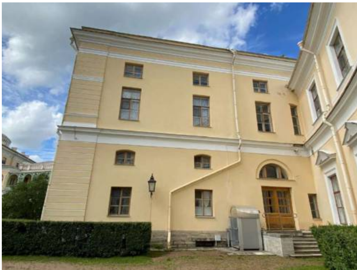
Фото 3. Вид на Северный прямоугольный корпус (лит. А6) со стороны парадного двора.
