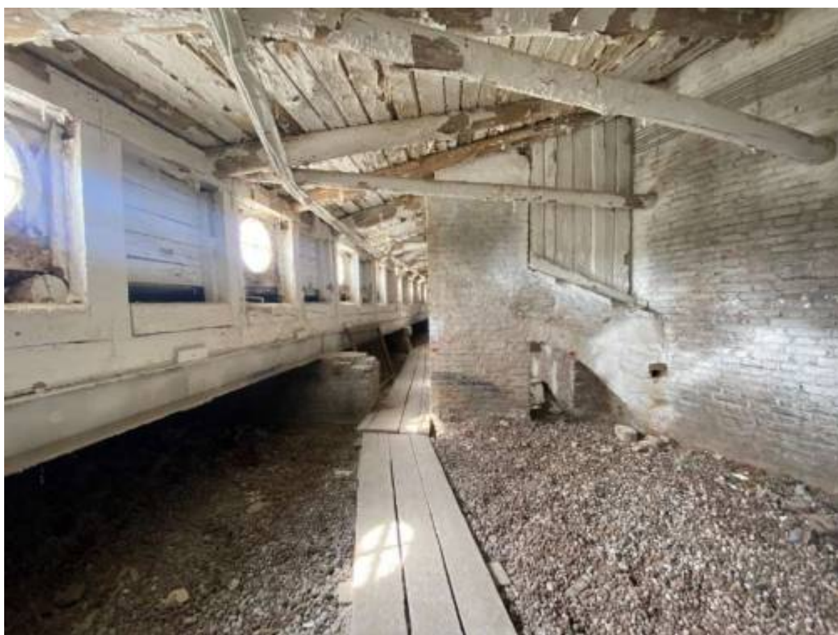
Фото 62. Чердачное пространство Центрального корпуса (лит. А4).
