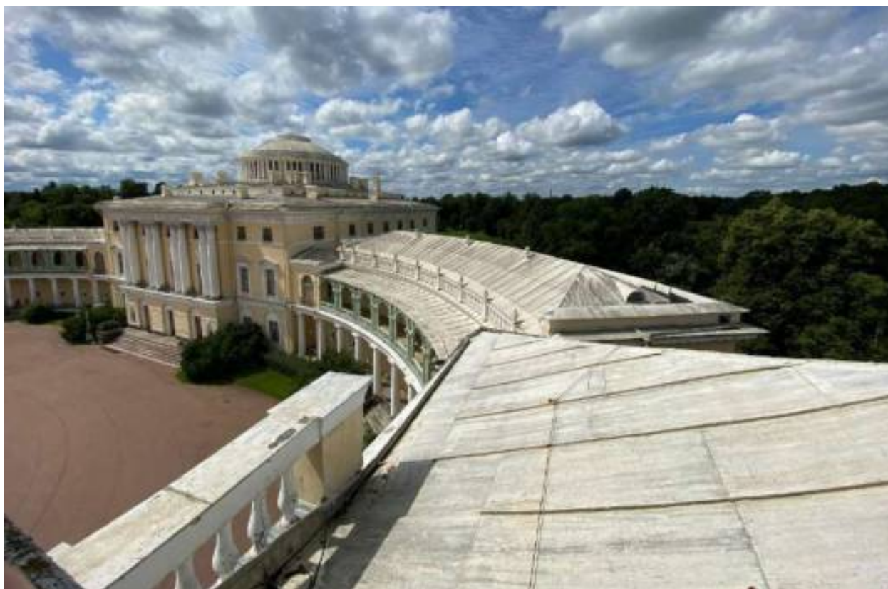
Фото 83. Вид на крышу здания.
