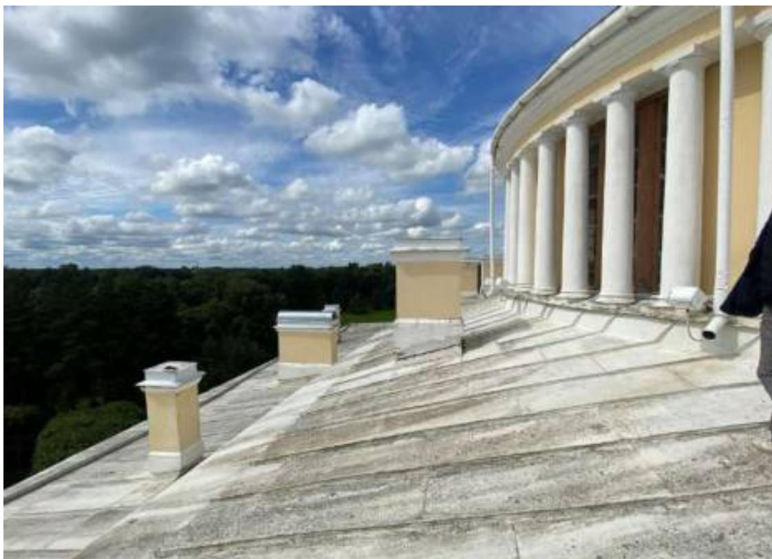
Фото 91. Вид на крышу Центрального корпуса (лит. А4).
