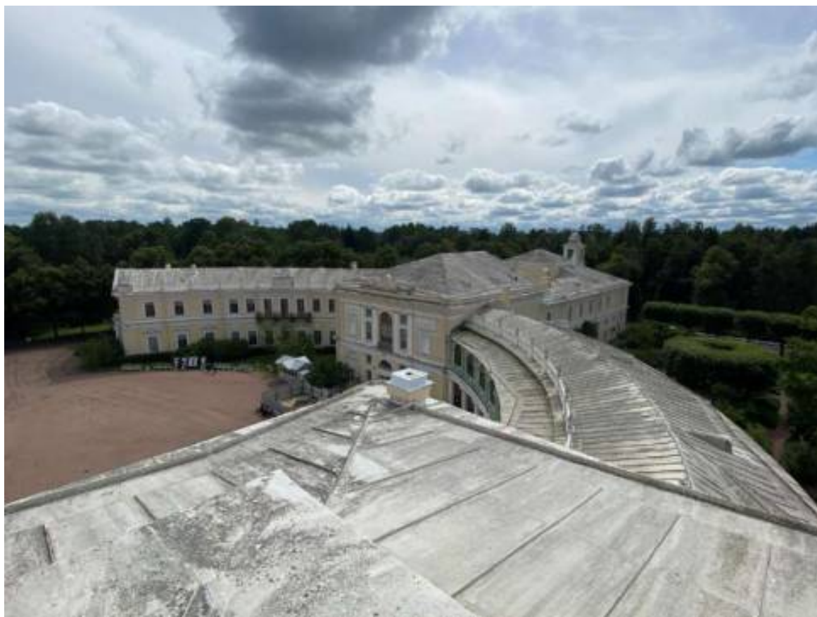
Фото 90. Вид на крышу южных корпусов.
