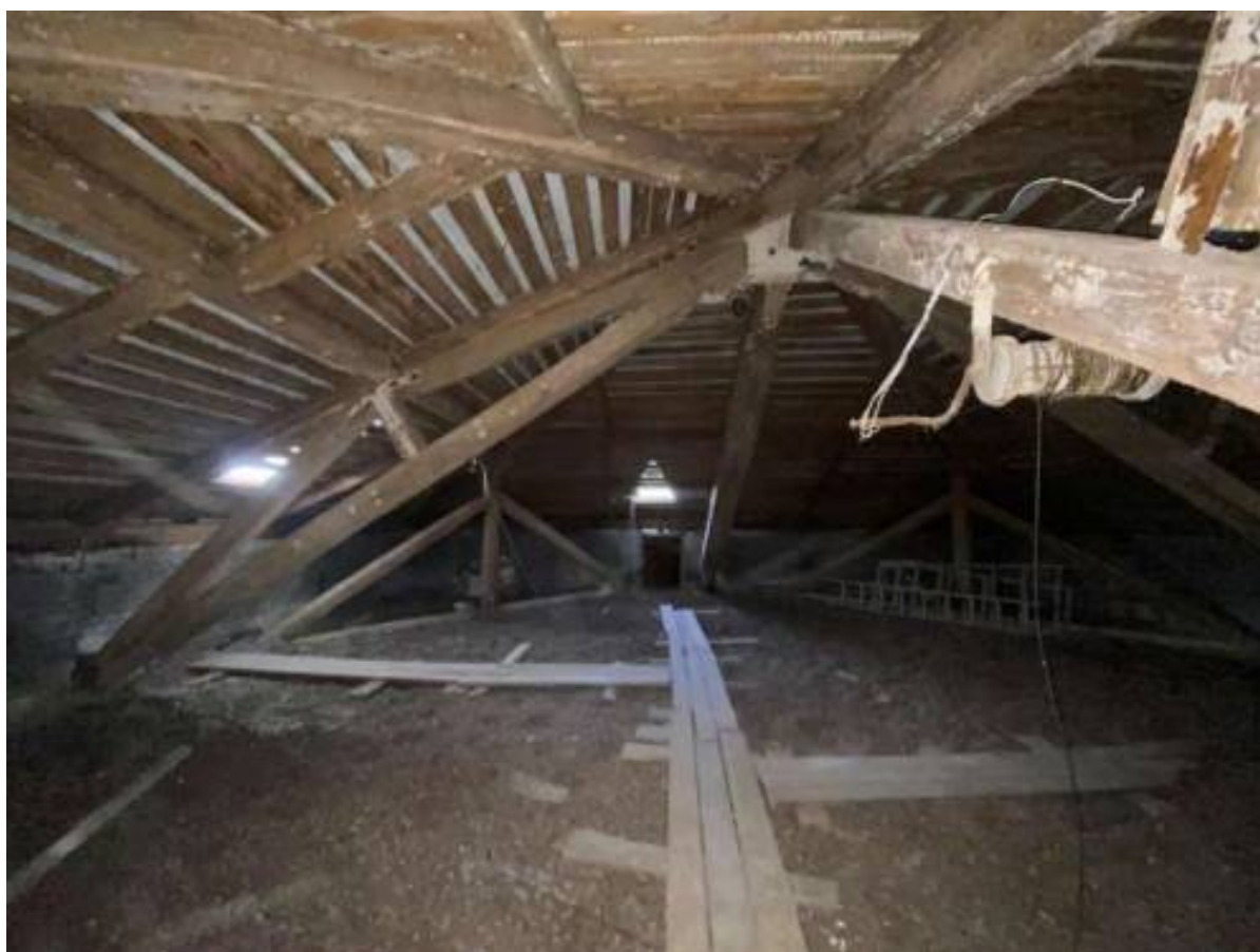
Фото 52. Чердачное пространство Церковного корпуса (лит. А2).
