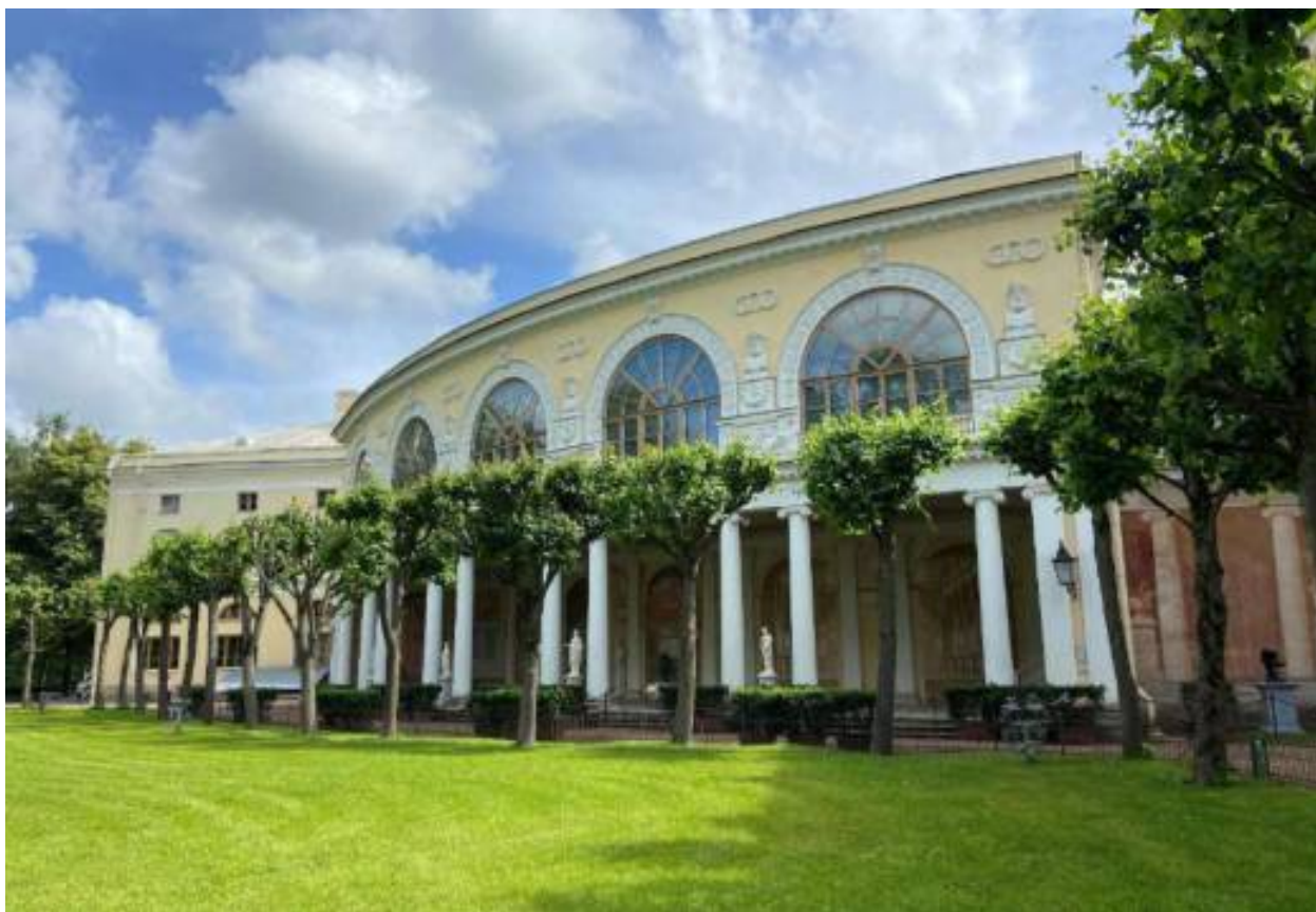
Фото 37. Вид на Северный полуциркульный корпус с колоннадой (лит. А5) со стороны парка.
