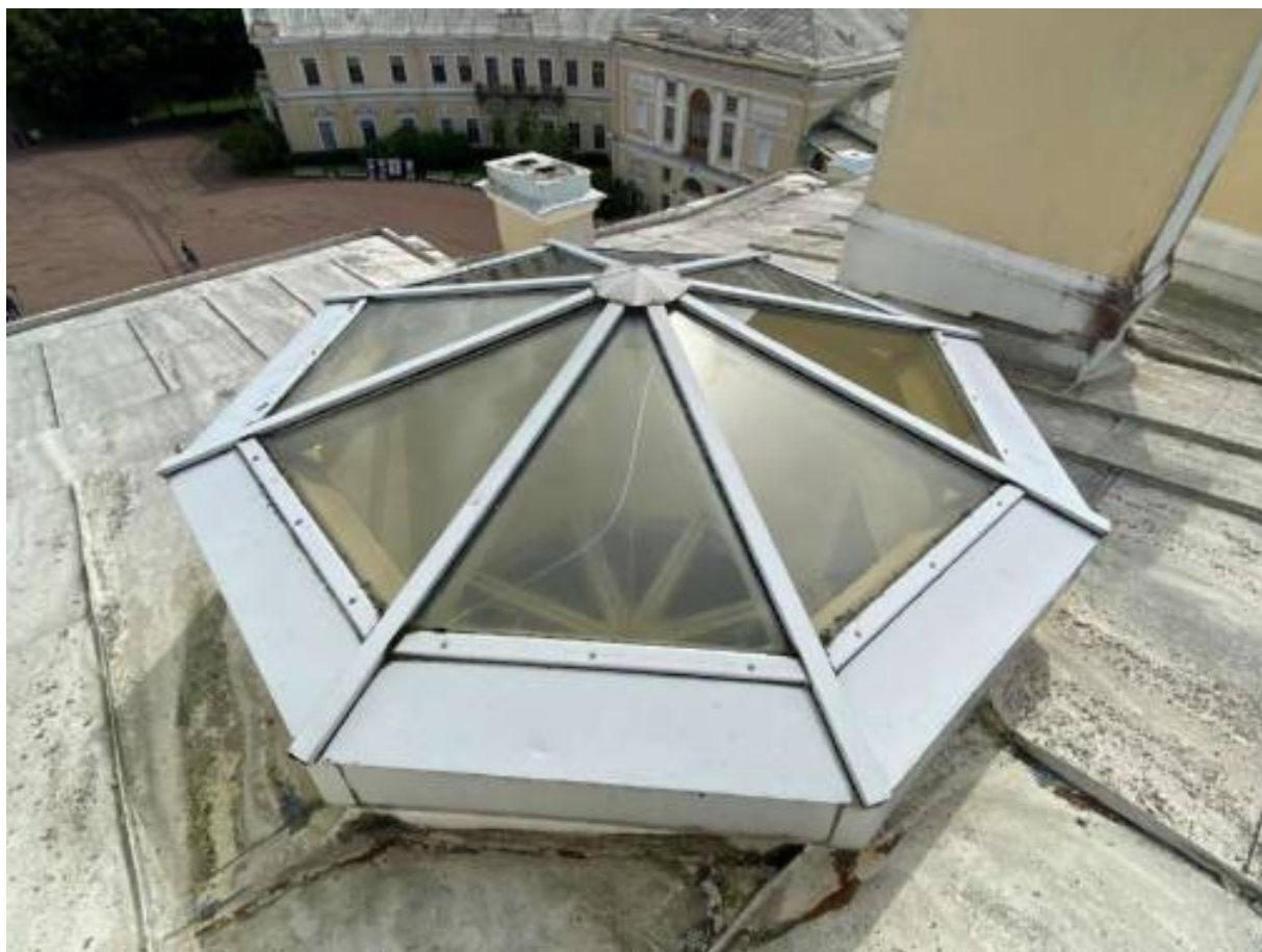
Фото 89. Вид на фонарь в крыше Центрального корпуса (лит. А4).
