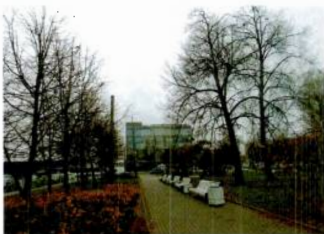
7. Южная часть объекта культурного наследия.
