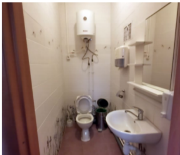
Фото 41. Пом. 24. Санузел. Общий вид.
