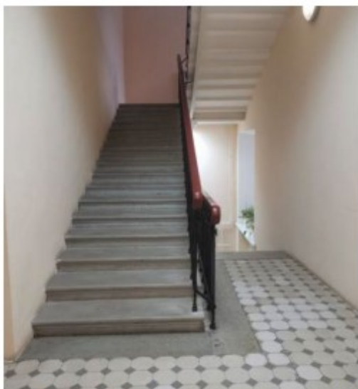
Фото 1. Пом. 7.9. Общий вид лестницы ЛК-7.
