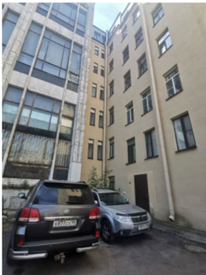
Фото 3. Фрагмент юго-восточного фасада здания.
