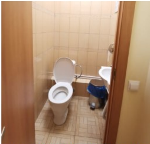
Фото 37. Пом. 16. Санузел. Общий вид.
