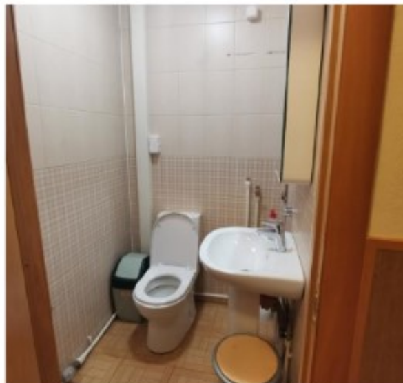
Фото 42. Пом. 19. Санузел. Общий вид.
