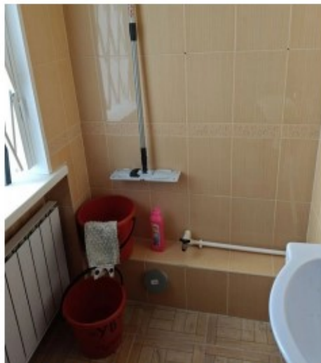
Фото 38. Пом. 14. Санузел. Общий вид.
