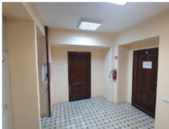
Фото 42. Пом. 6.8. Лестница ЛК-6. Общий вид лестничной площадки.
