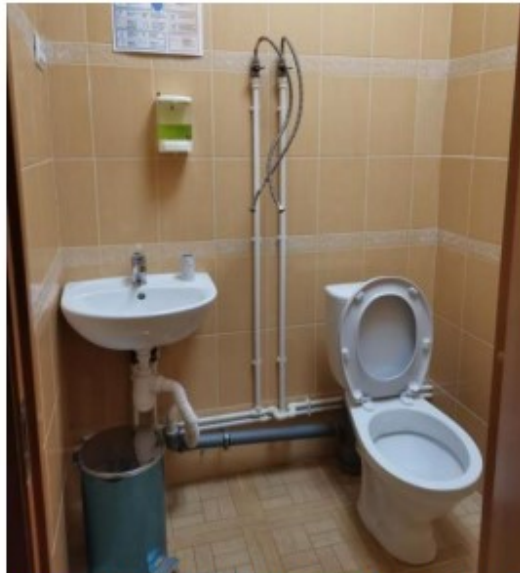
Фото 43. Пом.15. Санузел. Общий вид.
