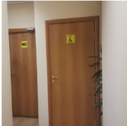
Фото 52. Пом. 23. Коридор. Общий вид в сторону санузлов.
