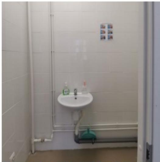
Фото 13. Пом. 3. Умывальня. Общий вид.
