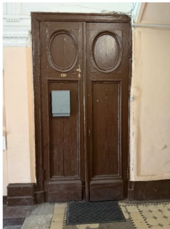
Входное дверное заполнение квартиры № 27 (1этаж) Выявленного объекта культурного наследия
