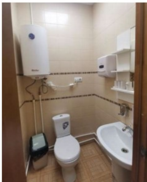
Фото 30. Пом. 11. Санузел. Общий вид.
