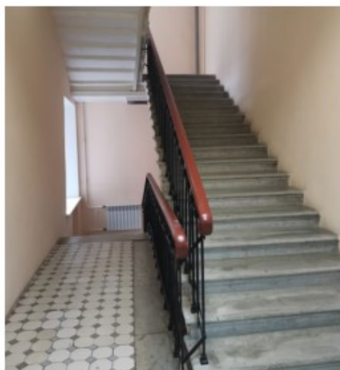
Фото 32. Пом.6.4. Общий вид лестничной площадки ЛК-6.
