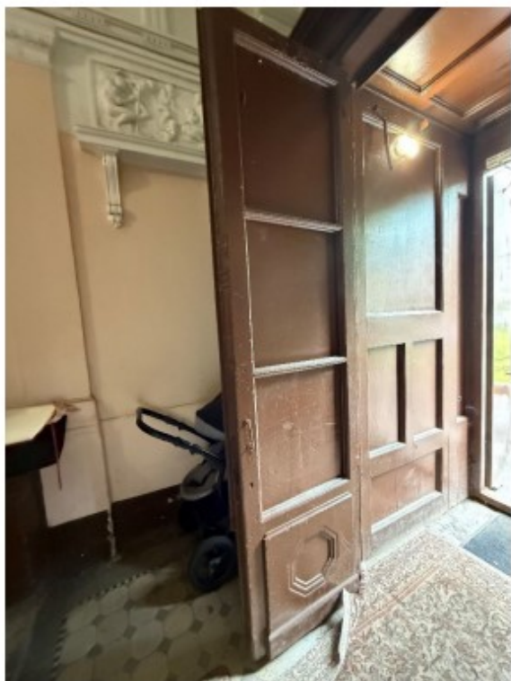
Фото 26. Внутреннее дверное заполнение тамбура парадной лестничной клетки Л12 Выявленного объекта культурного наследия
