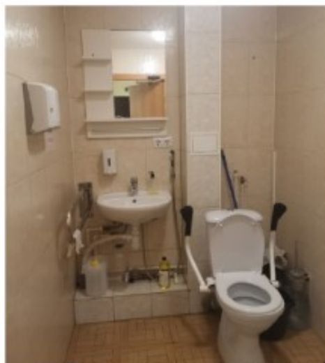
Фото 54. Пом. 26. Санузел. Общий вид.
