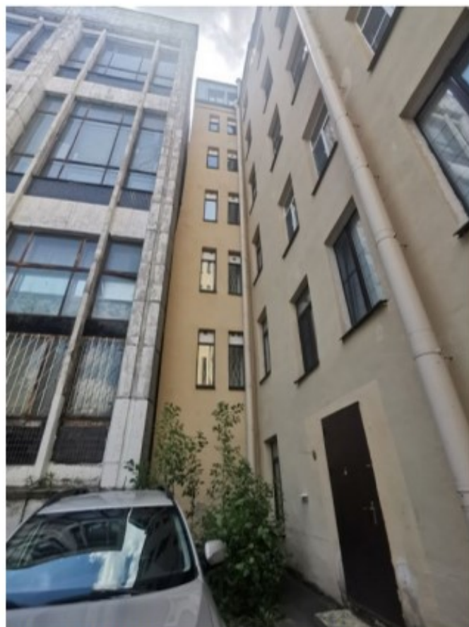
Фото 2. Фрагмент юго-восточного фасада здания.
