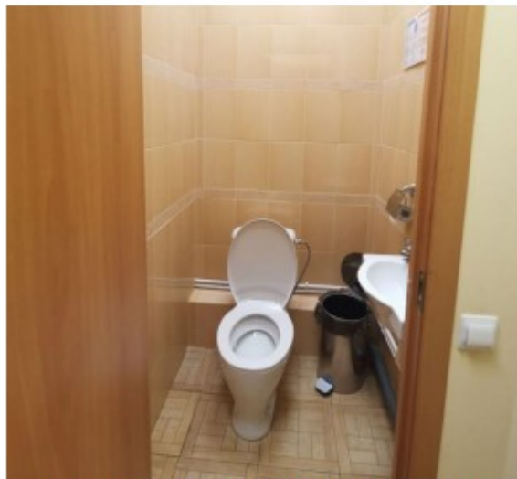
Фото 32. Пом. 18. Санузел. Общий вид.
