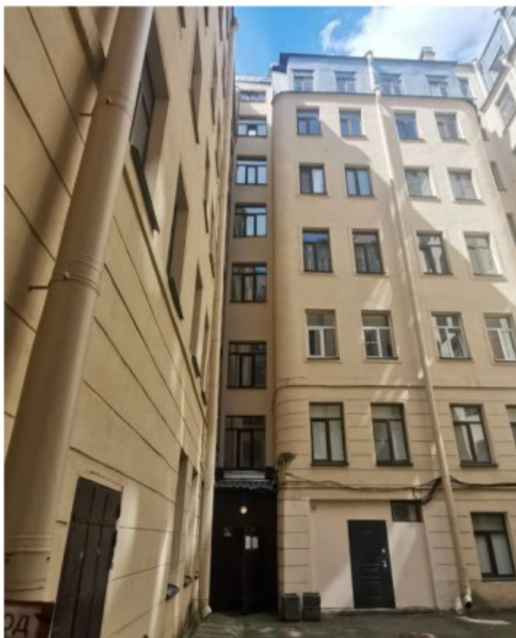
Фото 7. Фрагмент северо-восточного фасада здания во внутреннем дворе.
