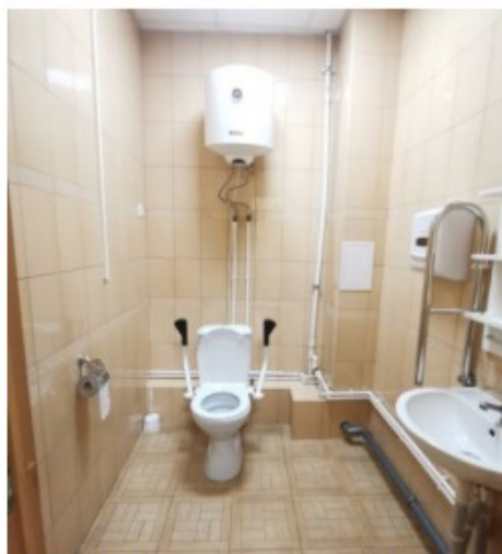
Фото 39. Пом. 17. Санузел для МГН. Общий вид.
