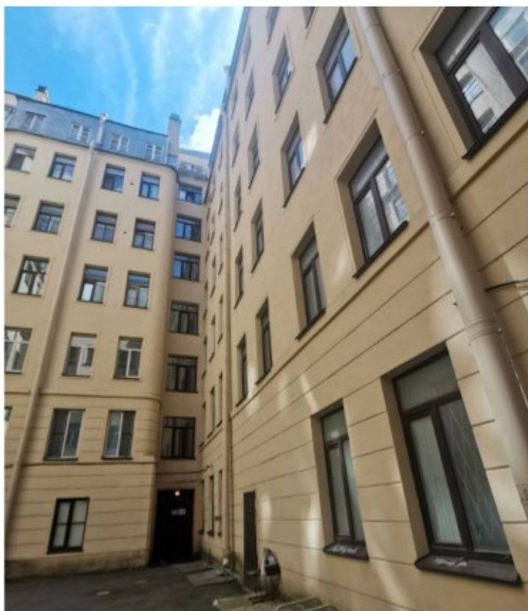
Фото 5. Фрагмент северо-восточного фасада здания во внутреннем дворе.
