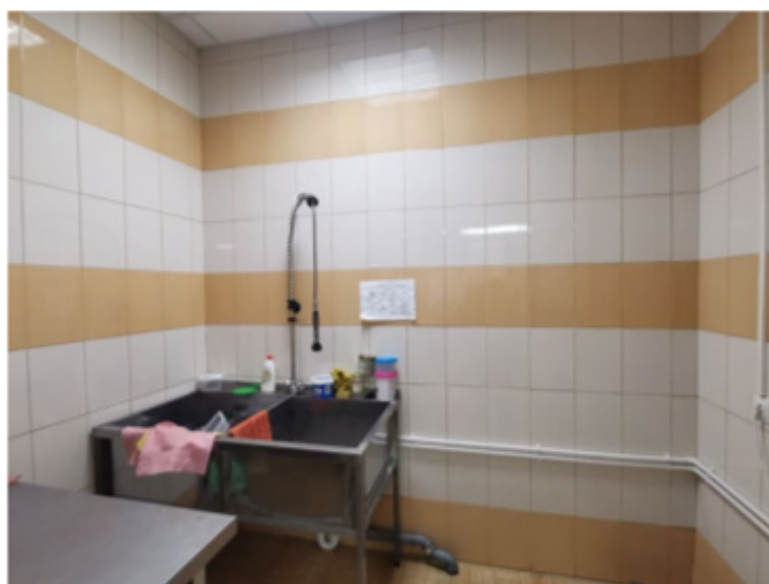
Фото 21. Пом. 13. Класс производственного обучения. Общий вид.
