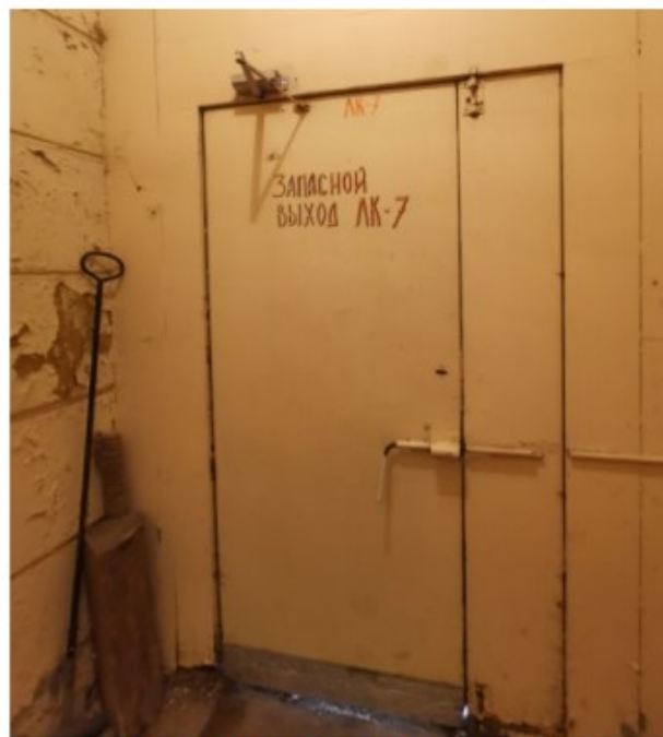
Фото 62. Выход с лестницы ЛК-7 во внутренний двор.
