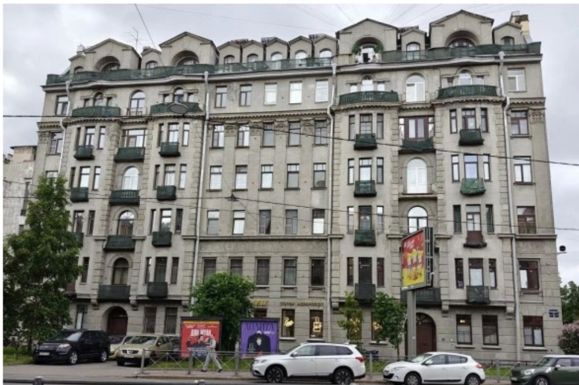
Фото 22. Главный фасад выявленного объекта культурного наследия «Дом Ф.П. Петрова (Д.Г. Лурье)».
