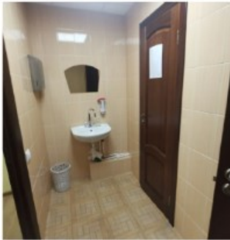
Фото 31. Пом. 13. Тамбур санузла.
