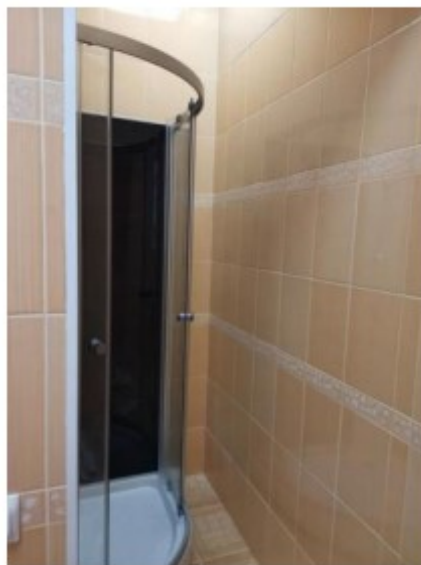
Фото 42. Пом.17. Душевая. Общий вид.
