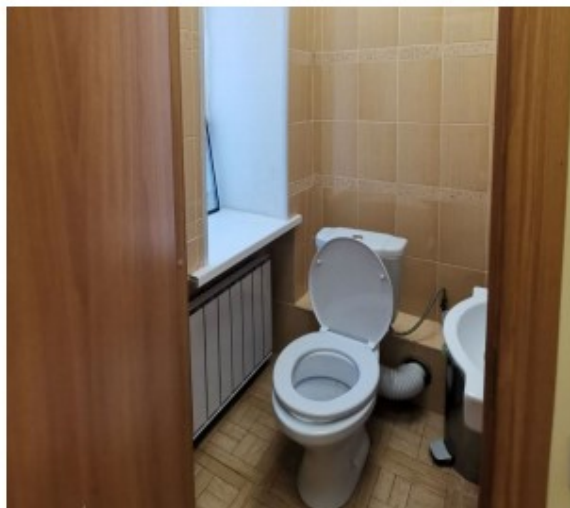
Фото 34. Пом. 16. Санузел. Общий вид.
