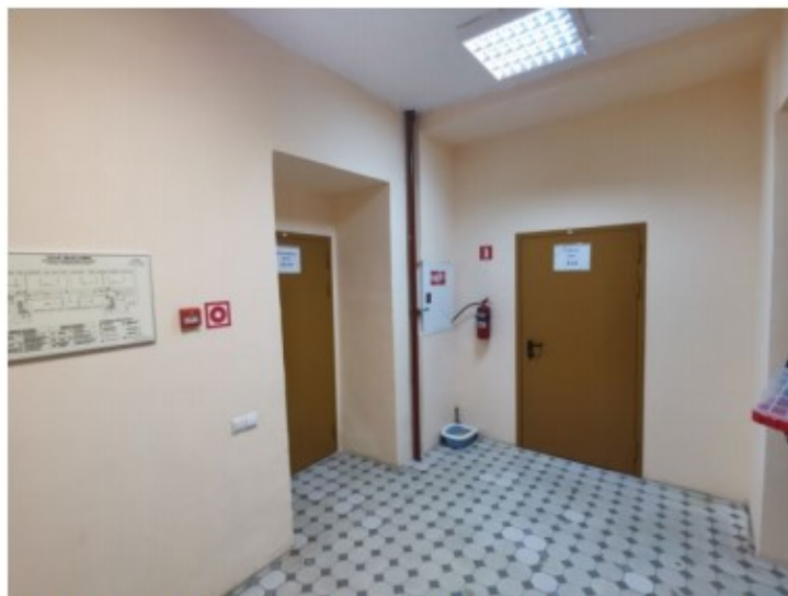
Фото 4. Пом. 7.7. Общий вид площадки лестницы ЛК-7.
