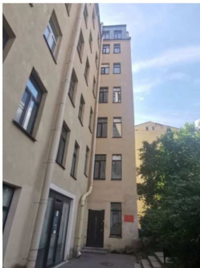
Фото 12. Фрагмент северо-восточного фасада здания.
