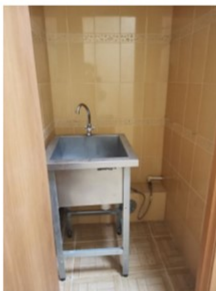
Фото 12. Пом. 6. Санузел. Общий вид.
