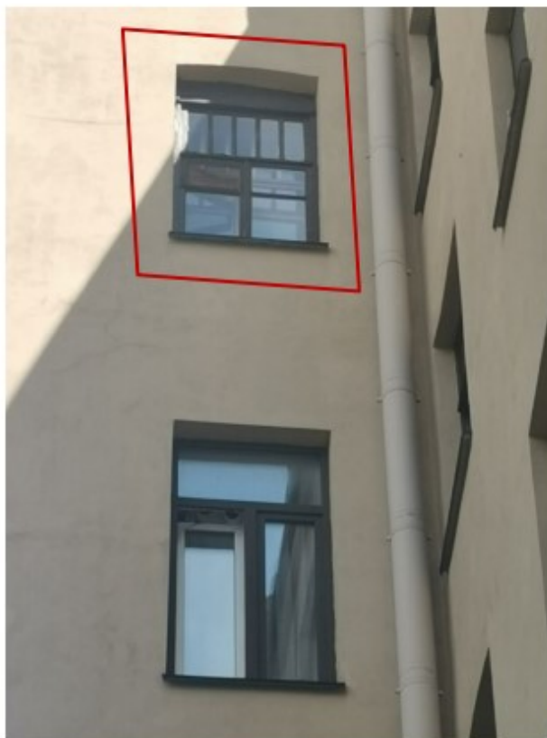
Фото 25. Сохранившийся деревянное оконное заполнение северо-западного фасада. — - деревянное оконное заполнение.
