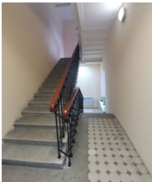
Фото 1. Пом. 7.10. Лестничная клетка ЛК-7. Общий вид.
