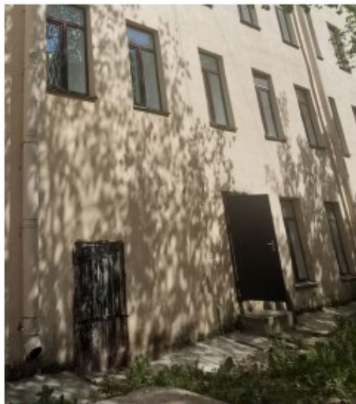
Фото 19. Юго-западный фасад здания. Фрагмент. Вход в здание.
