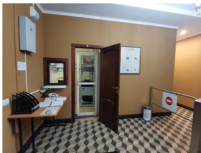
Фото 48. Пом. 28. Вестибюль. Общий вид.
