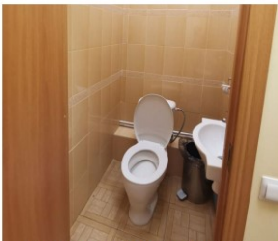
Фото 33. Пом. 17. Санузел. Общий вид.
