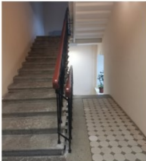
Фото 2. Пом. 7.11. Общий вид лестницы ЛК-7.
