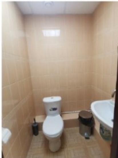
Фото 51. Пом. 23. Санузел. Общий вид.
