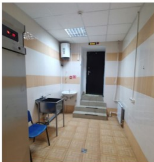
Фото 29. Пом. 15. Тамбур. Общий вид. Выход.
