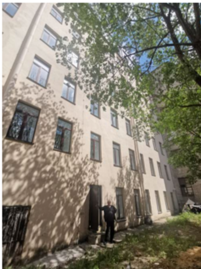
Фото 16. Юго-западный фасад здания. Фрагмент. Вид с запада.
