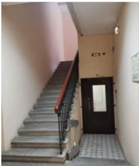
Фото 58. Пом. 7.4. Лестница ЛК-6. Общий вид.
