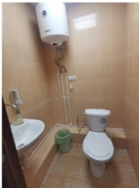
Фото 32. Пом. 14. Санузел. Общий вид.
