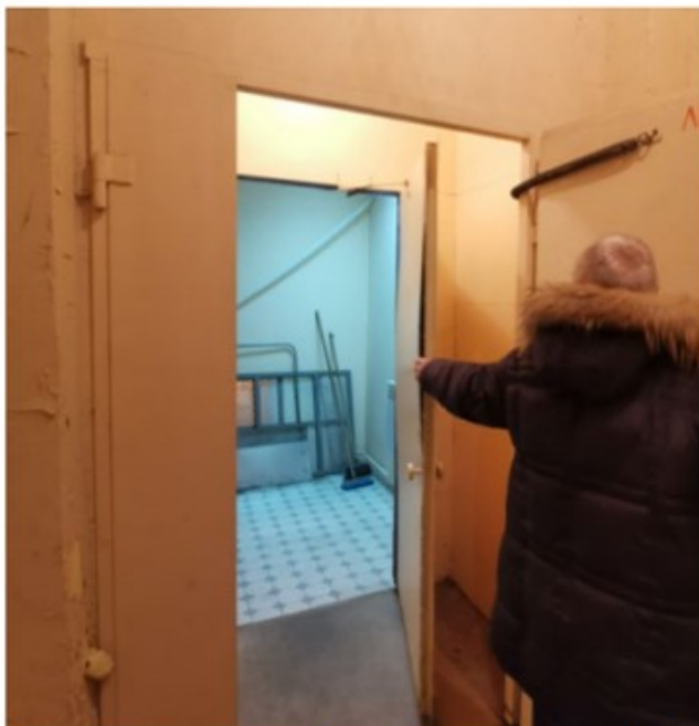
Фото 63. Пом. Пом. 7.2. Тамбур лестницы ЛК-7.
