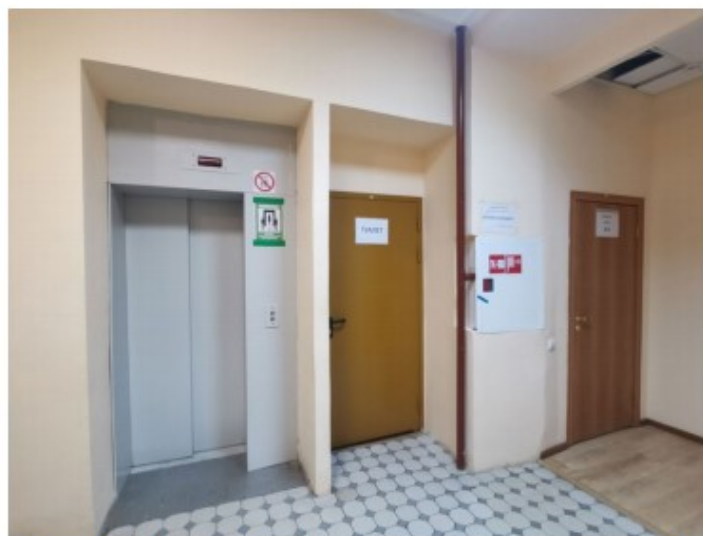
Фото 27. Пом. 6.6. Общий вид площадки лестницы ЛК-6.
