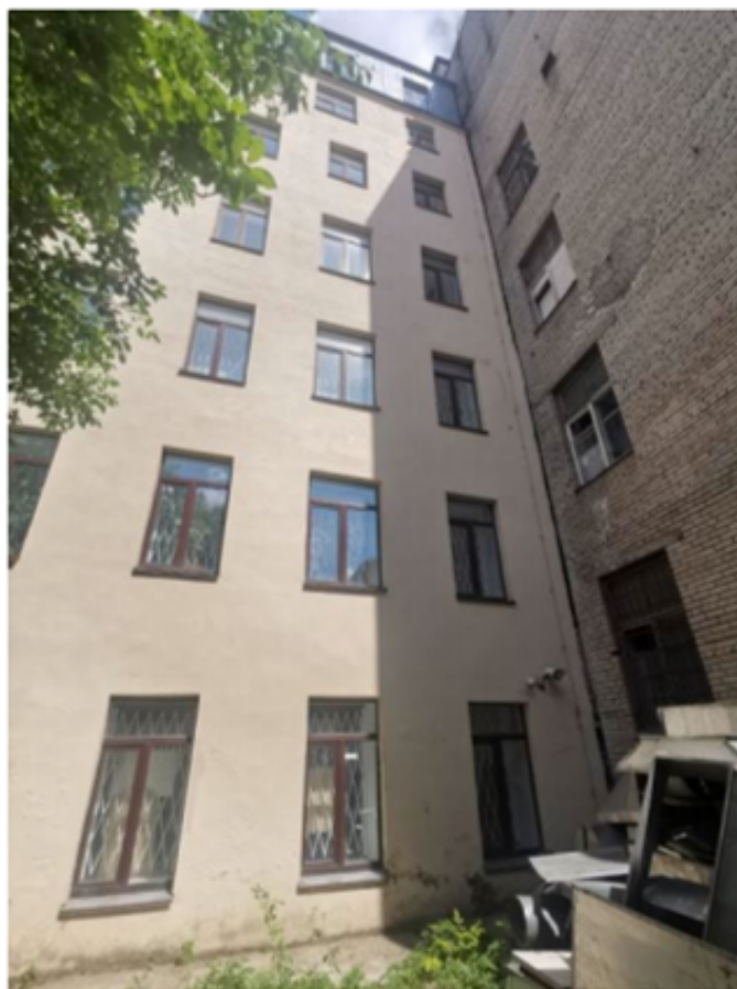
Фото 15. Фрагмент юго-западного фасада здания. Вид с юго-запада.
