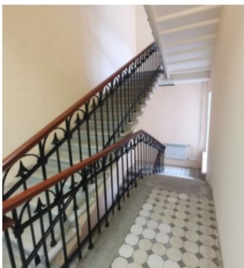
Фото 2. Пом. 7.7. Общий вид лестницы ЛК-7.
