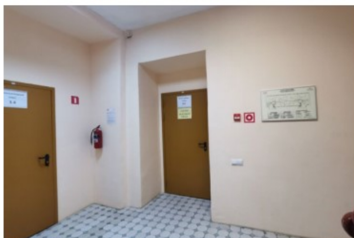
Фото 32.2. Пом. 6.5. Общий вид площадки лестницы ЛК-6.
