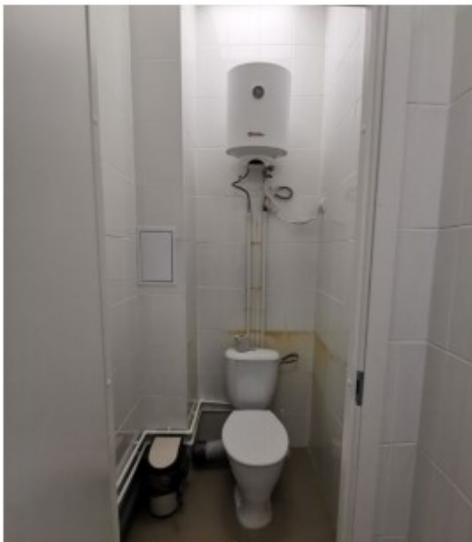
Фото 14. Пом. 4. Санузел. Общий вид.
