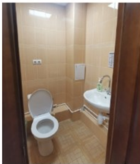
Фото 33. Пом. 15. Санузел. Общий вид.
