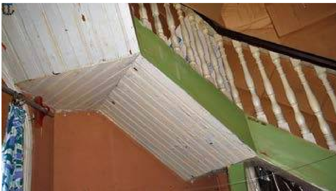
54. Лестница, ведущая из углового помещения 2-го этажа в башню. 2017 г. - http://www.citywalls.ru
