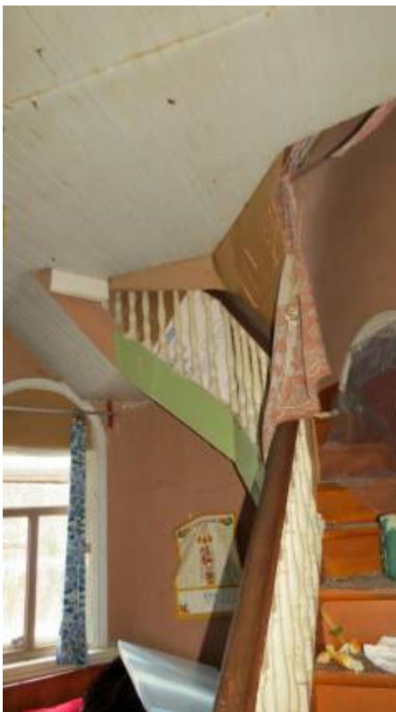
53. Лестница, ведущая из углового помещения 2-го этажа в башню. 2017 г. - http://www.citywalls.ru
