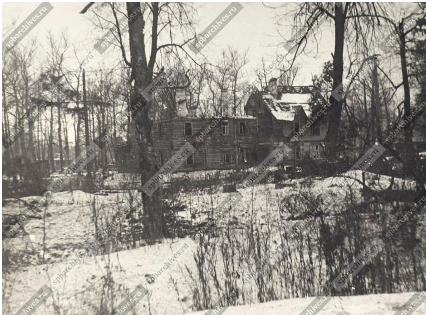
20. Вид разрушенных немцами жилых домов на Слуцком шоссе. Фотография. Автор фото неизвестен. 1941-1944 гг. // Источник: ЦГАКФФД СПб. Фотоальбом Пр 1048. Позитив сн.8.
