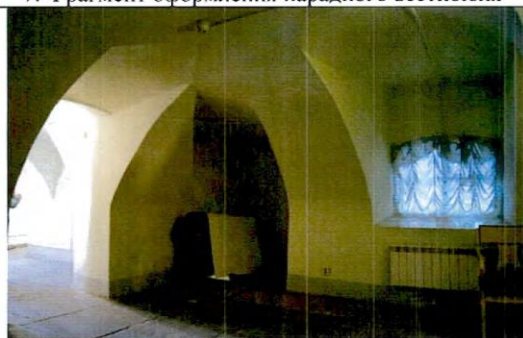
9. Фрагмент интерьера в уровне 1-го этажа
