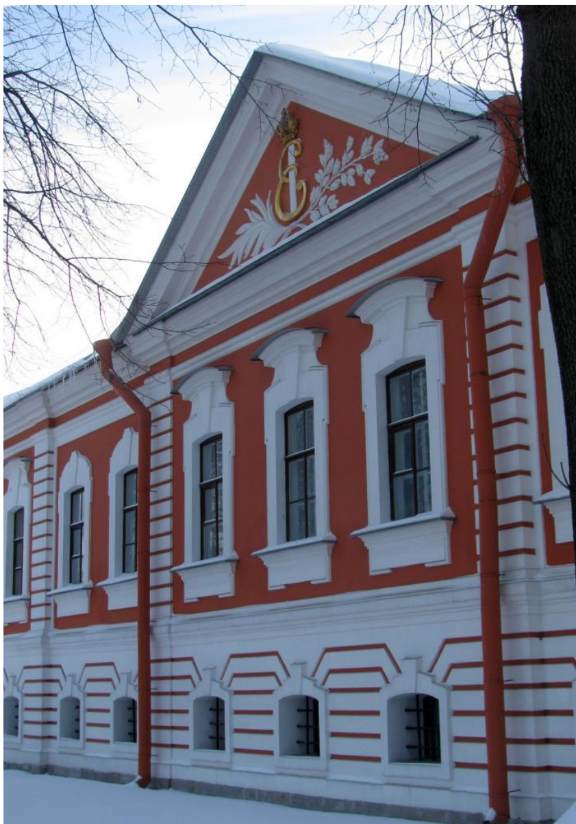
33. Петропавловская крепость. Дом комендантский. Фотография. Февраль 2021 г. Приведено на: https://www.citywalls.ru/ .
