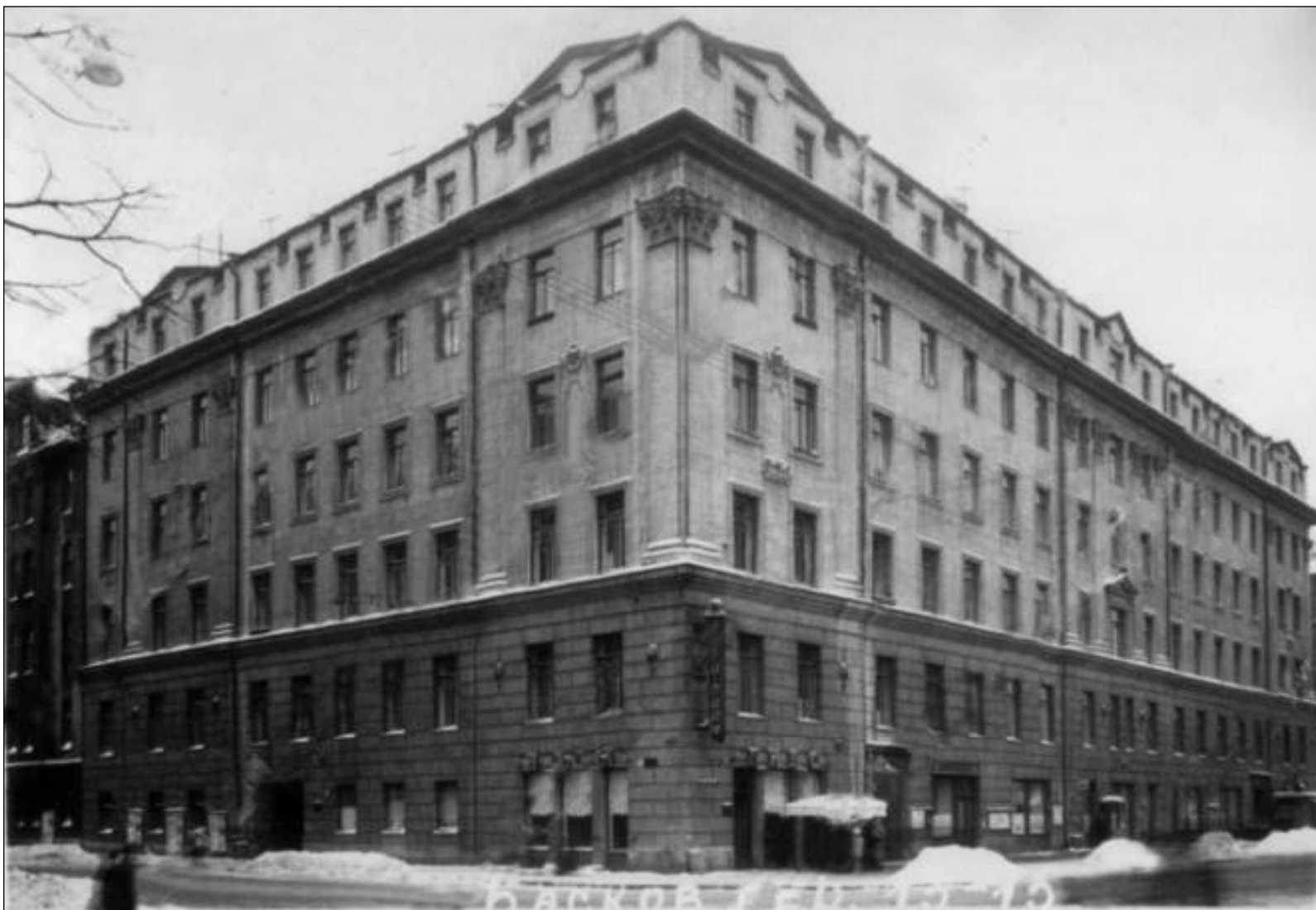
Илл. 26. Фасад углового дома № 13 – 15 в Басковом переулке. Фотография. 1960 г. Автор съемки: неизвестен. ЦГАКФФД СПб. Шифр: Гр 74965.
