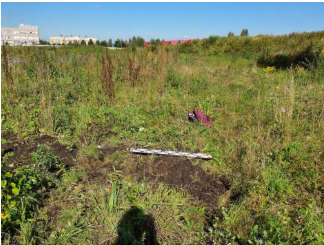
Рис. 98. Санкт-Петербург, Шушары-2026. Шурф 11. Восстановление поверхности. Вид с юга
