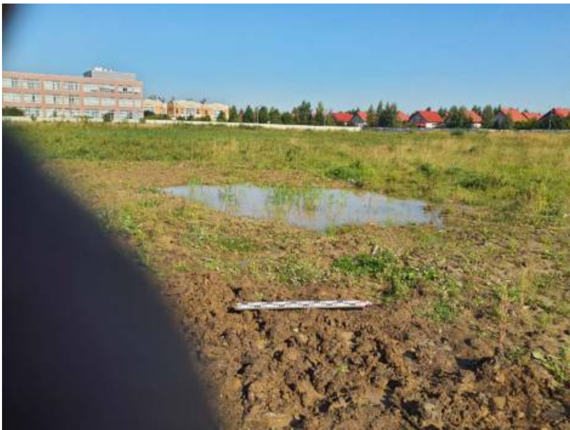
Рис. 93. Санкт-Петербург, Шушары-2026. Шурф 10. Восстановление поверхности. Вид с юга
