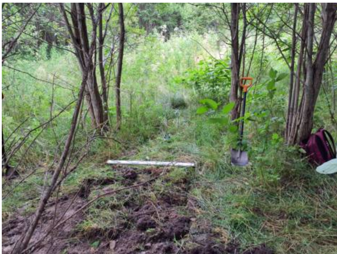
Рис. 54. Санкт-Петербург, Шушары-2026. Шурф 4. Восстановление поверхности. Вид с юга
