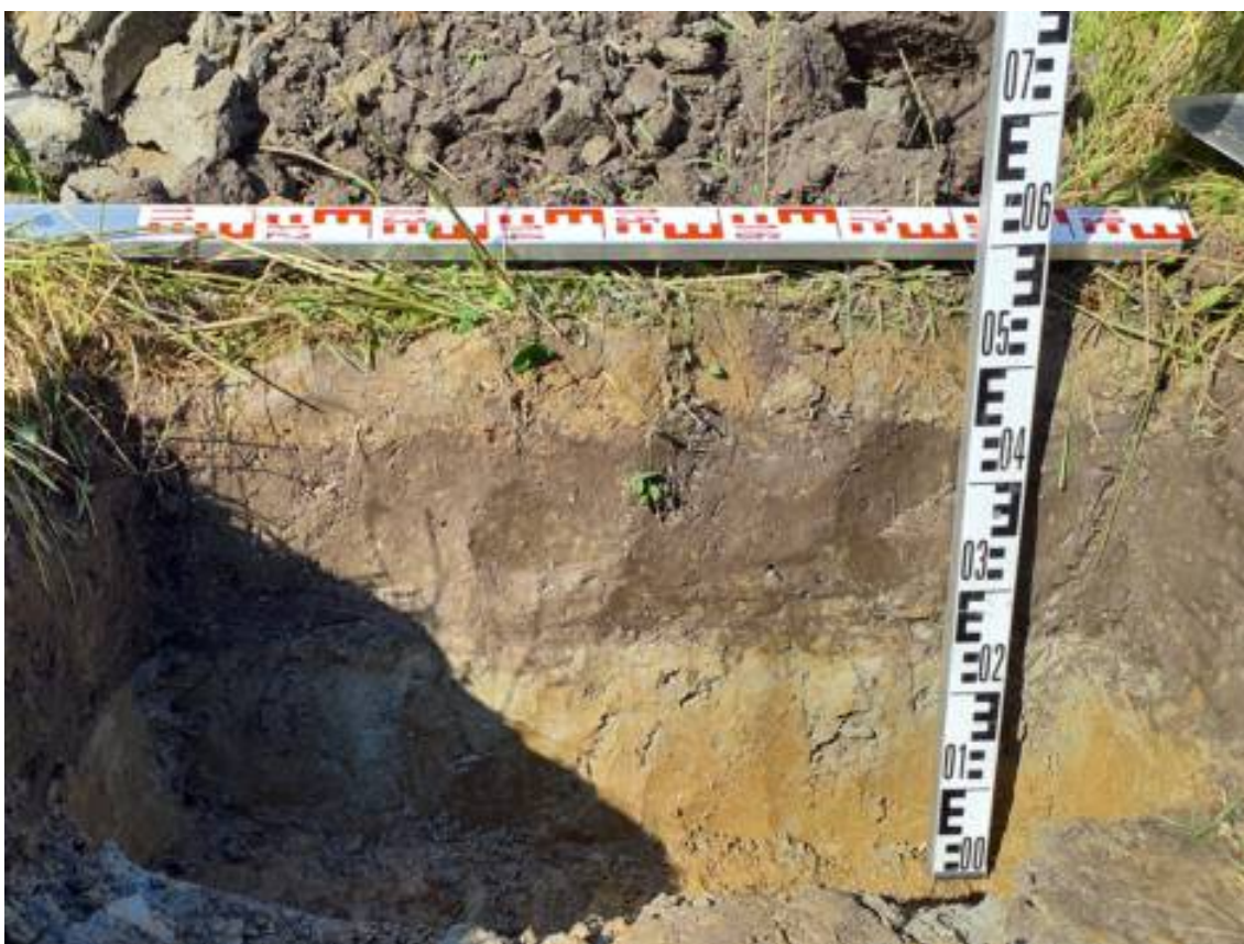
Рис. 38. Санкт-Петербург, Шушары-2026. Шурф 1. Северная стенка. Вид с юга
