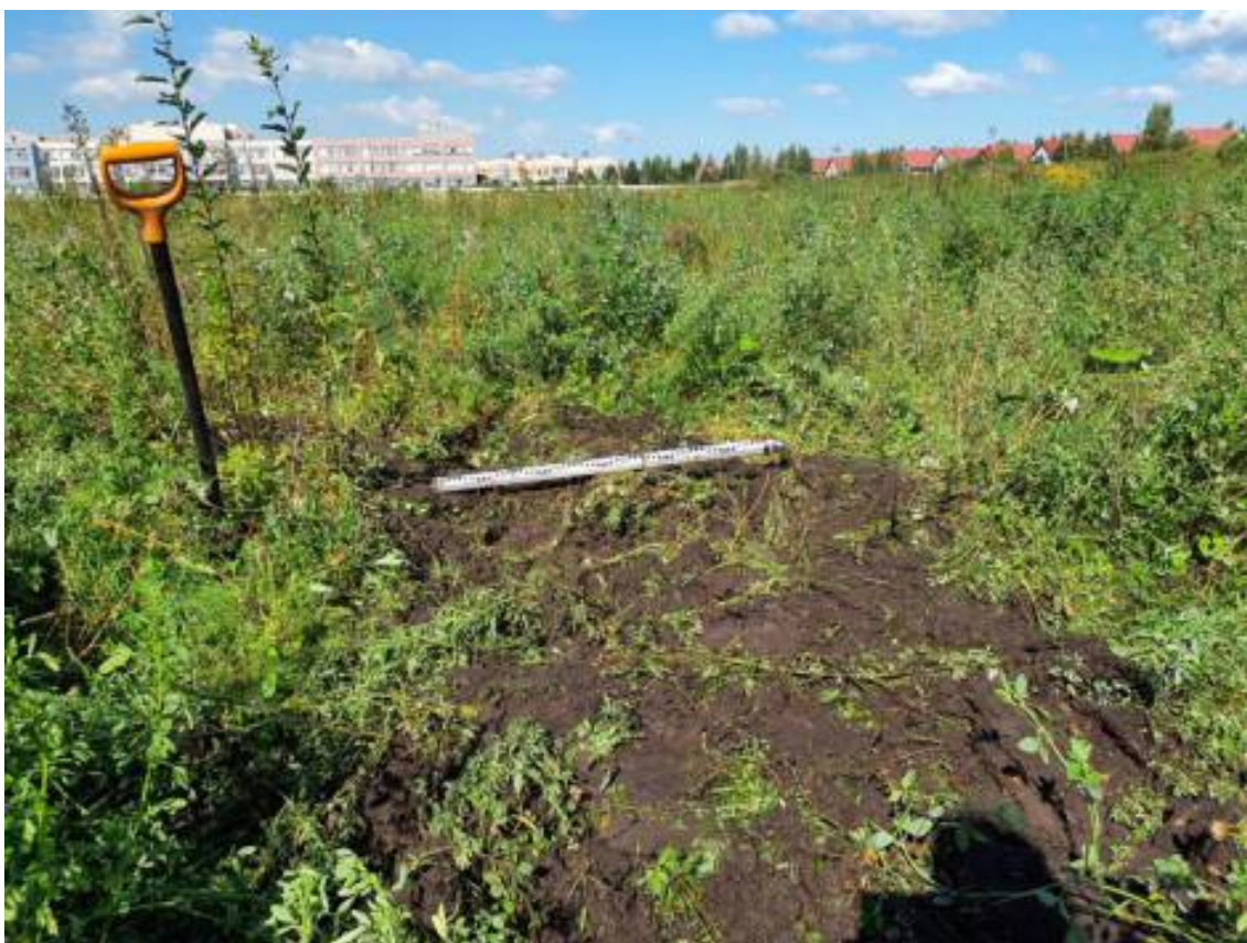
Рис. 103. Санкт-Петербург, Шушары-2026. Шурф 12. Восстановление поверхности. Вид с юга
