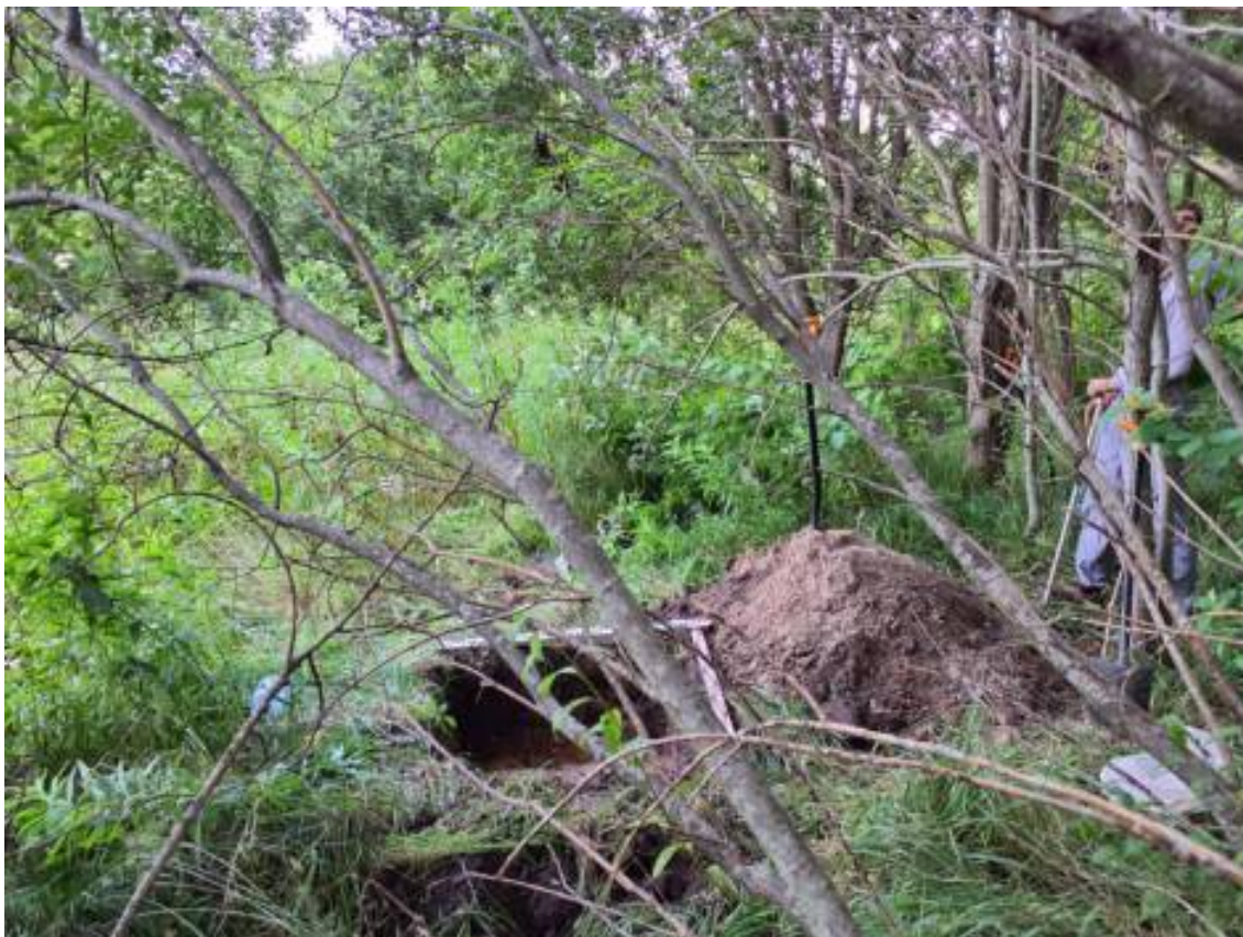
Рис. 57. Санкт-Петербург, Шушары-2026. Шурф 5 после зачистки по матерiku. Вид с юга.
