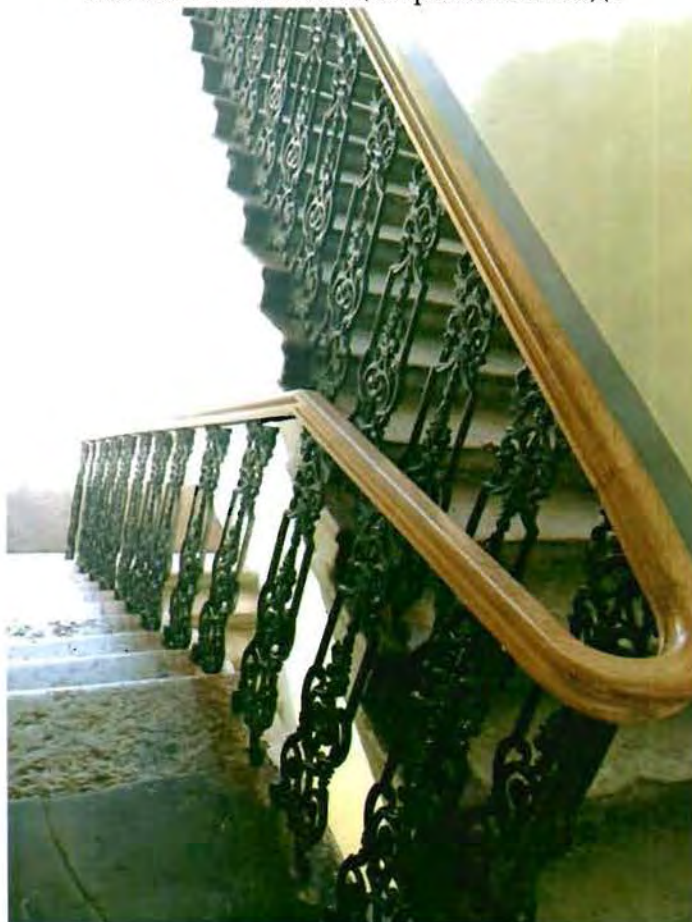
Фото 6. Лестница в южной части здания.
