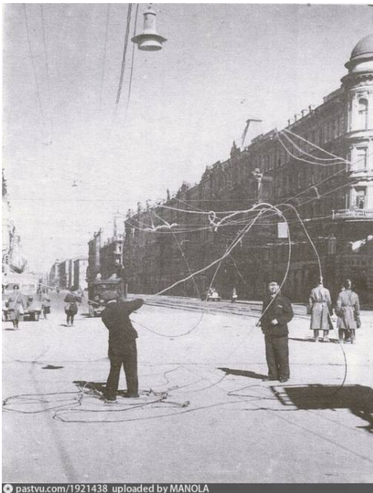
1. Ремонт контактной сети на проспекте 25 Октября. Фотография. Автор фото – Б. Лосин. 1943 г. // Источник: https://pastvu.com/p/1921438 .
