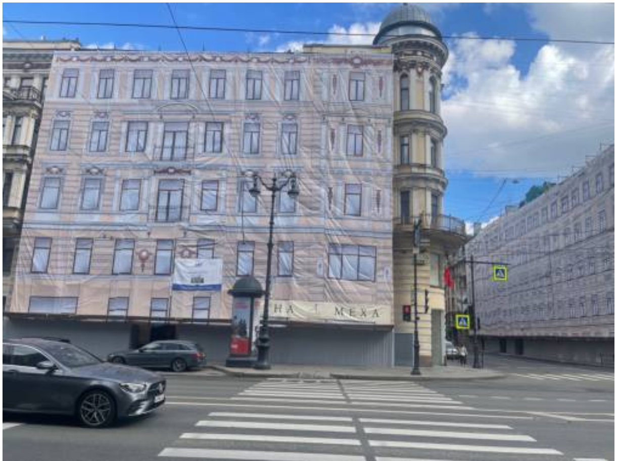
1. Общий вид фасада со стороны Невского проспекта.
