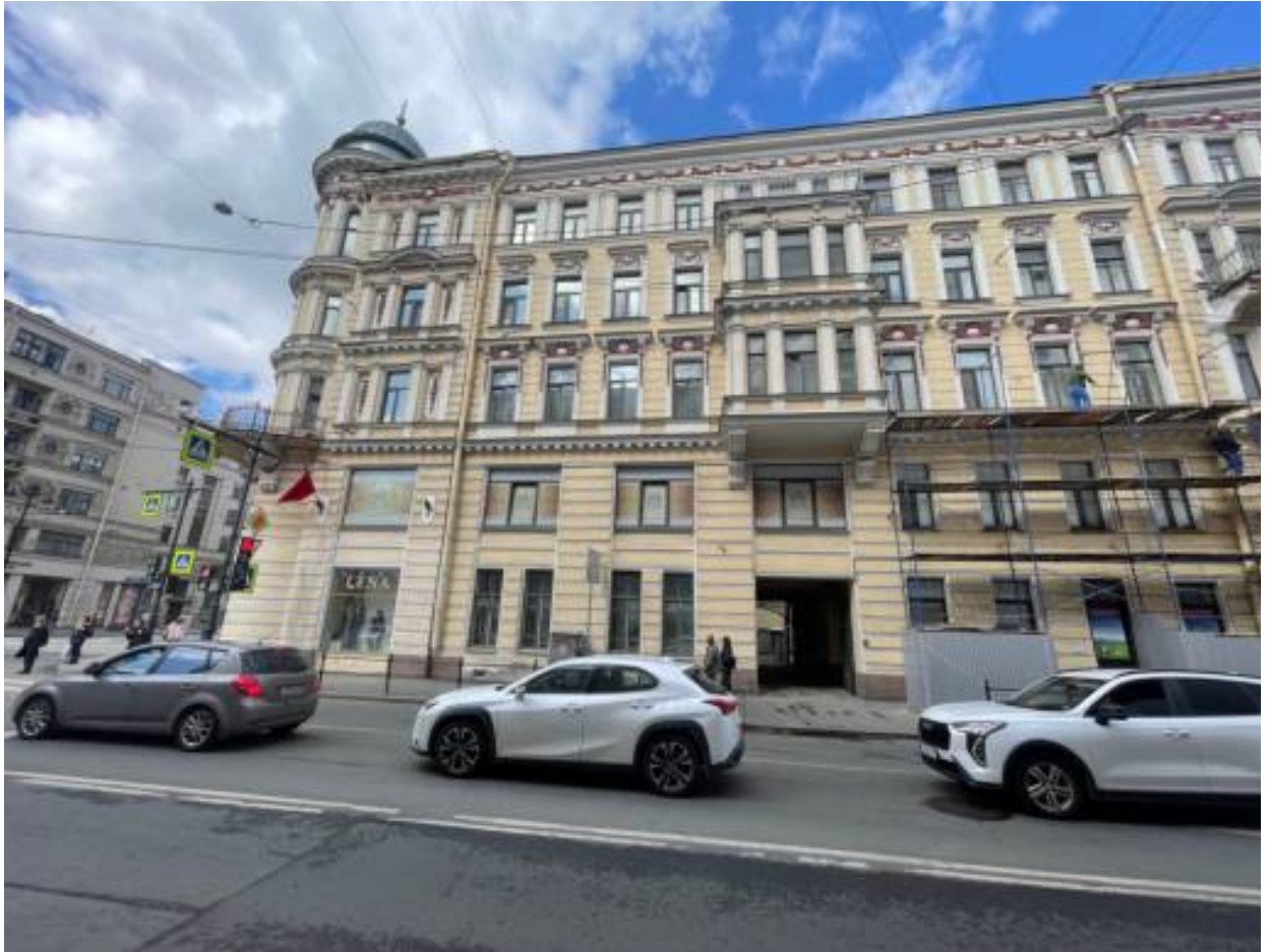
2. Общий вид фасада со стороны Исполкомского переулка.
