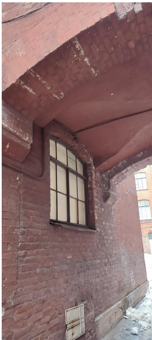
19. Оконный проём в переходе между корпусами.
