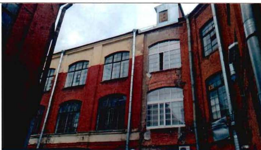
4. Фрагмент дворового фасада
