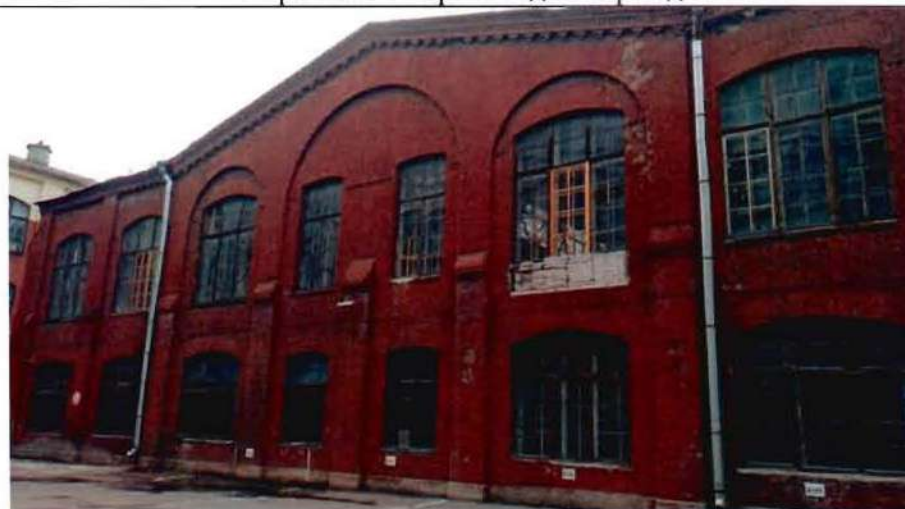
3. Фрагмент юго-западного фасада
