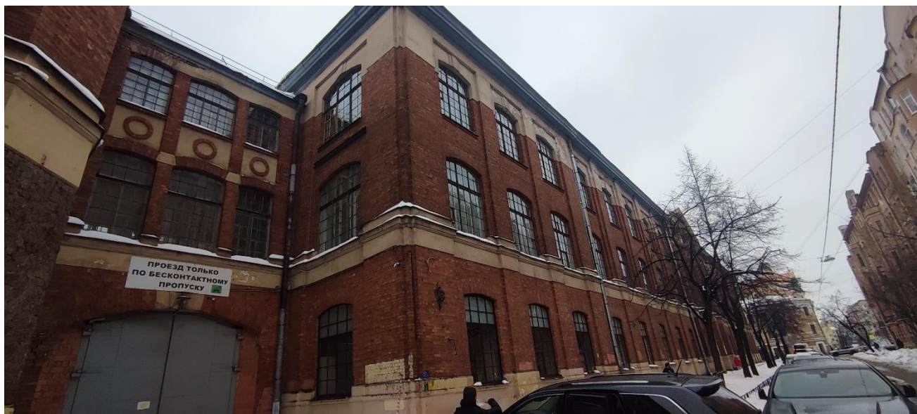
37. Фасад здания, выходящий на ул. Гатчинская.
