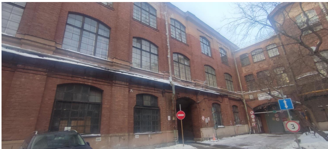
11. Восточные фасад здания.
