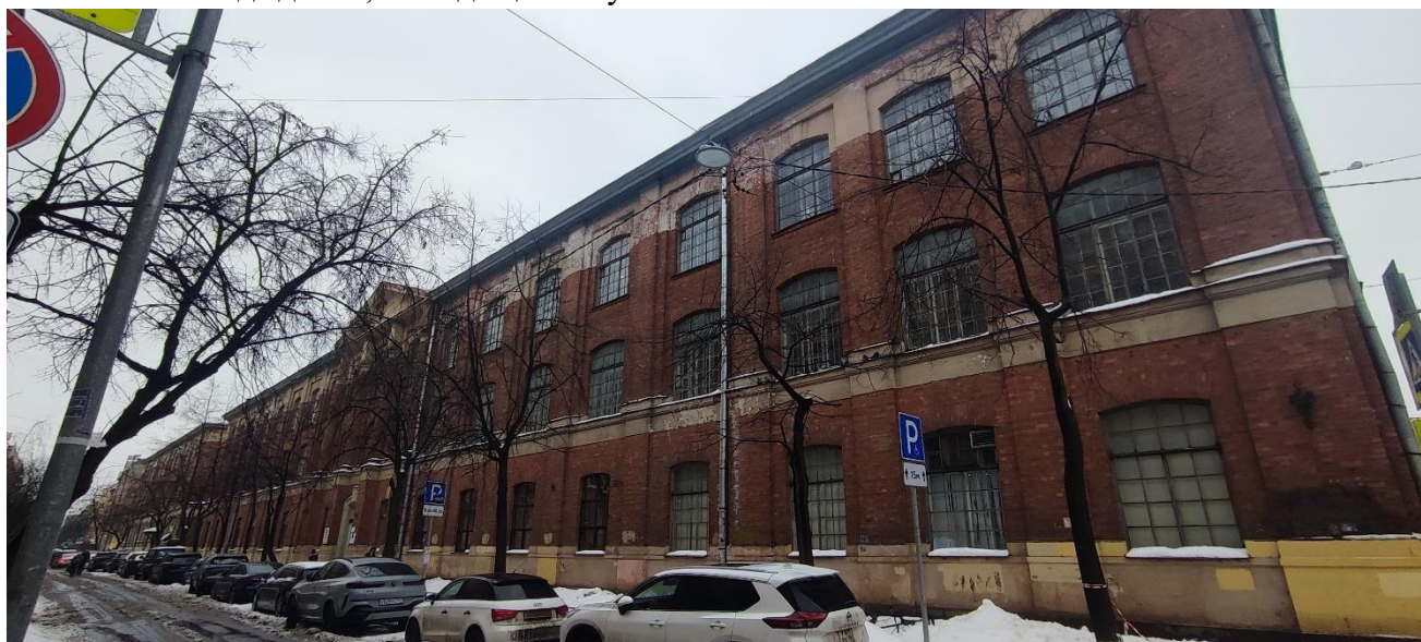
38. Фасад здания, выходящий на ул. Гатчинская.
