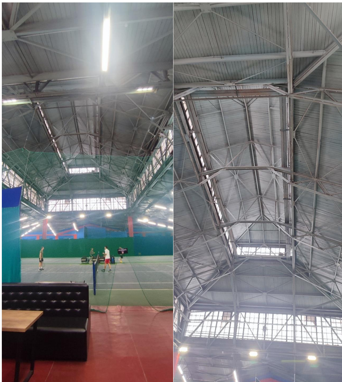
21. Фермовая металлическая конструкция дворового корпуса.
