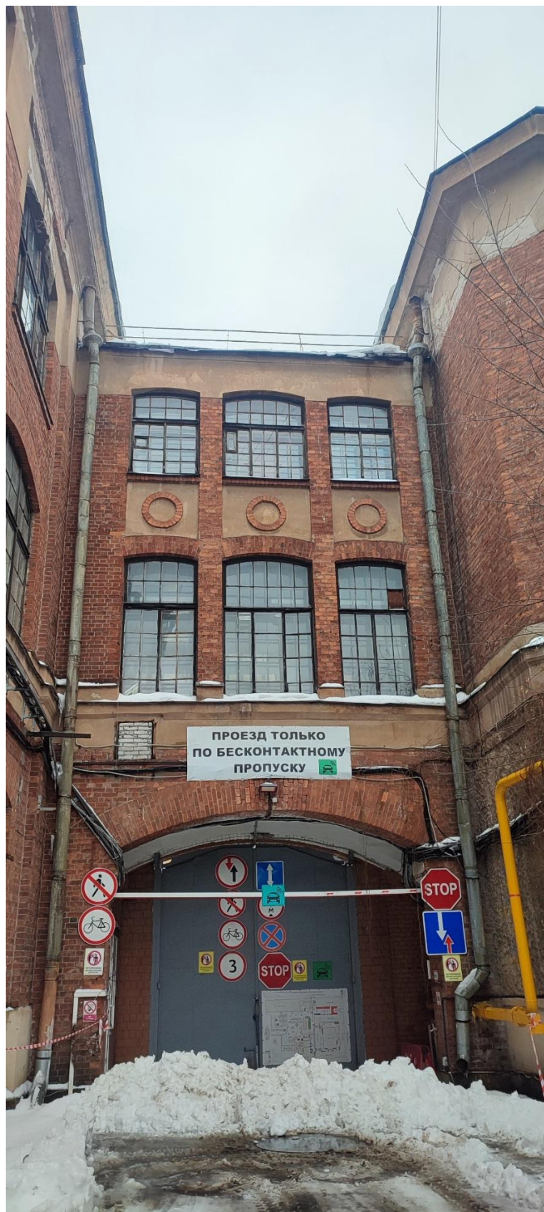
23. Переход над проездной аркой по гатчинской ул.
