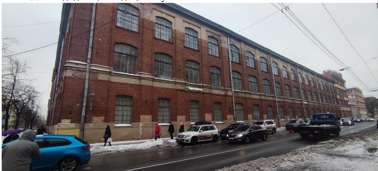
39. Фасад здания, выходящий на пр. Чкаловский.
