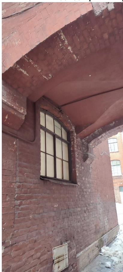
29. Оконные проём в дворовом проезде.
