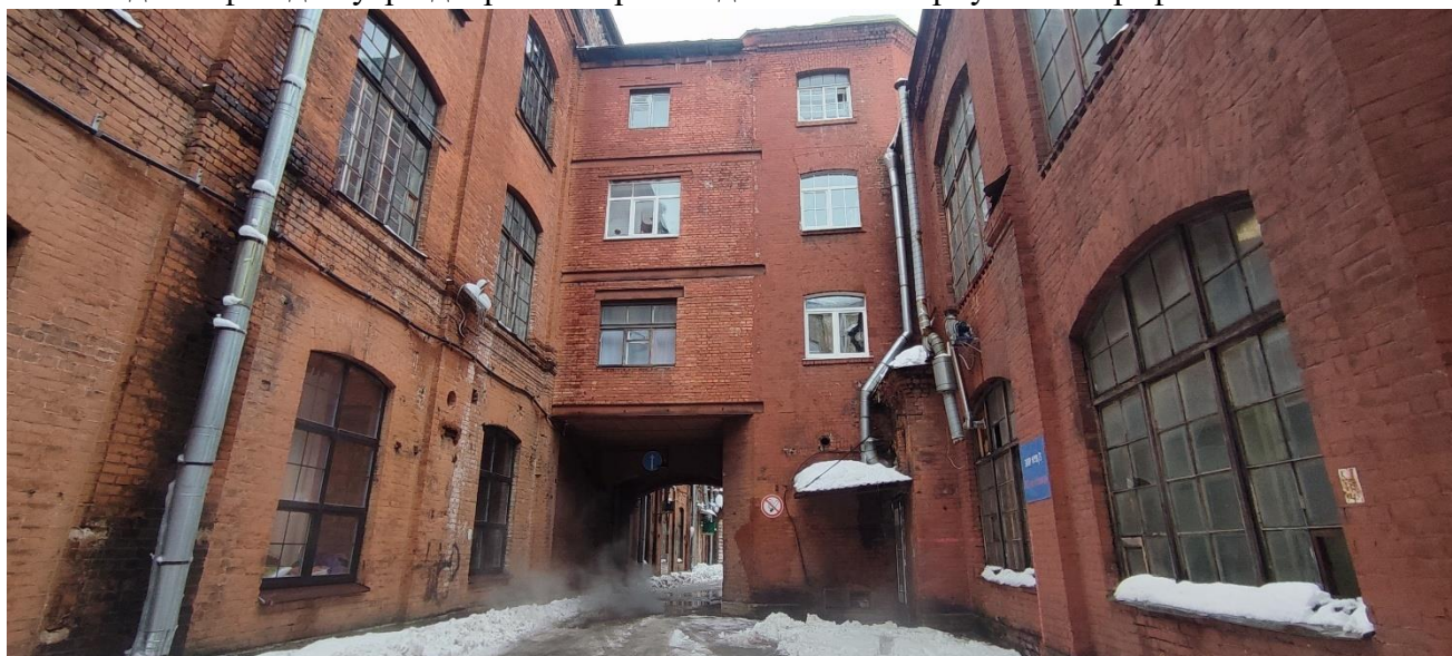
18. Переход между корпусами.
