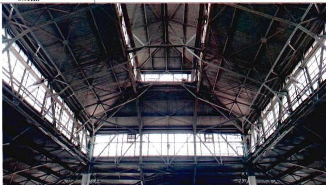
7. Металлоконструкции светового фонаря
