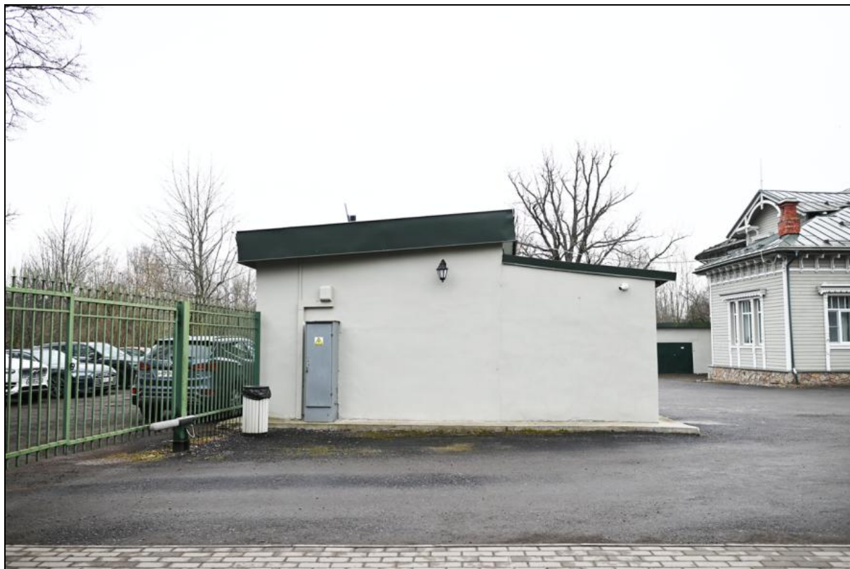
9. Северный фасад складского некапитального строения, подлежащего демонтажу. Справа - выявленный объект культурного наследия «Усадьба Белозерова (главное здание и сад)».
