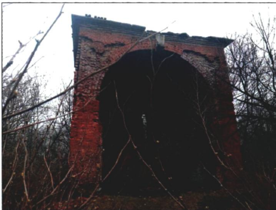
1.Общий вид на объект культурного наследия.
