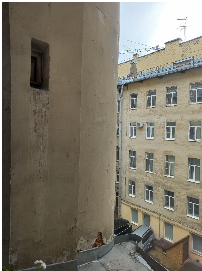
19. Выявленный ОКН «Дом С.В. Орлова-Давыдова» (г. Санкт-Петербург, Гороховая ул., д. 5. Вид оконного проема со стороны лестничной клетки.
