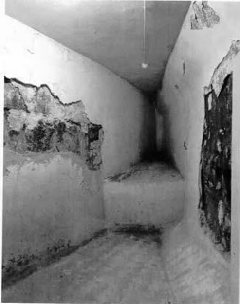
32. Помещение 1-Н, ч.п. 74. Загрязнения, утрата штукатурного и окрасочного слоев, оголение поверхности стены, биопоражения.
