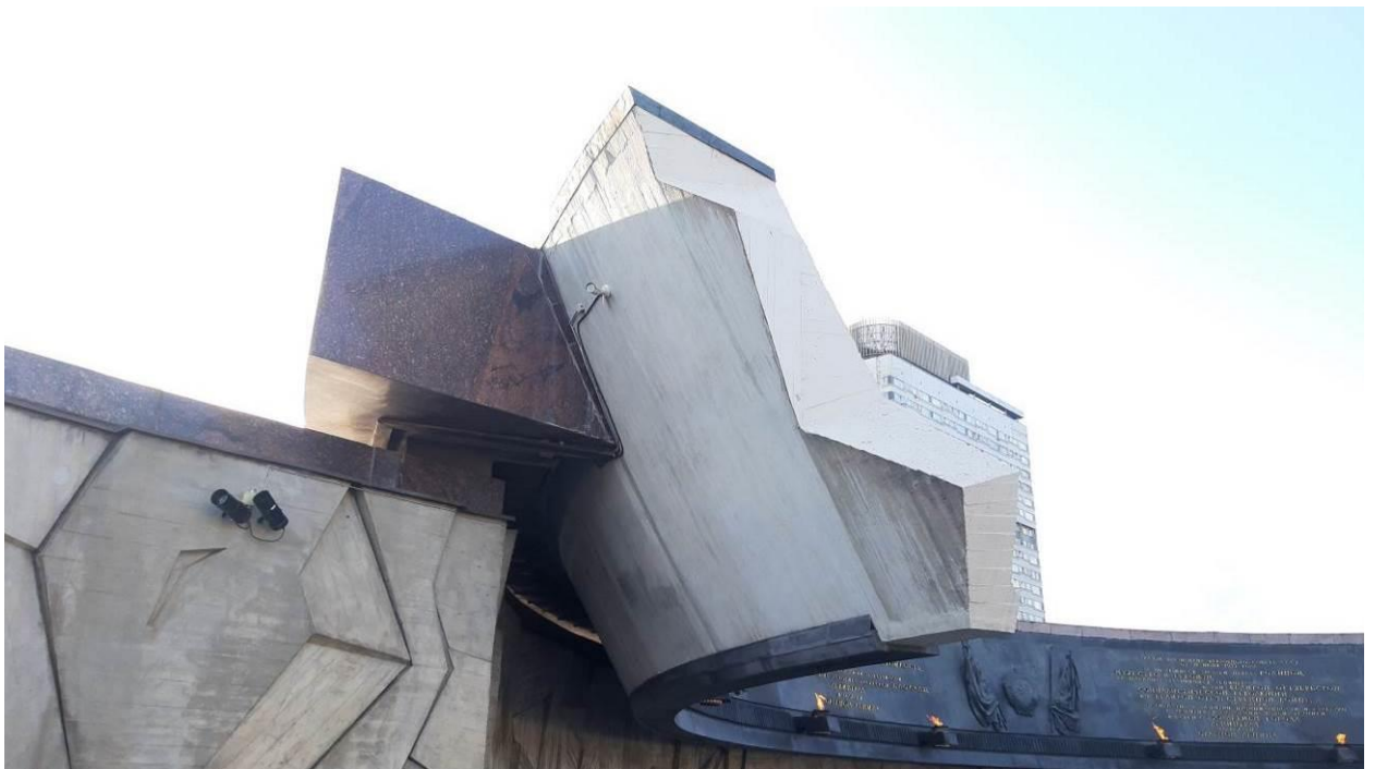
18. «Монумент героическим защитникам Ленинграда» (Победы пл., соор. 1, лит. А). Фото мест установки оборудования и прокладки кабельных трасс. Штиглиц М.С. 07.08.2026 г.
