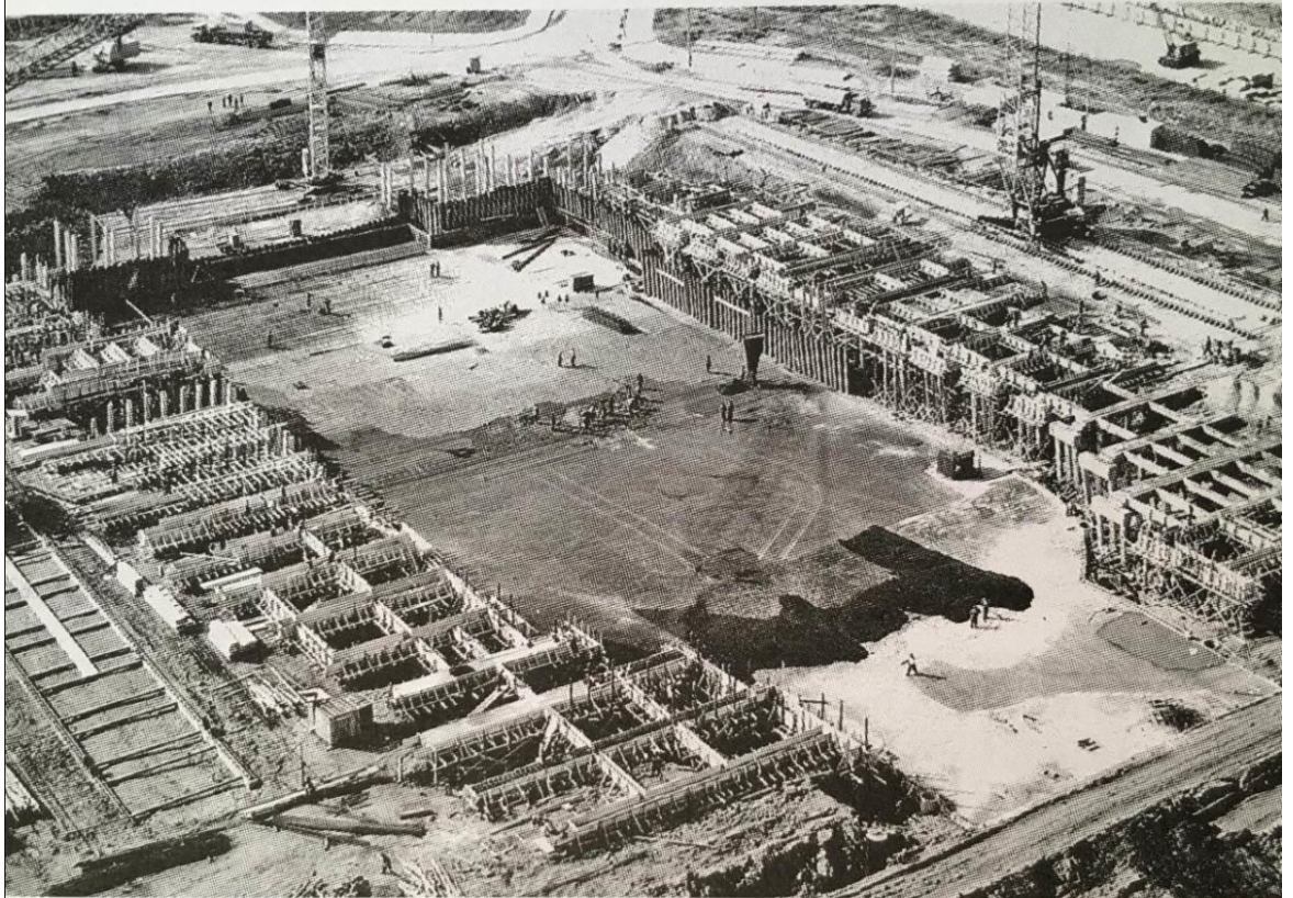
На строительной площадке Монумента героическим защитникам Ленинграда. Осень 1974 г.
