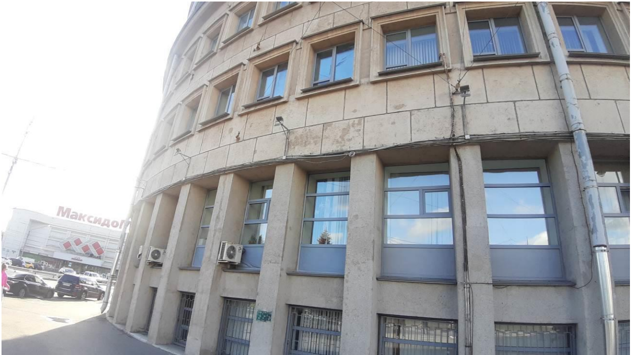
35. «Здание Московского райсовета» (Московский пр., д. 129, лит. А). Лицевой фасад (фрагмент). Фото мест установки оборудования и прокладки кабельных трасс. Штиглиц М.С. 07.08.2026 г.
