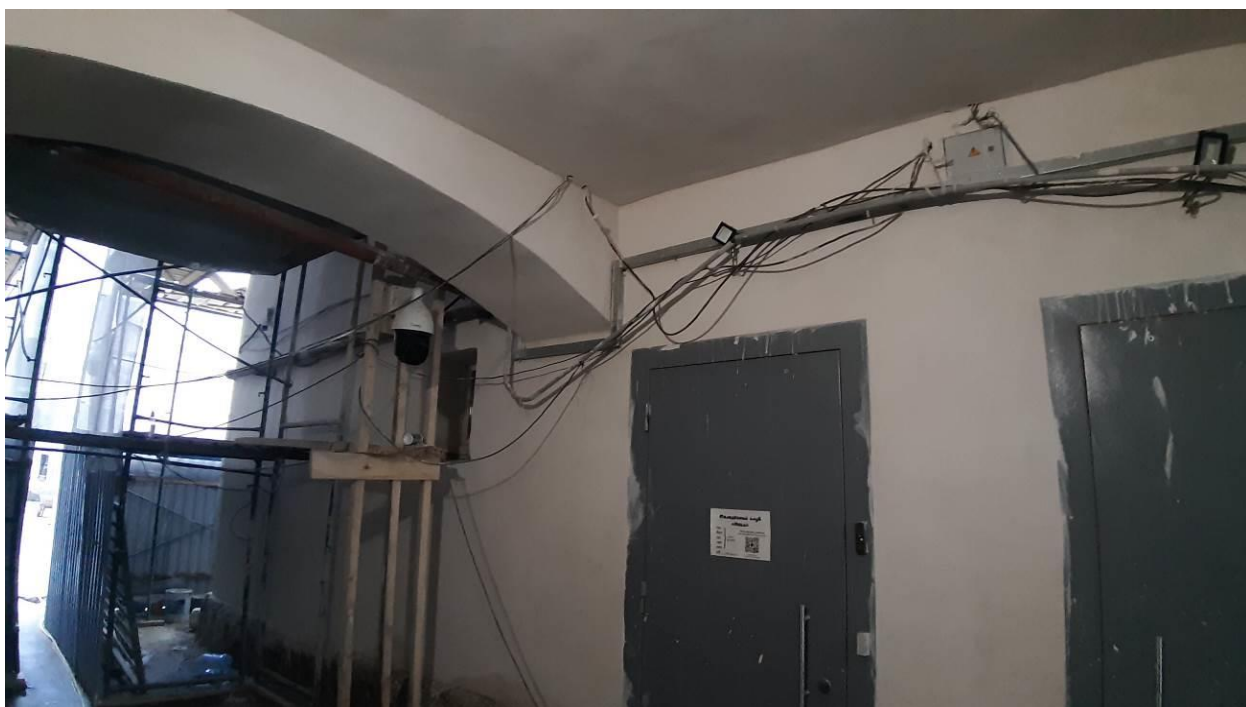
26. «Дом М.Д. Усова». Арка. Фото мест установки оборудования и прокладки кабельных трасс. (Смоленская ул., д. 1, лит. Д). Штиглиц М.С. 07.08.2026 г.
