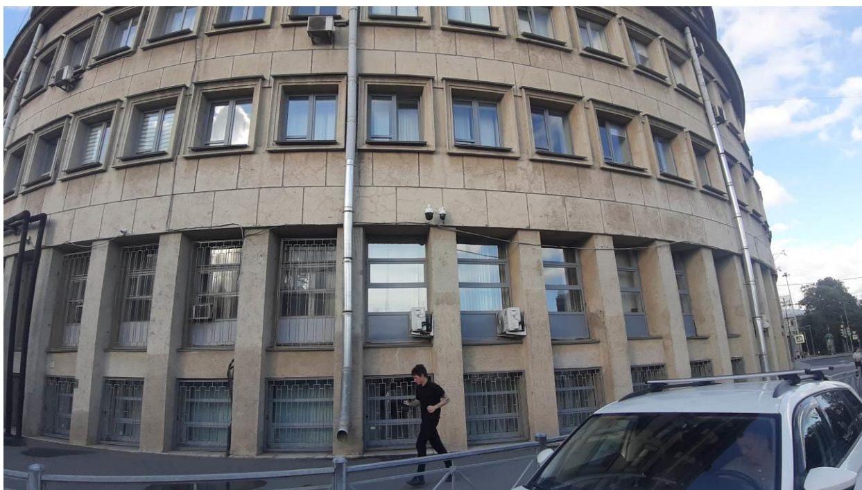
32. «Здание Московского райсовета» (Московский пр., д. 129, лит. А). Лицевой фасад (фрагмент). Фото мест установки оборудования и прокладки кабельных трасс. Штиглиц М.С. 07.08.2026 г.
