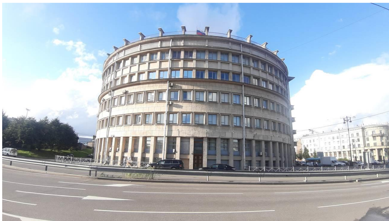
30. «Здание Московского райсовета» (Московский пр., д. 129, лит. А). Лицевой фасад. Штиглиц М.С. 07.08.2026 г.
