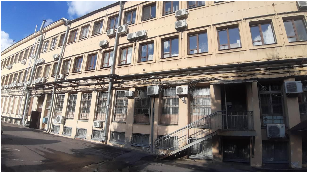
36. «Здание Московского райсовета» (Московский пр., д. 129, лит. А). Дворовый фасад (фрагмент). Фото мест установки оборудования и прокладки кабельных трасс. Штиглиц М.С. 07.08.2026 г.
