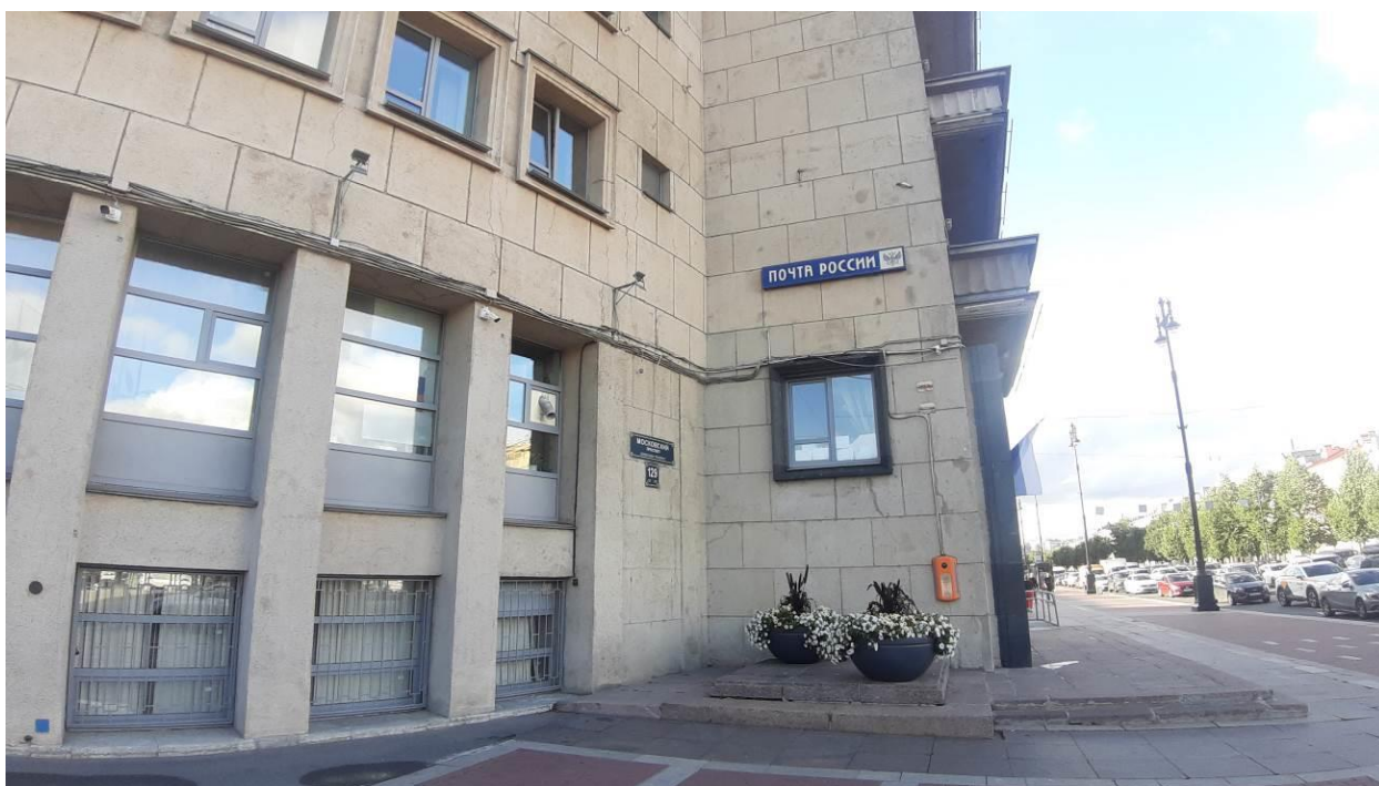
34. «Здание Московского райсовета» (Московский пр., д. 129, лит. А). Лицевой фасад (фрагмент). Фото мест установки оборудования и прокладки кабельных трасс. Штиглиц М.С. 07.08.2026 г.
