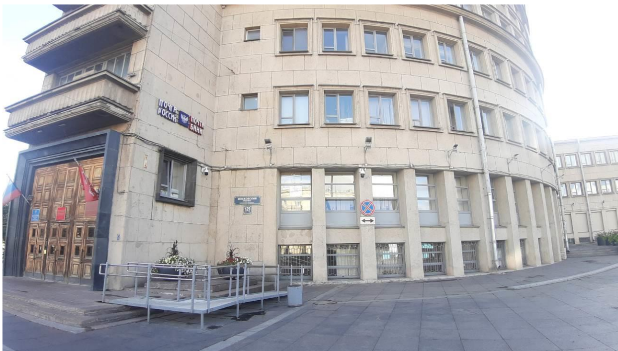
33. «Здание Московского райсовета» (Московский пр., д. 129, лит. А). Лицевой фасад (фрагмент). Фото мест установки оборудования и прокладки кабельных трасс. Штиглиц М.С. 07.08.2026 г.
