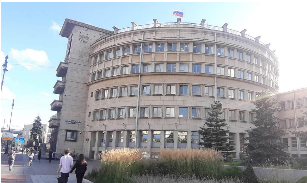
29. «Здание Московского райсовета» (Московский пр., д. 129, лит. А). Лицевой фасад. Штиглиц М.С. 07.08.2026 г.
