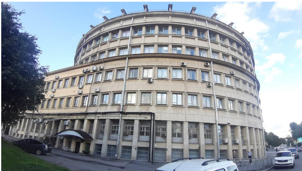
31. «Здание Московского райсовета» (Московский пр., д. 129, лит. А). Лицевой фасад. Штиглиц М.С. 07.08.2026 г.
