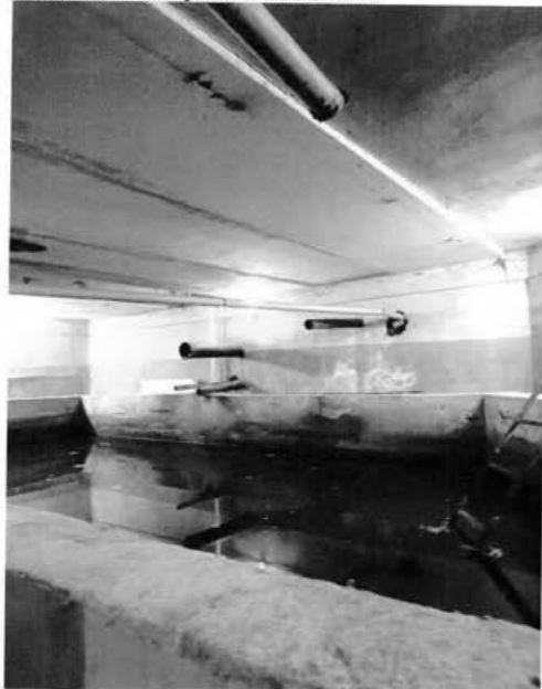
32. Помещение 1-Н, ч.п. 74. Загрязнения, утрата штукатурного и окрасочного слоев, оголение поверхности стены, биопоражения.
