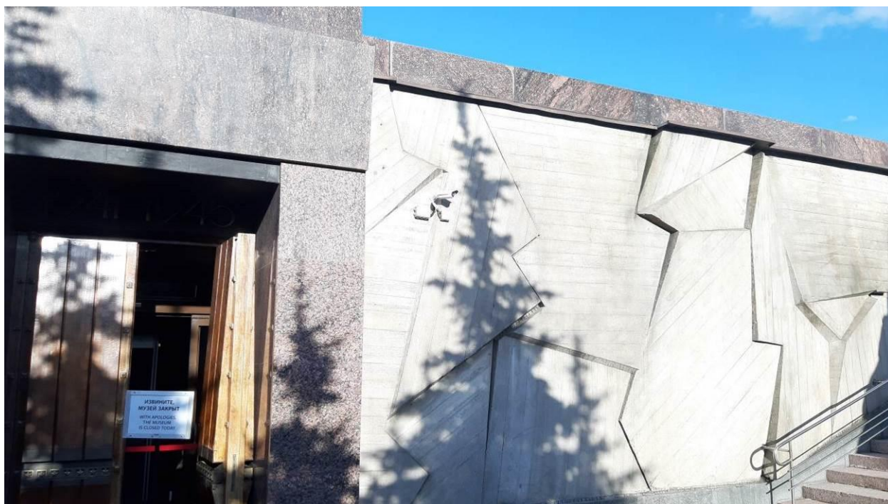
21. «Монумент героическим защитникам Ленинграда» (Победы пл., соор. 1, лит. А). Фото мест установки оборудования и прокладки кабельных трасс. Штиглиц М.С. 07.08.2026 г.
