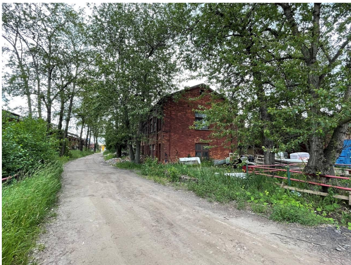
Фото 2. Фрагмент фасада здания по адресу Седова ул., дом 45, лит. АЕ
