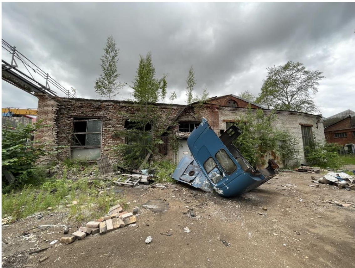
Фото 7. Фрагмент фасада здания по адресу Седова ул., дом 45, лит. АЕ
