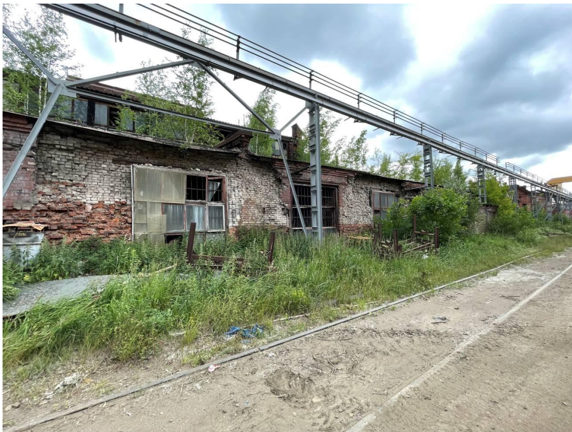
Фото 9. Фрагмент фасада здания по адресу Седова ул., дом 45, лит. АЕ
