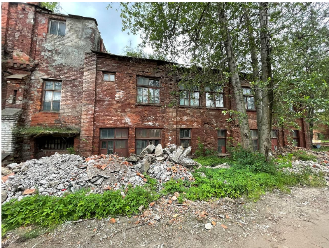
Фото 3. Фрагмент фасада здания по адресу Седова ул., дом 45, лит. АЕ
