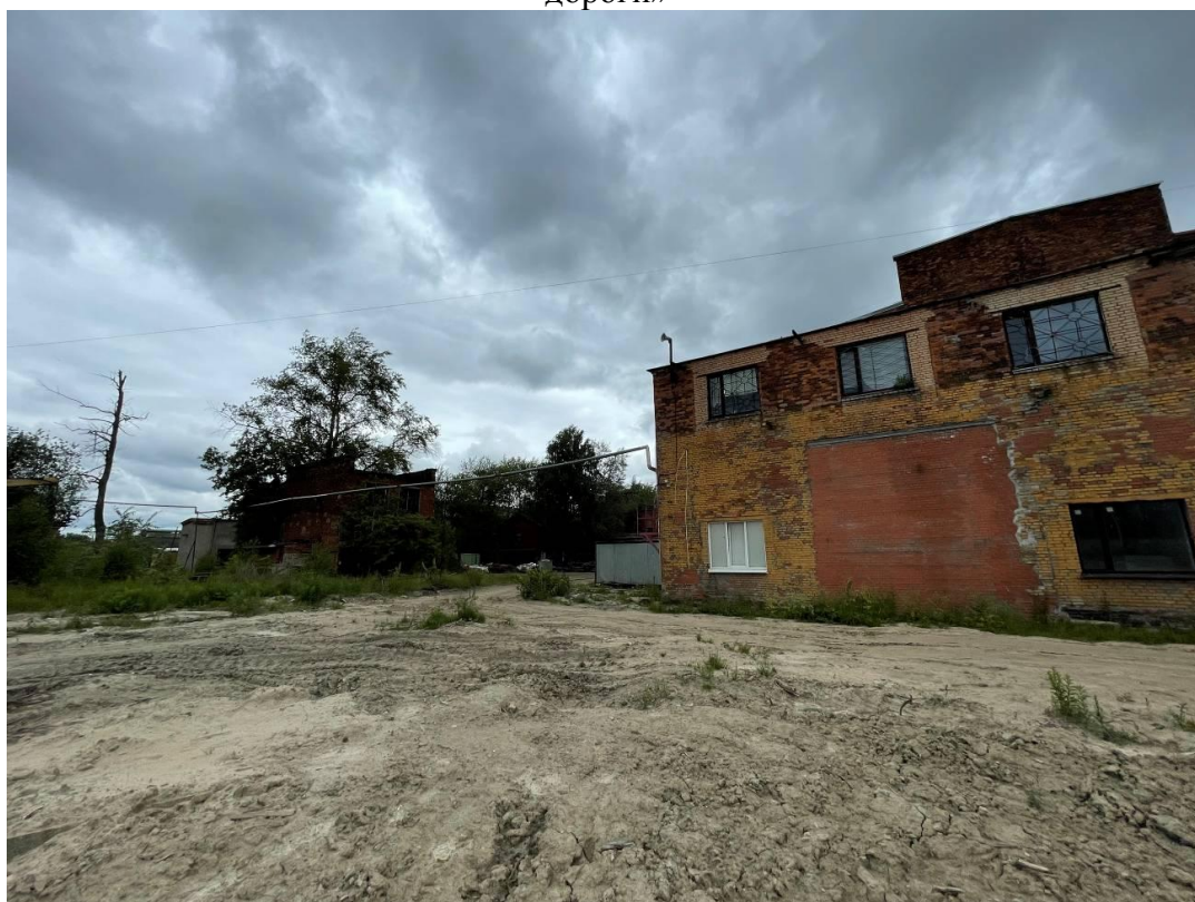
Фото 12. Фрагмент фасада выявленного объекта культурного наследия «Колесосборочный цех», входящего в состав выявленного объекта культурного наследия «Вагонные мастерские Александровского главного механического завода Николаевской железной дороги»
