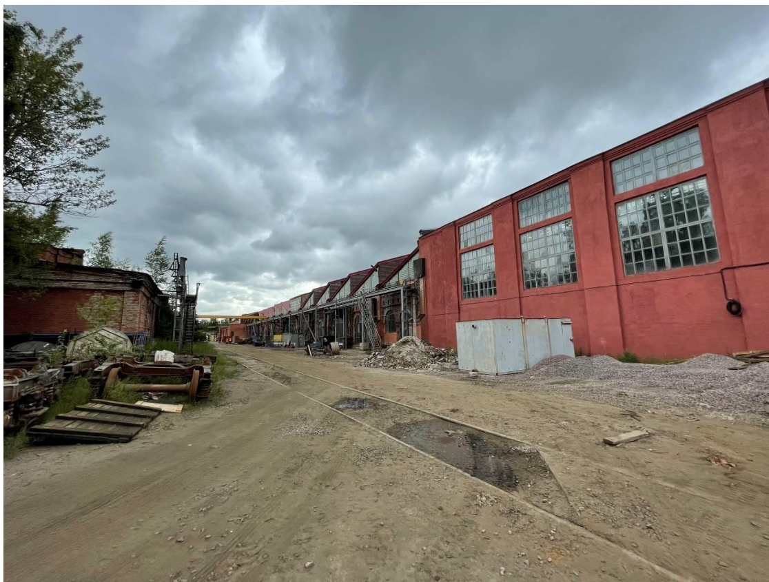
Фото 11. Фрагмент фасада выявленного объекта культурного наследия «Колесосборочный цех», входящего в состав выявленного объекта культурного наследия «Вагонные мастерские Александровского главного механического завода Николаевской железной дороги»
