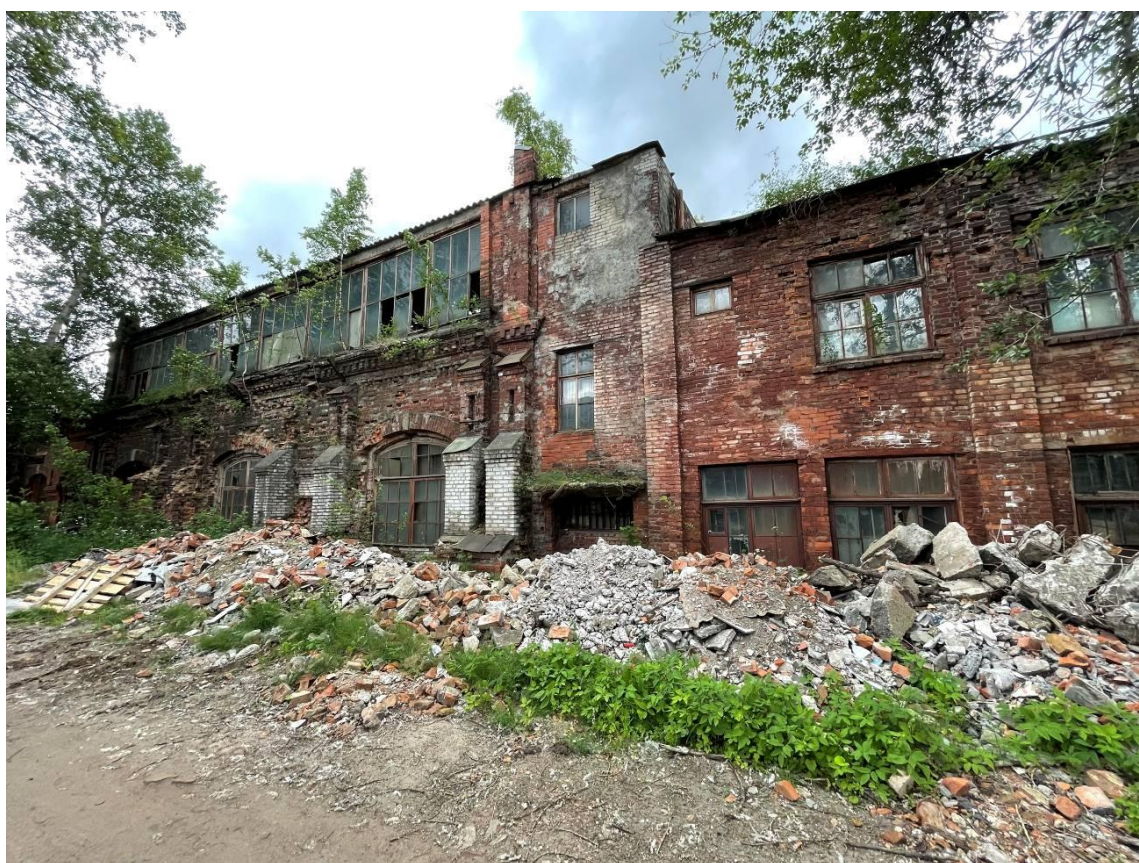
Фото 4. Фрагмент фасада здания по адресу Седова ул., дом 45, лит. АЕ
