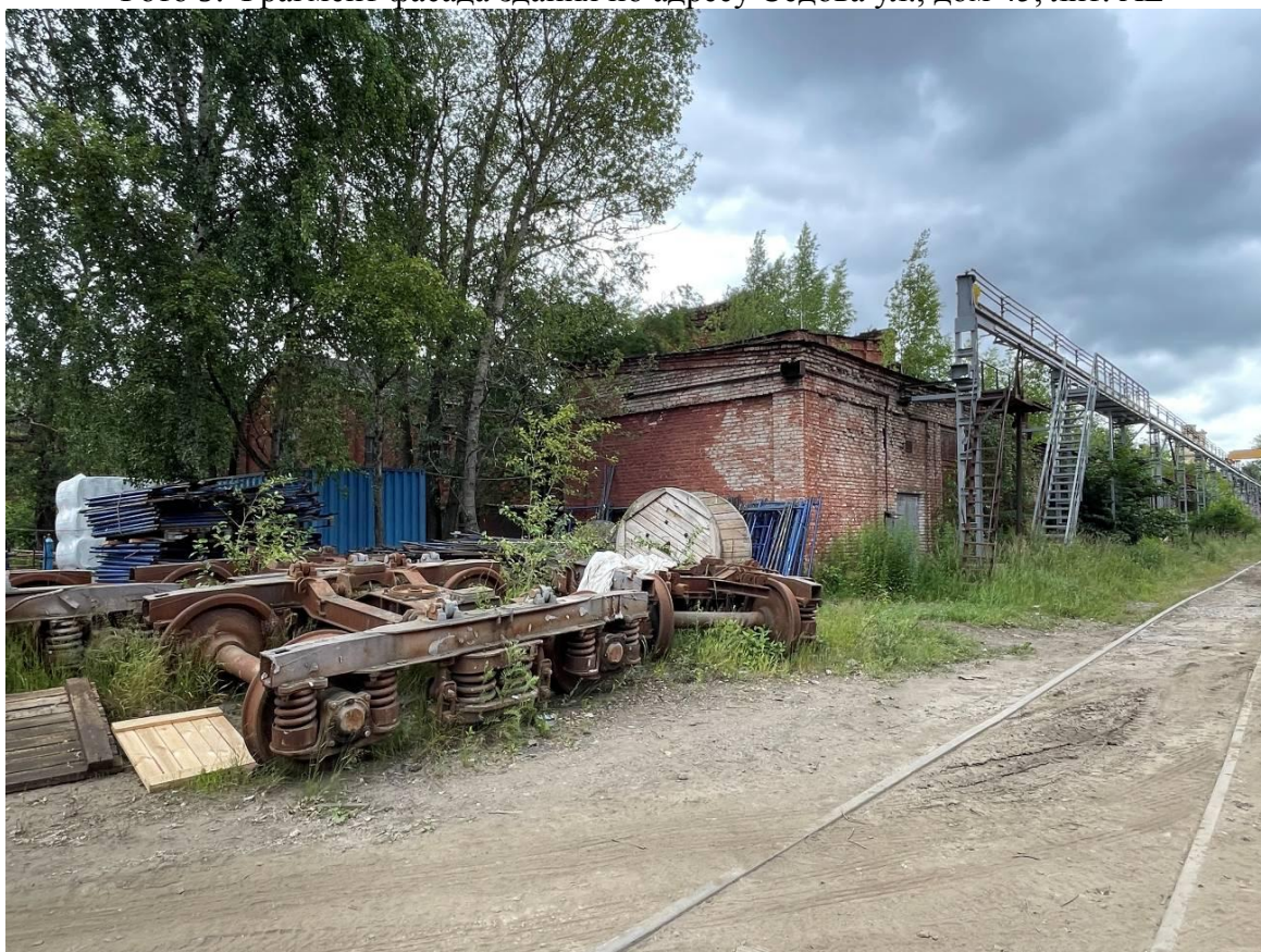
Фото 10. Фрагмент фасада здания по адресу Седова ул., дом 45, лит. АЕ
