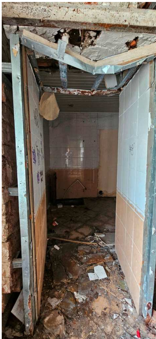
25. 1 эт. пом. б/н. Санузел.
