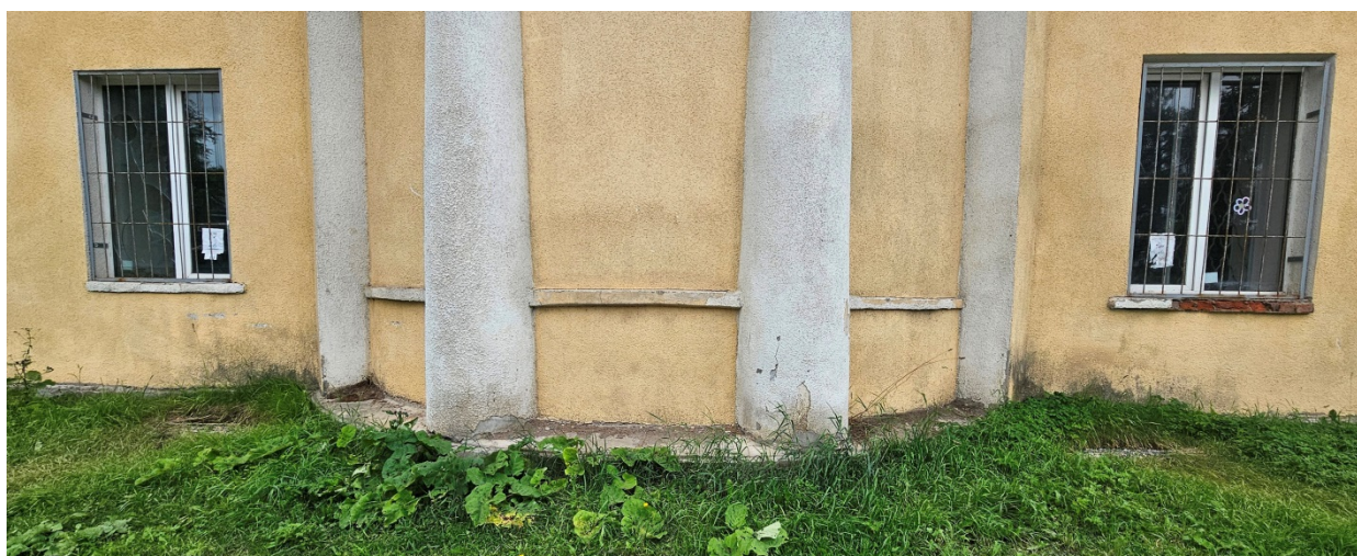
13. Фрагмент восточного фасада.
