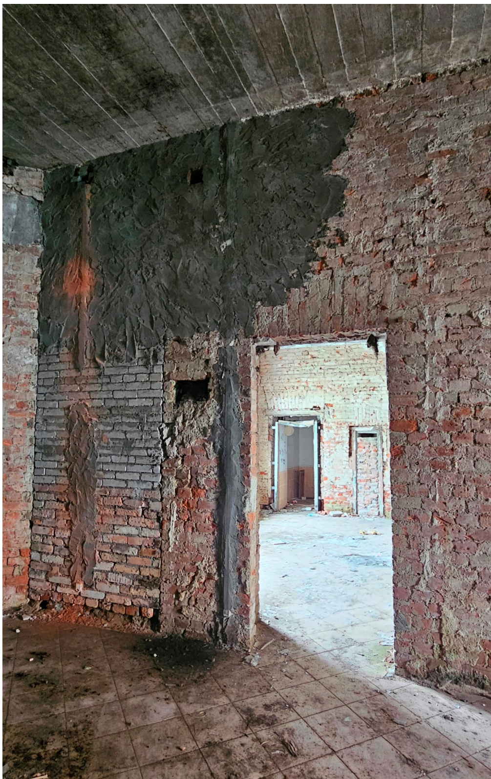
21. 1 эт., пом. 2. Дверной проем в южной капитальной стене.
