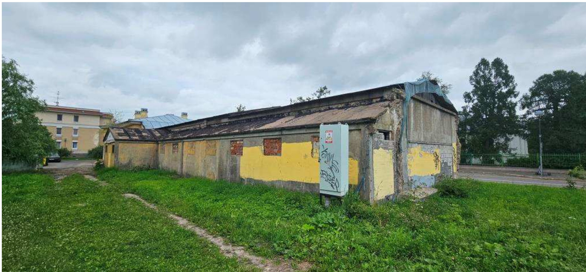
8. Общий вид объекта с юга. Западный и южный фасады.
