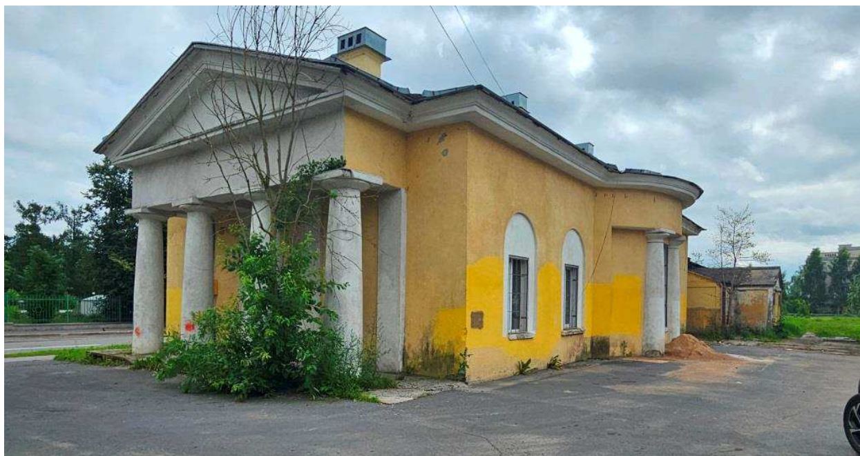
4. Общий вид северного и фрагмент западного фасада.
