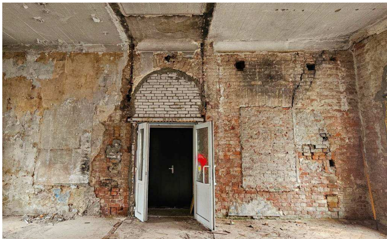
15. 1 эт., пом.1. Северная стена с заложенными проемами.
