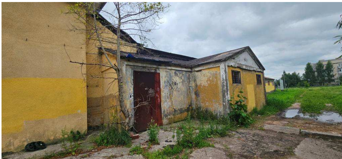
6. Фрагмент западного фасада. Вид поздней пристройки.
