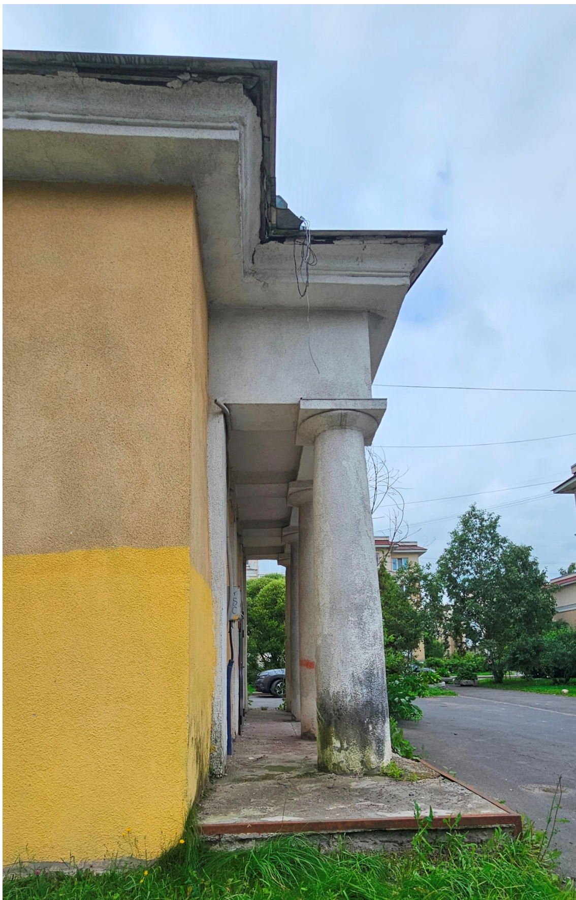
14. Портик главного фасада. Вид с запада.
