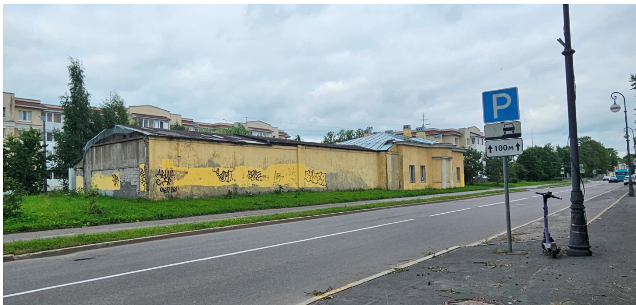
11. Общий вид восточного фасада (по Гусарской ул.).
