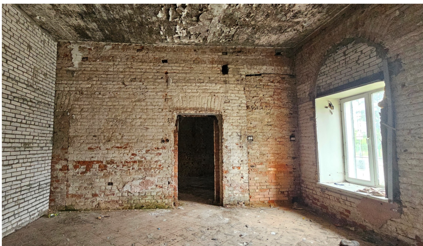
23. 1 эт., пом.3. Общий вид помещения. Вид северной капитальной стены.
