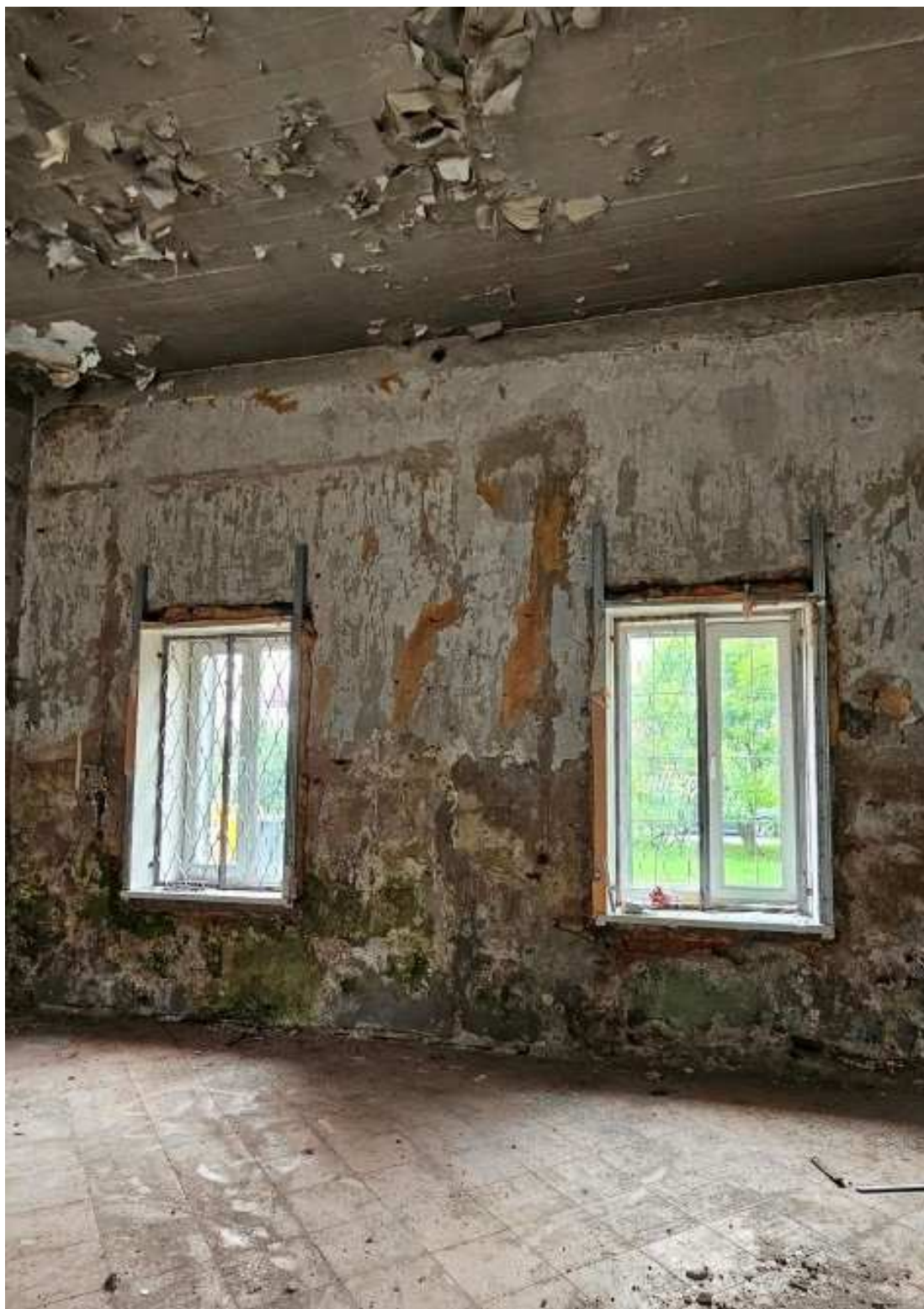
17. 1 эт., пом.1. Частично заложённые оконные проёмы в западной капитальной стене.
