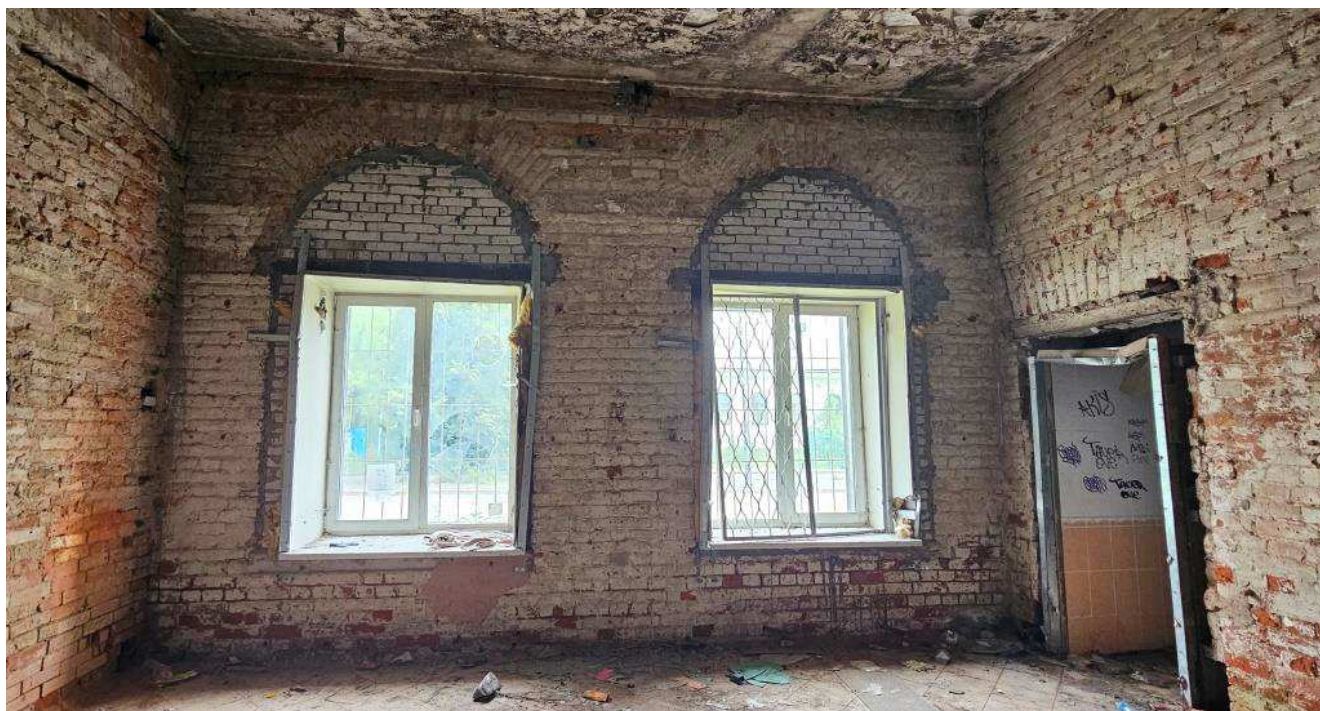
24. 1 эт.пом. 3. Частично заложенные оконные проемы в восточной капитальной стене.
