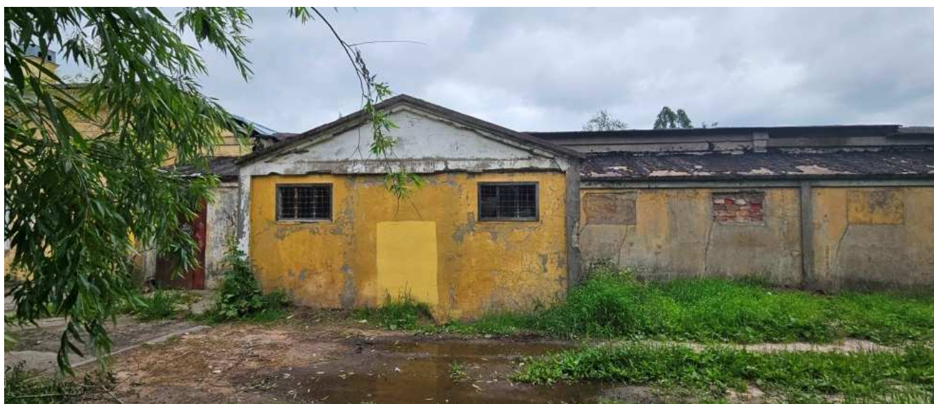
7. Фрагмент западного фасада. Вид поздней пристройки.
