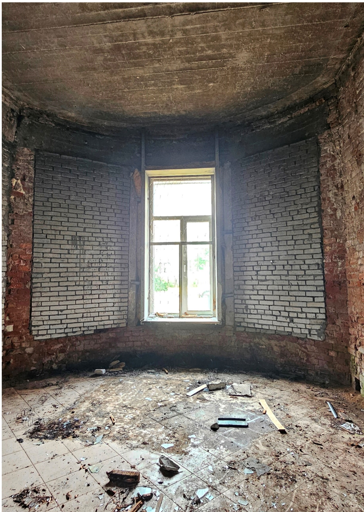
20. 1 эт., пом. 2. Заложенные оконные проемы в западной капитальной стене.
