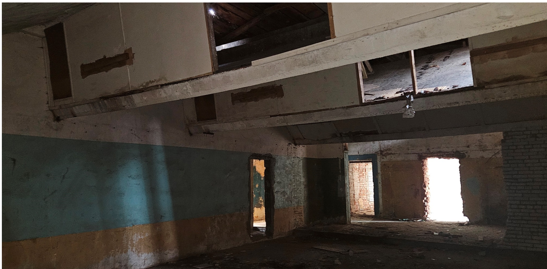
31. 1 эт. пом.5. Помещение бывшего тира. Вид пулеулавливающих козырьков.
