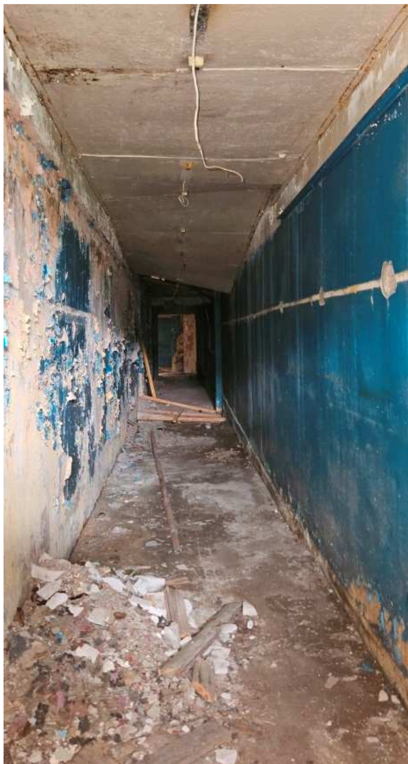
35. 1 эт., пом.8. Вид коридора. Съемка в направлении С-Ю.
