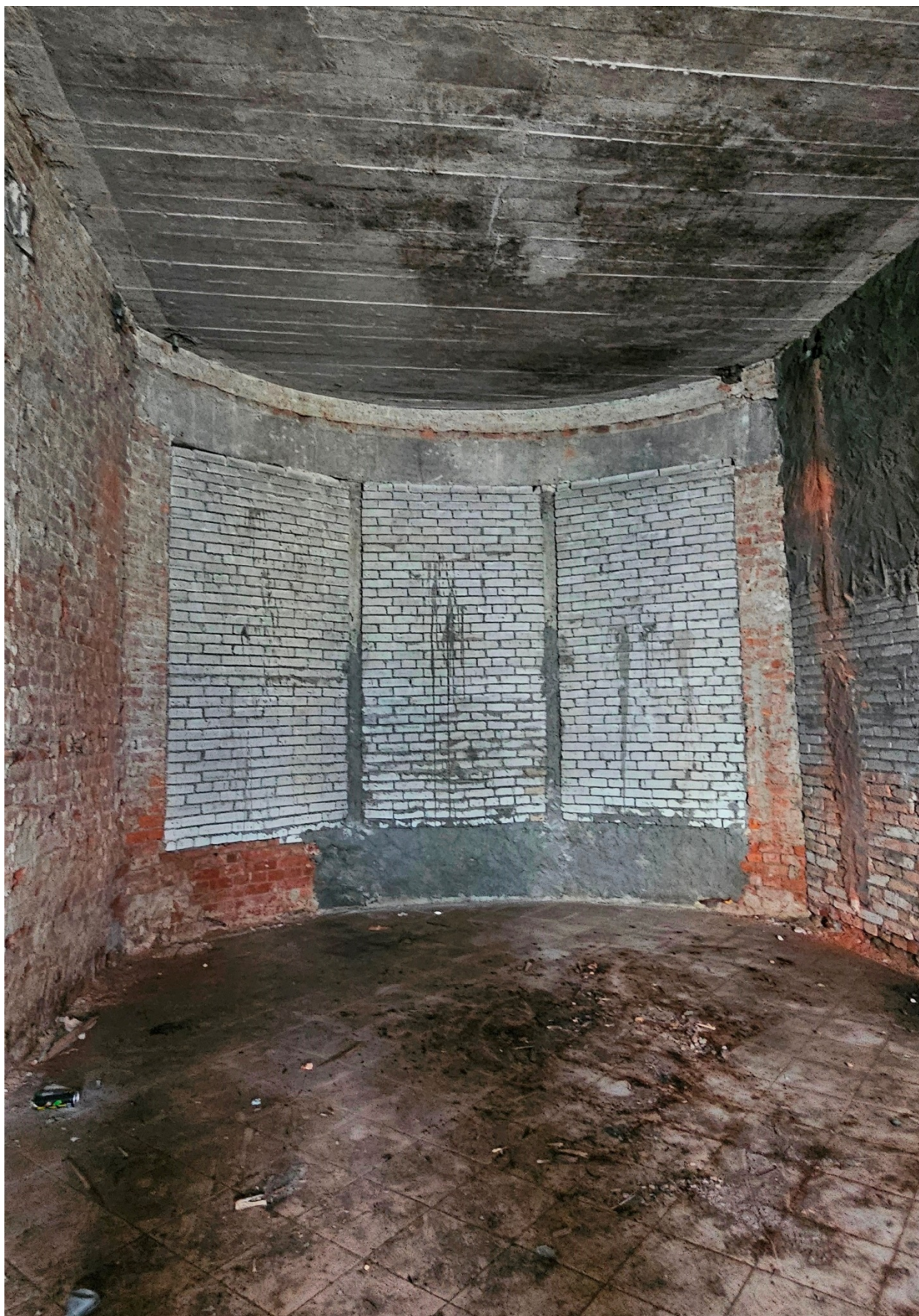
19. 1 эт., пом. 2. Заложенные оконные проемы в восточной капитальной стене.
