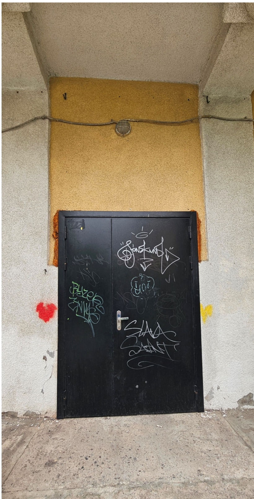
3. Фрагмент северного фасада. Главный вход в здание.
