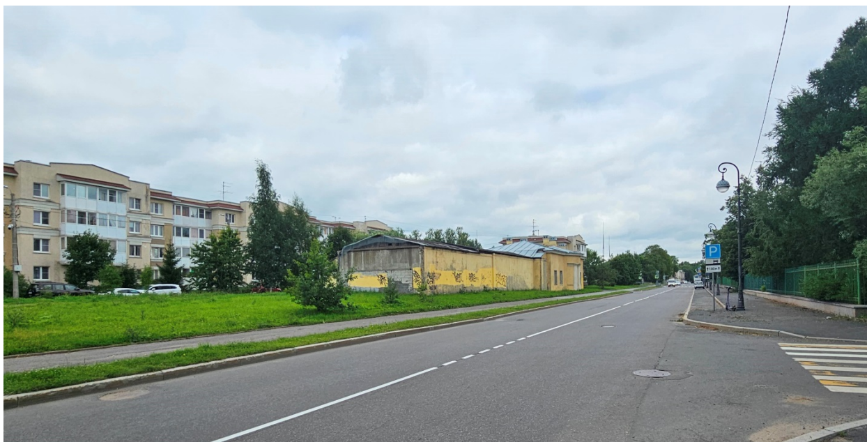
10. Общий вид объекта в застройке четной стороны Гусарской улицы. Съемка в направлении Ю-С.
