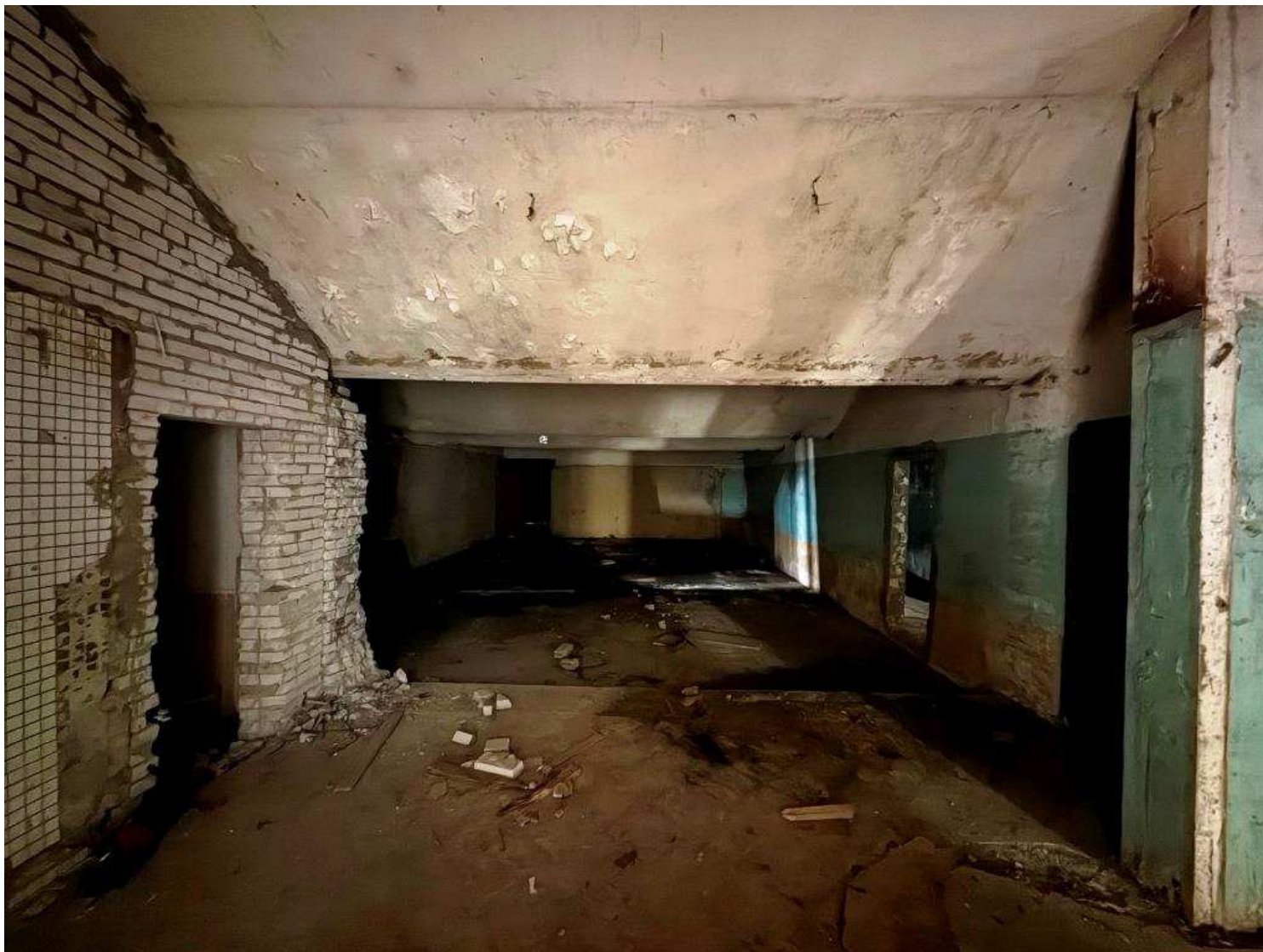
30. 1 эт., пом.5. Вид в направлении помещения бывшего тира. Съемка С-Ю.
