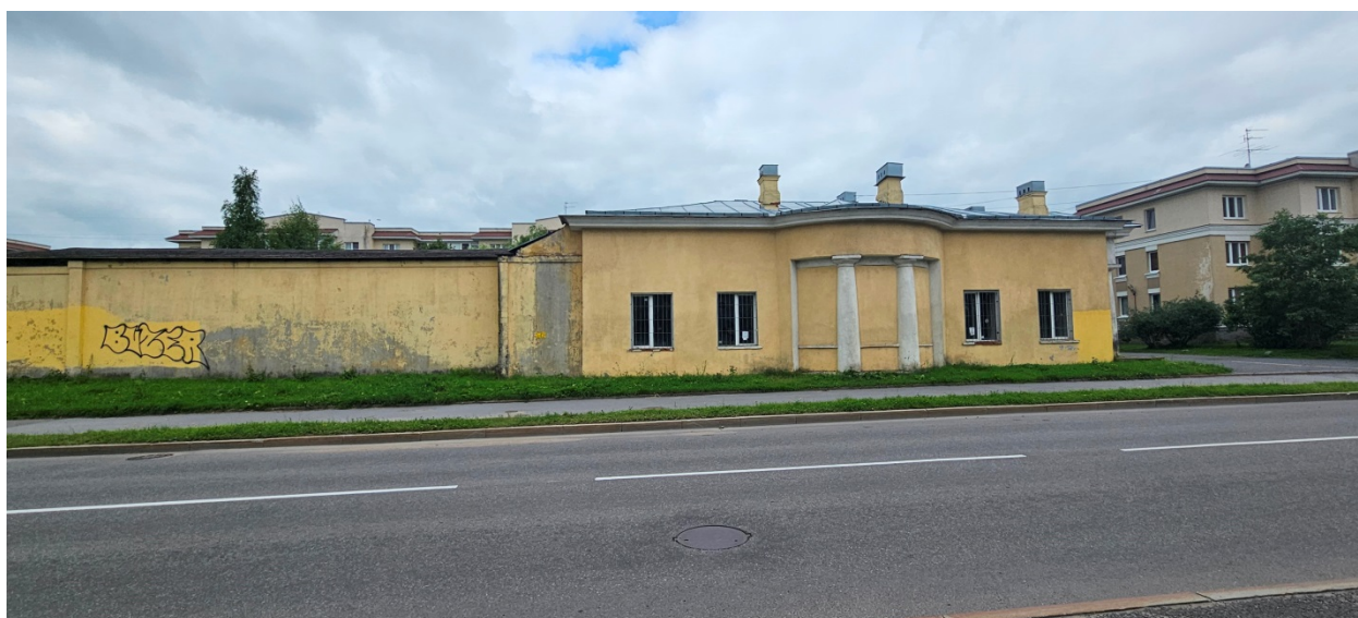
12. Фрагмент восточного фасада.
