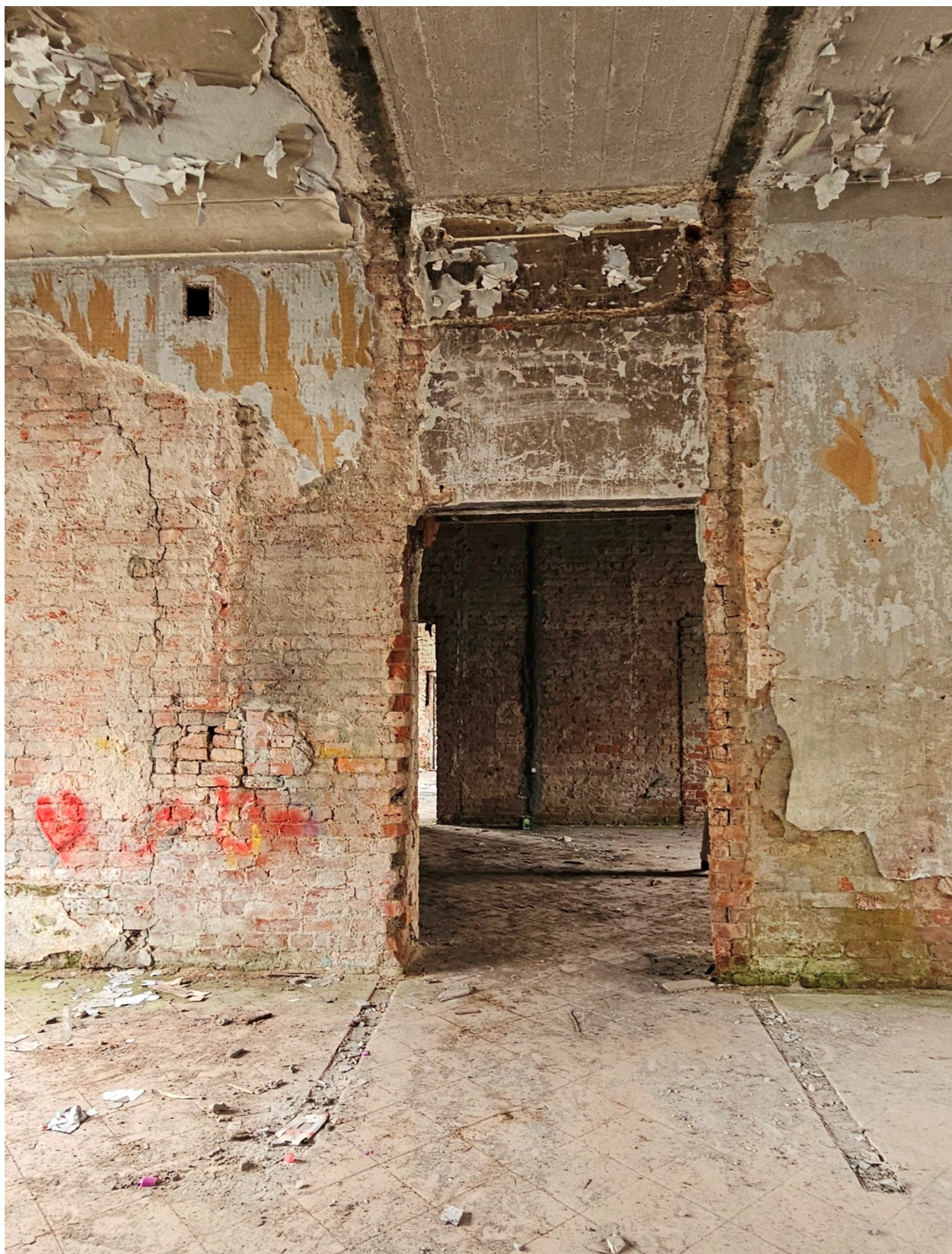
18. 1 эт., пом.1. Дверной проем южной капитальной стене.
