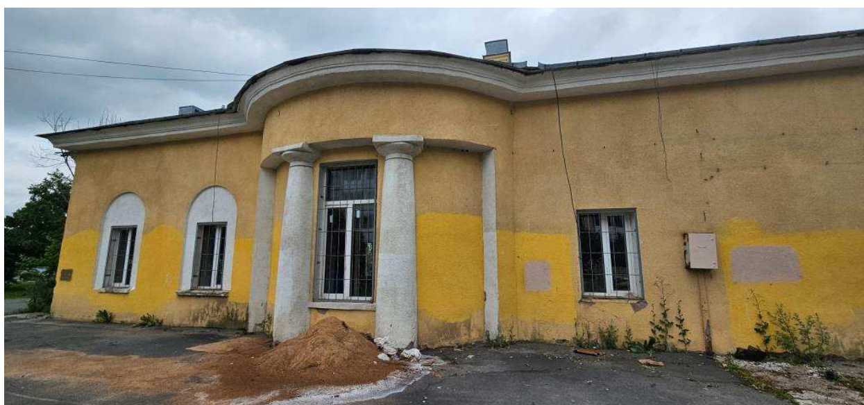
5. Фрагмент западного фасада.
