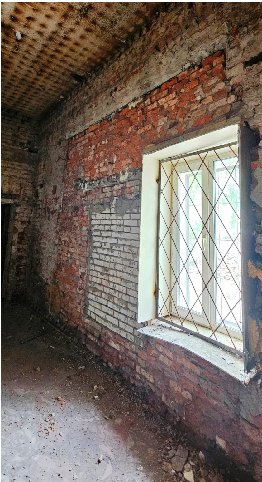
27. 1 эт., пом.4. Общий вид помещения. Вид оконного проема в западной капитальной стене.
