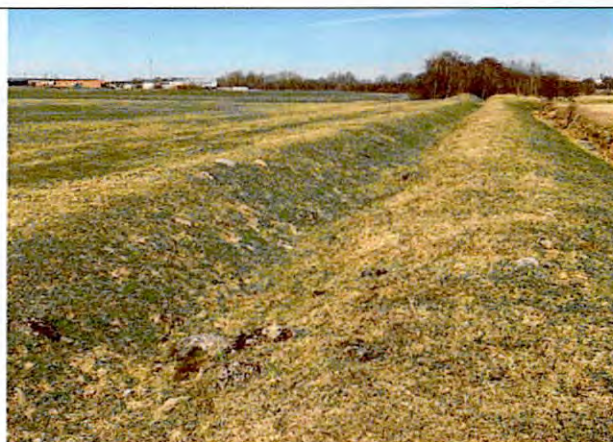
Фото 18. Подземный водовод в полях восточнее ж/д ветки.
