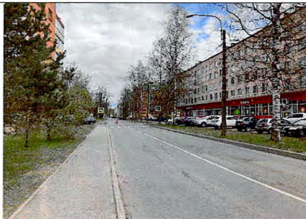
Фото 89. Трасса водовода. Павловск, ул. Березовая
