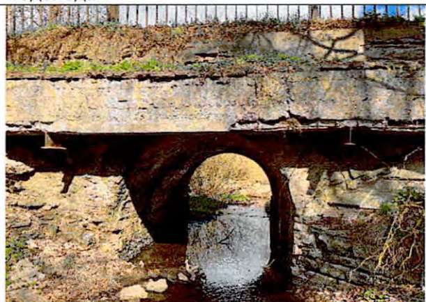
Фото 98. Павловск, ул. Правды. Водопроводный мост, южный фасад
