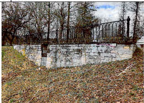
Фото 92. Павловск. Плотина на Купальном пруду с водопропускным сооружением
