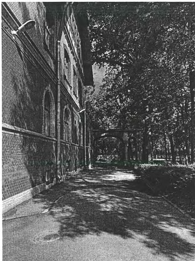
4. Северный фасад объекта.
