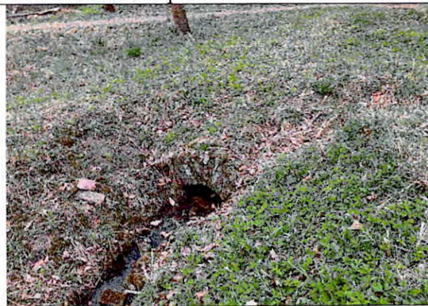
Фото 40. Выпуск из закрытого коллектора в открытую канаву
