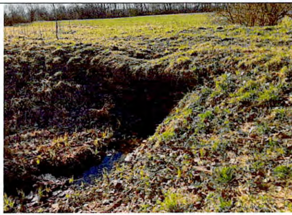
Фото 30. Каменный мост-акведук через мелиоративный канал на трассе водовода в поле южнее Красносельского шоссе
