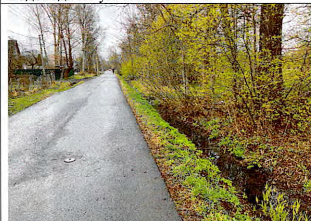
Фото 87. Пушкин, открытый канал по Садовой ул.
