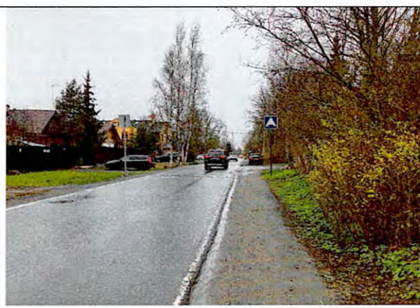
Фото 84. Пушкин, трасса водовода по ул. Ломоносова
