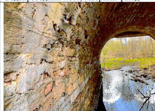
Фото 99. Павловск, ул. Правды. Водопроводный мост, свод
