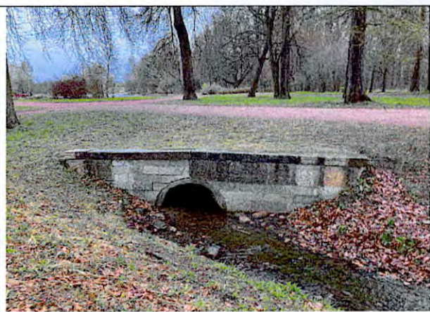
Фото 66. Водовыпуск в канал с облицовкой известняком
