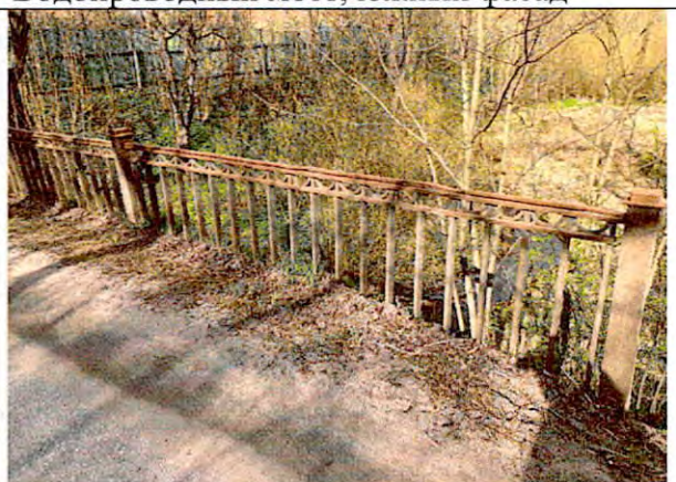
Фото 100. Павловск, ул. Правды. Водопроводный мост, ограждение
