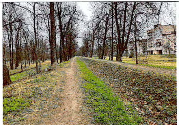
Фото 52. Баурский канал, выполненный в насыпи, имеется каменное мощение
