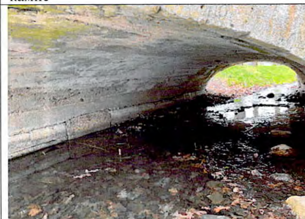
Фото 69. Свод мостика обетонирован
