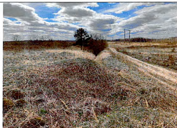
Фото 5. Трасса водовода в полях западнее Киевского шоссе. Рядом проходит историческая дорога
