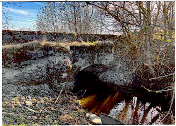
Фото 22. Акведук через р. Кузьминку, западный фасад
