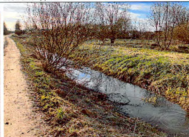
Фото 16. Открытый канал западнее Ж/д ветки в Новокондакопшино
