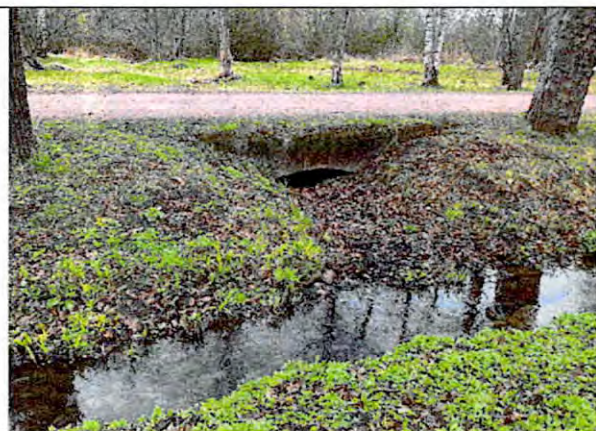
Фото 71. Мостик с гранитным фасадом под аллеей. Западный фасад
