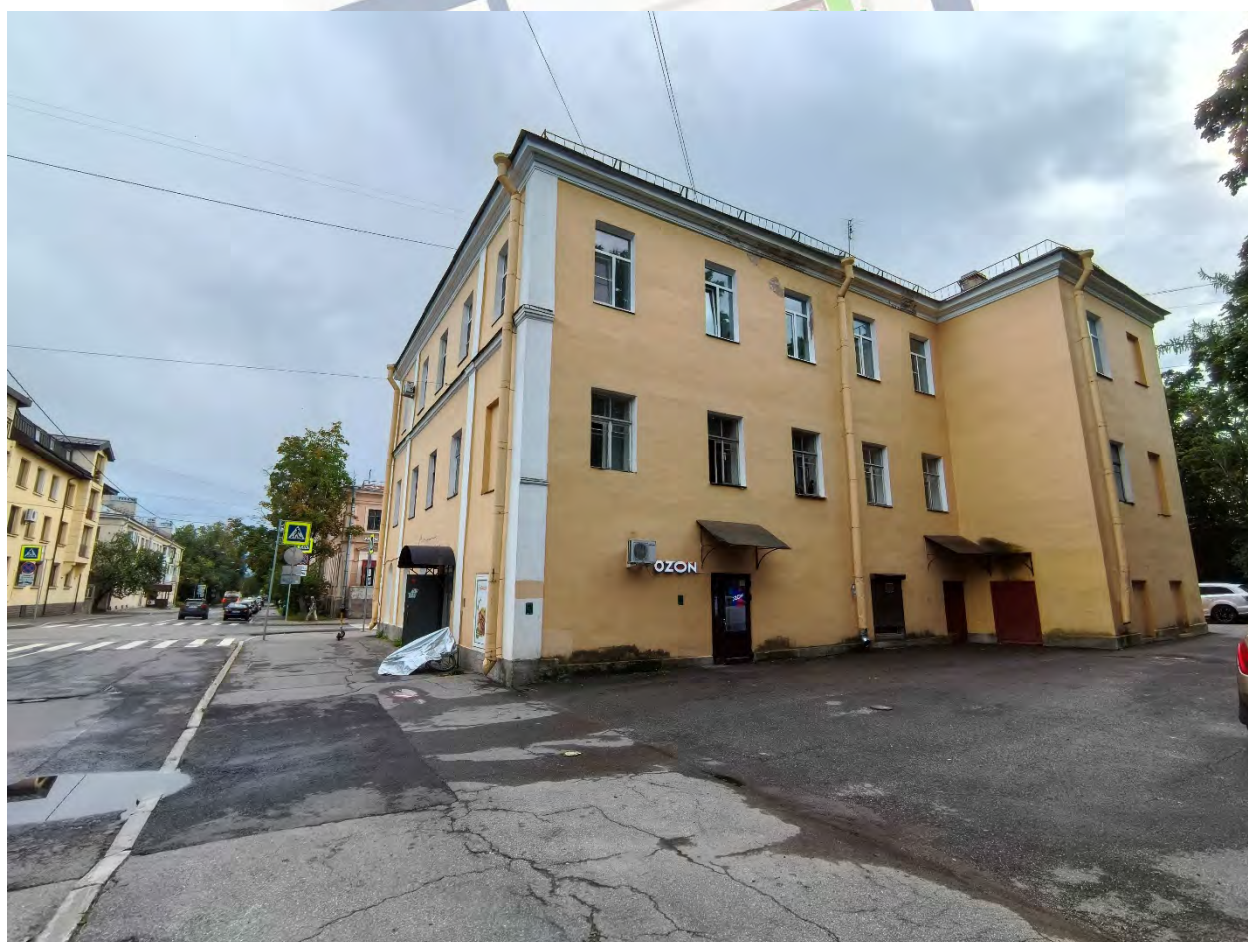
15.Выявленный объект культурного наследия «Дом Г.В. Клеве (Лазарева)» по адресу: Санкт-Петербург, г. Пушкин, Красной Звезды ул., 17; Радищева ул., 9. Дворовые фасады. Дата съемки: 08.06.2026г.
