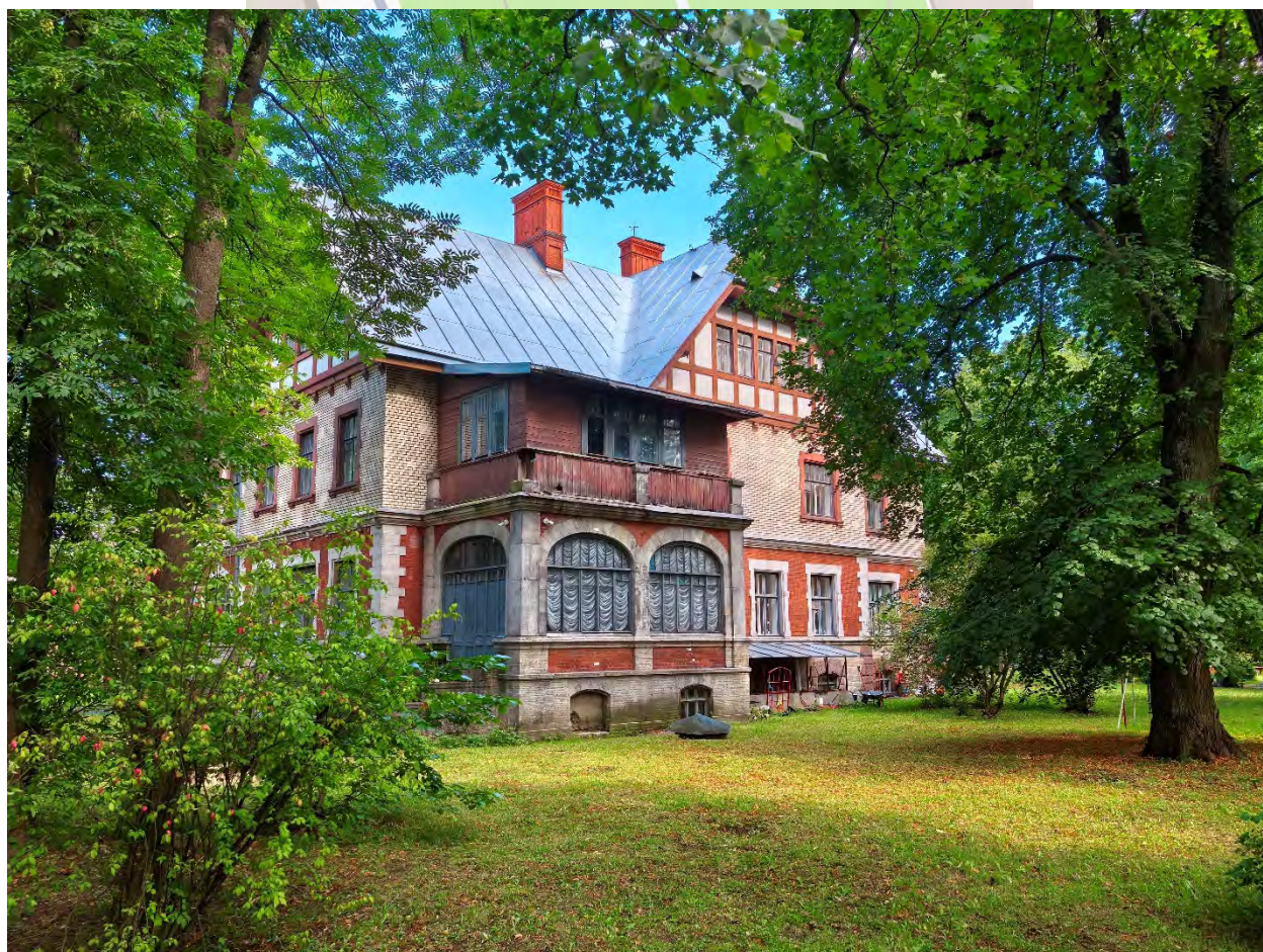
3. Объект культурного регионального значения «Дом Гудовича В.В. со служебным флигелем, садом и оградой» по адресу: Санкт-Петербург, г. Пушкин, Парковая ул., 18. Общий вид. Дата съемки: 08.06.2026г.
