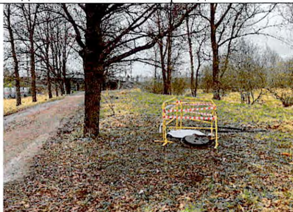
Фото 74. Трасса подземного участка Павловского водовода
