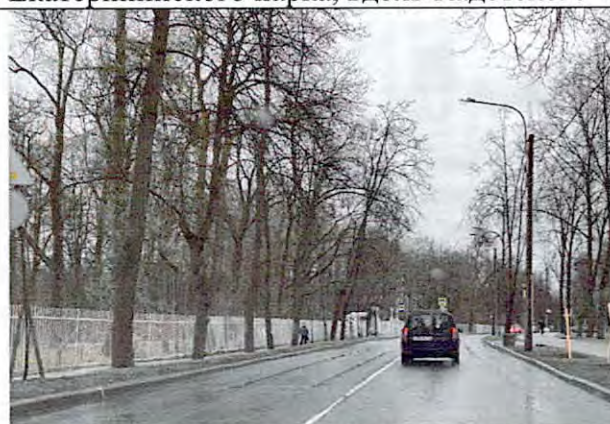
Фото 81. Пушкин, Парковая ул., Трасса водовода вдоль границы Екатерининского парка.
