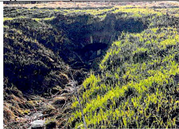
Фото 14. Конец подземного водовода и выход в открытый канал в Новокондакопшино
