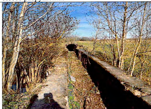
Фото 21. Акведук через р. Кузьминку
