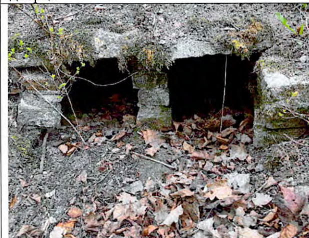
Фото 45. Выходные отверстия галереи, подававшей воду на Баболовский грот
