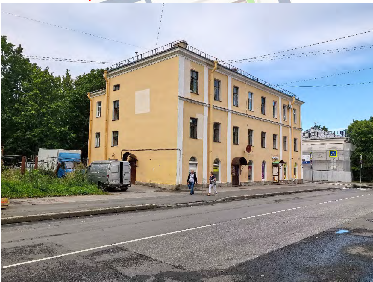
14.Выявленный объект культурного наследия «Дом Г.В. Клеве (Лазарева)» по адресу: Санкт-Петербург, г. Пушкин, Красной Звезды ул., 17; Радищева ул., 9. Общий вид. Дата съемки: 08.06.2026г.
