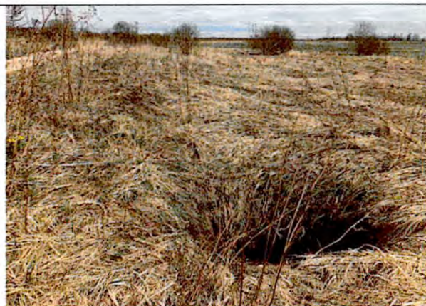
Фото 2. Воронка на месте колодца для обслуживания водовода
