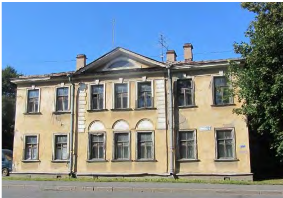
18.«Дом Е.Р. Фридрици (А.А. Григорьевой)» по адресу: Санкт-Петербург, г. Пушкин, Красной Звезды ул., 21. 2013г. Источник: www.citywalls.ru
