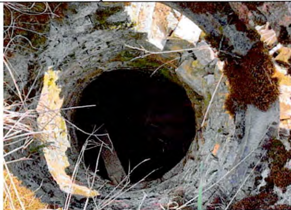
Фото 32. Кирпичный колодец с гранитным обрамлением на кирпичной галерее (вид внутри)
