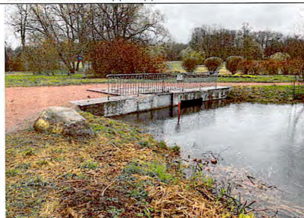
Фото 63. Железобетонная плотина-распределитель на Колонистском пруду в Отдельном парке. Водозабор Павловского водовода.
