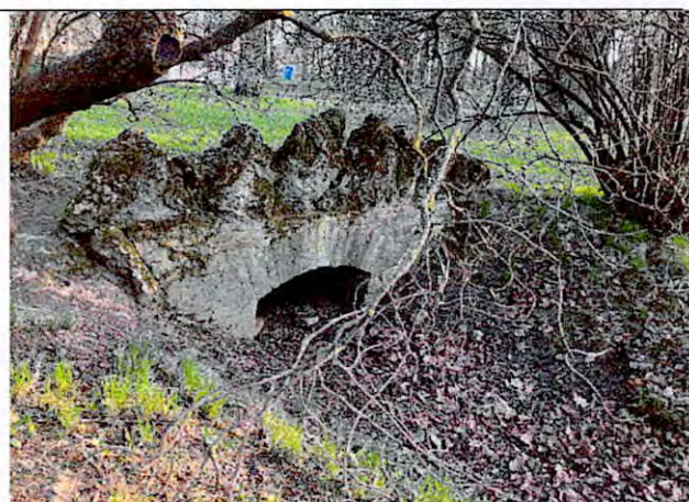
Фото 60. Портал выпуска Таицкого водовода в Екатерининском парке
