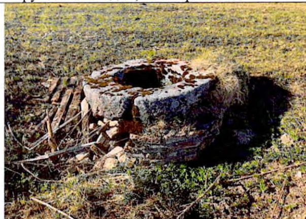
Фото 31. Кирпичный колодец с гранитным обрамлением на кирпичной галерее
