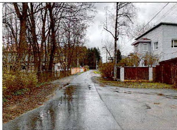
Фото 79. Водопроводная улица пос. Тярлево
