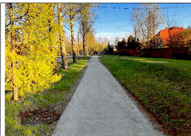
Фото 83. Пушкин, трасса водовода по ул. Ломоносова
