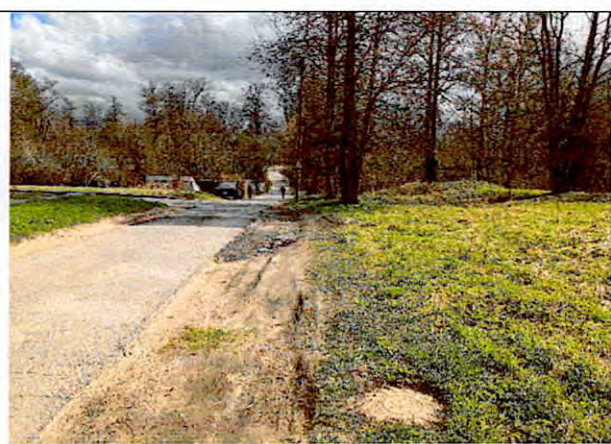
Фото 96. Павловск, ул. Правды. Трасса водовода
