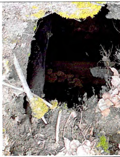
Фото 4. Колодец для обслуживания водовода на участке минной галереи. Внутри сохранились деревянные крепления
