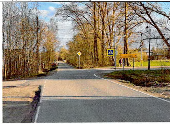
Фото 88. Пушкин, открытый канал по Садовой ул.
