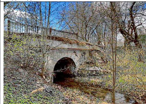
Фото 97. Павловск, ул. Правды. Водопроводный мост, северный фасад
