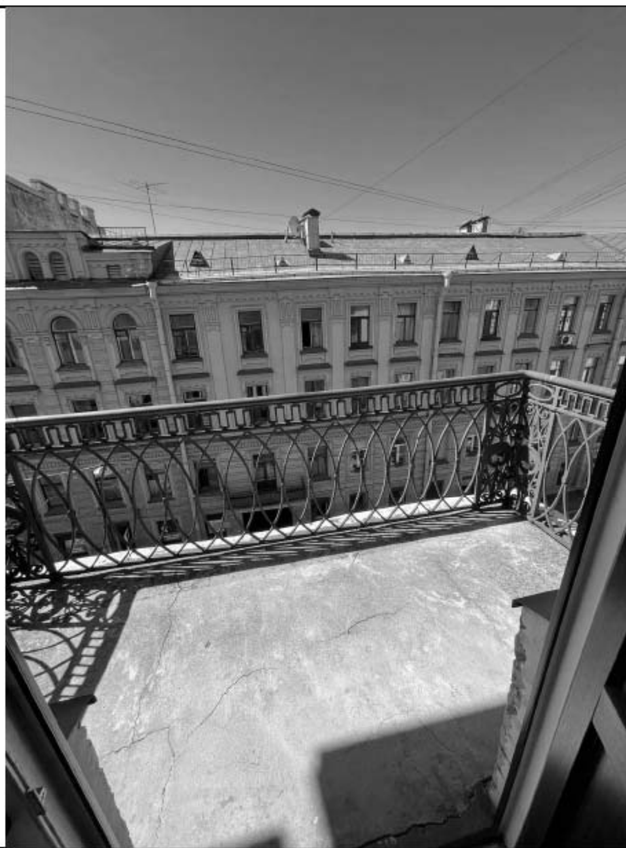
4. Общий вид балкона квартиры № 11.
