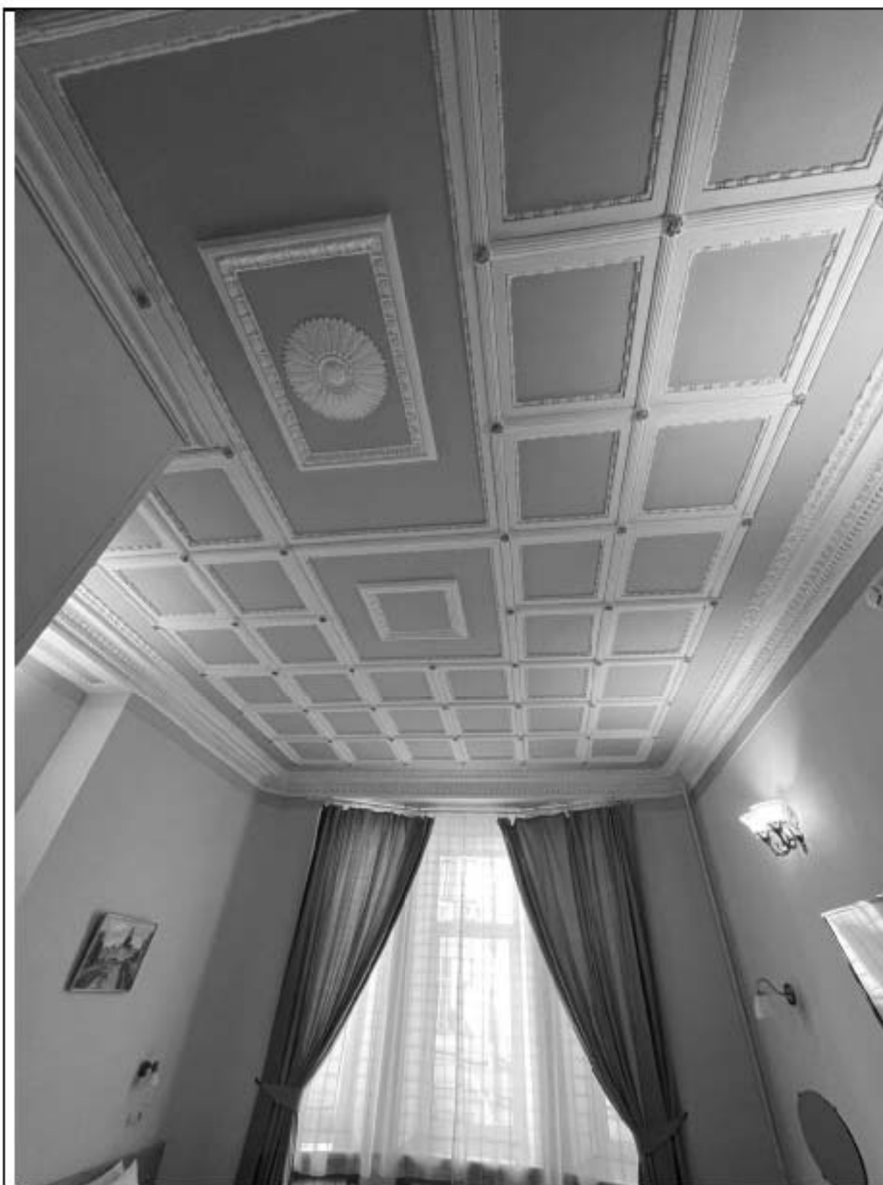
4. Общий вид интерьера помещения 8/30,4.
