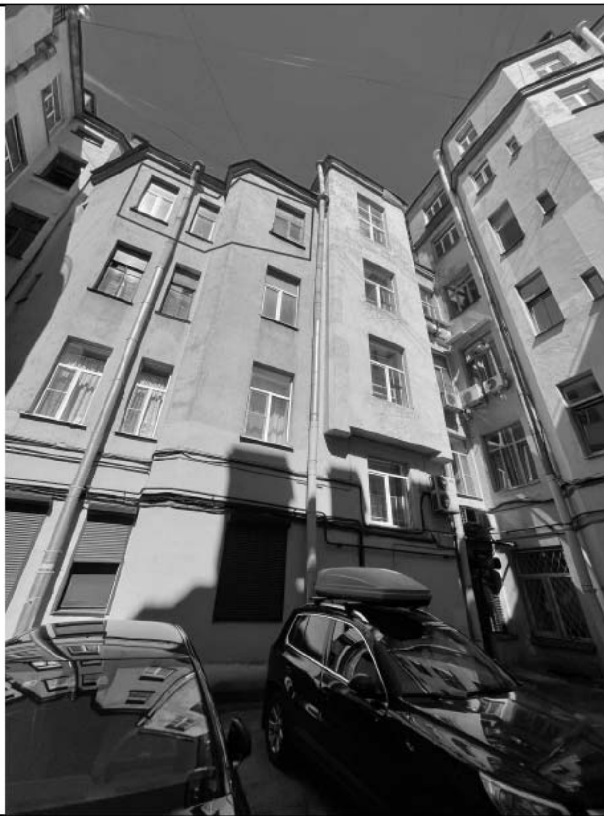
4. Общий вид дворового фасада.
