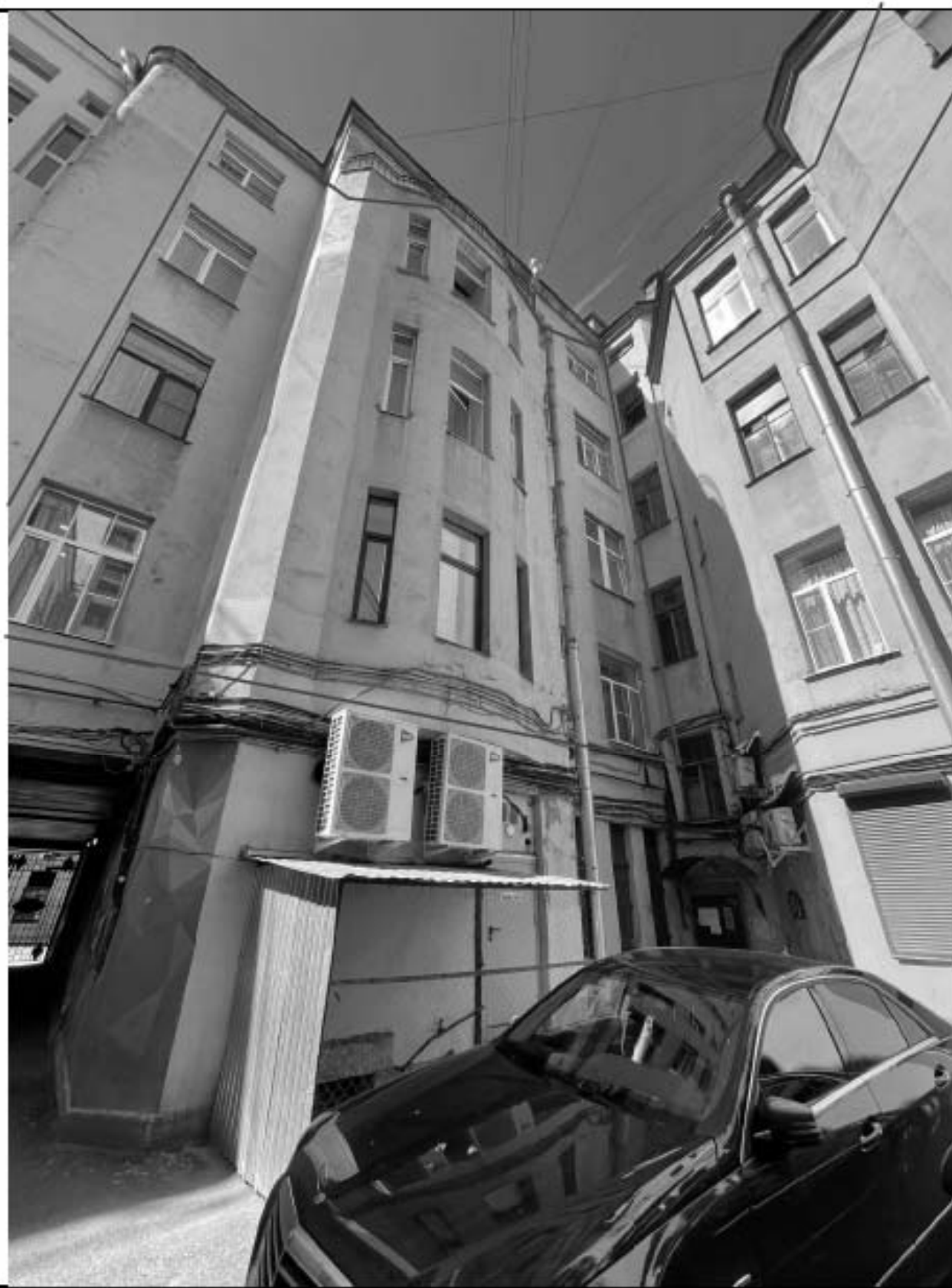
3. Общий вид дворового фасада.
