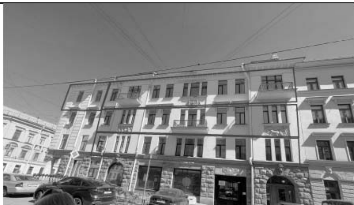
1. Общий вид лицевого фасада со стороны Столярного пер.
