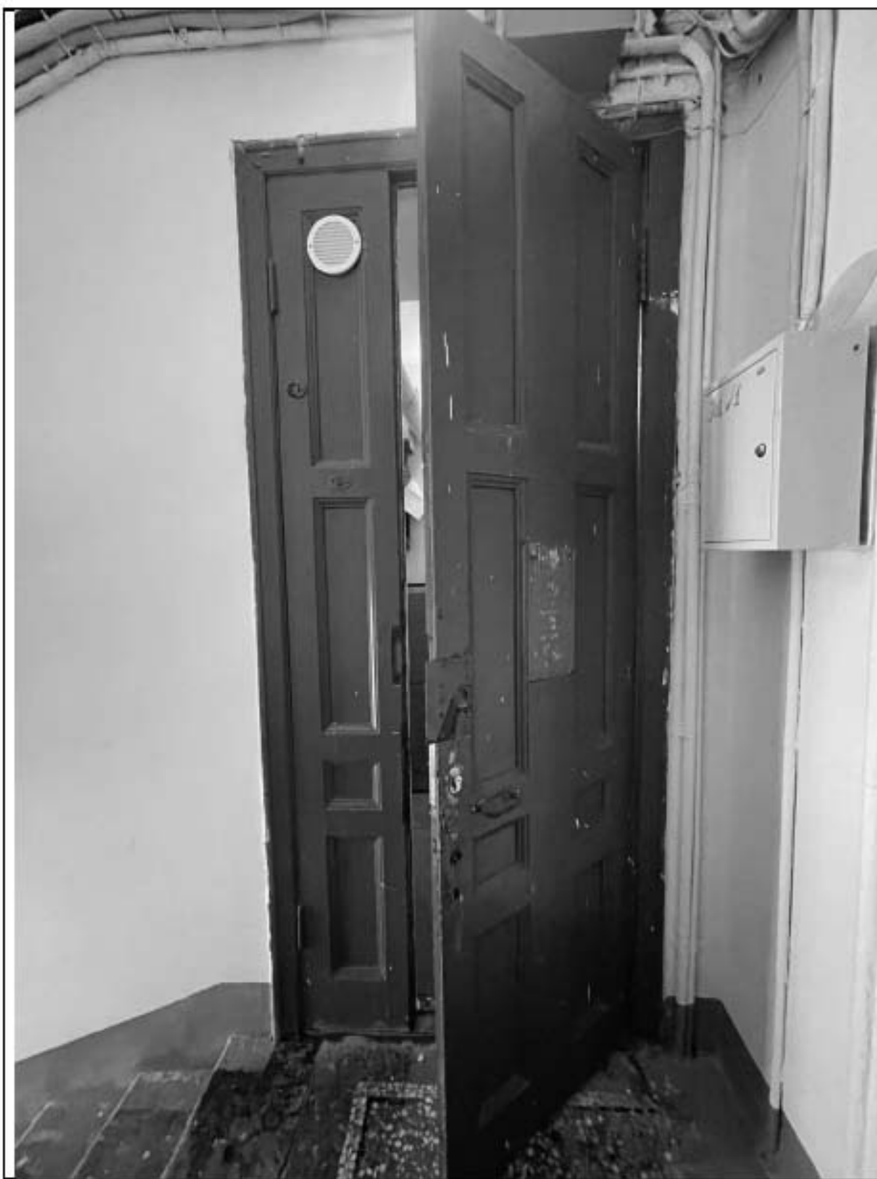
10. Входная дверь в квартиру № 9 со стороны лестничной клетки.
