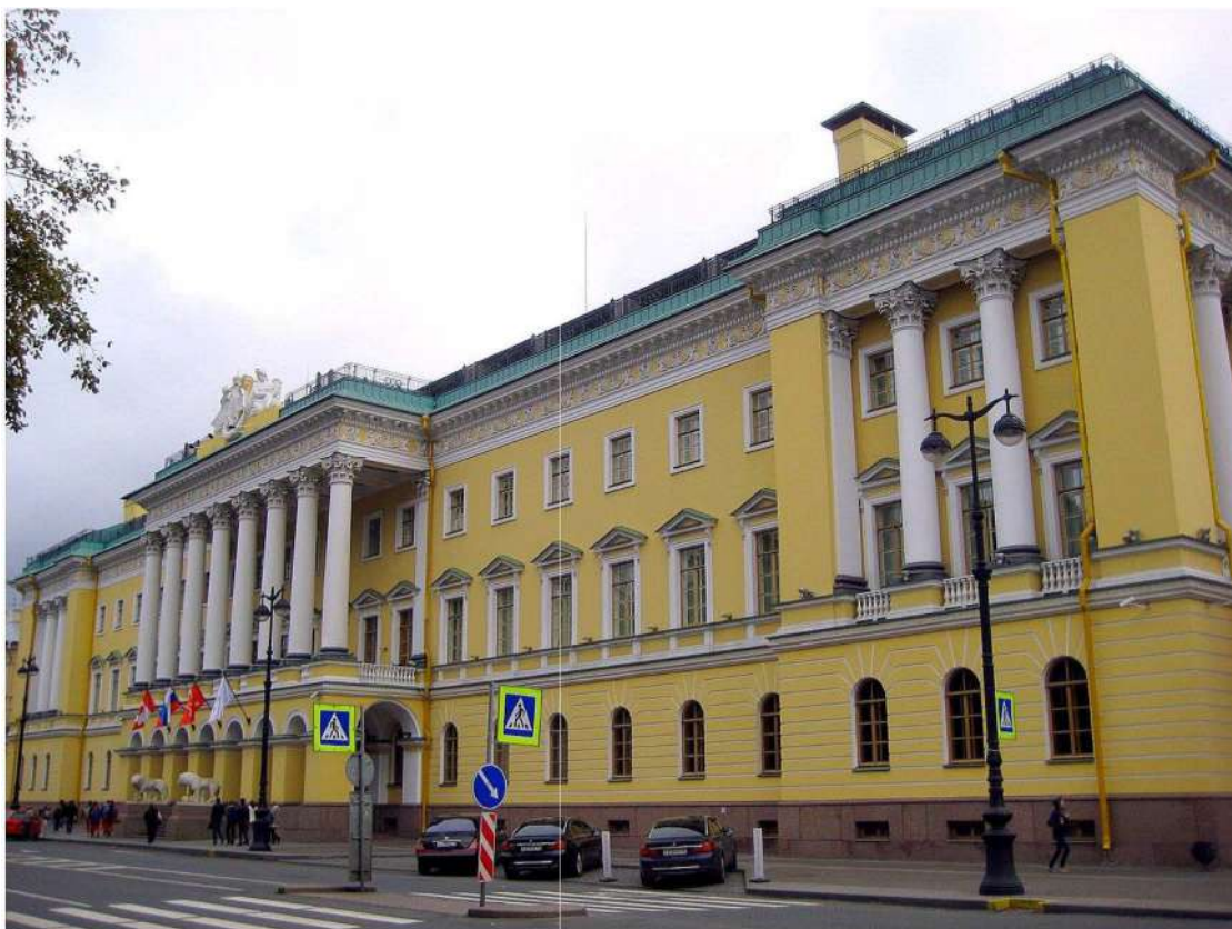
Рис. 26 — Фасад со стороны Адмиралтейского просп. после реконструкции. 2013 г.
