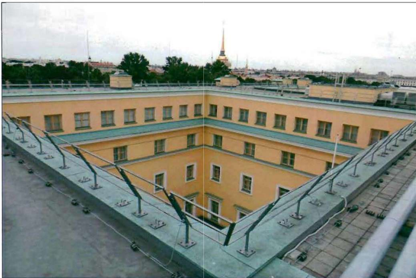
4. Общий вид внутреннего двора с кровли здания.
