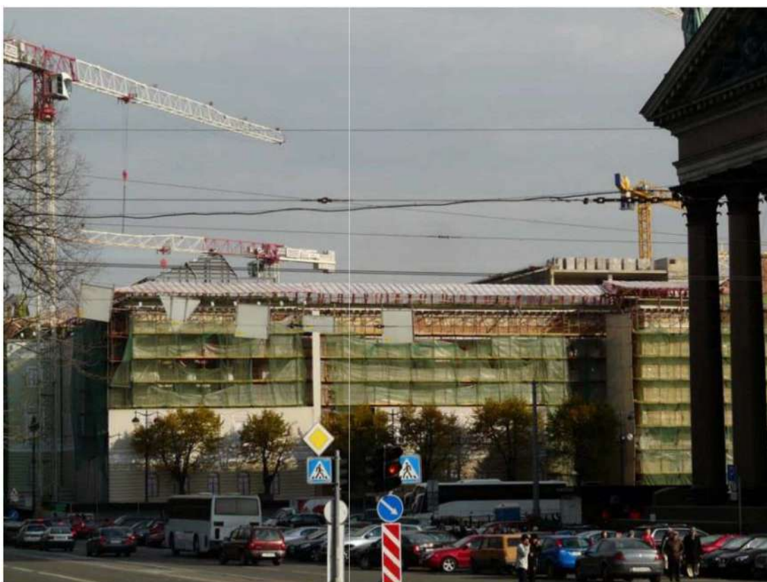
Рис. 25 — Возведение мансарды и нового флигеля на месте исторического флигеля А-4. 2008 г.
