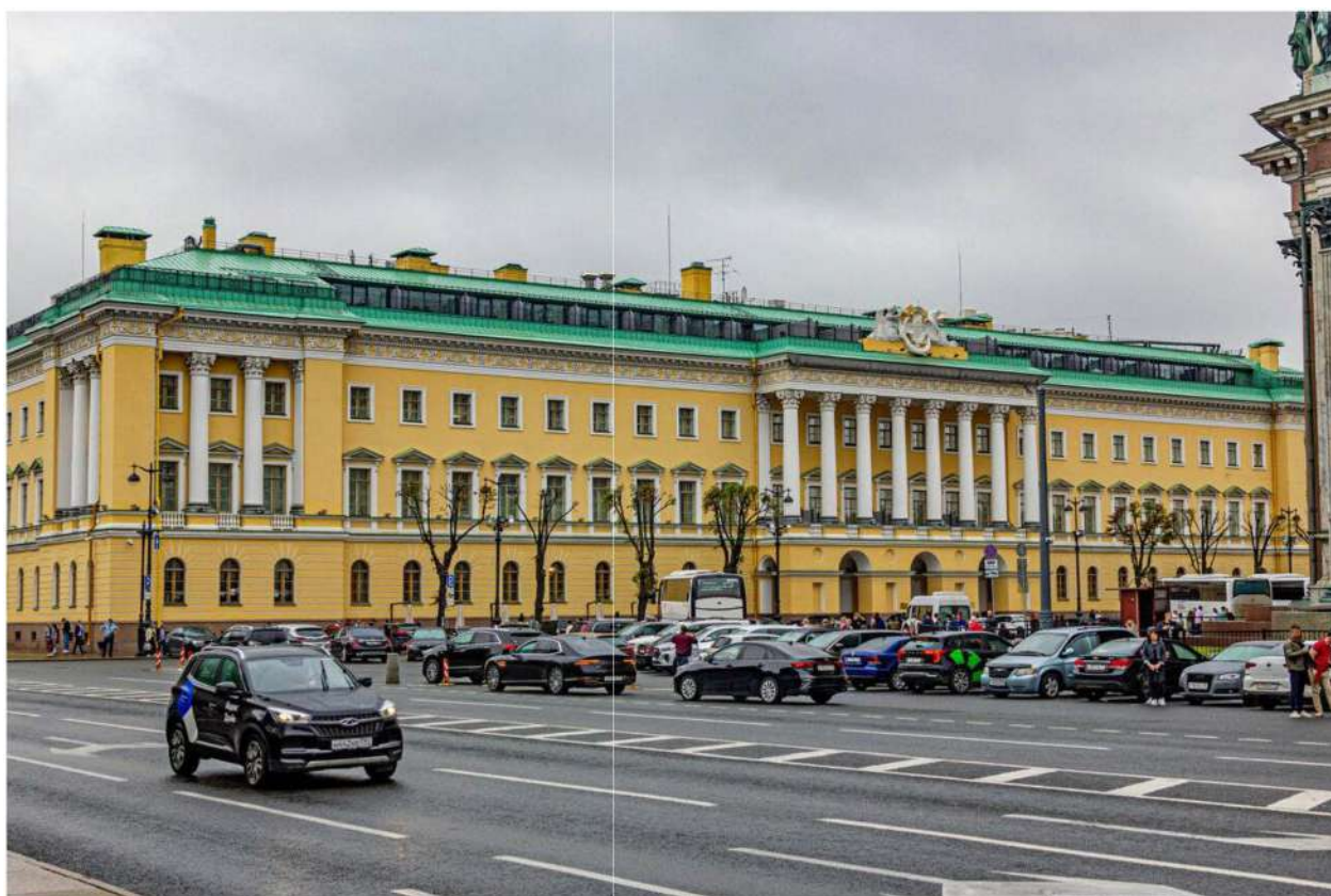
Рис. 27 — Фасад со стороны Исаакиевской пл. после реконструкции. 2024 г.
