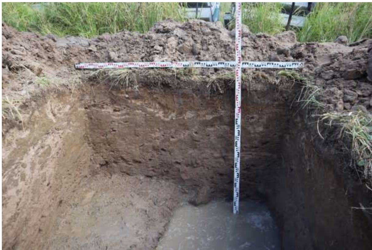
Рис. 25. СПБ-2026. Приморский район. Сооружения обеззараживания и доочистки сточных вод Северной станции аэрации, расположенной по адресу: Санкт-Петербург, Коннолахтинский пр., 12 Шурф 1. Восточная стенка. Вид с запада
