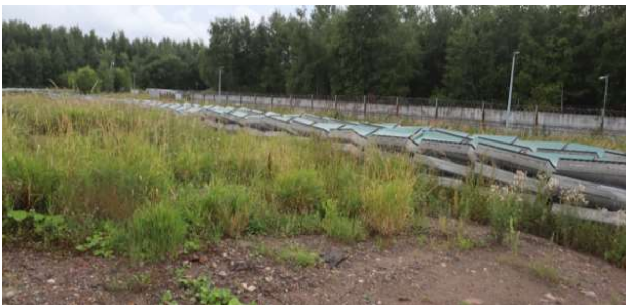
Рис. 15. СПб-2026. Приморский район. Сооружения обеззараживания и доочистки сточных вод Северной станции аэрации, расположенной по адресу: Санкт-Петербург, Коннолахтинский пр., 12 Общий вид участка обследования. Точка фотофиксации 4. Вид с северо-востока
