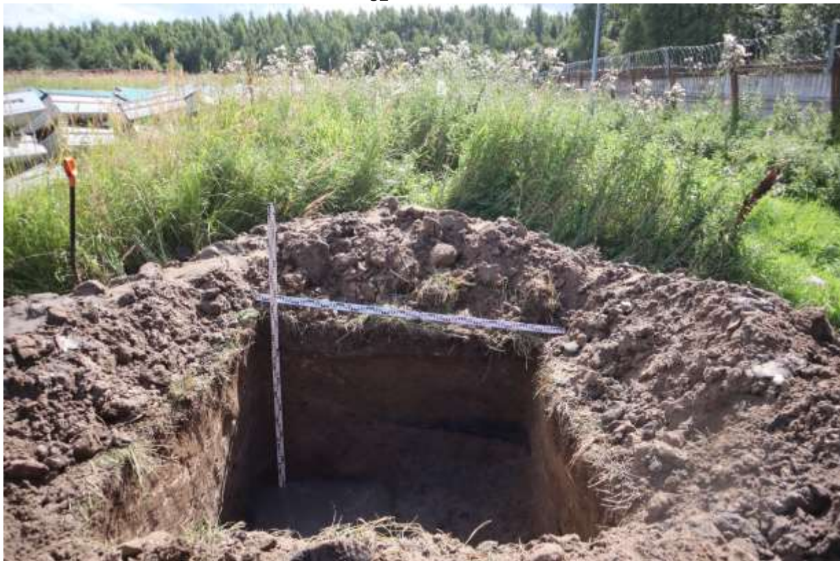
Рис. 20. СПб-2026. Приморский район. Сооружения обеззараживания и доочистки сточных вод Северной станции аэрации, расположенной по адресу: Санкт-Петербург, Коннолахтинский пр., 12. Шурф 1. Общий вид по окончанию работ. Вид с севера
