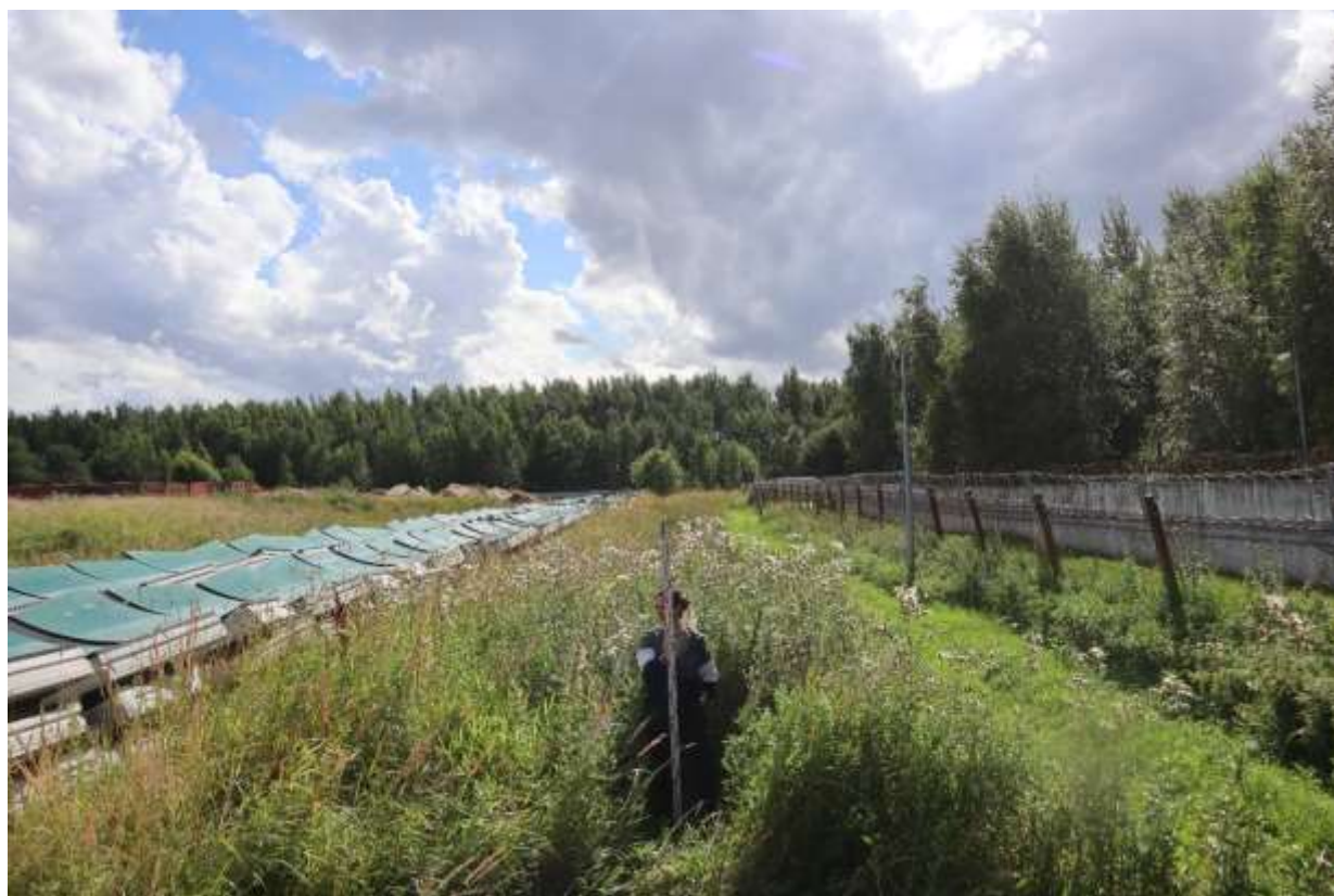
Рис. 19. СПб-2026. Приморский район. Сооружения обеззараживания и доочистки сточных вод Северной станции аэрации, расположенной по адресу: Санкт-Петербург, Коннолахтинский пр., 12. Шурф 1. Общий вид до начала работ. Вид с севера
