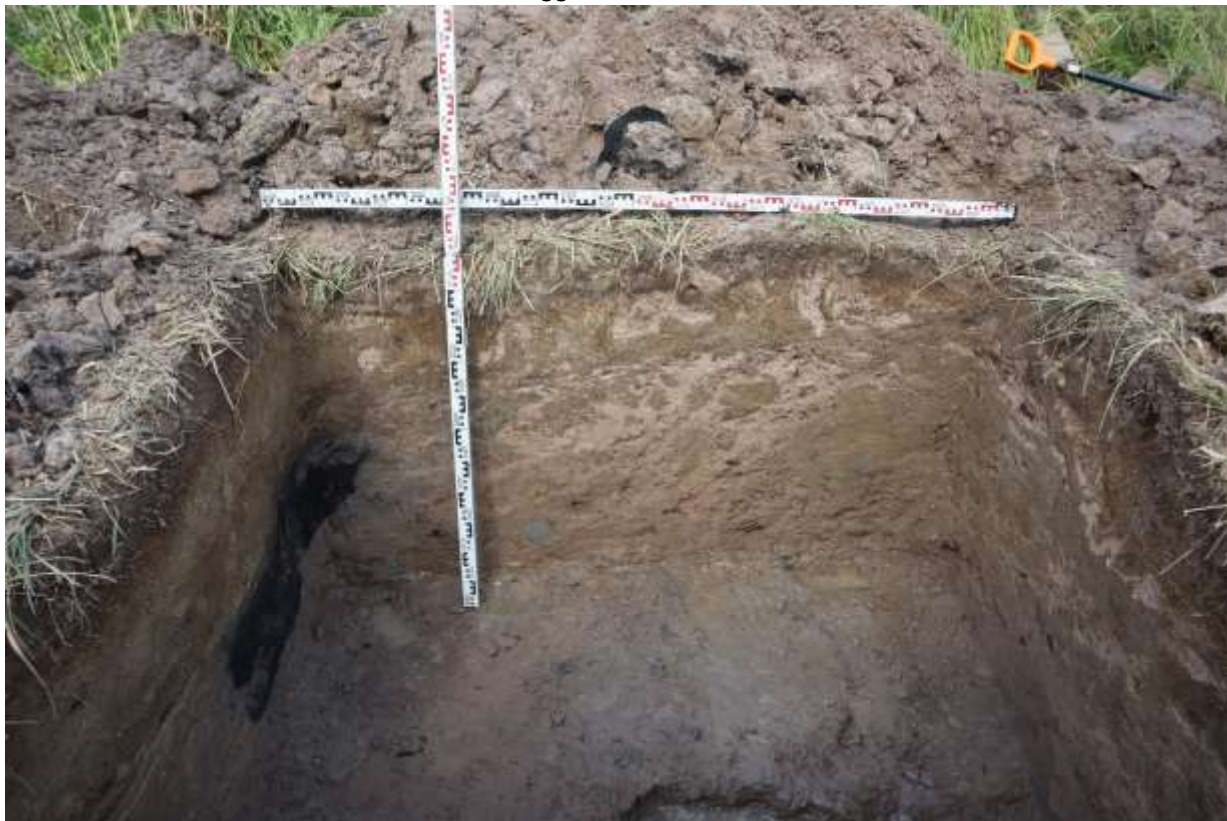
Рис. 24. СПБ-2026. Приморский район. Сооружения обеззараживания и доочистки сточных вод Северной станции аэрации, расположенной по адресу: Санкт-Петербург, Коннолахтинский пр., 12 Шурф 1. Северная стенка. Вид с юга
