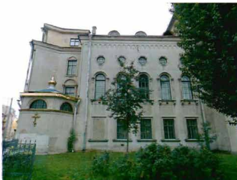
Фото 2. Часть западного фасада.
