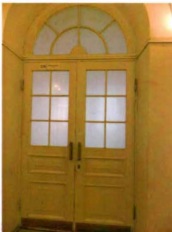
Фото 11. Двустворчатые двери с арочным завершением.
