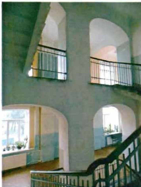
Фото 13. Парадная трехмаршевая лестница, пом. Н-1.
