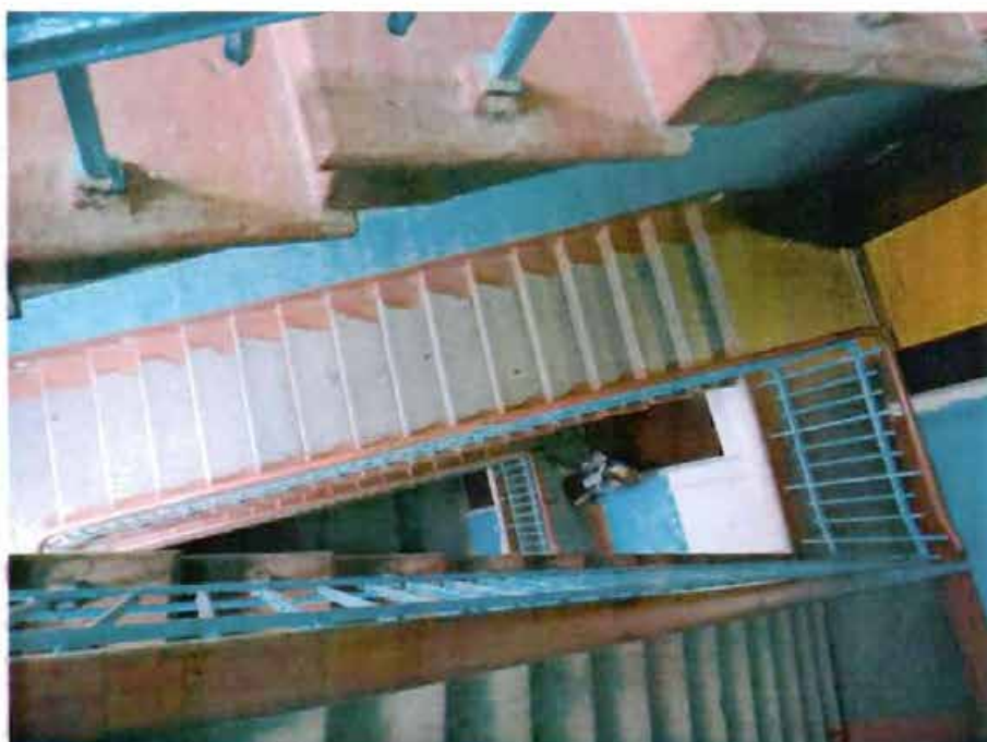
Фото 14. Лестница в южной части здания, пом. Н-2.
