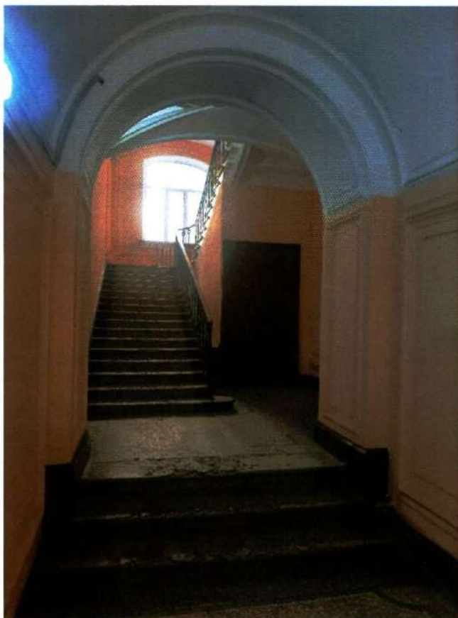
Фото 43. Лестничная клетка 4ЛК (дата съемки 27.03.2025).
