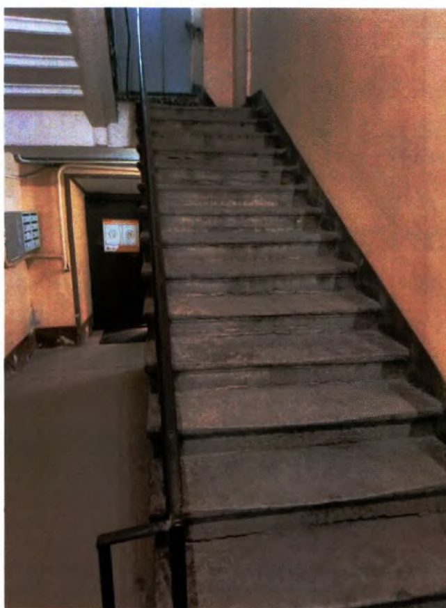
Фото 48. Лестничная клетка 15ЛК (дата съемки 27.03.2025).
