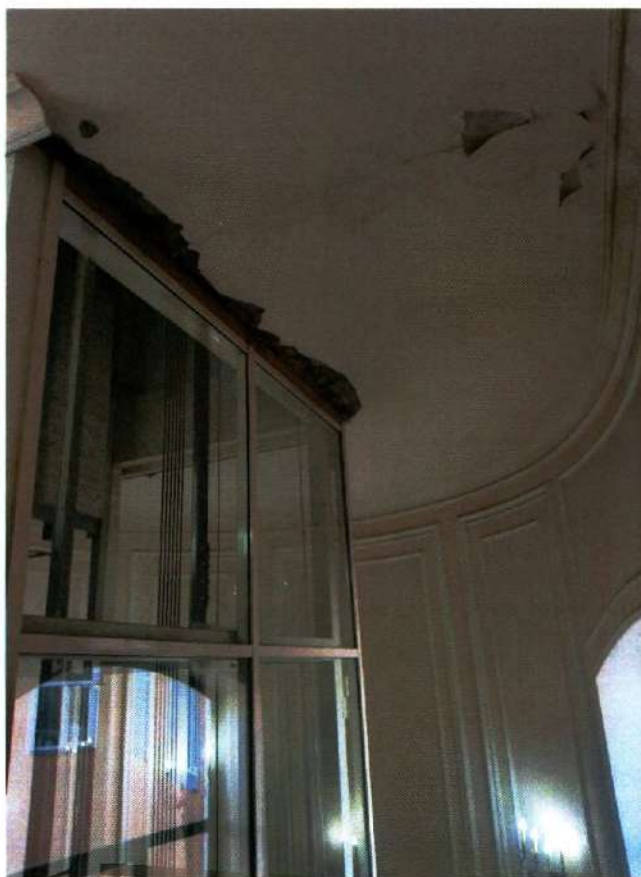
Фото 42. Лестничная клетка 3ЛК (дата съемки 27.03.2025).
