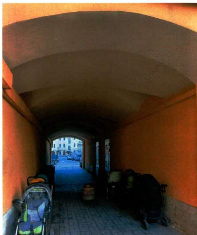
Фото 11. Юго-западный воротный проезд (дата съемки 27.03.2025).
