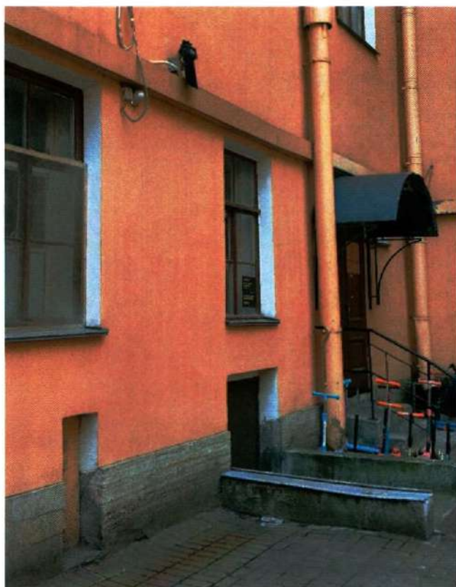
Фото 18. Фрагмент северного фасада западного внутреннего двора (дата съемки 27.03.2025).
