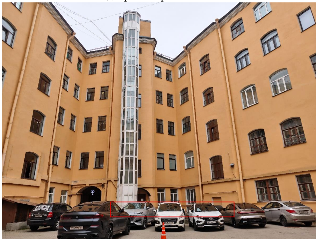
Фото 8. Вид на дворовые фасады западного внутреннего двора объекта культурного наследия регионального значения «Дом по 2-й Советской ул. с дворовым флигелем». Красным отмечены границы помещения 22-Н.
