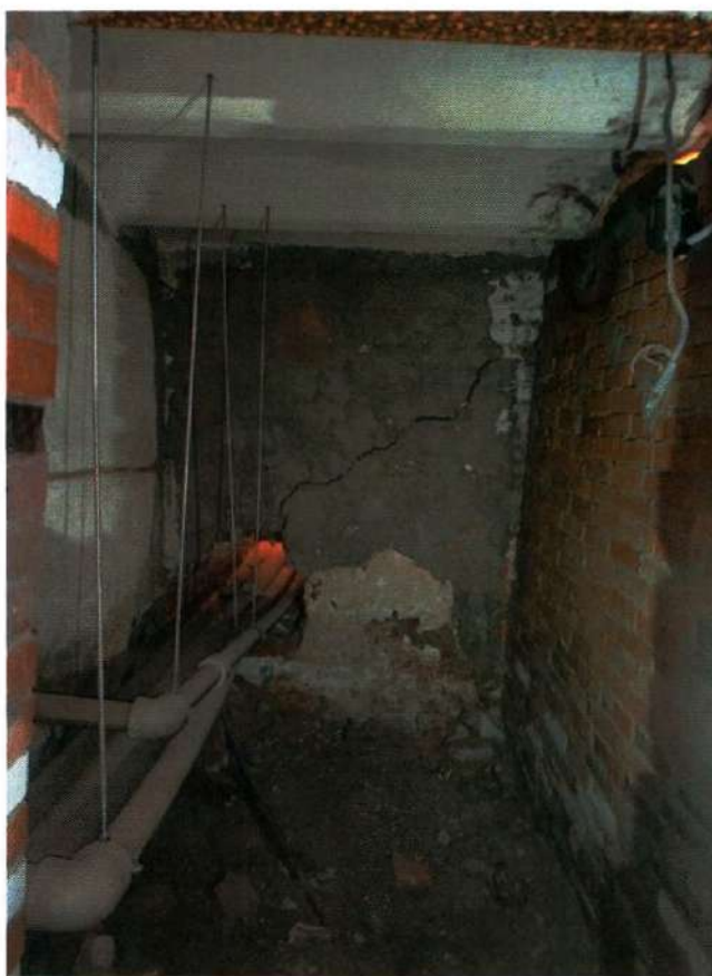
Фото 36. Общий вид помещения 32-Н (ч.п. 4) (дата съемки 27.03.2025).
