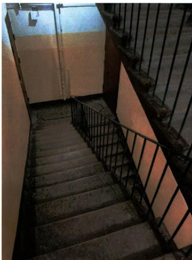
Фото 47. Лестничная клетка 14ЛК (дата съемки 27.03.2025).
