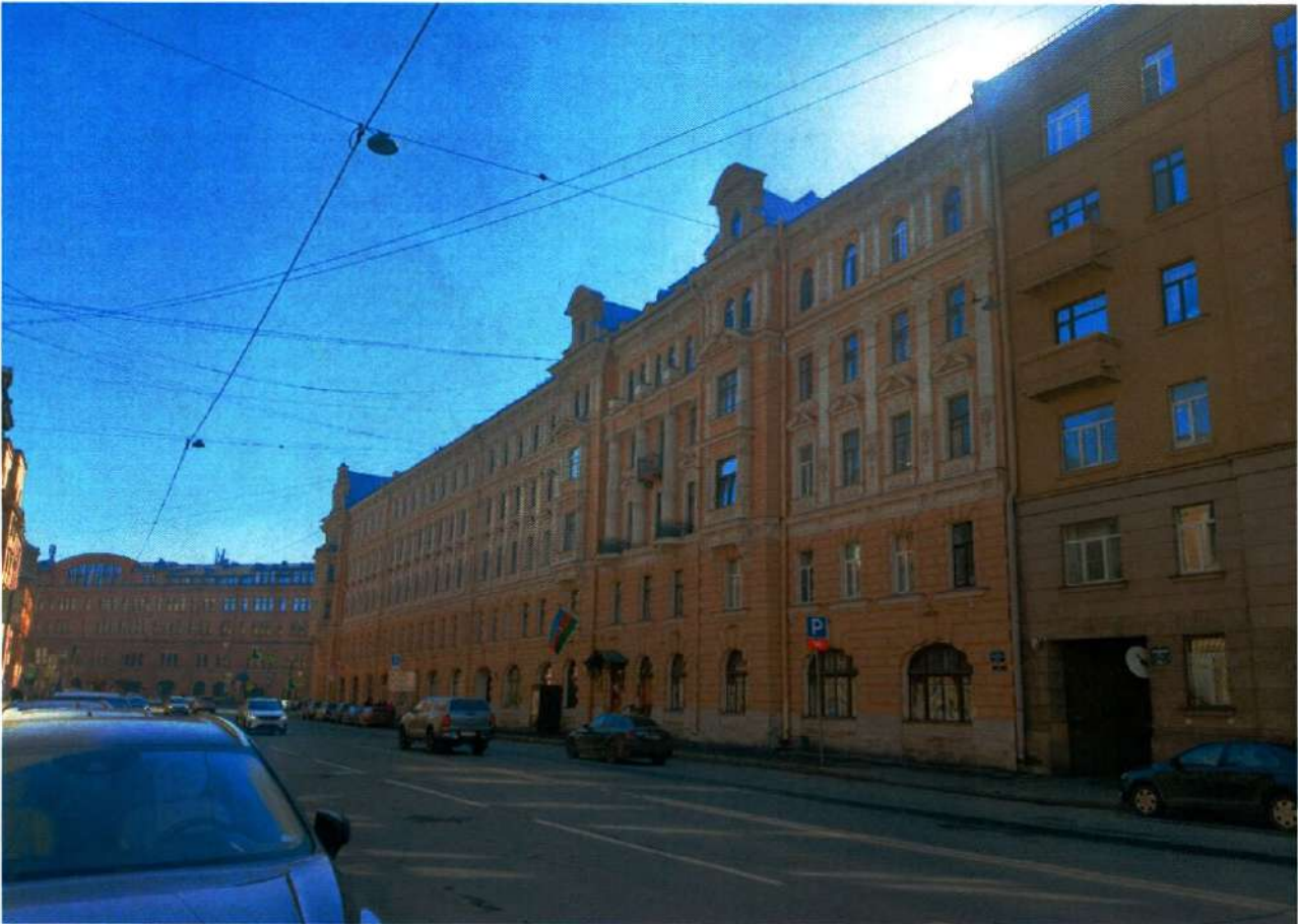
Фото 1. Северный лицевой фасад объекта культурного наследия (дата съемки 27.03.2025).
