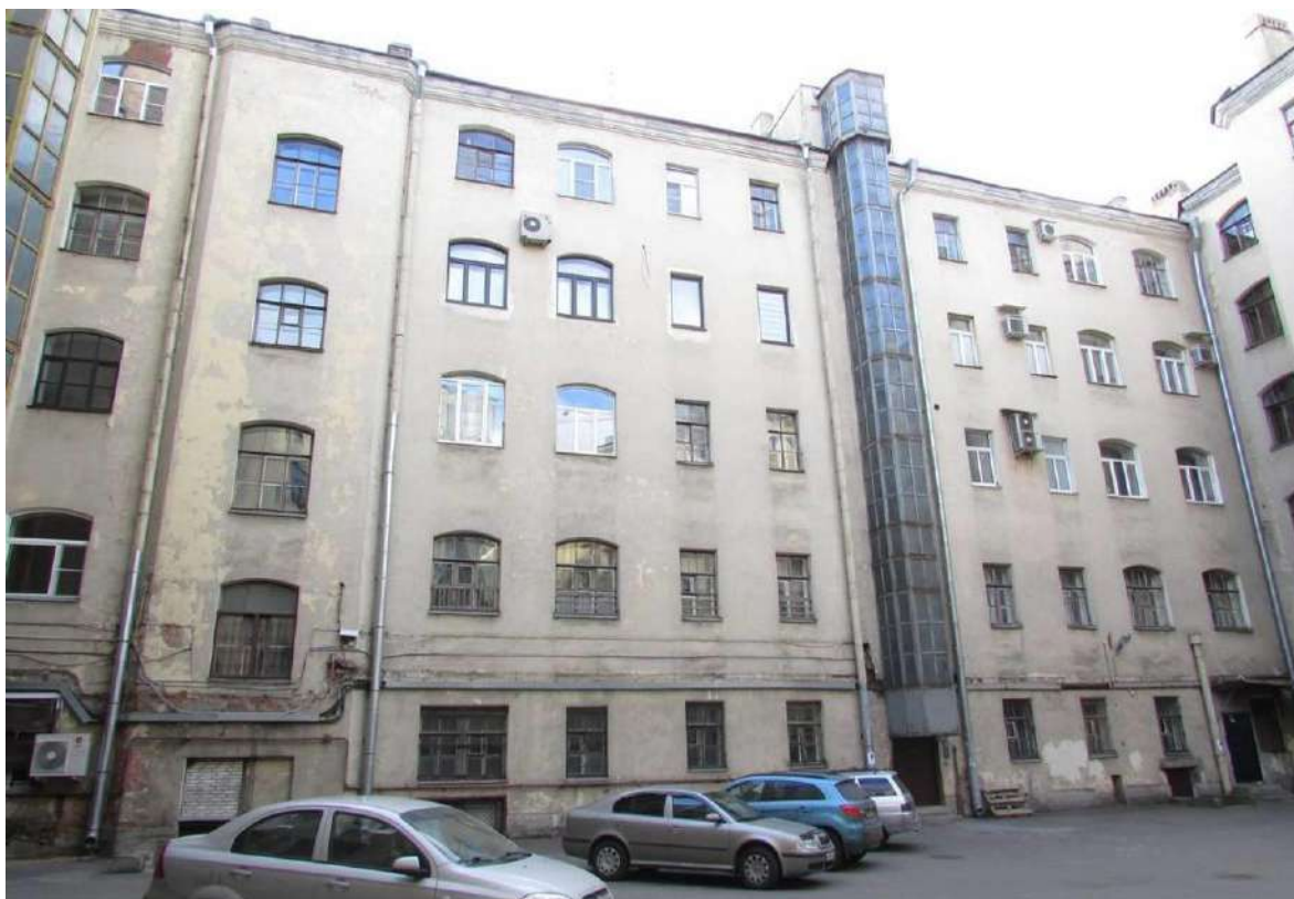
Илл. 60. 2-ая Советская ул., 27. Дворовый фасад. Фото 2015. (источник: http://www.citywalls.ru/house25786.html )
