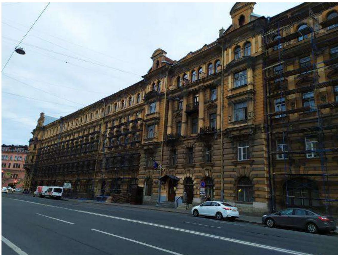
Илл. 62. Ремонт фасадов объекта культурного наследия «Дом Галунова И.В.». Фото 30.06.2019 г. (источник: http://www.citywalls.ru/house25774.html ).
