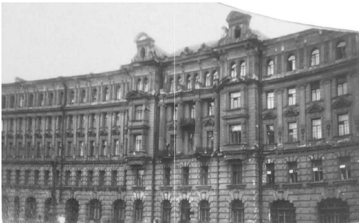
Илл. 52. Лицевой фасад д. 27 по 2-й Советской ул. 1960 г. (источник: ЦГАКФФД СПб. Фотодокументы. Опись 1ГР-50. Ед.хр.76481).
