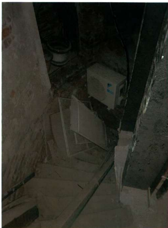
Фото 37. Общий вид помещения 34-Н (ч.п. 1) (дата съемки 27.03.2025).
