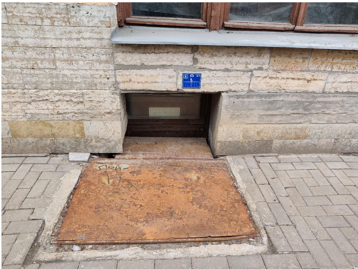
Фото 110. Вид на южный фасад объекта культурного наследия регионального значения «Дом по 2-й Советской ул. с дворовым флигелем». Вид на лаз (прямо́к) помещения 22-Н.
