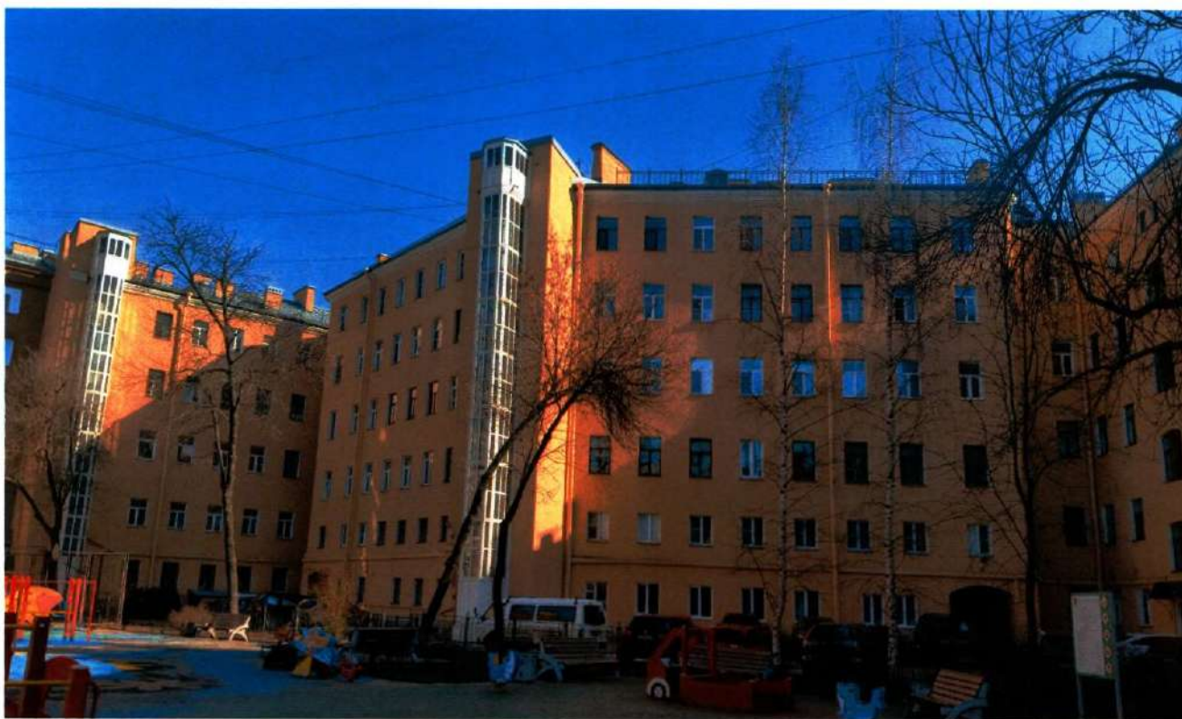
Фото 5. Вид на западный дворовой фасад объекта культурного наследия (дата съемки 27.03.2025).
