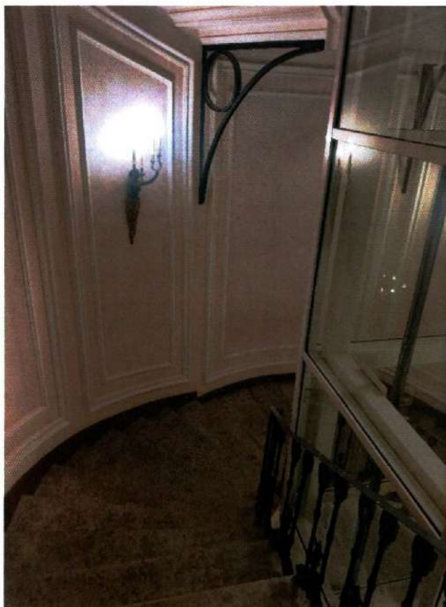
Фото 41. Лестничная клетка 3ЛК (дата съемки 27.03.2025).
