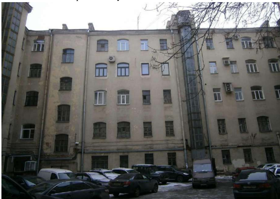
Илл. 59. 2-ая Советская ул., 27. Дворовый фасад. Фото 2011. (источник: http://www.citywalls.ru/house25774.html ).
