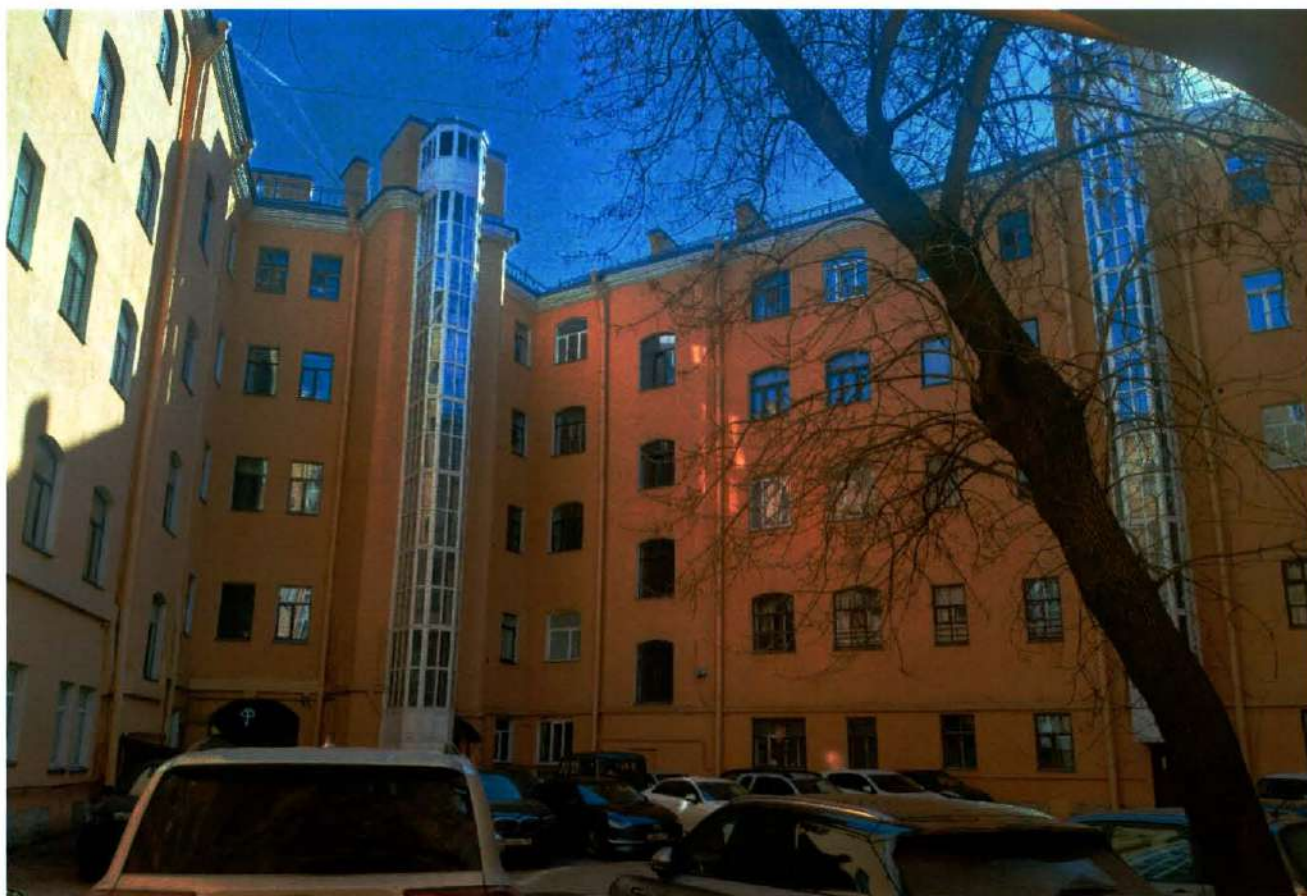
Фото 4. Вид на западный и северный фасады западного внутреннего двора объекта культурного наследия (дата съемки 27.03.2025).
