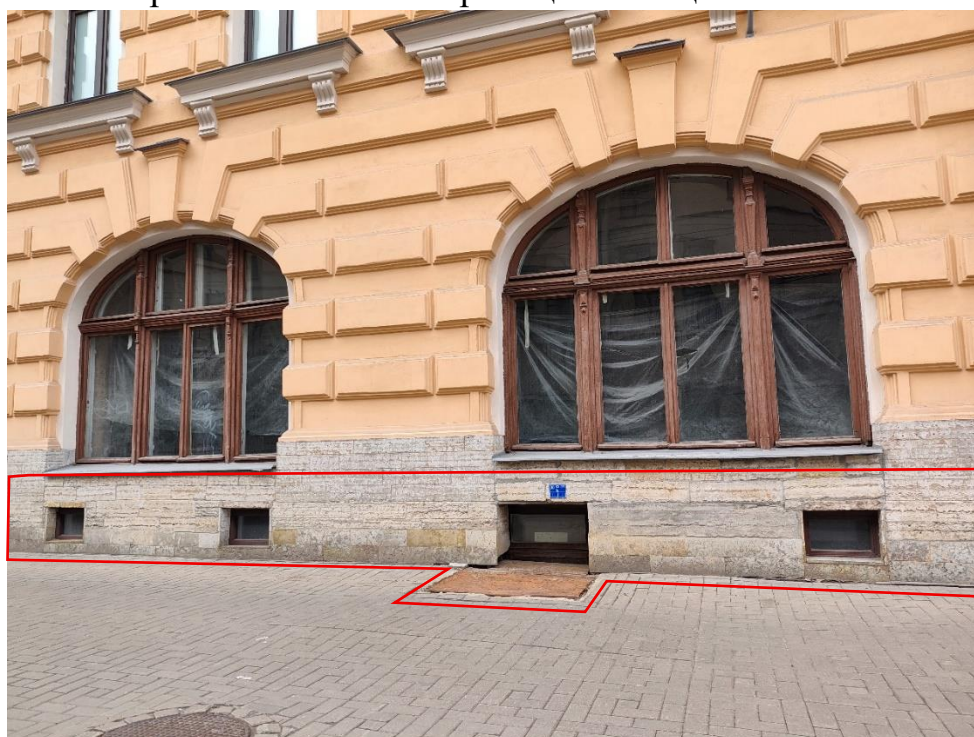
Фото 109. Вид на южный фасад объекта культурного наследия регионального значения «Дом по 2-й Советской ул. с дворовым флигелем». Вид на лаз (прямо́к) помещения 22-Н. Красным отмечены границы помещения 22-Н.
