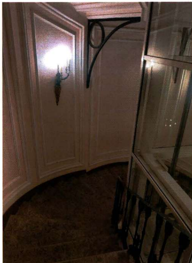
Фото 9. Лестничная клетка 3ЛК объекта культурного наследия (дата съемки 27.03.2025).
