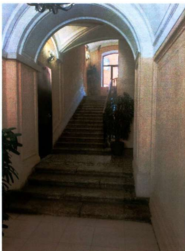
Фото 40. Лестничная клетка 2ЛК (дата съемки 27.03.2025).
