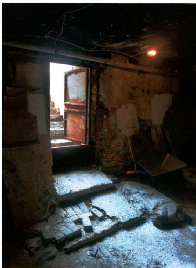
Фото 38. Общий вид помещения 40-Н (ч.п. 1) (дата съемки 27.03.2025).
