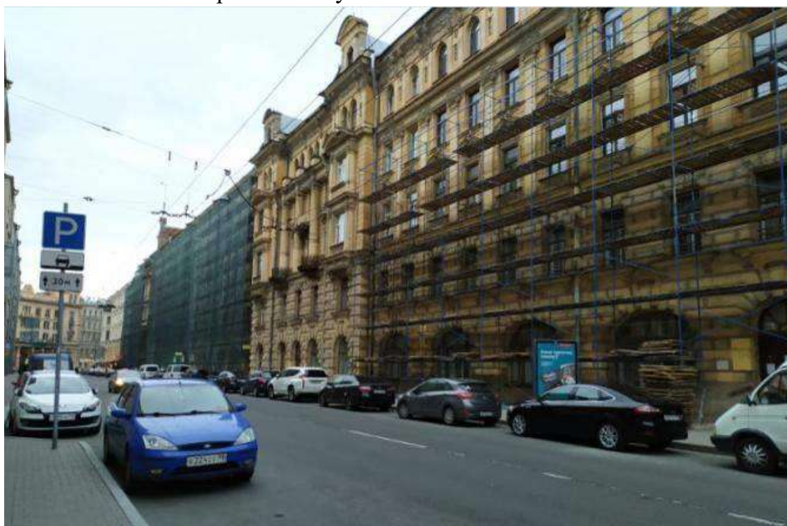
Илл. 61. Ремонт фасадов объекта культурного наследия «Дом Галунова И.В.». Фото 30.06.2019 г. (источник: http://www.citywalls.ru/house25774.html ).
