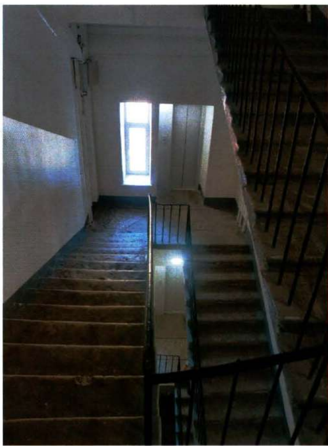
Фото 13. Лестничная клетка 13ЛК объекта культурного наследия (дата съемки 27.03.2025).
