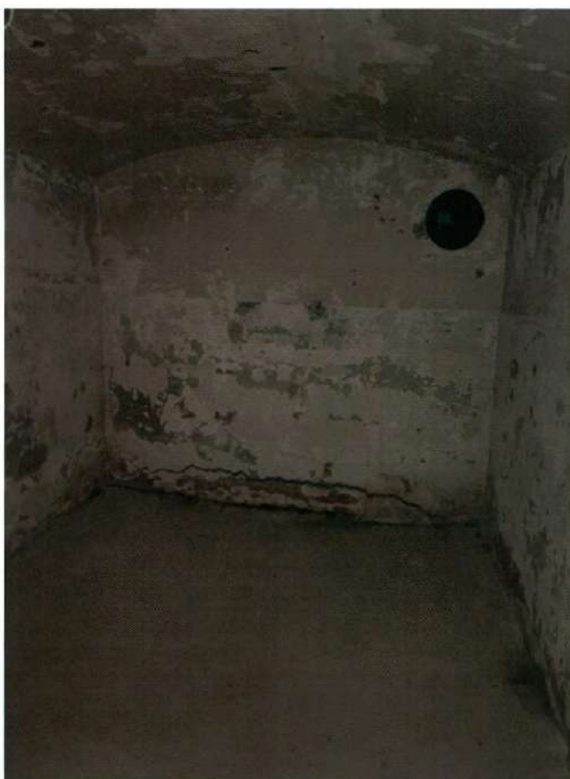
Фото 35. Общий вид помещения 32-Н (ч.п. 9) (дата съемки 27.03.2025).
