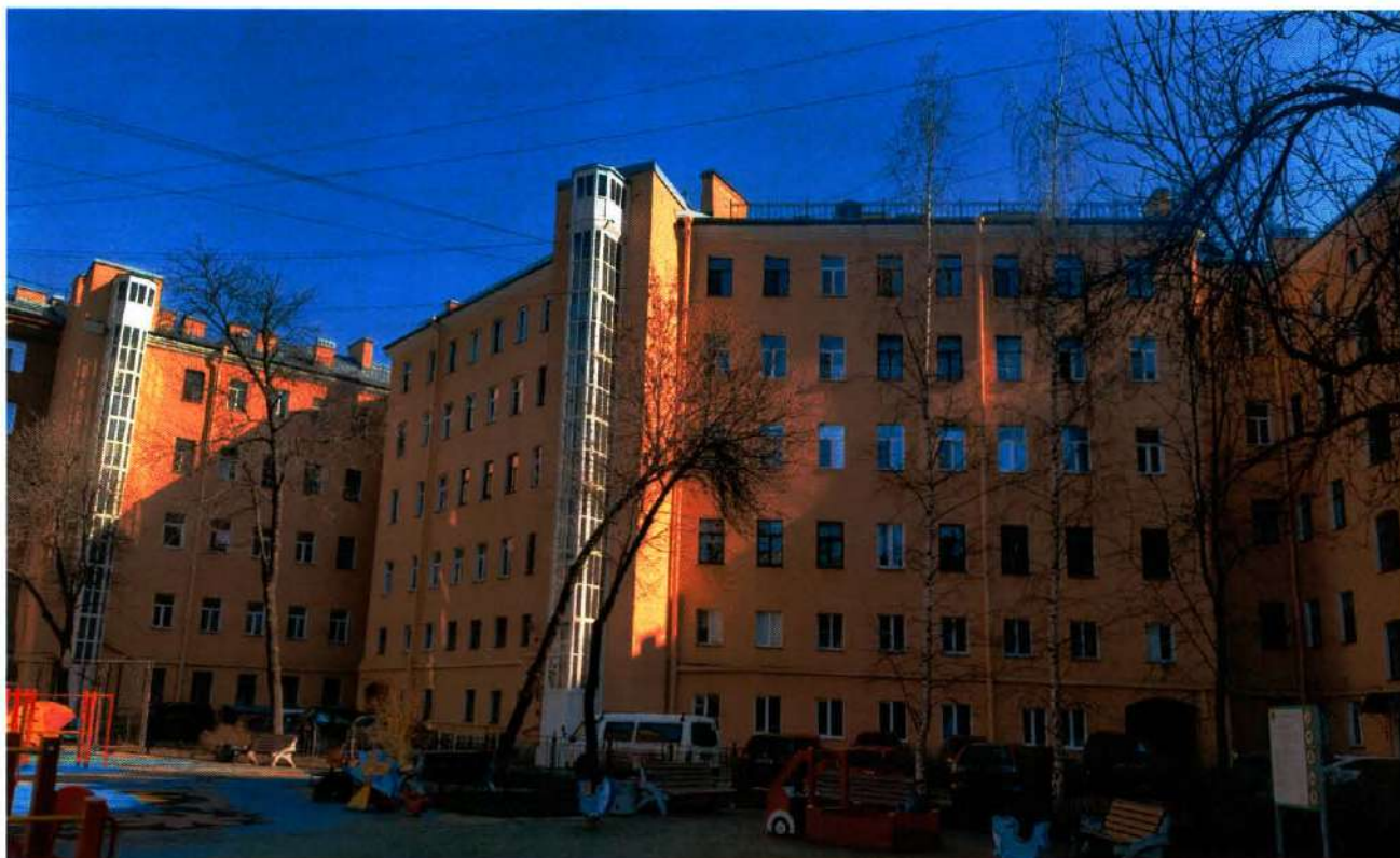
Фото 3. Вид на западный дворовой фасад объекта культурного наследия (дата съемки 27.03.2025).
