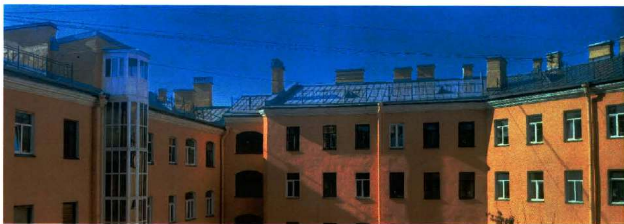
Фото 20. Вид на кровлю объекта культурного наследия (дата съемки 27.03.2025).
