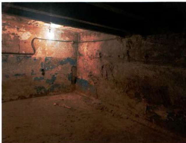
Фото 34. Общий вид помещения 32-Н (ч.п. 13) (дата съемки 27.03.2025).
