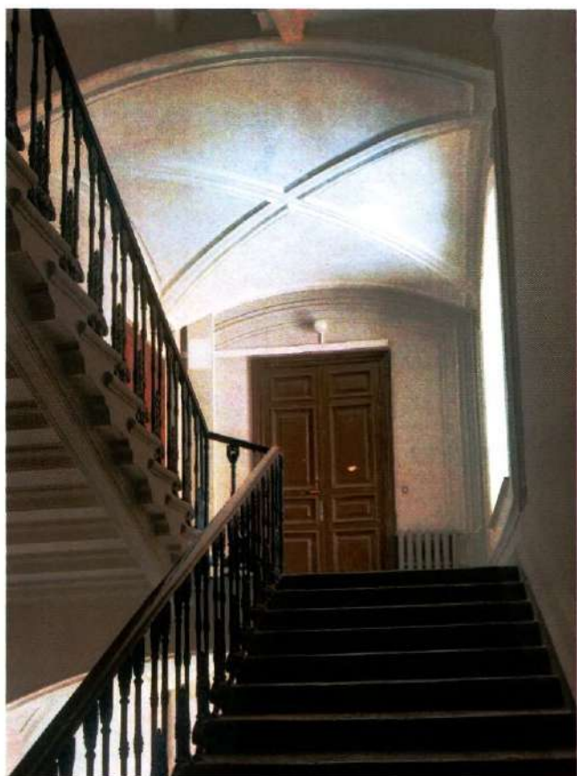
Фото 39. Лестничная клетка 1ЛК (дата съемки 23.05.2025).
