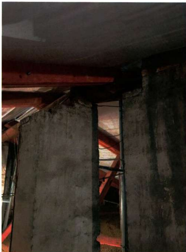
Фото 53. Конструкция крыши (дата съемки 27.03.2025).
