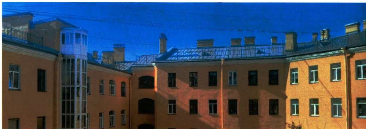
Фото 55. Вид на кровлю объекта культурного наследия (дата съемки 27.03.2025).
