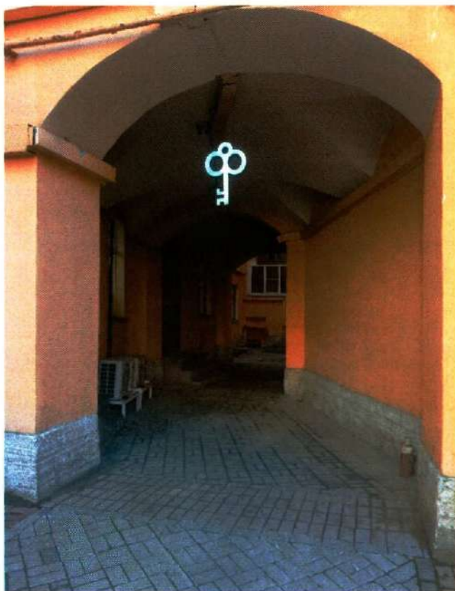
Фото 13. Восточный воротный проезд, соединяющий западный и восточный внутренние дворы (дата съемки 27.03.2025).
