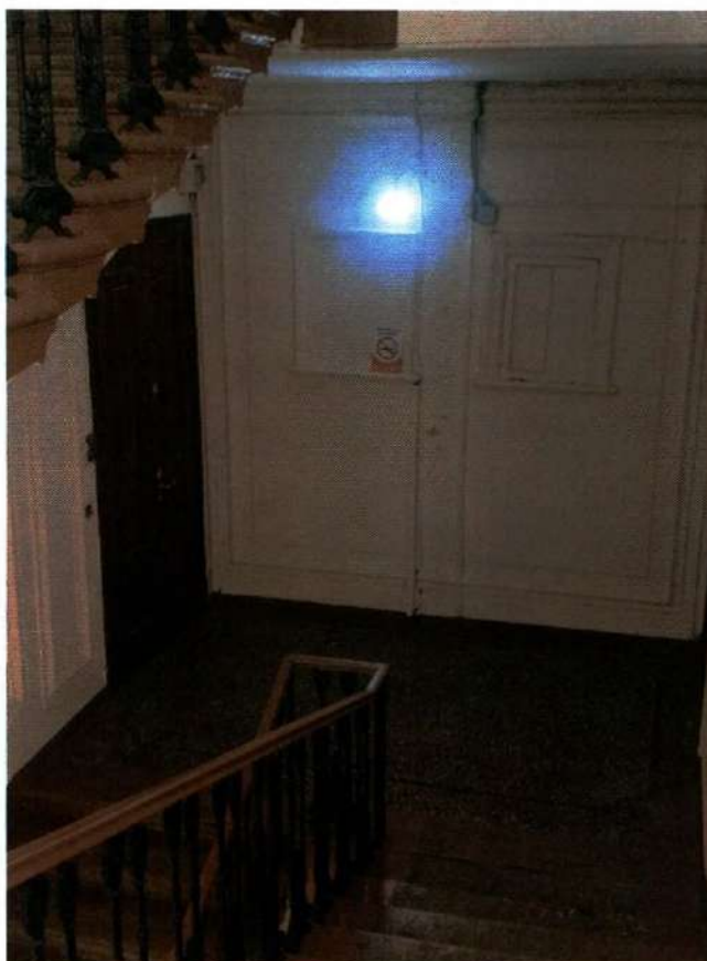
Фото 44. Лестничная клетка 5ЛК (дата съемки 23.05.2025).
