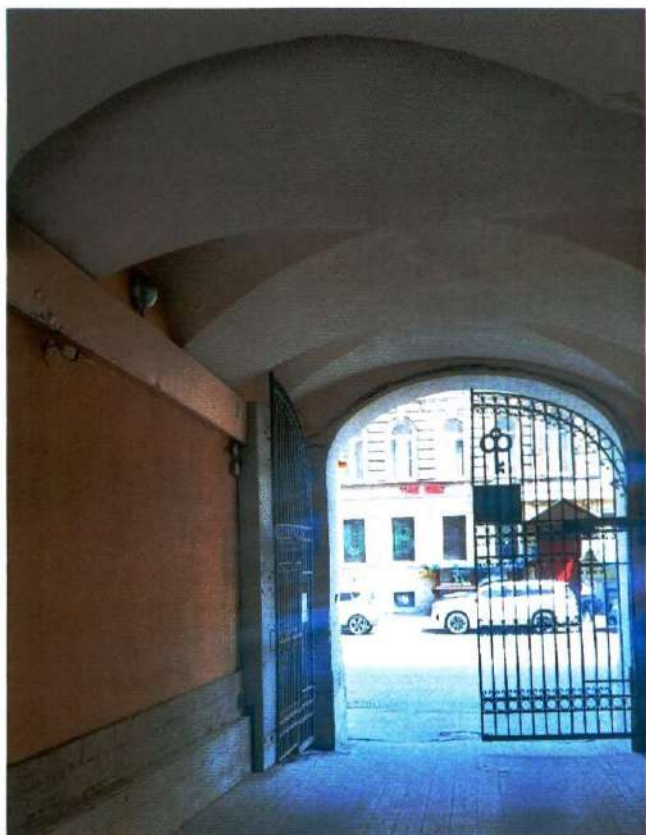
Фото 12. Северный воротный проезд, ведущий в западный внутренний двор (дата съемки 27.03.2025).
