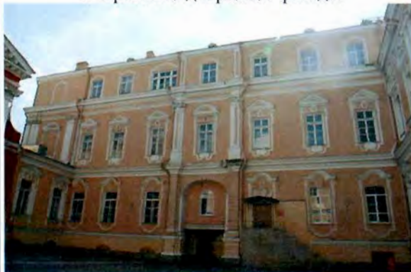
4. Фрагмент дворового фасада.
