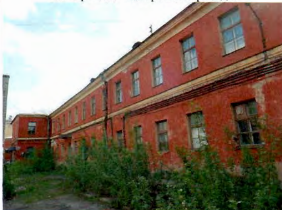
32. Фрагмент дворового фасада.
