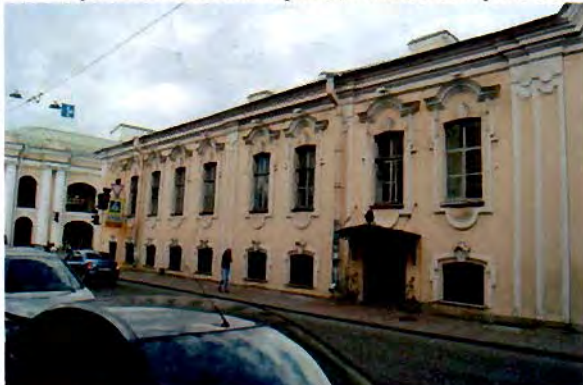
34. Фрагмент лицевого фасада западного флигеля.
