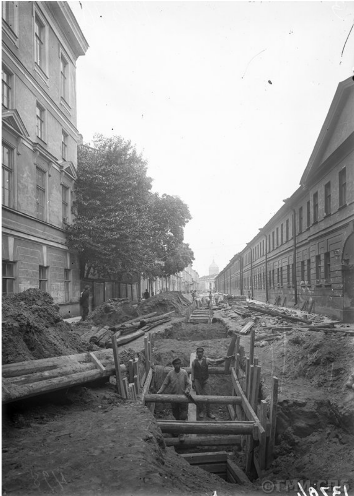
Илл. 25. Сооружение канализации. Траншейные работы на Чернышевском переулке (улице Ломоносова). 1920-1929 гг. Retro View of Mankind's Habitat [Электронный ресурс] URL: https://pastvu.com/p/1441632
