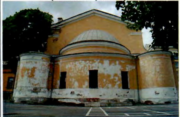
16. Фрагмент дворового фасада.
