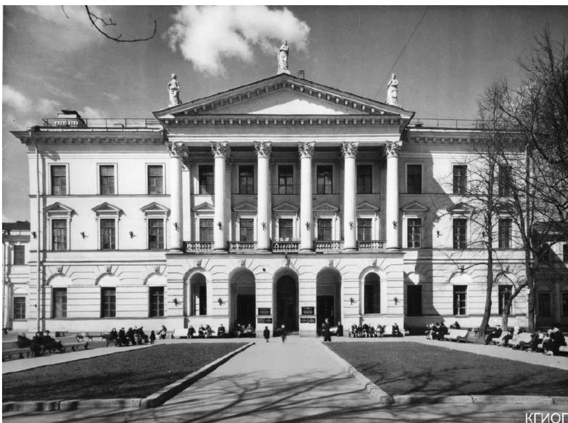
Илл.1.4.12. Главный фасад. Ленинградский финансово-экономический институт (здание Ассигнационного банка). Григорьев А.А. 1953 // из архива КГИОП.
