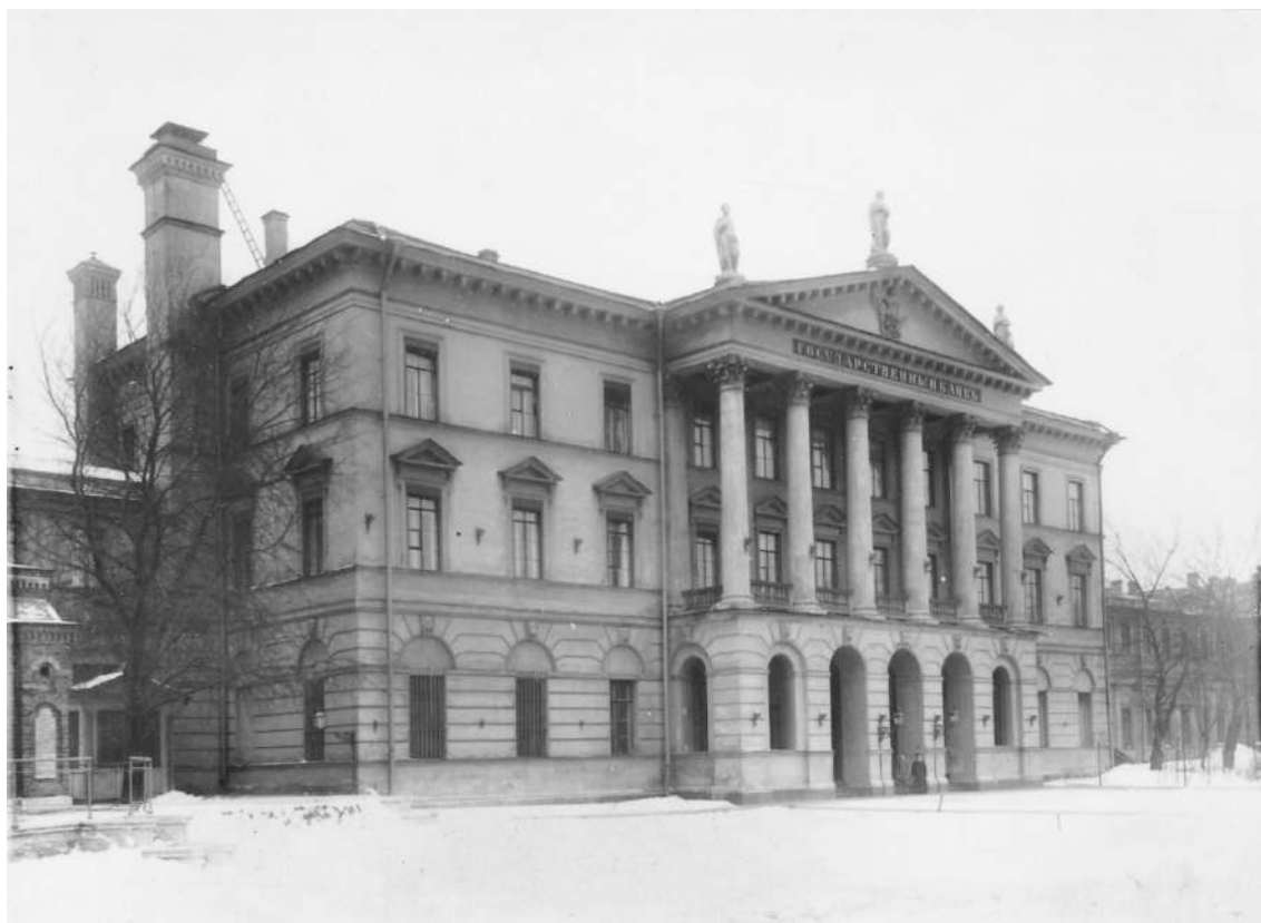
Илл. 1.4.5. Правая часть центрального фасада здания Государственного банка со стороны Садовой улицы. 1903 г. ЦГАКФД СПб. Фотодокументы. Оп.1Е-17. Ед.хр.14738.
