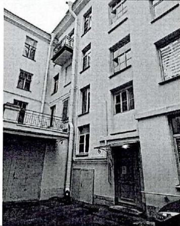
Фрагмент дворового фасада
