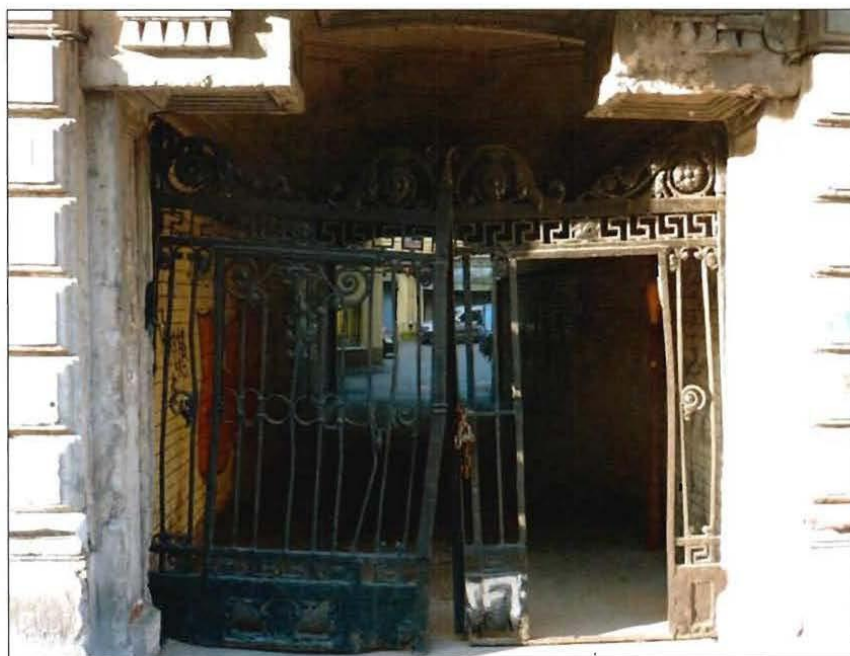
2. Металлические ворота со стороны лицевого фасада.
