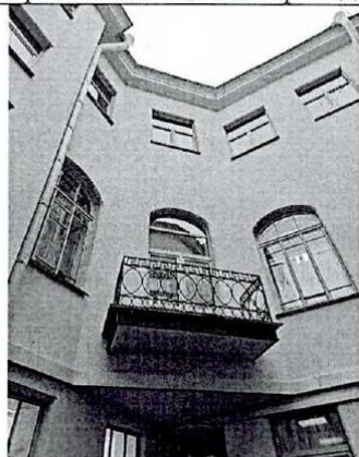
Фрагмент дворового фасада
