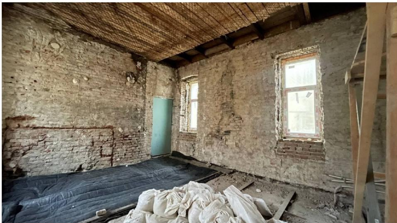
Илл. 34. Объект культурного наследия регионального значения «Особняк Л.Н. Симонova (Столыпиных)», расположенный по адресу: Санкт-Петербург, Гагаринская ул., 5, лит. А. Вид на стену по оси Г и 5 с демонтированными перегородками и отделочными слоями.
