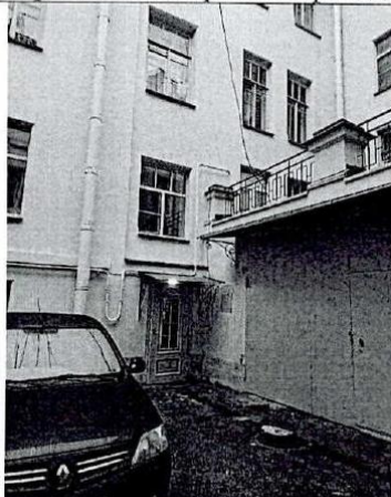
Фрагмент дворового фасада
