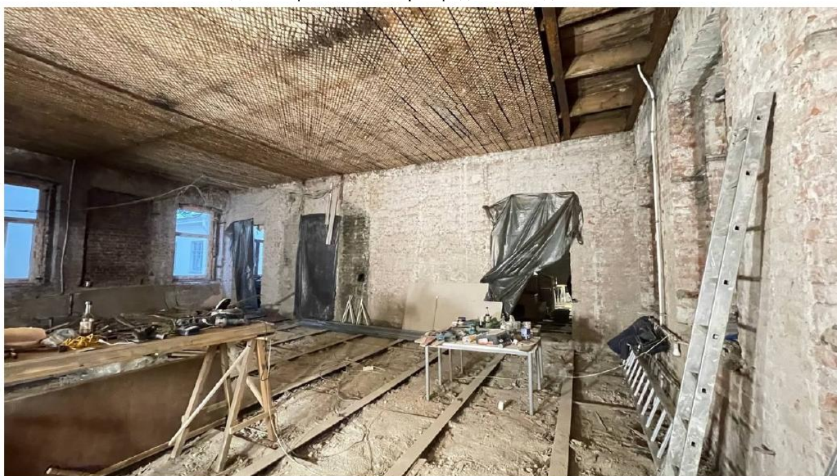
Илл. 27. Объект культурного наследия регионального значения «Особняк Л.Н. Симонова (Столыпиных)», расположенный по адресу: Санкт-Петербург, Гагаринская ул., 5, лит. А. Общий вид помещения в осях 1-3/А-В с демонтированными перегородками и отделочными слоями.
