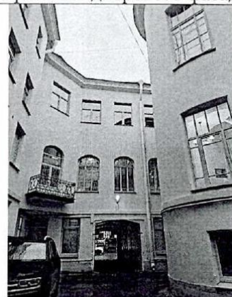
Фрагмент дворового фасада
