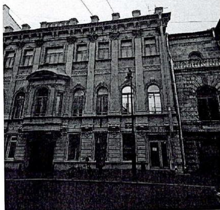
Фрагмент лицевого фасада
