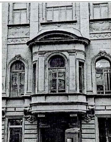
Фрагмент лицевого фасада
