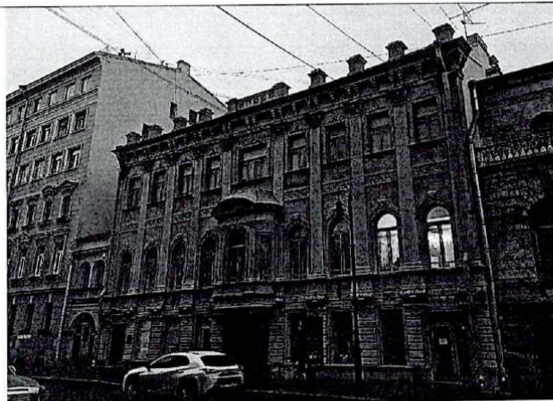
Общий вид лицевого фасада
