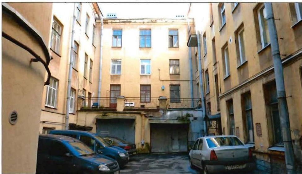
3. Дворовые фасады. Вид с востока.
