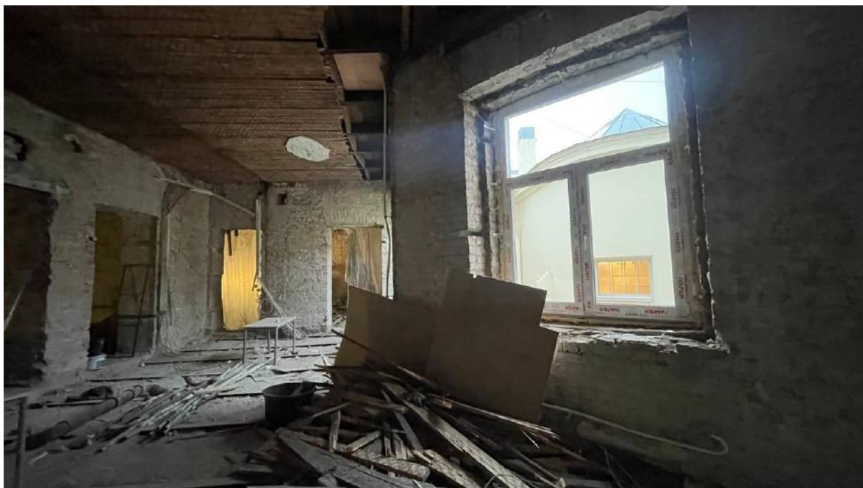
Илл. 32. Объект культурного наследия регионального значения «Особняк Л.Н. Симонова (Столыпиных)», расположенный по адресу: Санкт-Петербург, Гагаринская ул., 5, лит. А. Общий вид помещения в осях Б-В/4-5 с демонтированными перегородками и отделочными слоями.
