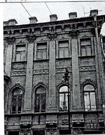
Фрагмент лицевого фасада
