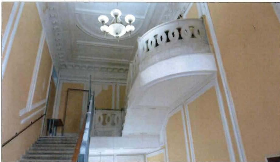
9. Верхняя площадка парадной лестницы (1 Л).
