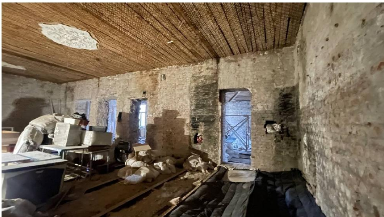
Илл. 30. Объект культурного наследия регионального значения «Особняк Л.Н. Симонова (Столыпиных)», расположенный по адресу: Санкт-Петербург, Гагаринская ул., 5, лит. А. Общий вид помещения в осях 3-5/А-Б с демонтированными перегородками и отделочными слоями.
