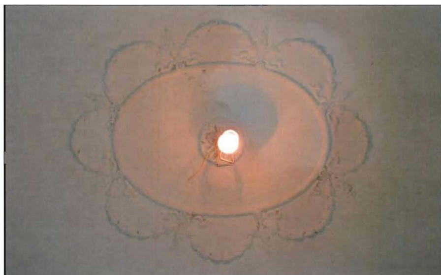
34. Лепная потолочная розетка (квартира № 23).
