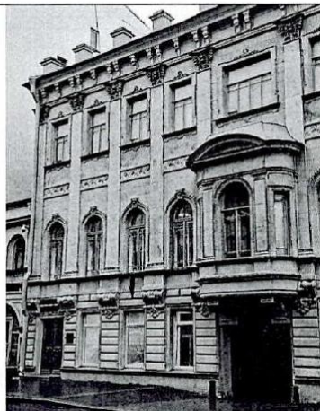
Фрагмент дворового фасада
