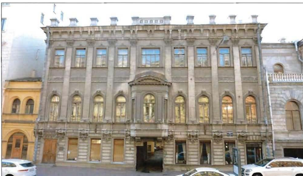
1. Восточный лицевой фасад.
