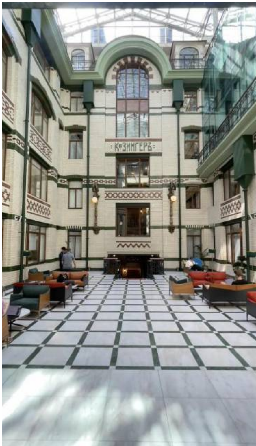
Фото. 5. Объект культурного наследия федерального значения «Дом компании «Зингер», расположенный по адресу: г. Санкт-Петербург, Невский просп., 28, канала Грибоедова наб., 21. Общий вид на фасад в осях Б-Д/3 (согласно проекту), расположенный в части атриума внутреннего двора.
