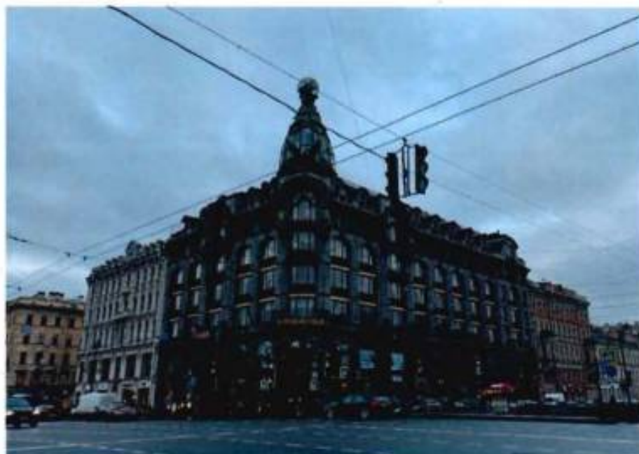
1. Общий вид на объект культурного наследия.
