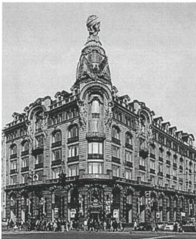
Фото 1. Лицевой фасад здания.
