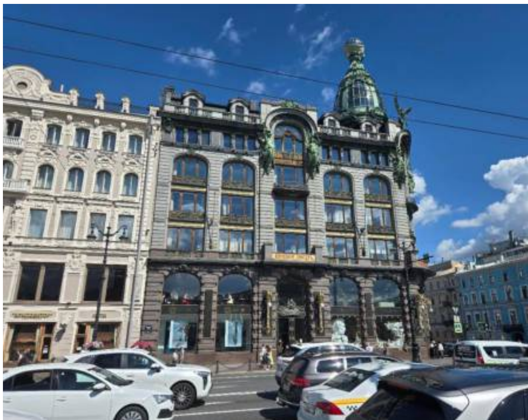
Фото. 1. Объект культурного наследия федерального значения «Дом компании «Зингер», расположенный по адресу: г. Санкт-Петербург, Невский просп., 28, канала Грибоедова наб., 21. Вид с Невского проспекта.
