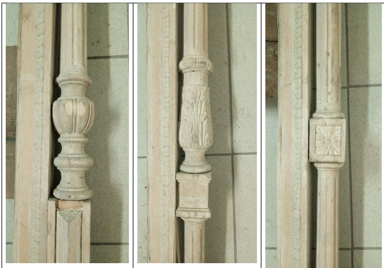
7. Деревянная напольная резная рама с консолью объекта культурного наследия регионального значения «Особняк Нобеля Э.Л. (Олейниковой М.Л.) с оградой». Фрагмент. Каннелированные колонки. 21.05.2026
